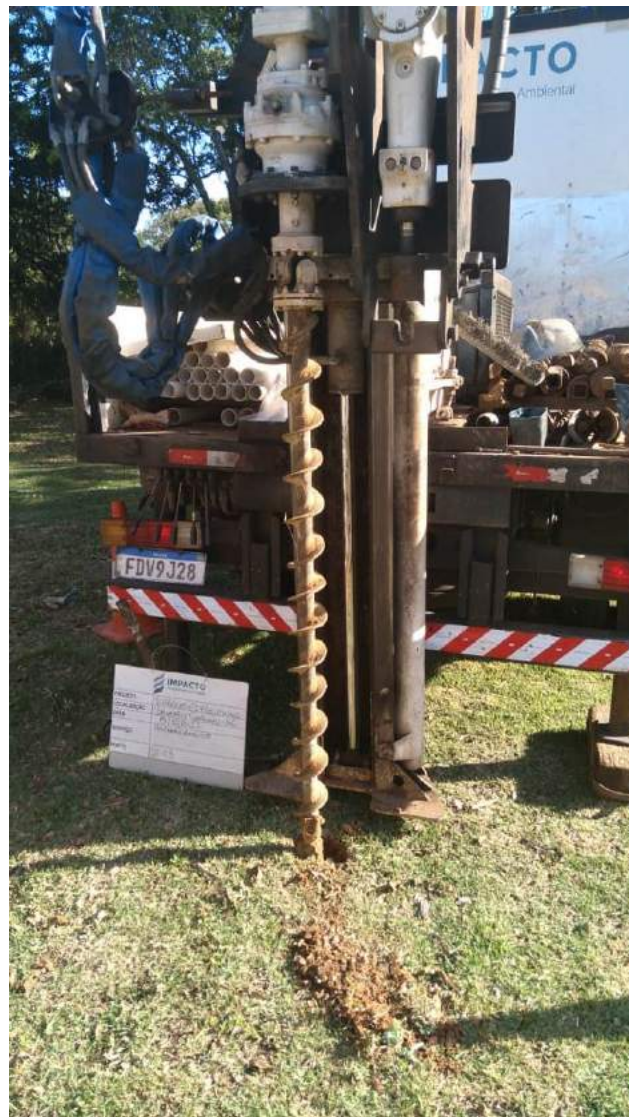
Fotografia 08: Execução da sondagem de reconhecimento ST-03
