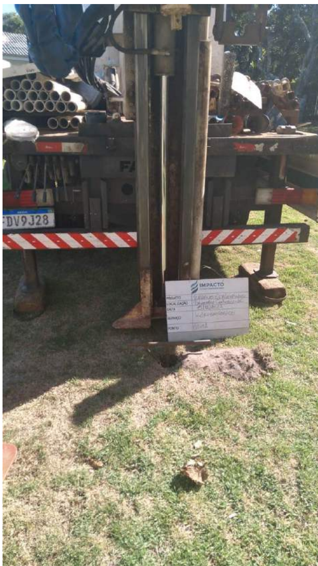
Fotografia 07: Execução da sondagem de reconhecimento ST-01
