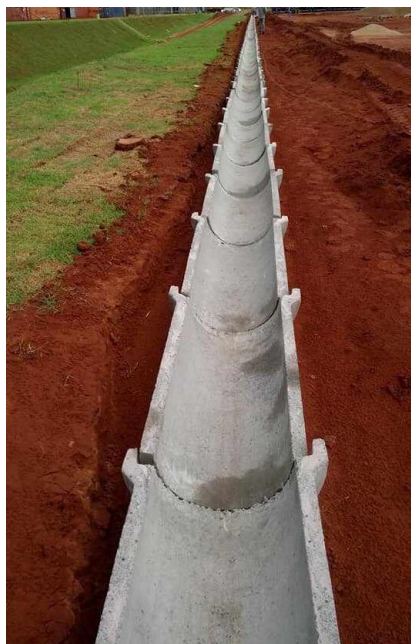
Figura 2- Ilustração de um sistema de drenagem com calhas do tipo meia cana
