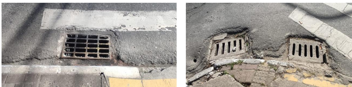
Figura 78 – Componentes do sistema de drenagem pluvial existentes nas ruas de entorno do empreendimento. Fonte: Autor, 2025.
