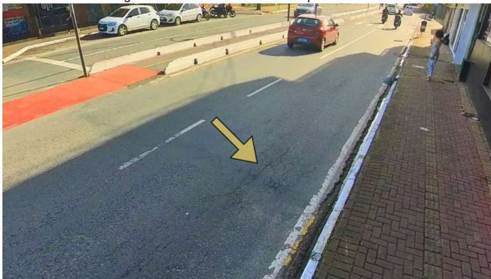
Figura 121- Fissuras no pavimento
