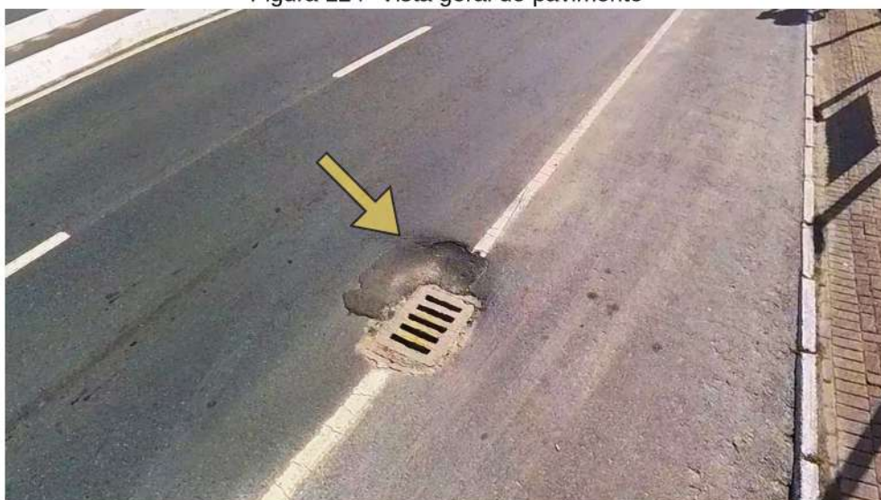
Figura 125- Remendo perto da boca de lobo
