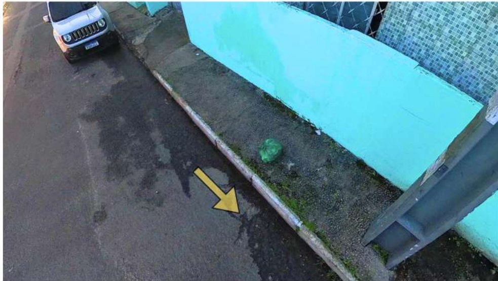
Figura 43 Marca de recorte no asfalto
