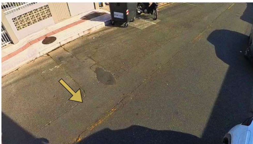
Figura 62- Marca de recorte no asfalto
