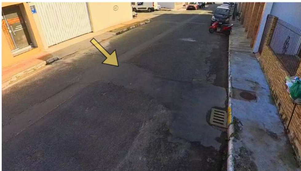
Figura 47- Marca de recorte no asfalto
