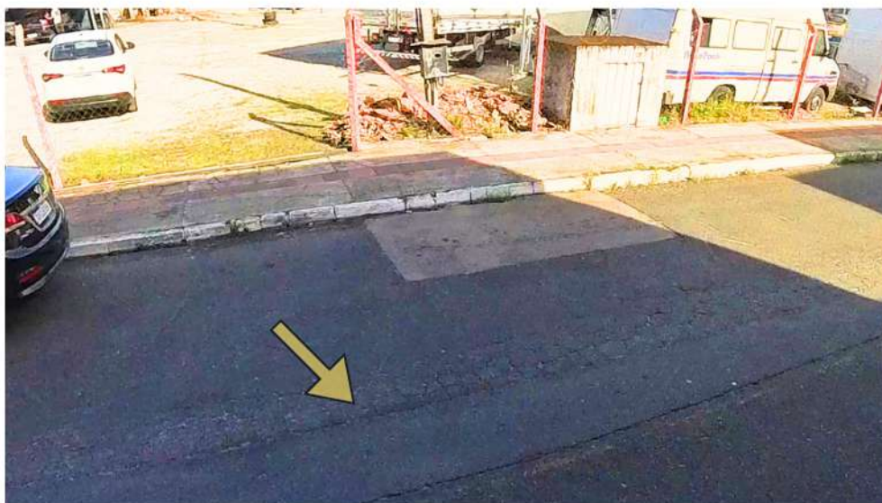
Figura 73- Marca de recorte no asfalto
