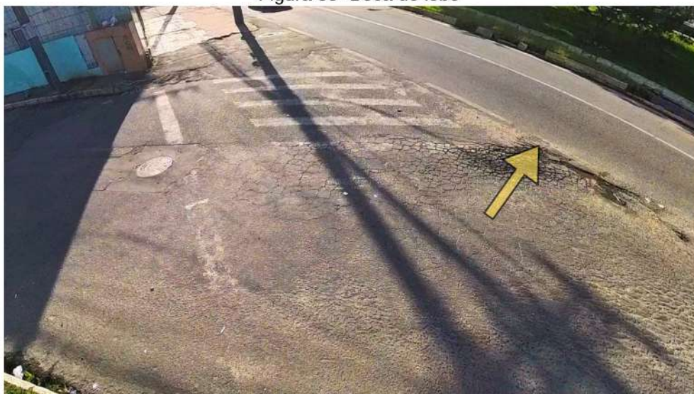
Figura 36- Fissuras no asfalto ocasionados por tráfego intenso, variações climáticas e problemas de construção.
