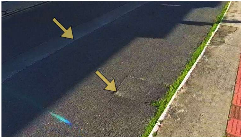
Figura 09- Marca de recorte no asfalto
