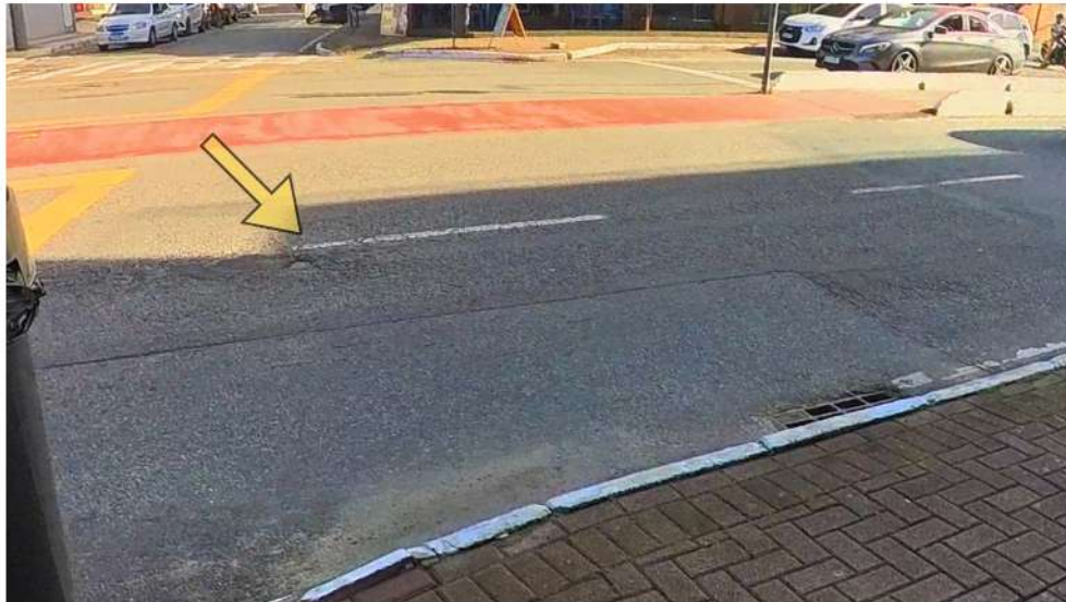
Figura 123- Buraco no pavimento
