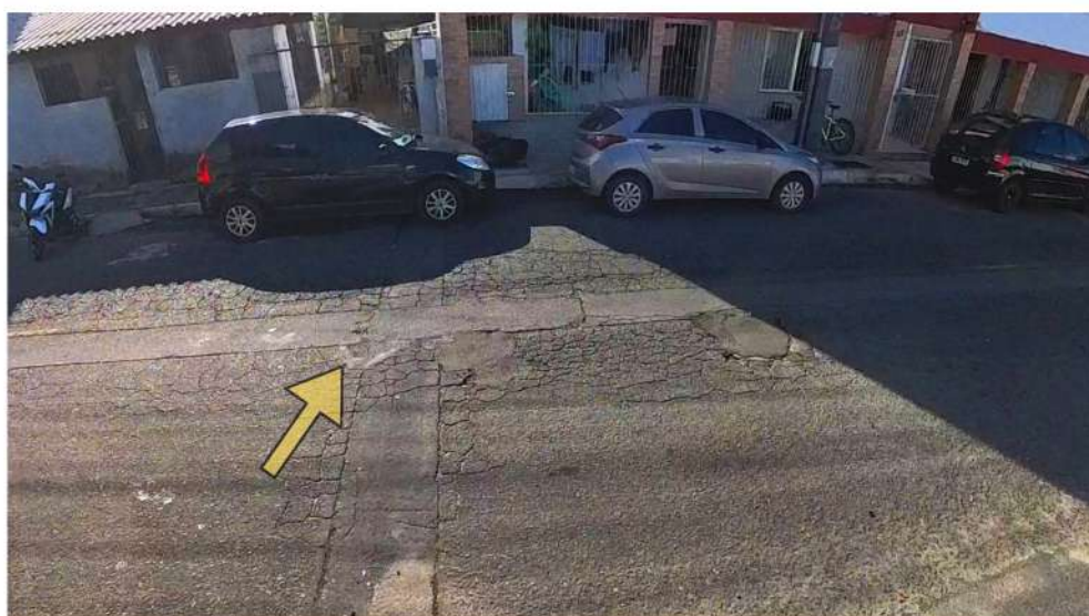
Figura 31- Marca de recorte no asfalto
