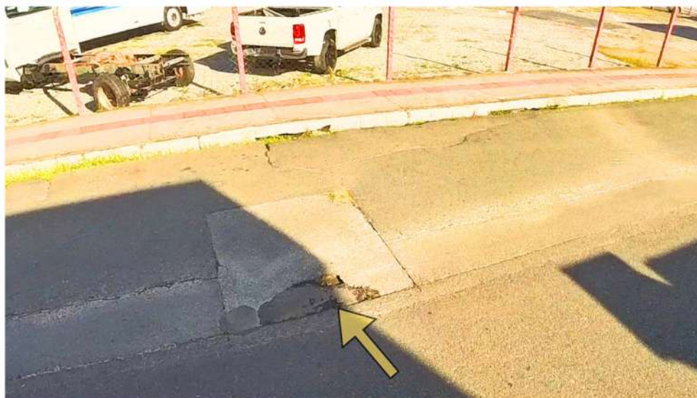
Figura 79- Marca de recorte no asfalto
