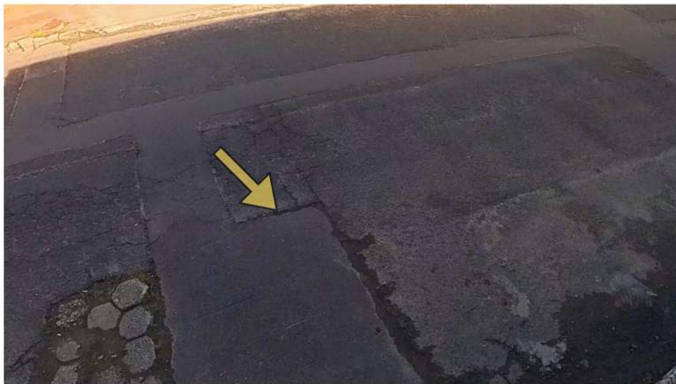
Figura 46- Marca de recorte no asfalto
