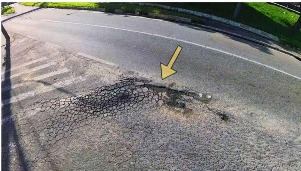
Figura 40- Fissuras no asfalto ocasionados por tráfego intenso, variações climáticas e problemas de construção.
