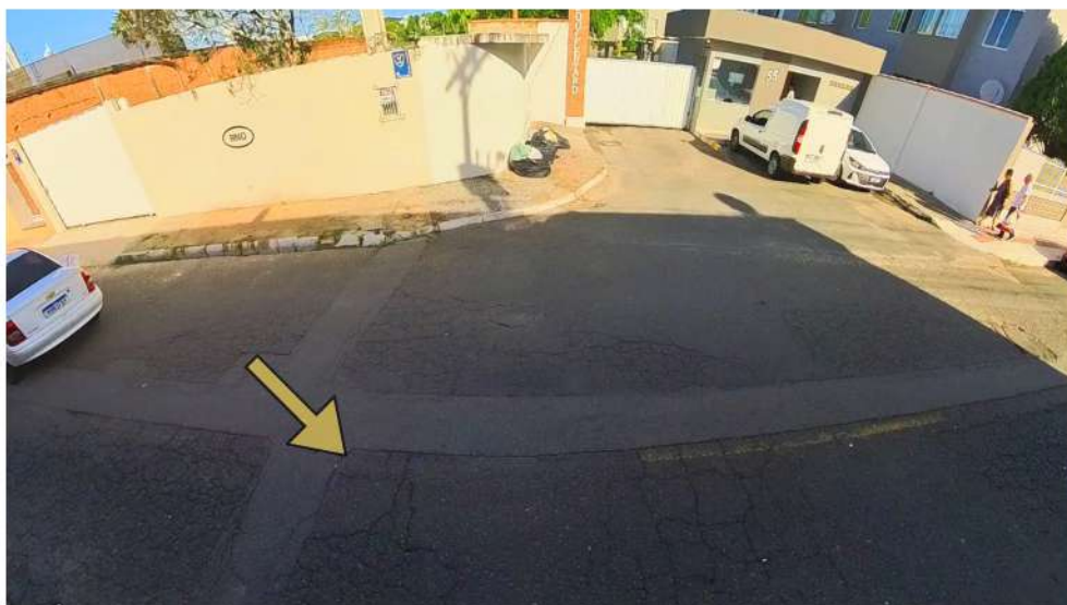
Figura 50- Marca de recorte no asfalto
