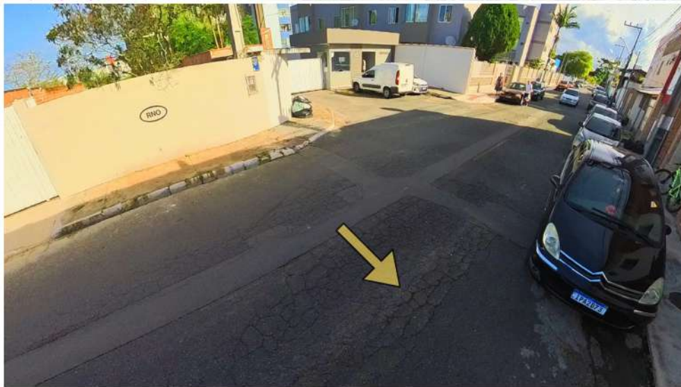
Figura 49- Fissuras na pavimentação
