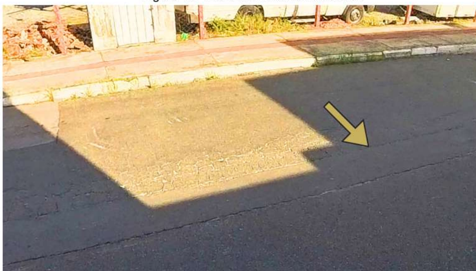
Figura 74- Marca de recorte no asfalto
