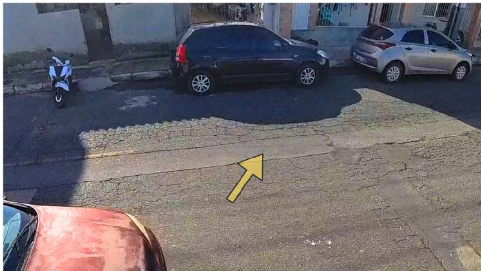
Figura 29- Marca de recorte no asfalto
