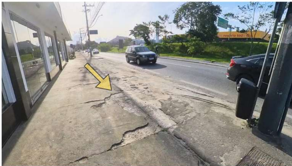
Figura 197-pavimento do passeio danificado
