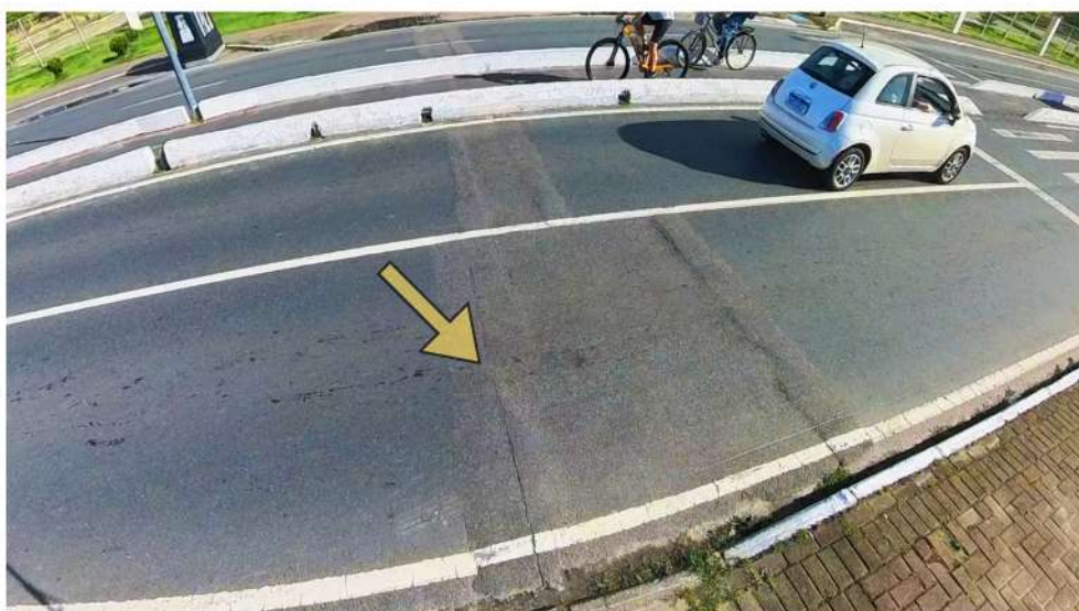
Figura 92- remendo na pavimentação
