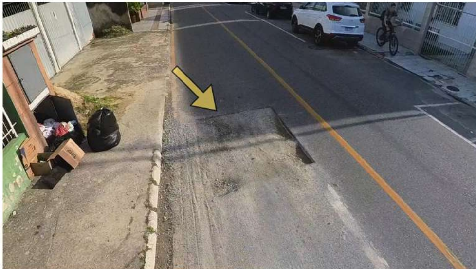
Figura 167 - buraco no pavimento com alta profundidade (+ 10 cm)
