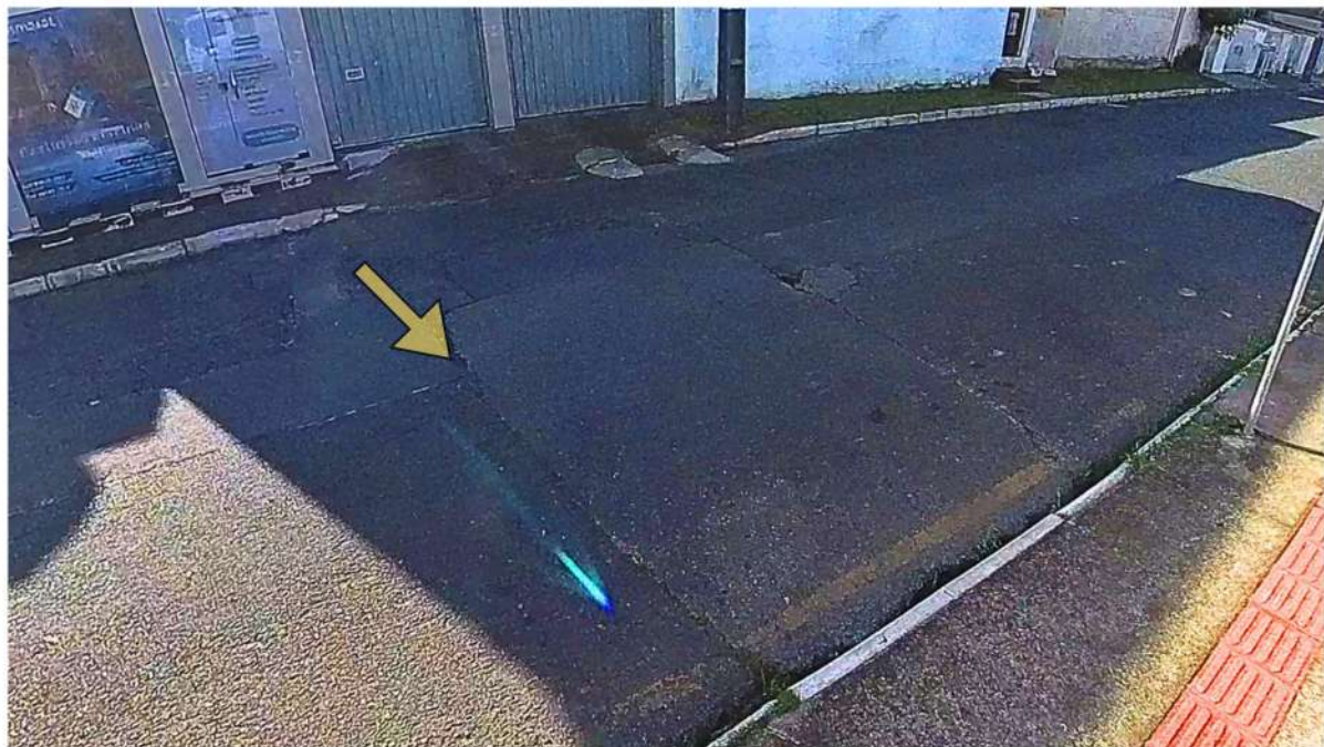
Figura 02- Marca de recorte no asfalto
