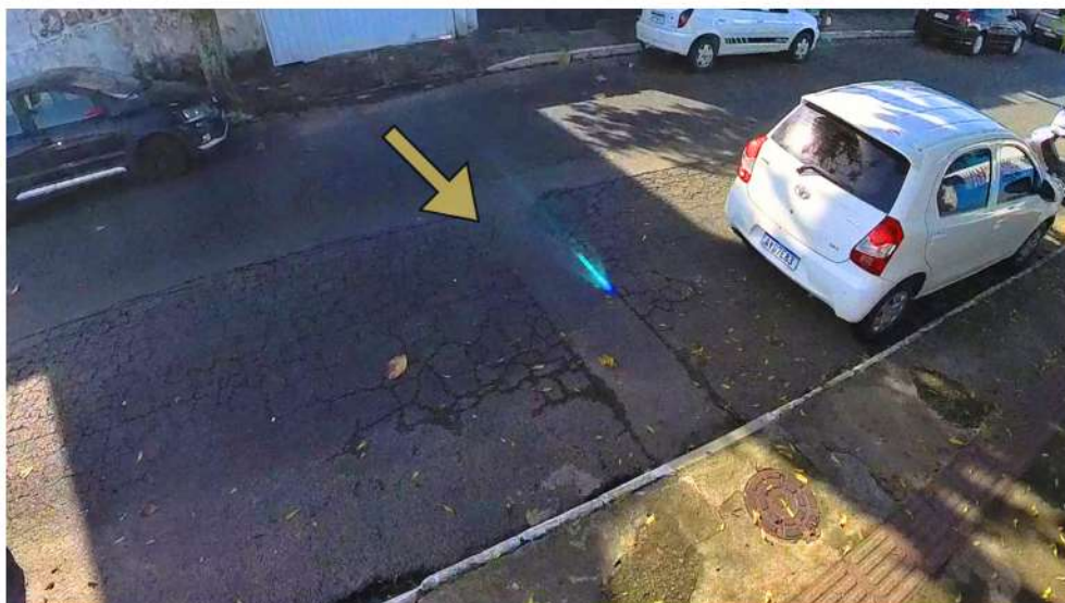
Figura 16- Marca de recorte no asfalto
