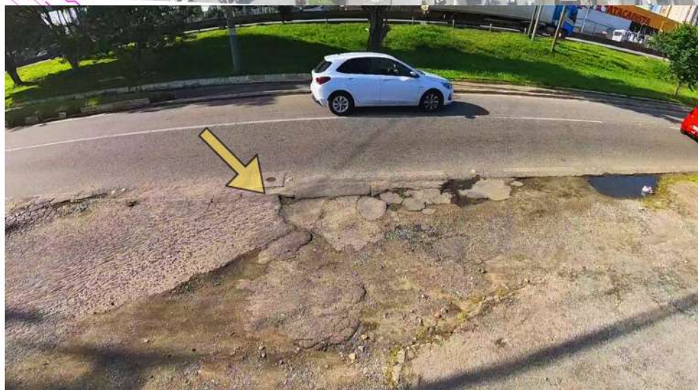
Figura 37- Fissuras no asfalto ocasionados por tráfego intenso, variações climáticas e problemas de construção.
