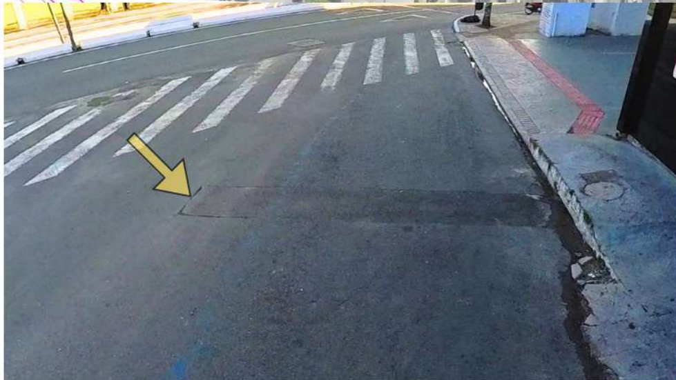
Figura 85- Marca de recorte no asfalto
