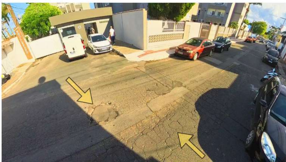
Figura 51- Remendos e fissuras nesse trecho
