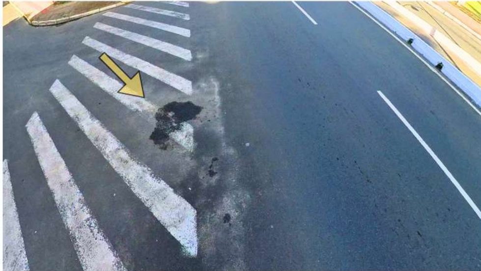
Figura 88 - Deformação plástica no pavimento
