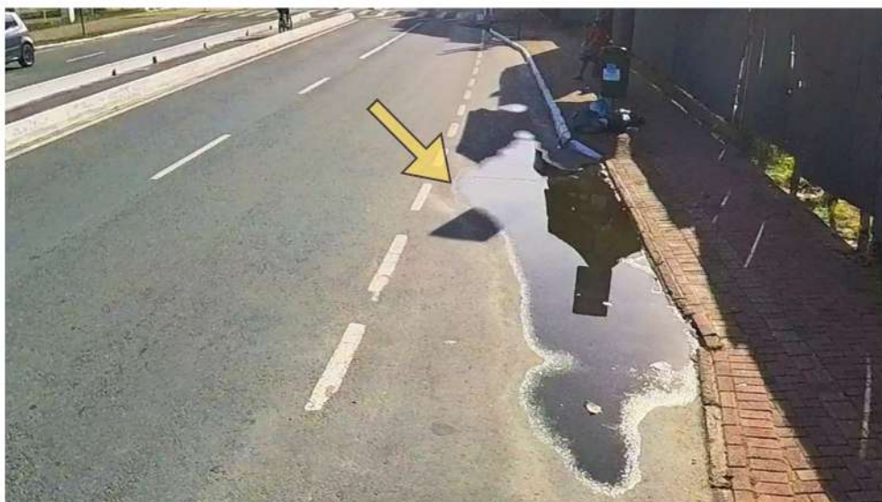
Figura 112- Acúmulo de água na pavimentação - Acesso da futura obra
