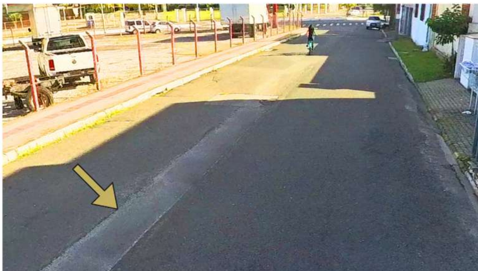
Figura 77- Marca de recorte no asfalto
