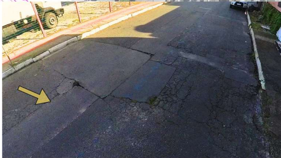
Figura 82- Marca de recorte no asfalto
