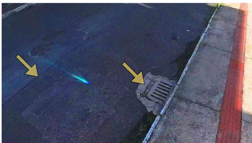
Figura 10- Marca de recorte no asfalto
