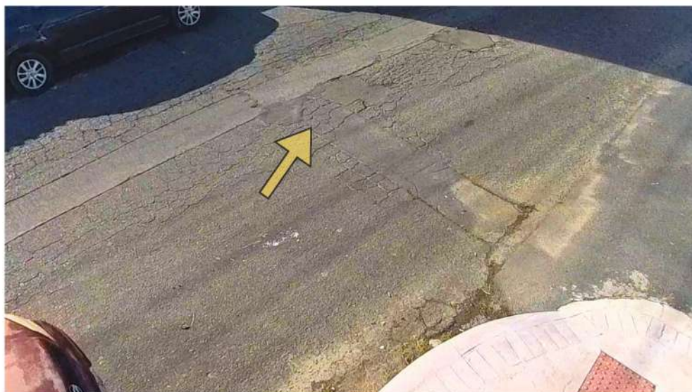
Figura 30- Marca de recorte no asfalto
