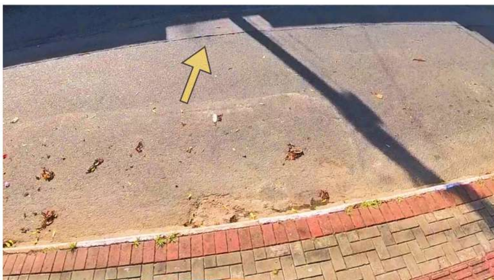
Figura 17- Marca de recorte no asfalto
