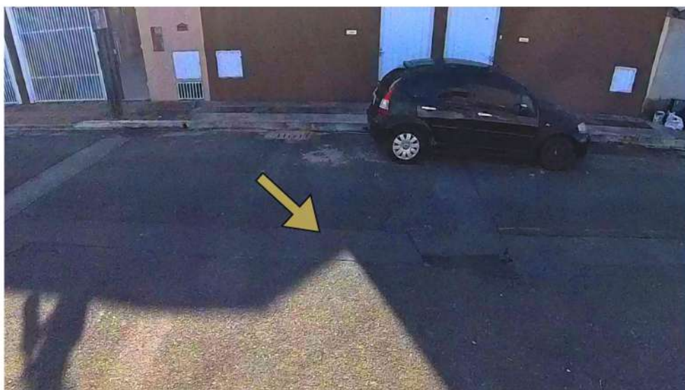
Figura 27- Marca de recorte no asfalto
