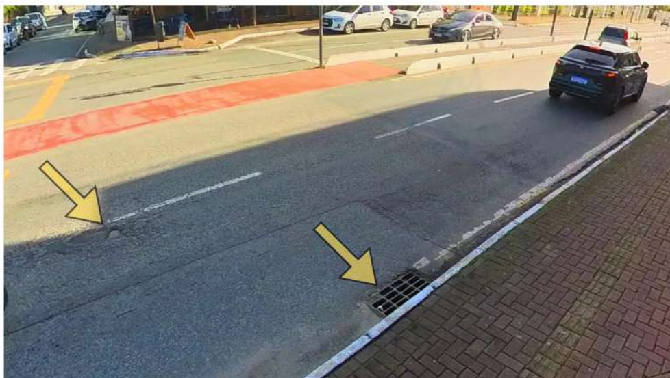
Figura 122- Buraco no pavimento
