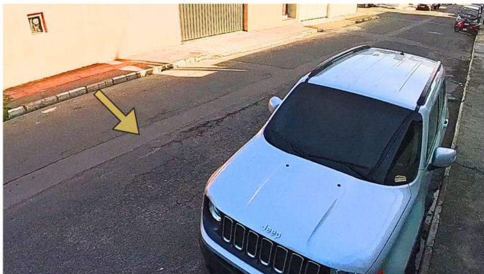
Figura 44- Marca de recorte no asfalto e rachaduras nesse trecho
