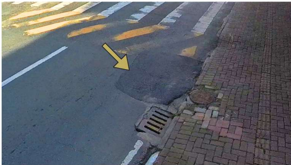
Figura 108 - Remendo na pavimentação
