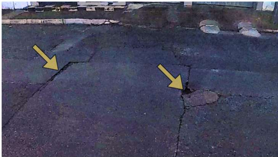
Figura 03- Marca de recorte no asfalto
