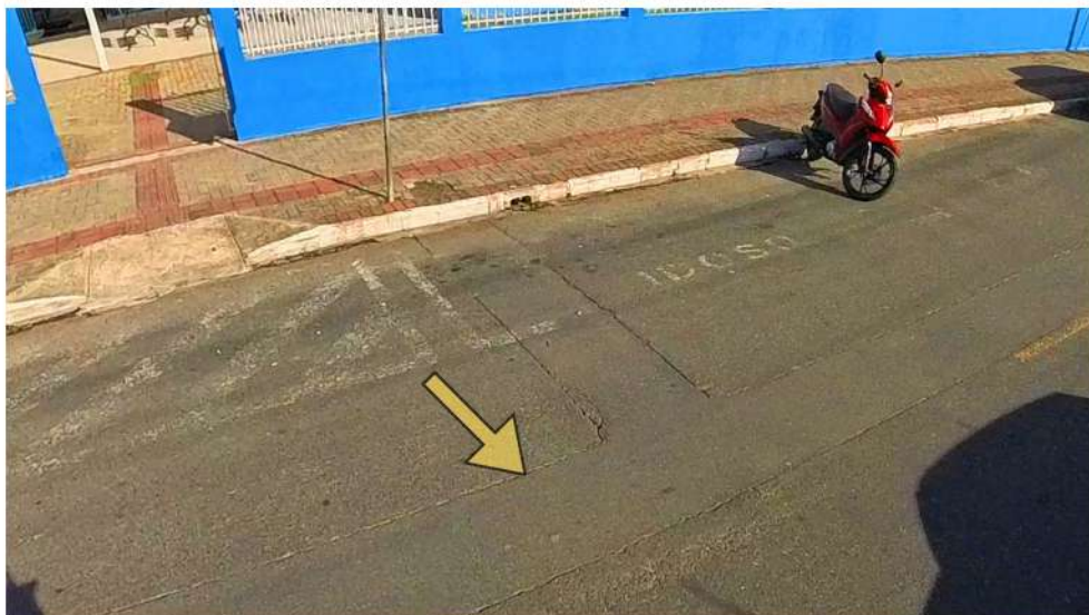
Figura 66- Marca de recorte no asfalto
