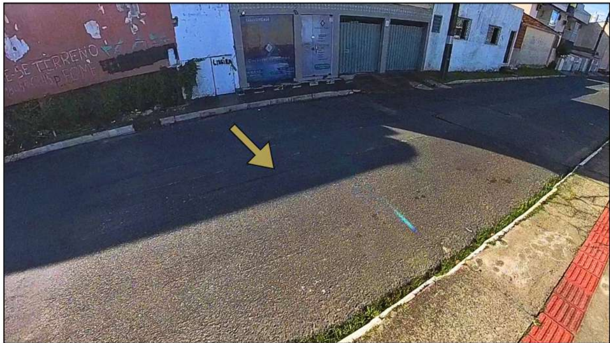
Figura 01- Marca de recorte no asfalto
