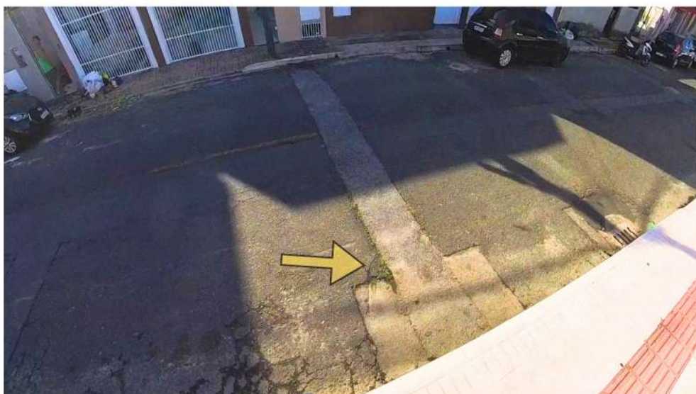
Figura 26- Marca de recorte no asfalto
