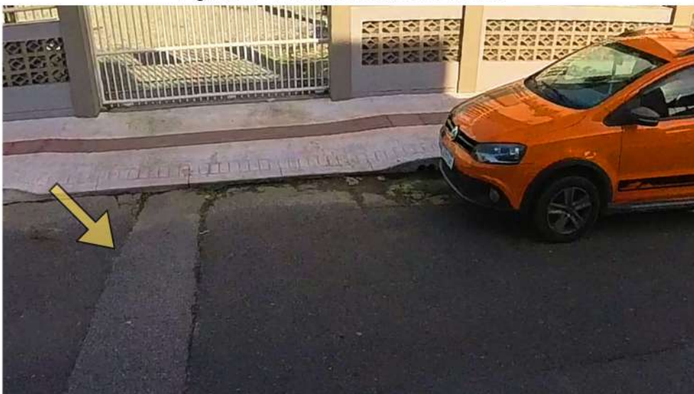
Figura 60- Marca de recorte no asfalto
