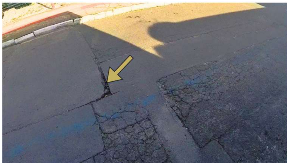
Figura 83- Marca de recorte no asfalto
