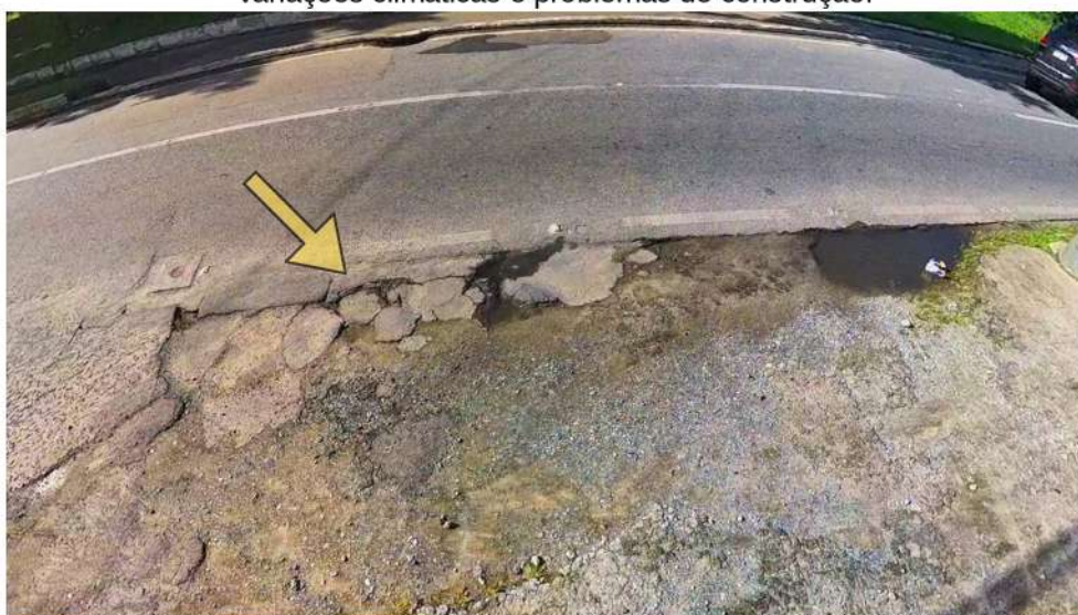
Figura 38- Fissuras no asfalto ocasionados por tráfego intenso, variações climáticas e problemas de construção.
