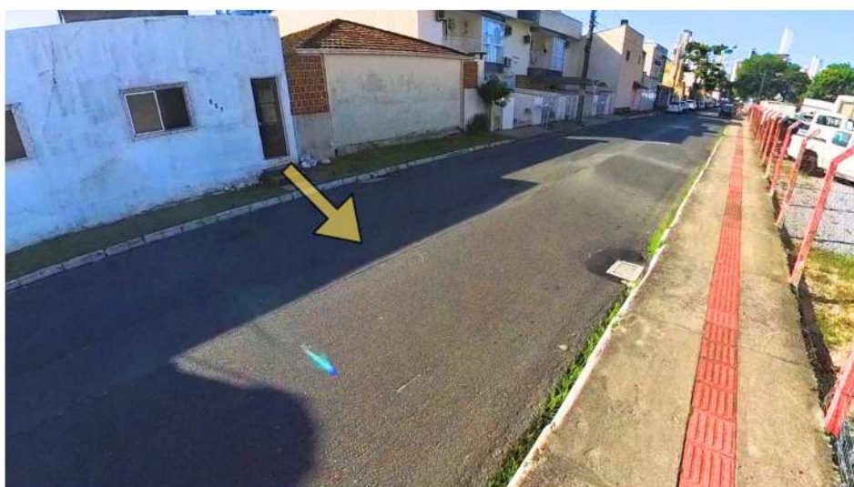
Figura 04- Marca de recorte e emenda no asfalto
