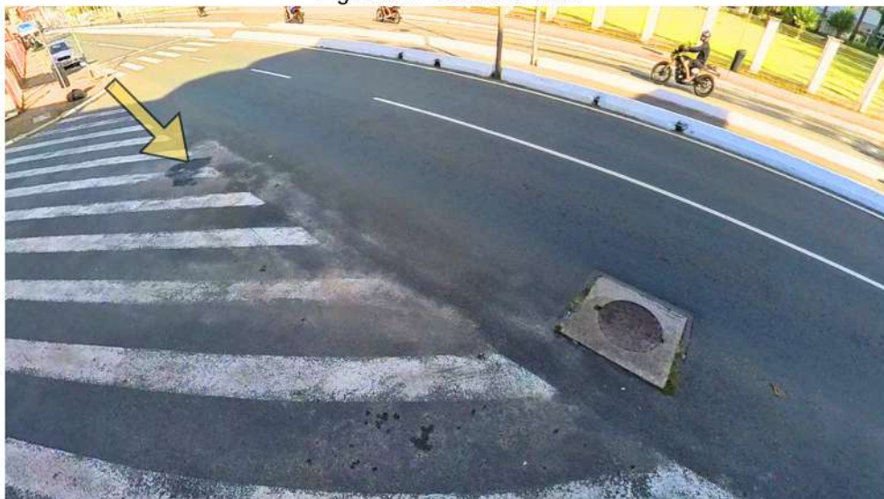
Figura 87- Deformação plástica no pavimento
