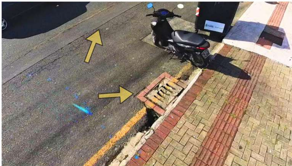
Figura 21- Marca de recorte no asfalto
