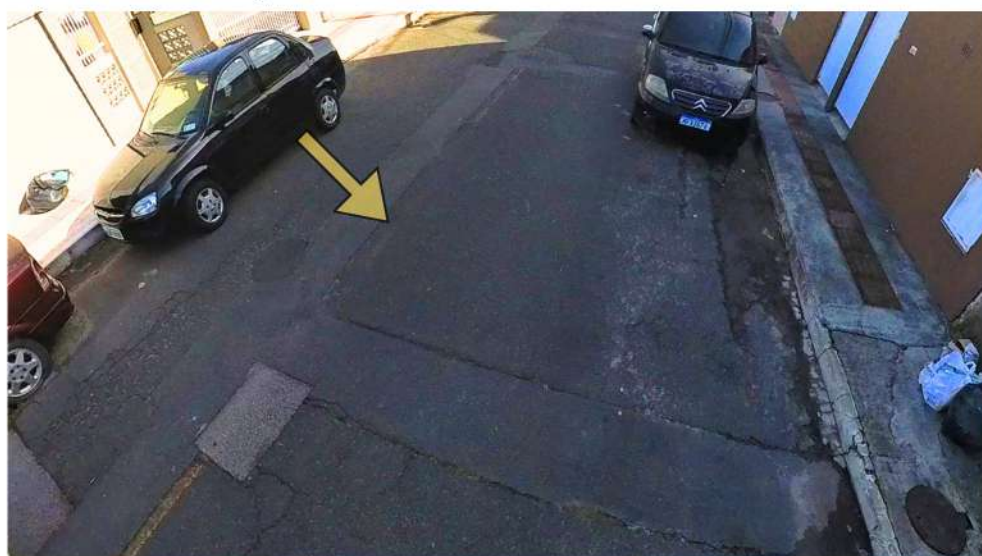
Figura 54- Marca de recorte no asfalto
