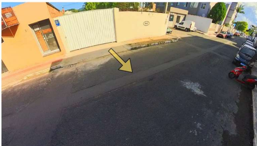
Figura 48- Marca de recorte no asfalto
