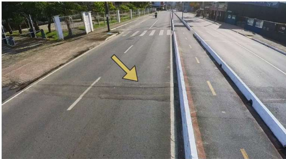
Figura 141- Remendo na pavimentação
