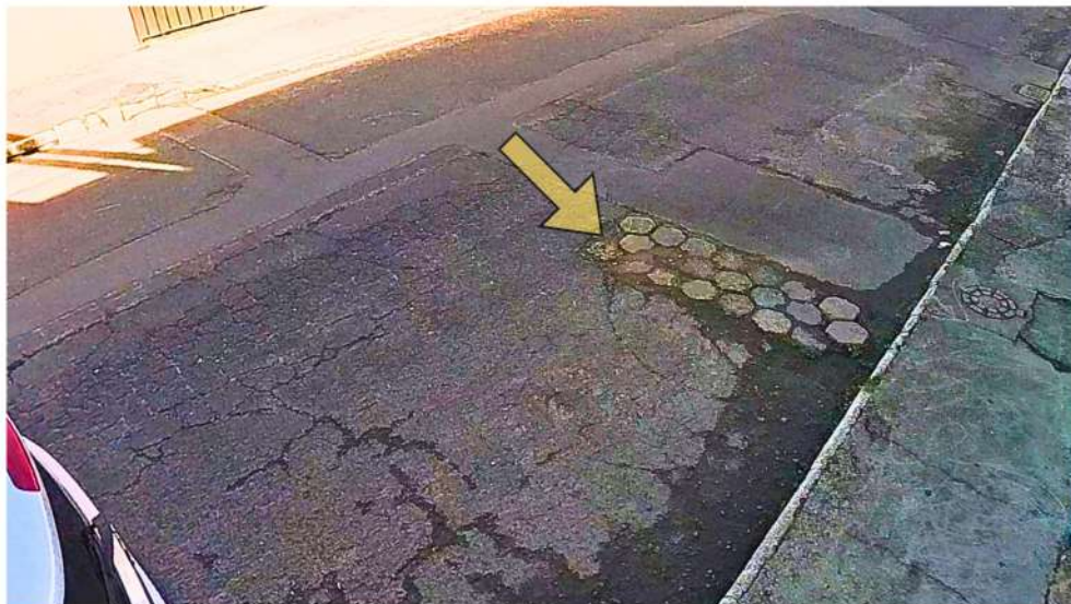
Figura 45- Uso de lajotas sextavadas para fechar buraco na pavimentação
