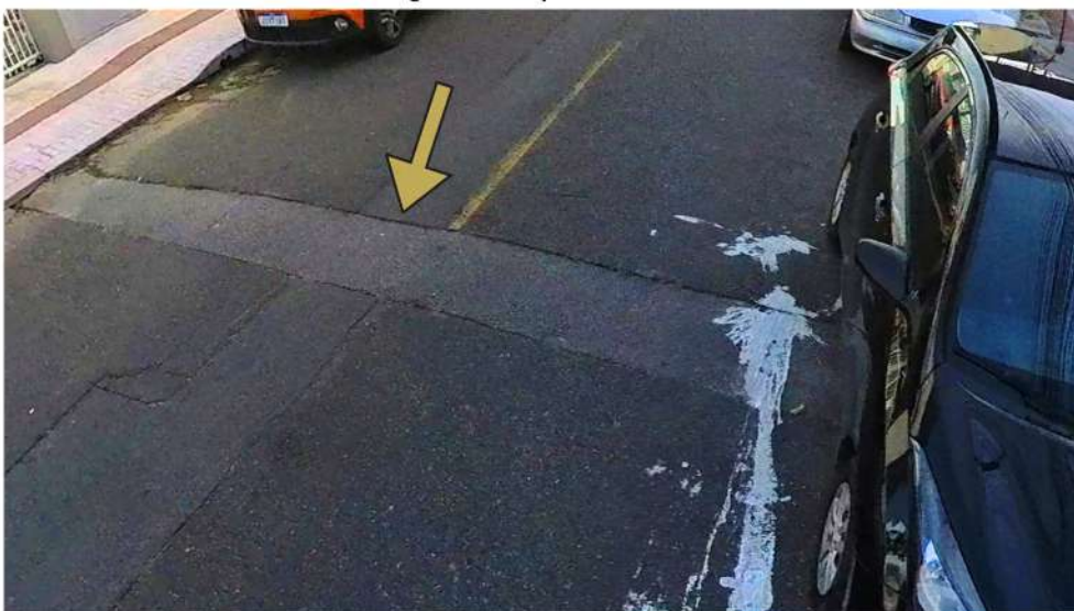
Figura 59- Marca de recorte no asfalto
