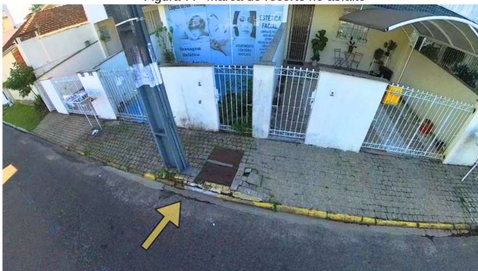
Figura 78- Marca de recorte no asfalto
