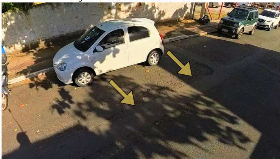
Figura 68- Marca de recorte no asfalto e presença de fissuras
