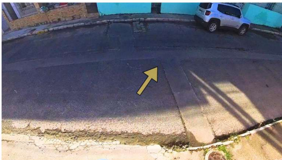
Figura 33- Marca de recorte no asfalto
