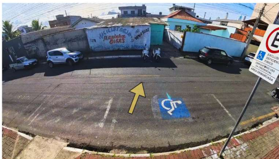
Figura 20- Marca de recorte no asfalto
