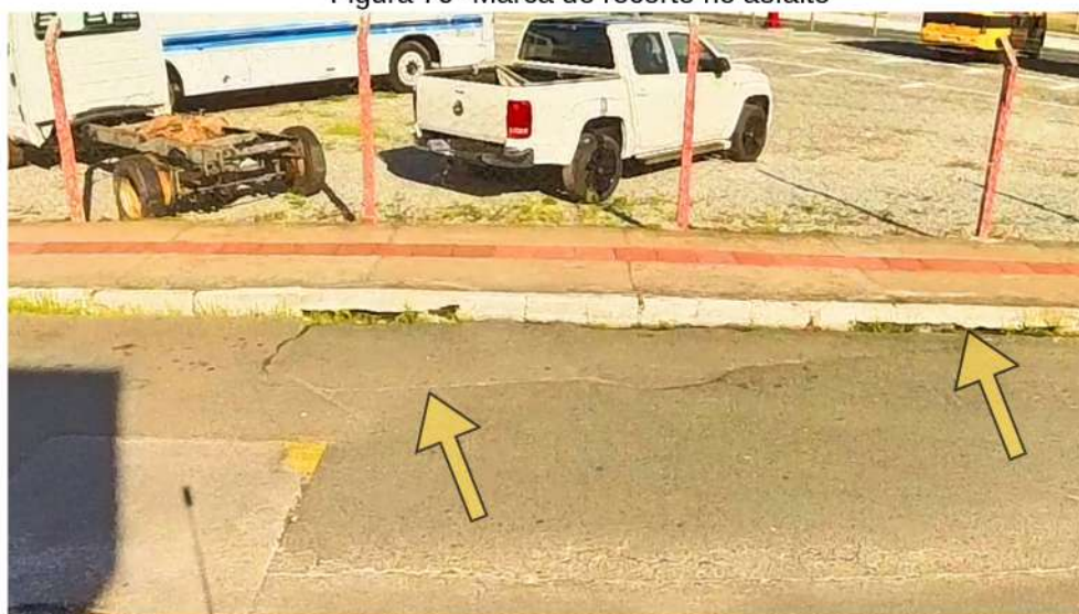
Figura 80- Marca de recorte no asfalto
