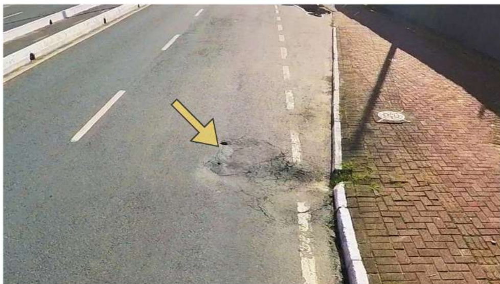
Figura 115- deformação plástica do pavimento
