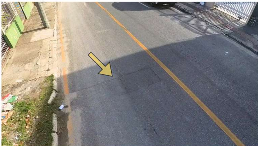
Figura 165- remendo no pavimento
