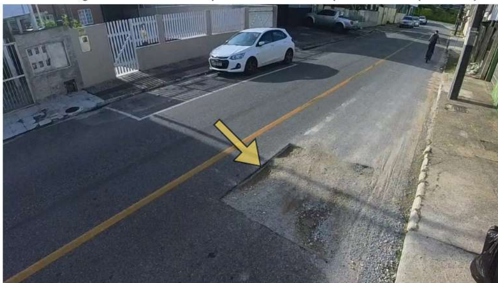
Figura 168-buraco no pavimento com alta profundidade (+ 10 cm)
