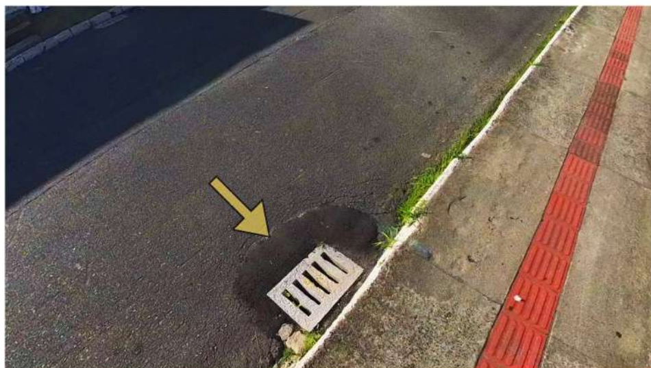
Figura 05- Marca de recorte no asfalto
