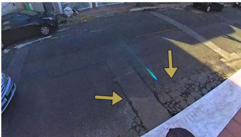
Figura 25- Marca de recorte no asfalto
