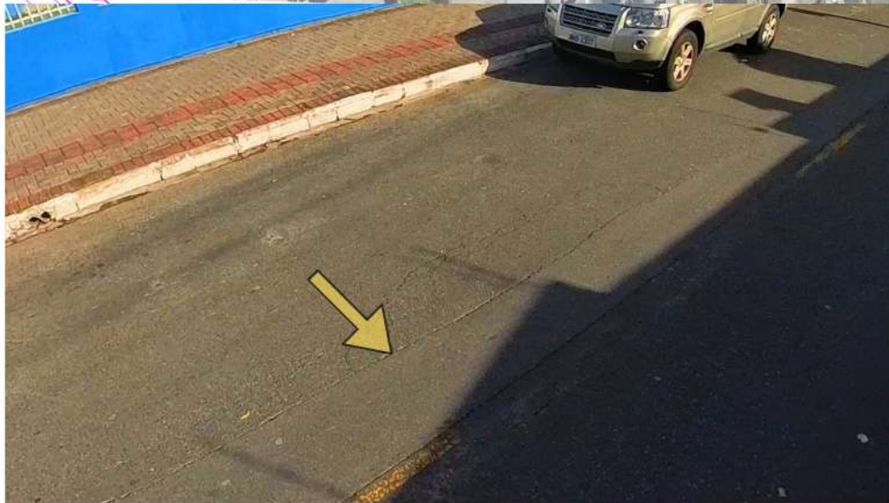
Figura 67- Marca de recorte no asfalto
