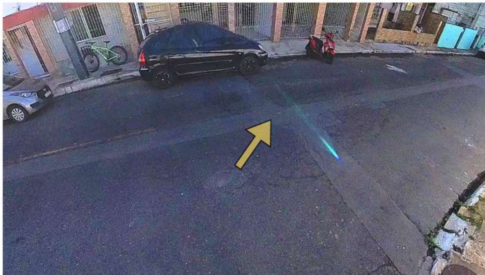
Figura 31- Marca de recorte no asfalto
