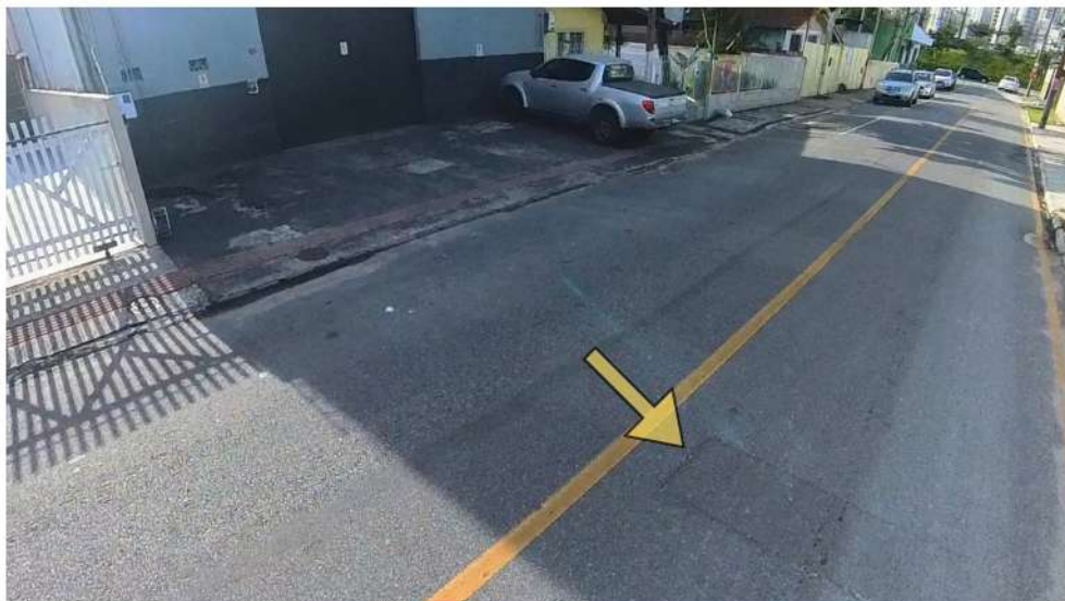
Figura 166 - remendo no pavimento
