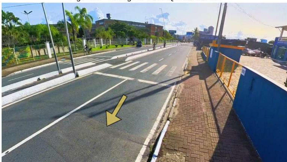
Figura 98 - Remendo na pavimentação
