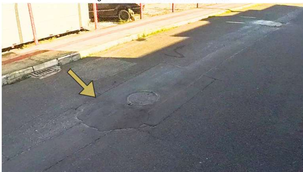
Figura 75- Marca de recorte no asfalto
