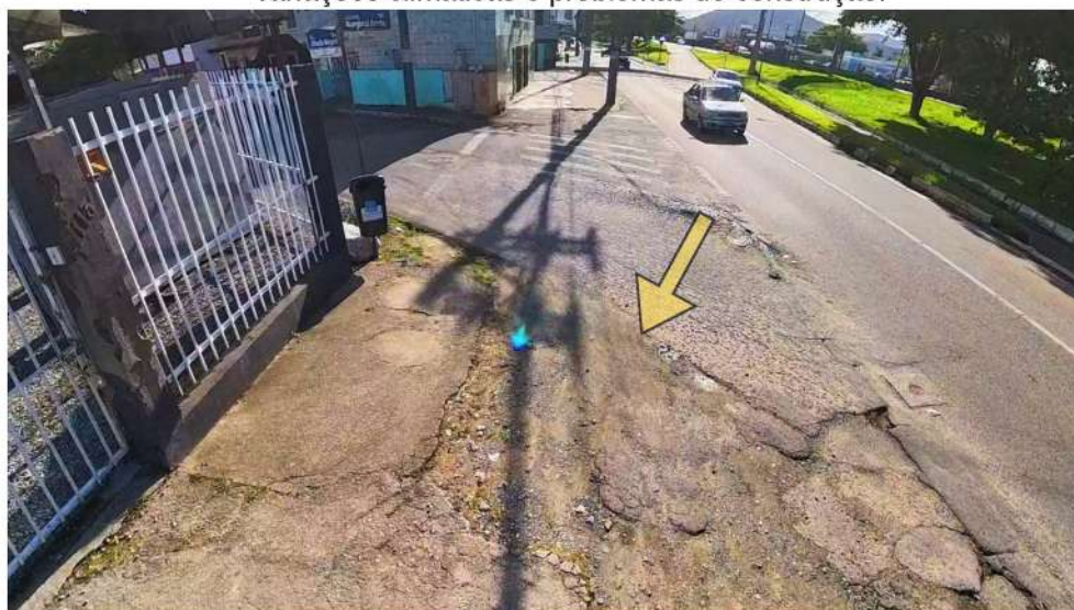
Figura 39- Fissuras no asfalto ocasionados por tráfego intenso, variações climáticas e problemas de construção.
