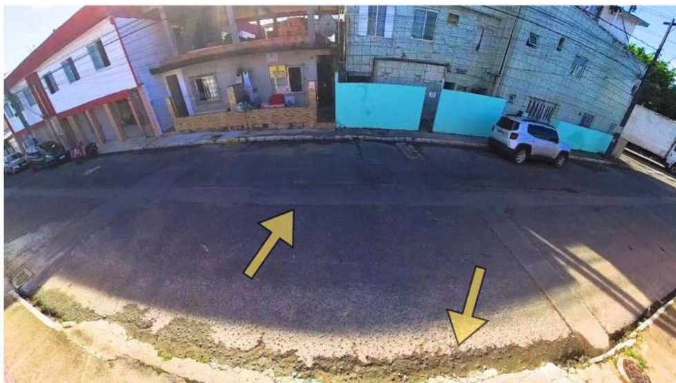
Figura 32- Marca de recorte no asfalto
