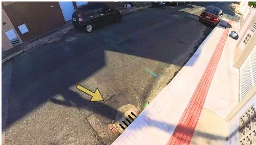
Figura 26- Marca de recorte no asfalto
