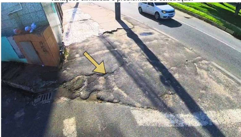
Figura 41- Patologias no asfalto aplicado no passeio público
