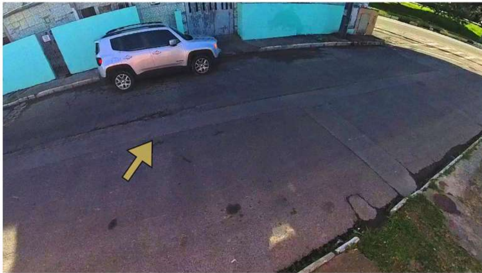
Figura 34- Marca de recorte no asfalto
