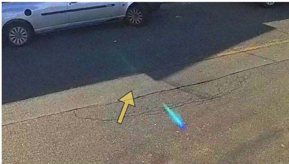
Figura 18- Marca de recorte no asfalto
