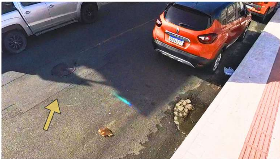
Figura 24- Marca de recorte no asfalto
