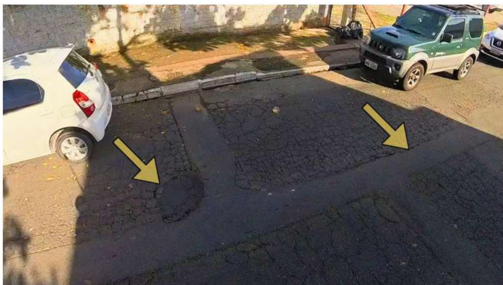
Figura 69- Marca de recorte no asfalto
