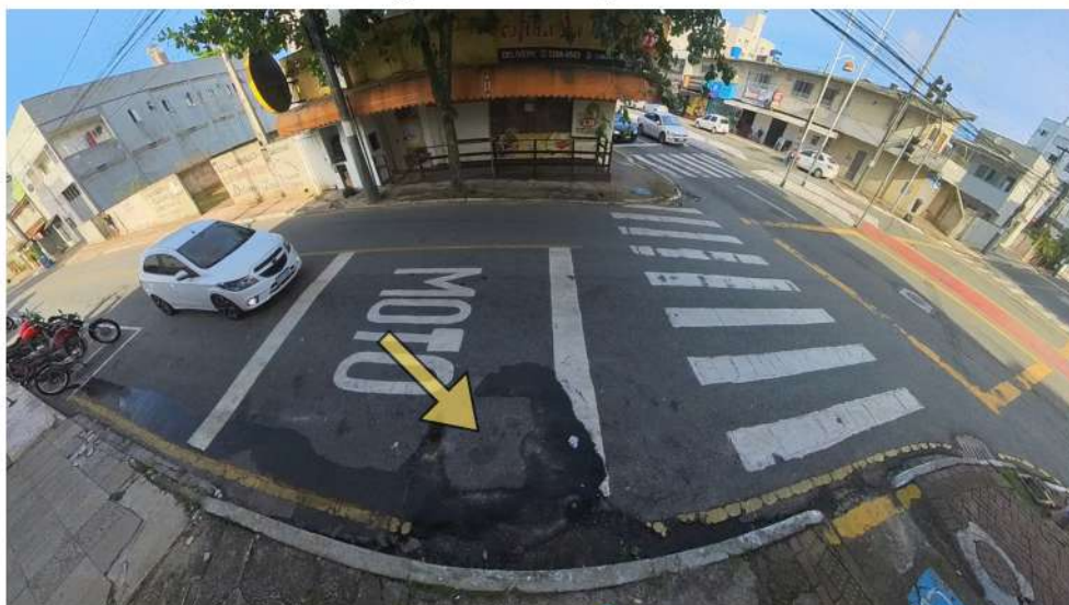
Figura 181- remendo no pavimento
