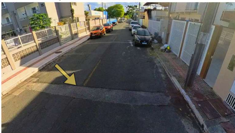
Figura 57- Marca de recorte no asfalto
