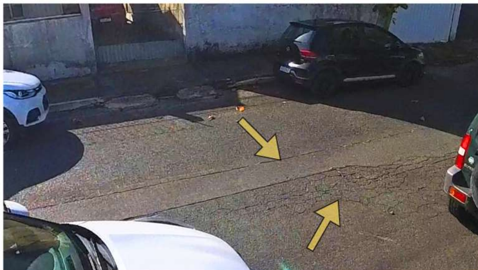
Figura 14- Marca de recorte no asfalto
