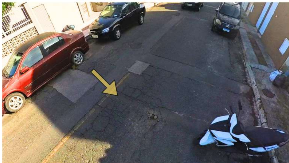
Figura 52- Fissuras na pavimentação
