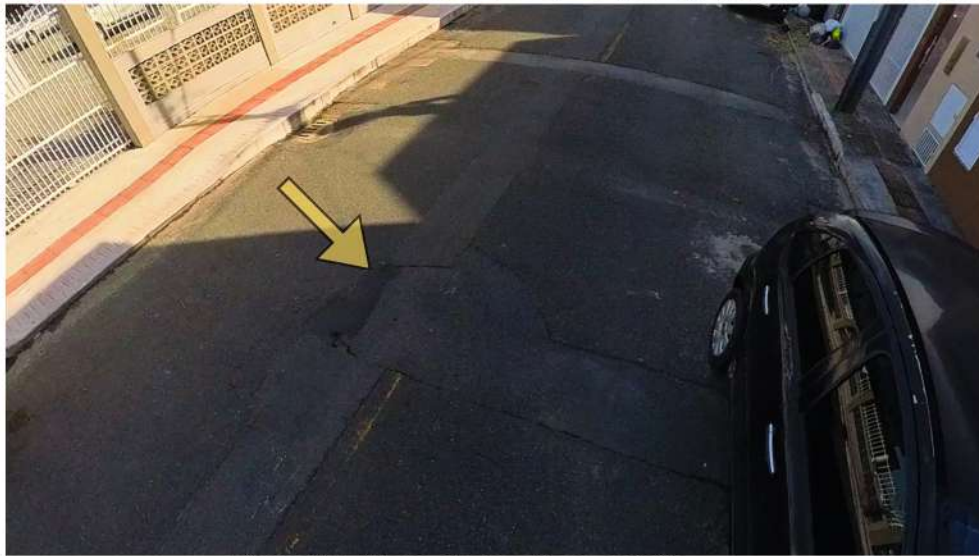
Figura 55- Marca de recorte no asfalto
