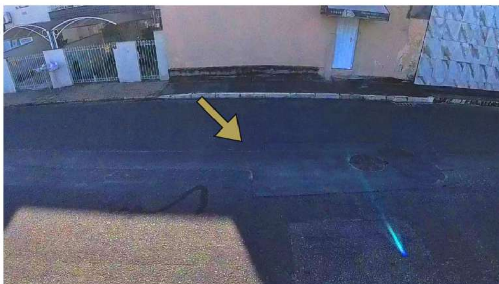
Figura 11- Marca de recorte no asfalto
