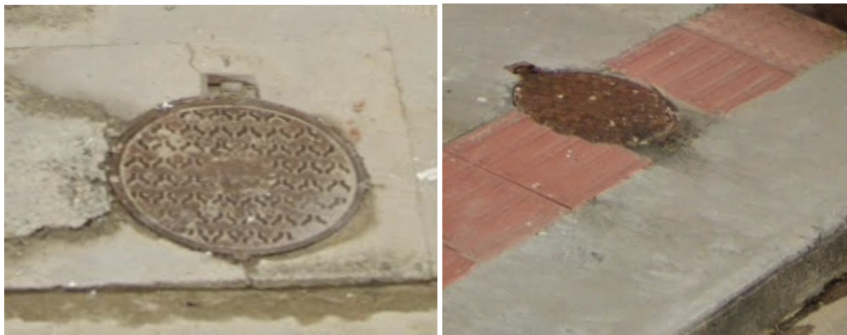
Figura – Caixas de Inspeção da rede pública de coleta de efluentes sanitários na região do empreendimento. Fonte: Autor, 2025.
