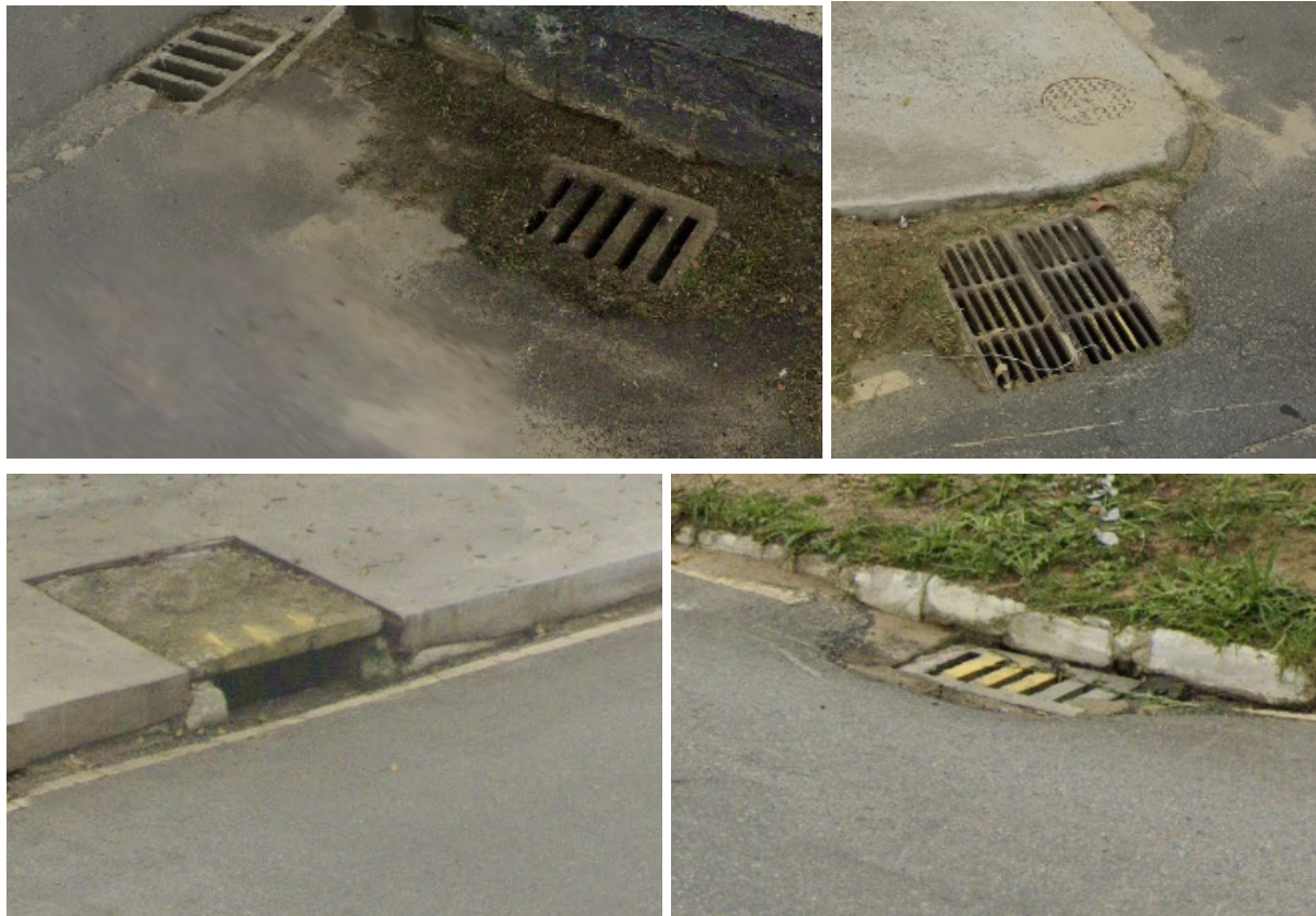
Figura – Componentes do sistema de drenagem pluvial existentes na região do empreendimento. Fonte: Autor, 2025.
