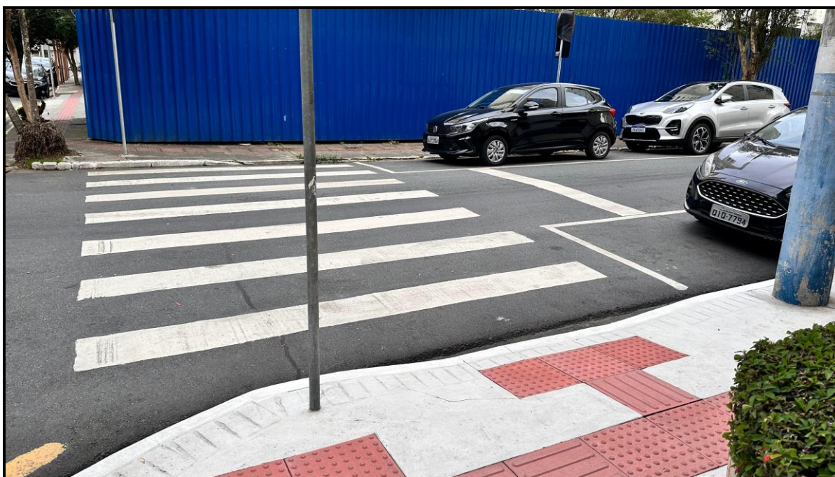
Figura 135 – Rua 3110 na interseção com a Rua 3158: ausência de rampa de acessibilidade em um dos lados e problemas de nivelamento (09/04/2024). Fonte: Autor, 2024.
