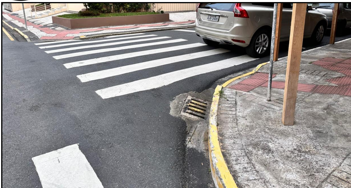
Figura 130 – Rua 3160 na interseção com a Rua 3158: desnível entre rampa e pista (09/04/2024).
