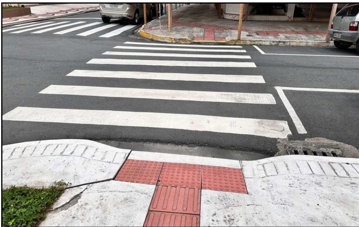
Figura 129 – Rua 3158 na interseção com ruas 3126 e 3160: desnível entre rampa e pista (09/04/2024). Fonte: Autor, 2024.
