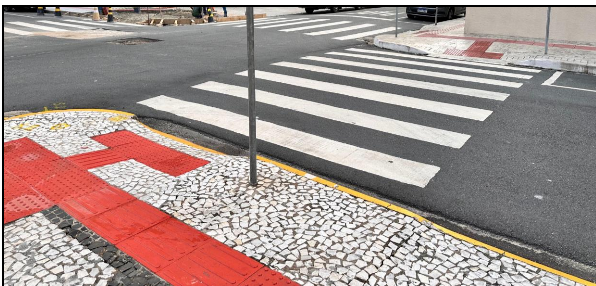
Figura 131 – Rua 3160 na interseção com a Rua 3140: desnível entre rampa e pista (09/04/2024).
