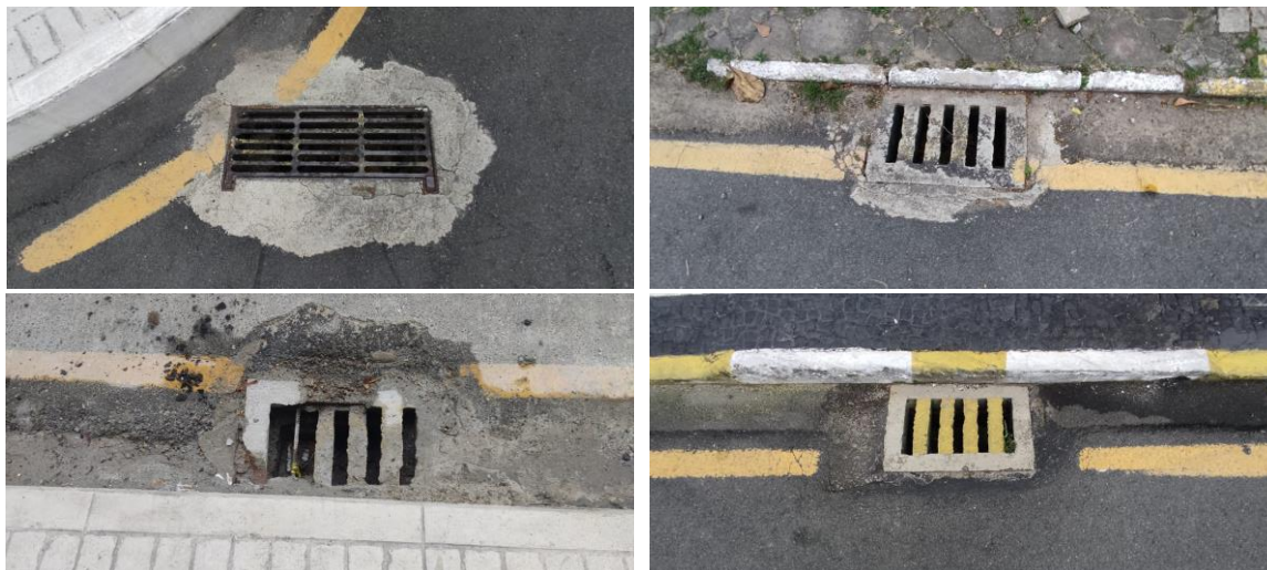
Figura 82 – Componentes do sistema de drenagem pluvial existentes no entorno. Fonte: Autor, 2024.
