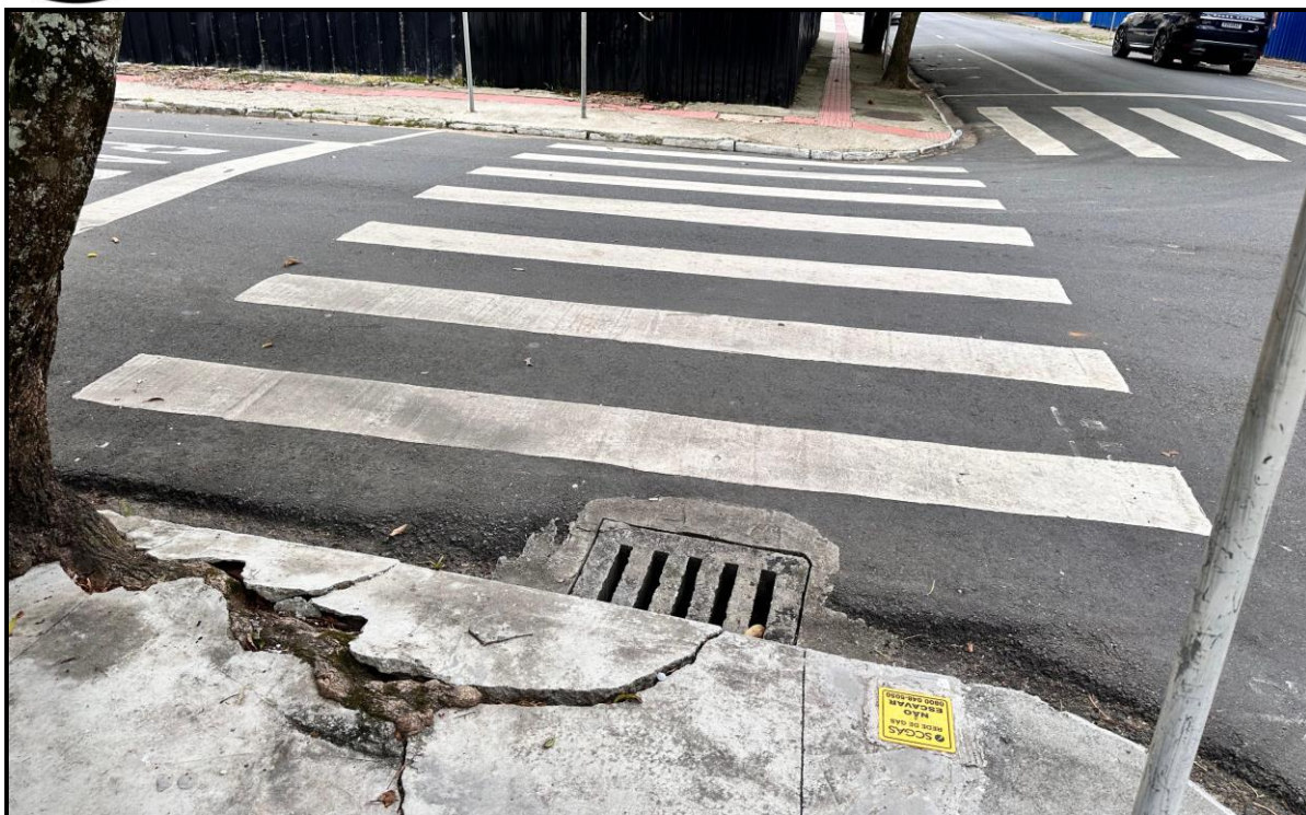
Figura 134 – Rua 3140 na interseção com a Rua 3110: calçada deteriorada e ausência de rampas de acessibilidade (09/04/2024). Fonte: Autor, 2024.
