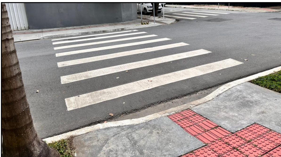
Figura 133 – Rua 3110 na interseção com a Rua 3140: ausência de rampa de acessibilidade em um dos lados e problemas de nivelamento (09/04/2024). Fonte: Autor, 2024.
