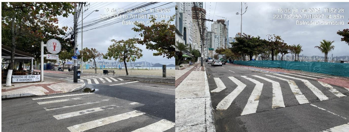
Figura 163. Faixa elevada de travessia de pedestres na Av. Atlântica, próximo à Rua 4750 e Rua 4600, respectivamente
