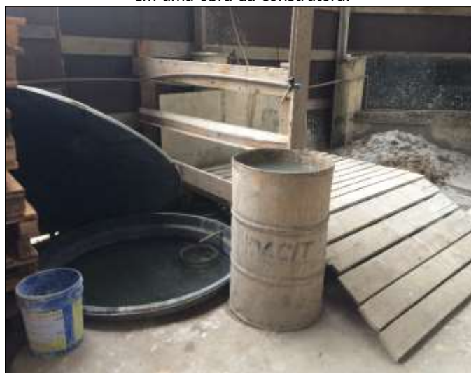
Figura 10 – Sistema para reaproveitamento da água proveniente da limpeza dos equipamentos executado em uma obra da construtora.
