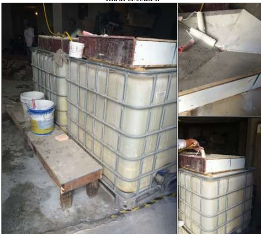
Figura 11 – Sistema para armazenamento da água proveniente da limpeza dos pincéis executado em uma obra da construtora.
