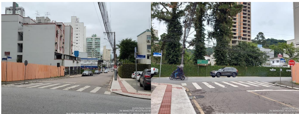
Figura 143. Piso tátil e rebaixamento de guia na interseção entre a Rua Miguel Matte e Rua Antônio Bittencourt
