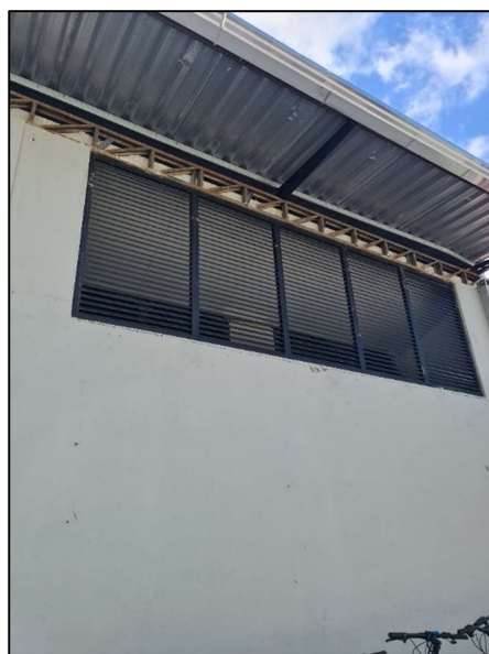
Figura 12.4: Ventilação na área de máquinas do empreendimento. Fonte: Alameda Engenharia, 2024.
