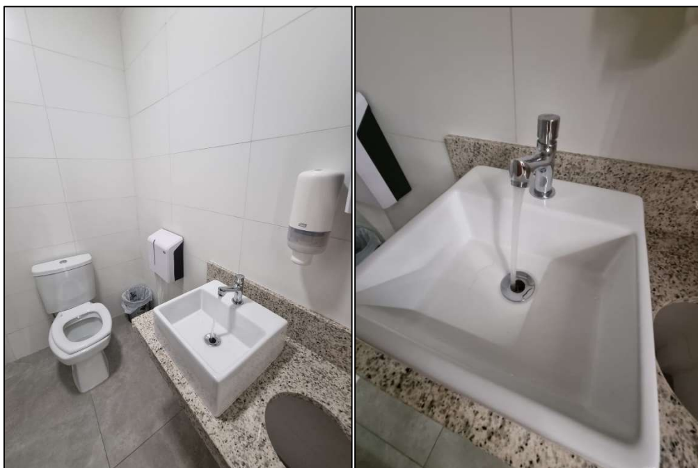
Figuras 14.1 e 14.2: Redutores de vazão nas torneiras nos banheiros. Fonte: Alameda, 2024.
