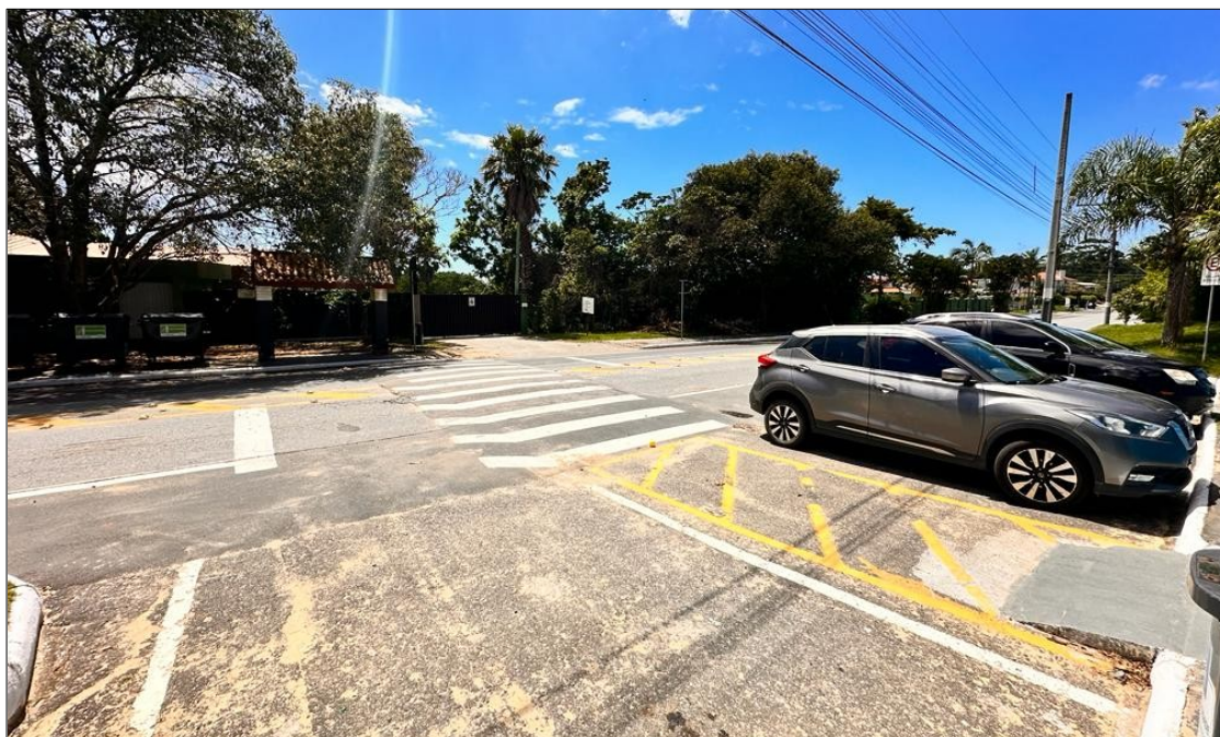
Figura 12 – Rampa de transição com baixa inclinação e plataforma desconexa do passeio (12/12/2023). Fonte: Autor, 2023.
