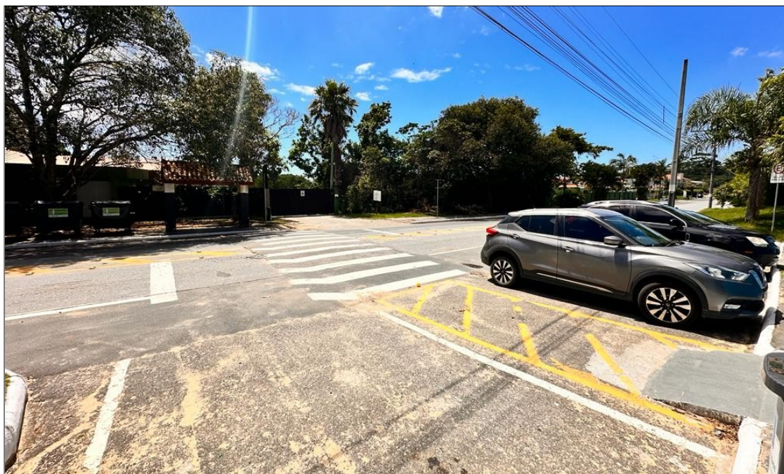
Figura 11 – Rampa de transição com baixa inclinação e plataforma desconexa do passeio (12/12/2023). Fonte: Autor, 2023.
