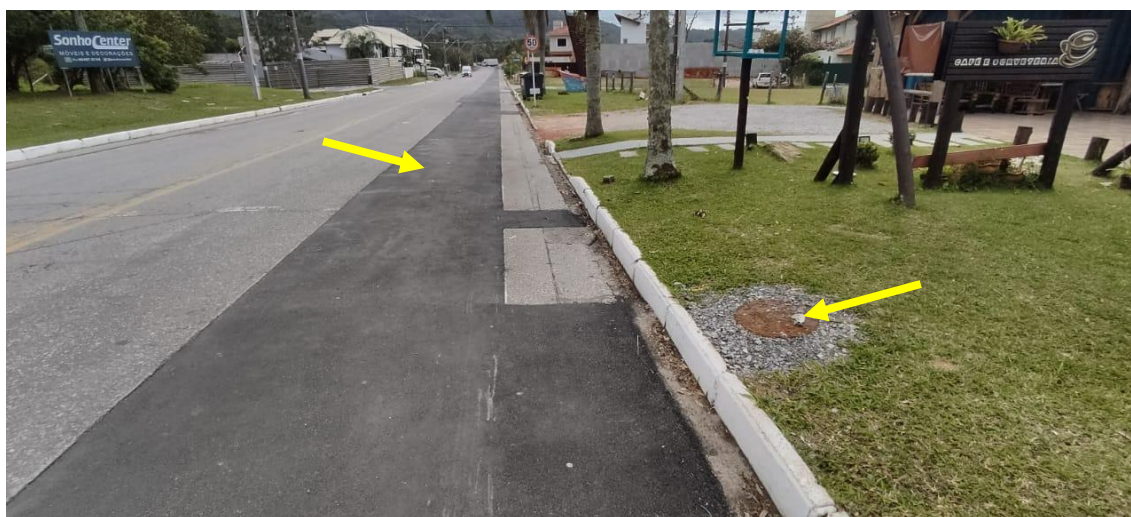
Figura 64 – Indícios da recém instalação dos equipamentos da rede pública de coleta de efluentes sanitários na Av Rodesindo Pavan indicados pela seta amarela. Fonte: Autor, 2022.
