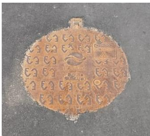
Figura 65 – Caixas de Inspeção da rede pública de coleta de efluentes sanitários recém instalados na Av Rodesindo Pavan. Fonte: Autor, 2022.
