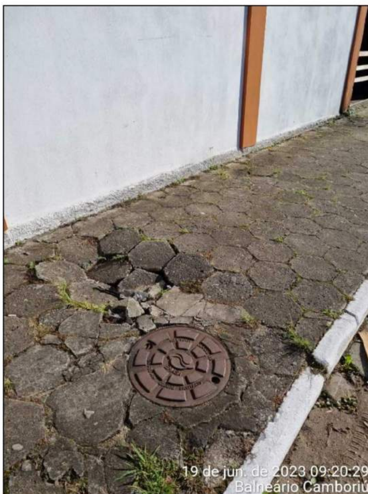
Figura 50: Caixa de inspeção de esgoto sanitário na calçada em frente à área do empreendimento.
