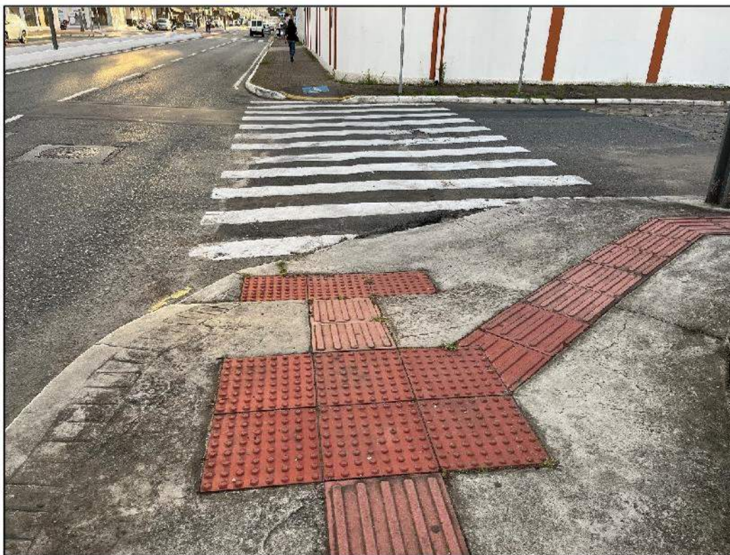
Figura 75: Acessibilidade das calçadas com sinalização tátil no piso. Fonte: Alameda Eng. 2023.
