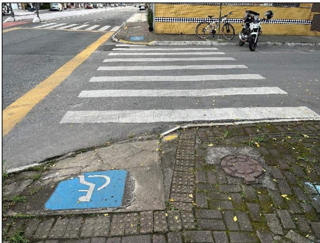
Figura 76: Acessibilidade das calçadas com sinalização tátil no piso. Fonte: Alameda Eng. 2023.
