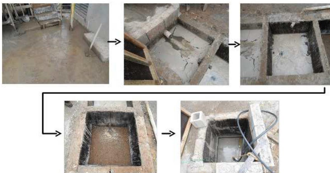
Figura 7 - Exemplo de 4 caixas em série que constituem um sistema para decantação e filtragem.
