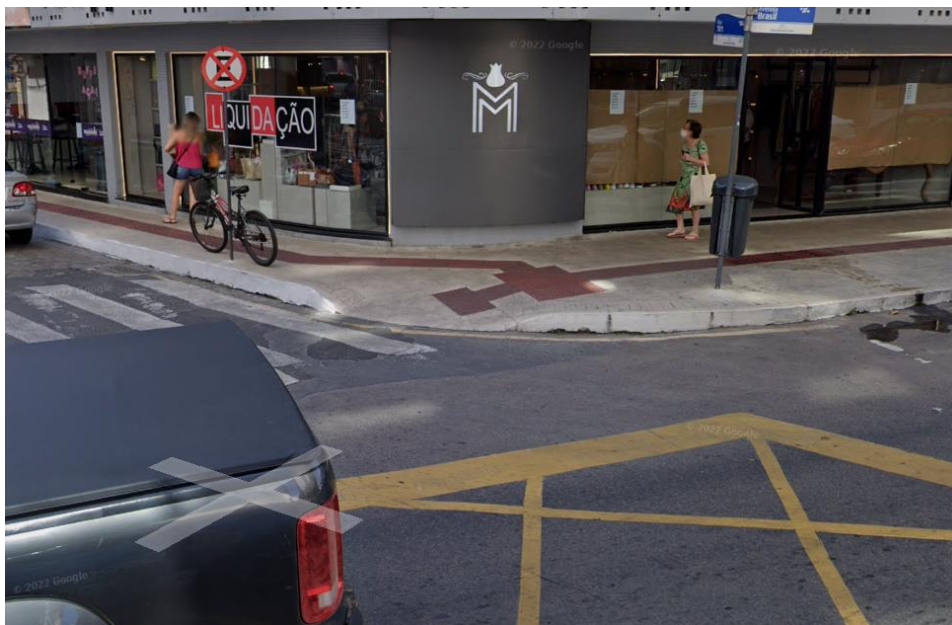
Figura 2 - Rebaixamento de acessibilidade na av. Brasil com Rua 701.
