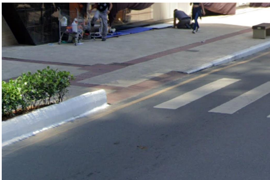
Figura 4 - Rebaixamento de acessibilidade na av. Brasil com Rua 511.
