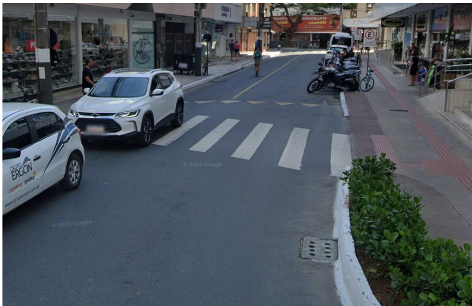
Figura 29 - Faixa elevada de pedestres na Rua 511, próximo da Av. Brasil.
