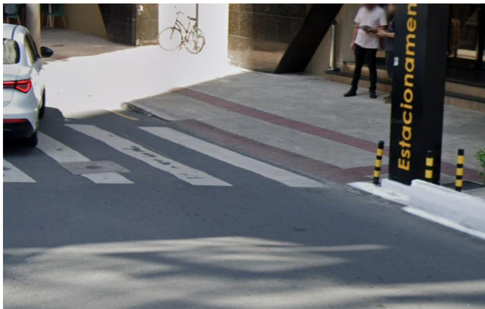
Figura 3 - Rebaixamento de acessibilidade na av. Brasil com Rua 511.
