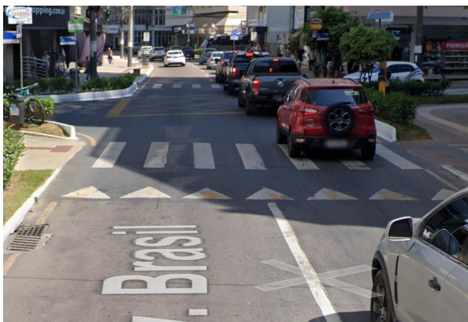
Figura 30 - Faixa elevada de pedestres na Av. Brasil, próximo da Rua 511.
