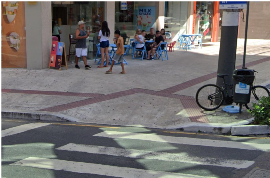
Figura 1 - Rebaixamento de acessibilidade na av. Brasil com Rua 701.
