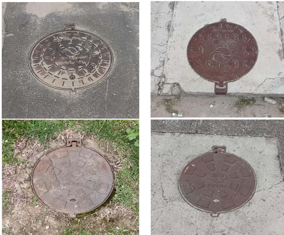
Figura 66 – Caixas de Inspeção da rede pública de coleta de efluentes sanitários na Av Rodesindo Pavan. Fonte: Autor, 2022.
