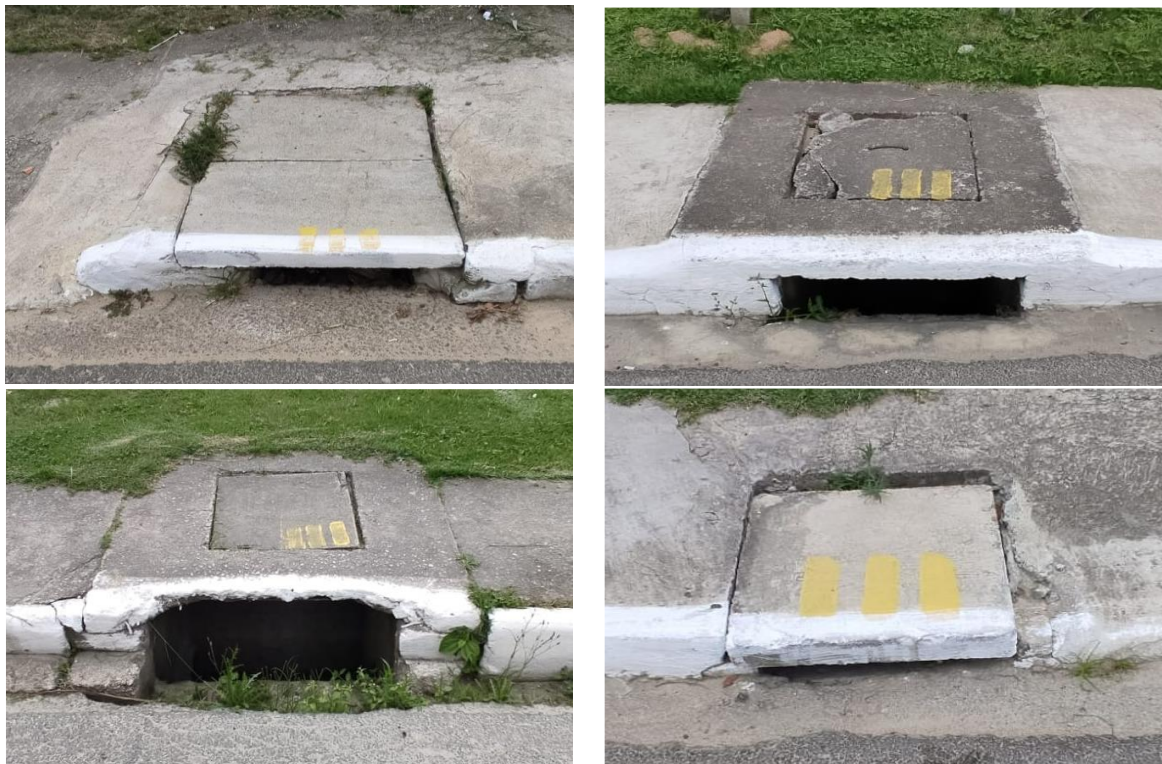
Figura 67 – Componentes do sistema de drenagem pluvial existentes na Av Rodesindo Pavan. Fonte: Autor, 2022.
