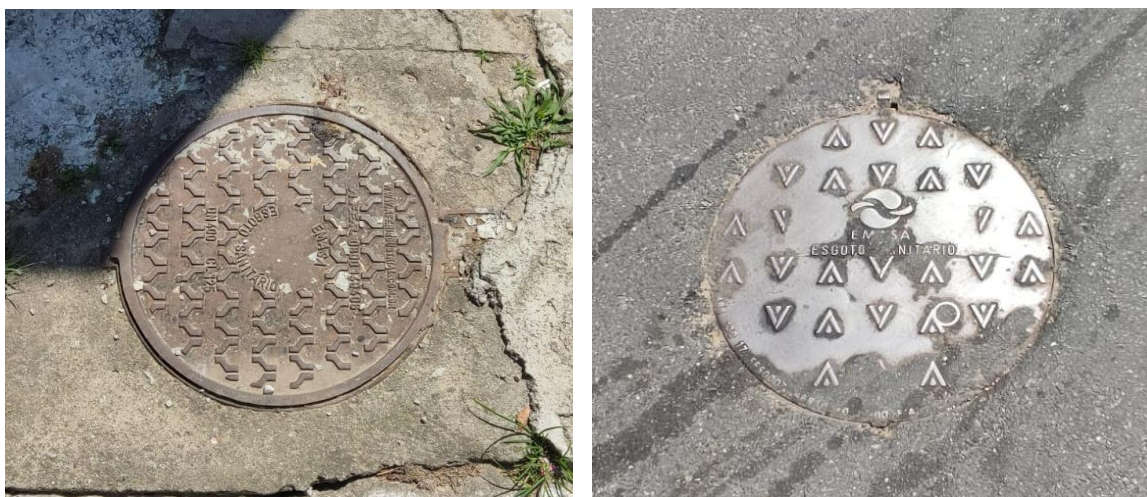
Figura 83 – Caixas de Inspeção da rede pública de coleta de efluentes sanitários no entorno. Fonte: Autor, 2023.
