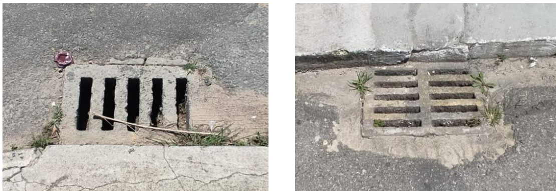
Figura 84 – Componentes do sistema de drenagem pluvial existentes no entorno. Fonte: Autor, 2023.
