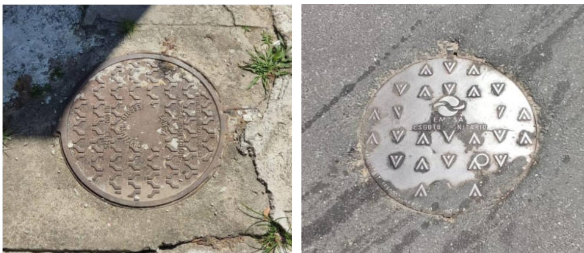
Figura 80 – Caixas de Inspeção da rede pública de coleta de efluentes sanitários no entorno. Fonte: Autor, 2023.
