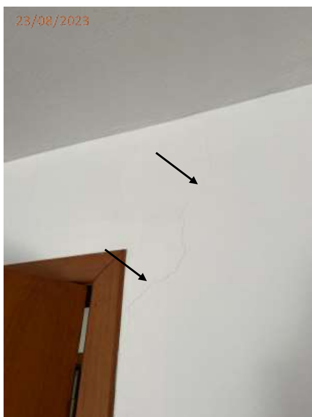
Fotos 03 e 04: Trinca na parede junto a porta de entrada e junto a porta da sacada.
