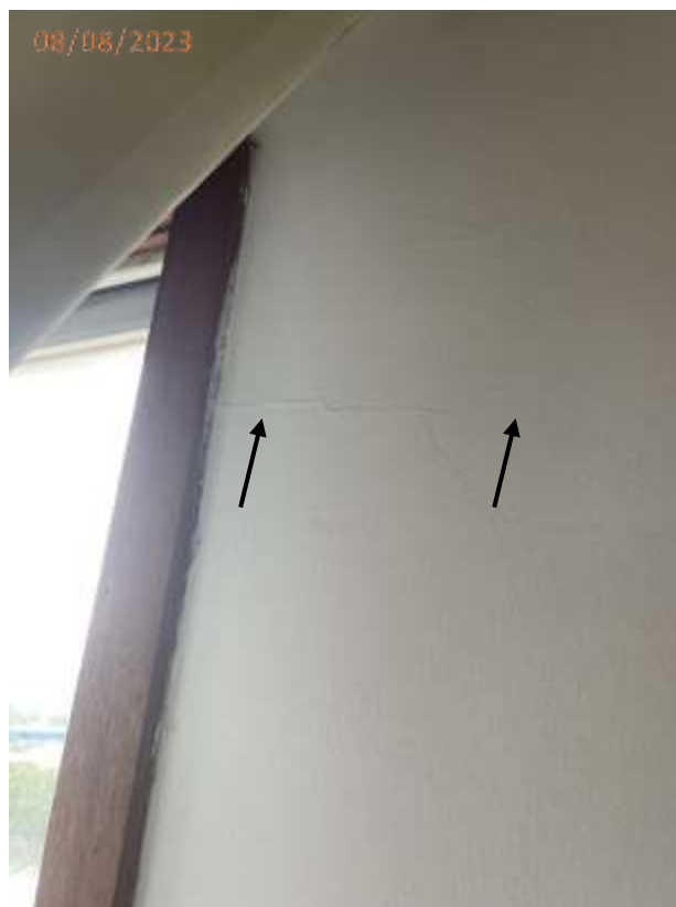
Fotos 06, 07, 08 e 09: Trincas na parede junto a janela da sala.
