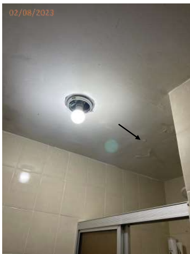
Fotos 12 e 13: Fissura no teto do banheiro da dependência.
