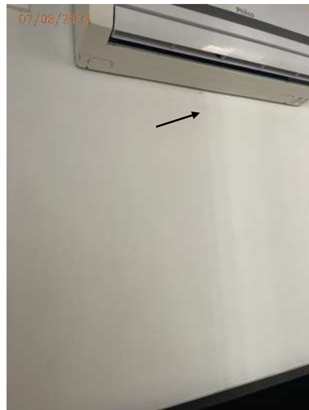
Fotos 10, 11, 12 e 13: Trinca nas paredes junto a janela e ar condicionado do dormitório.
