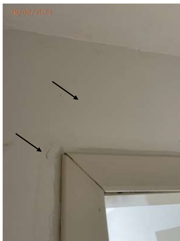
Fotos 10 e 11: Trinca na parede junto a porta do dormitório na circulação íntima.
