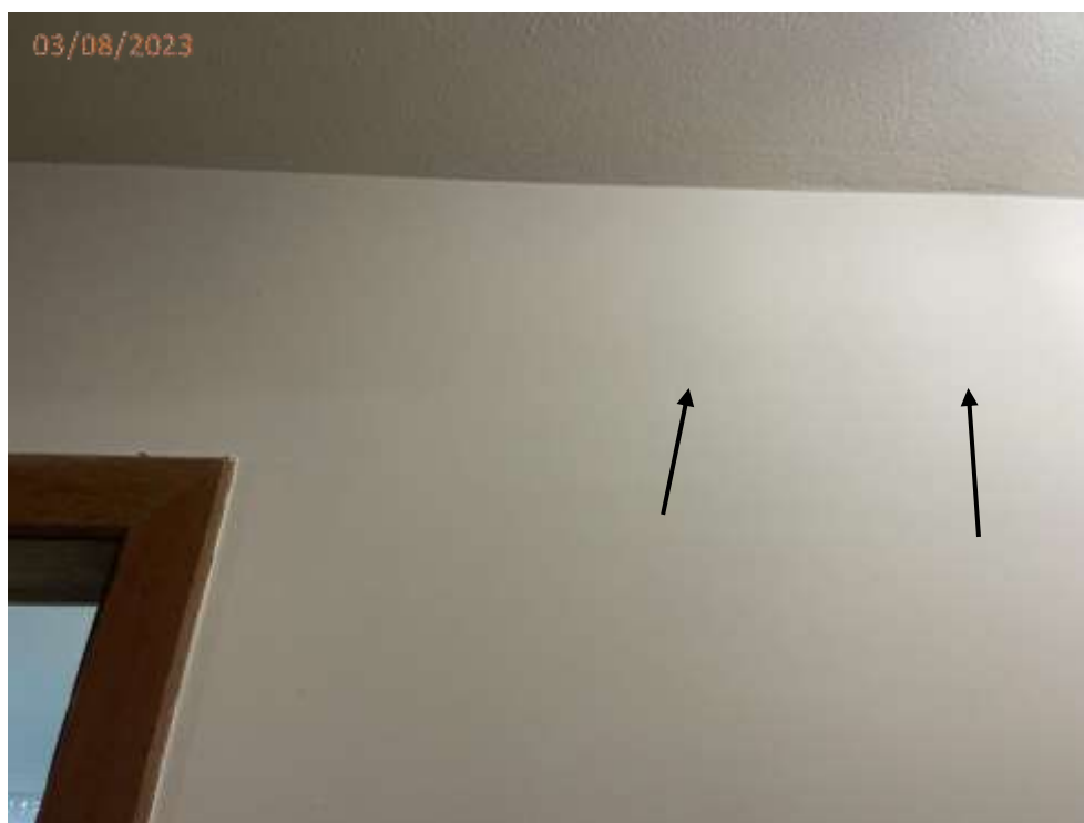
Fotos 12 e 13: Trinca na parede da circulação íntima junto a porta do banheiro.
