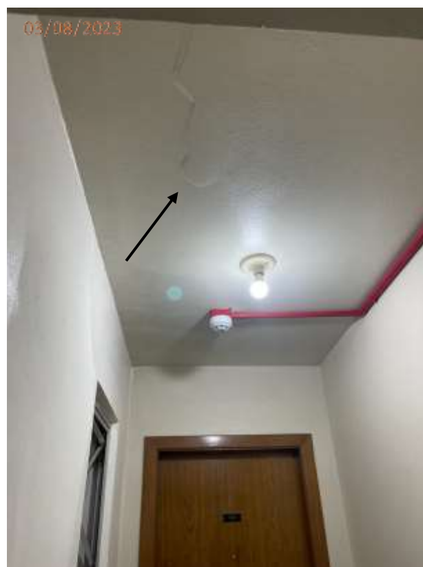
Fotos 38 e 39: Trincas e descolamento de revestimento no teto do hall do 10º andar.
