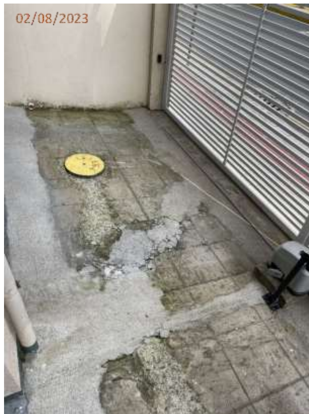
Fotos 43 e 44: Trincas e rachaduras generalizadas no piso da garagem lateral esquerda da edificação.
