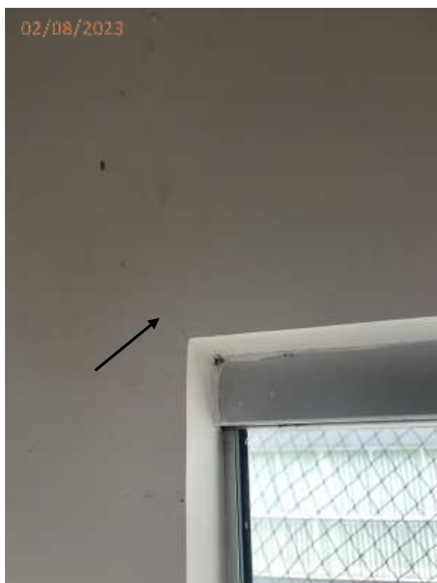
Foto 05: Fissura na parede junto a janela da sala de estar.
