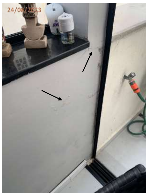
Fotos 05 e 06: Fissuras e sinais de umidade no peitoril da janela da sala.
