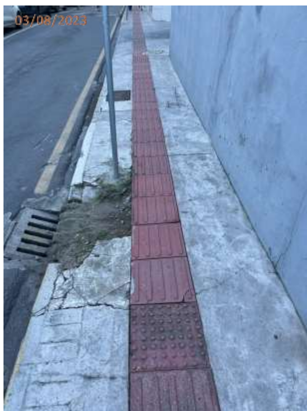
Fotos 131 e 132: Trincas e rachaduras no piso da calçada
