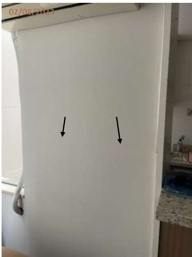
Foto 03: Fissura na parede junto ao ar condicionado na sala de estar.
