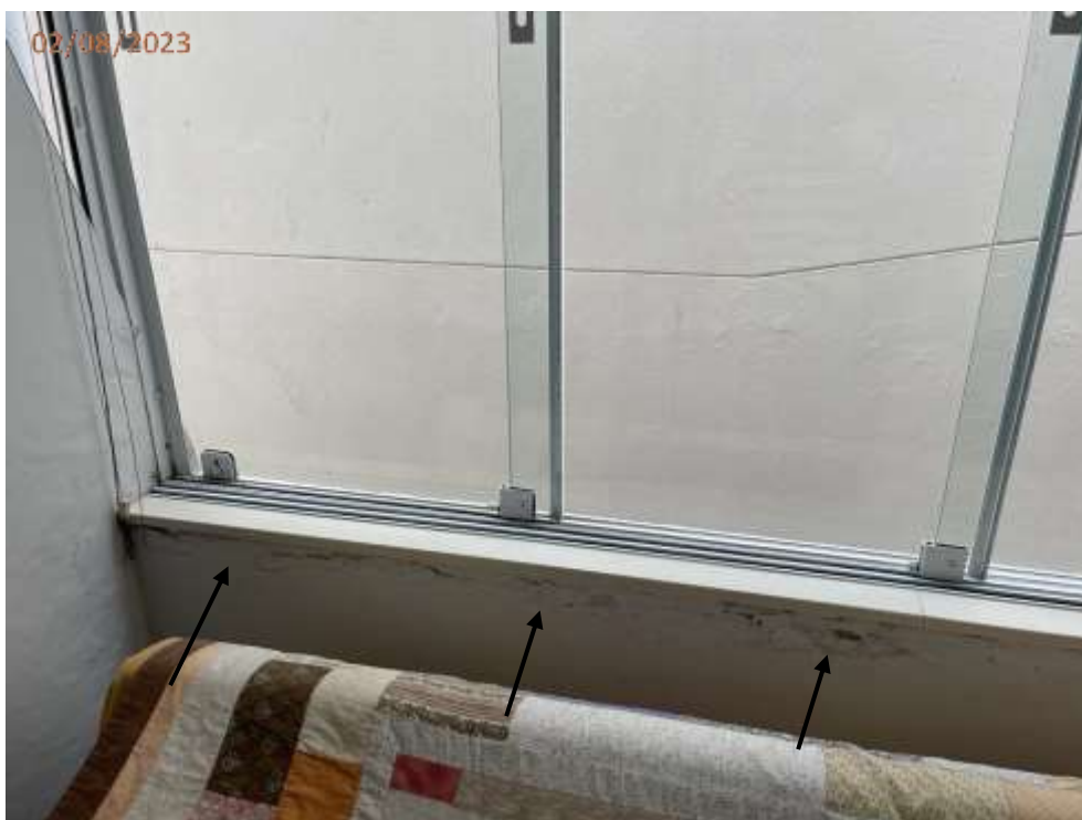
Foto 04: Trinca na parede junto a janela da sala de estar.
