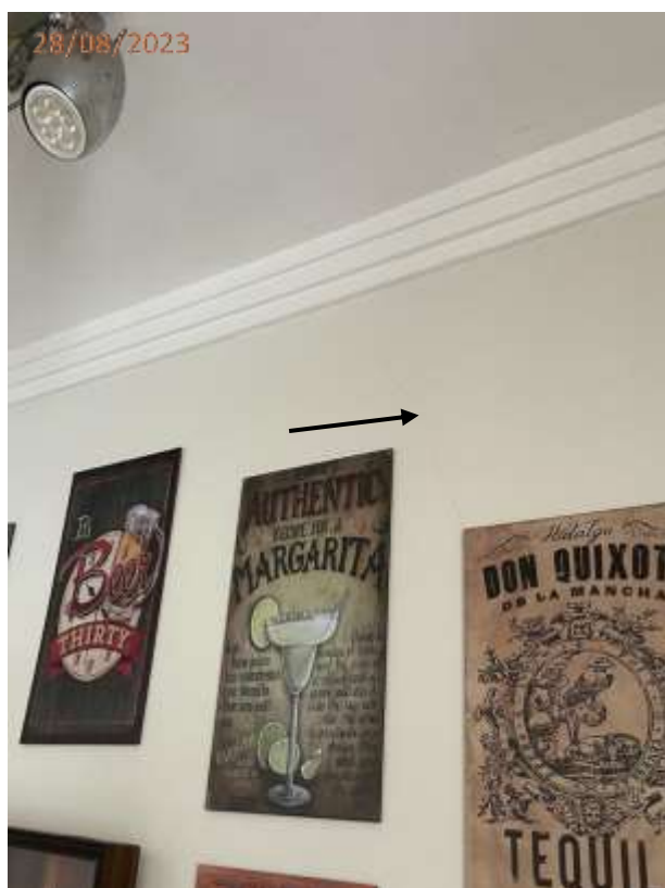
Fotos 16 e 17: Trincas na parede junto aos quadros na ante sala e junto a porta de acesso ao banheiro.
