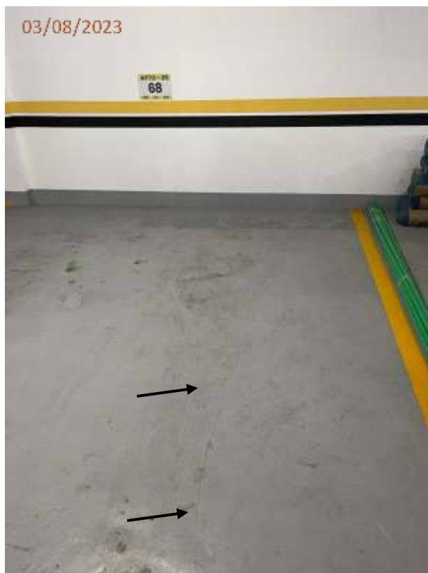
Foto 82: Trincas no piso junto a vaga V68.
