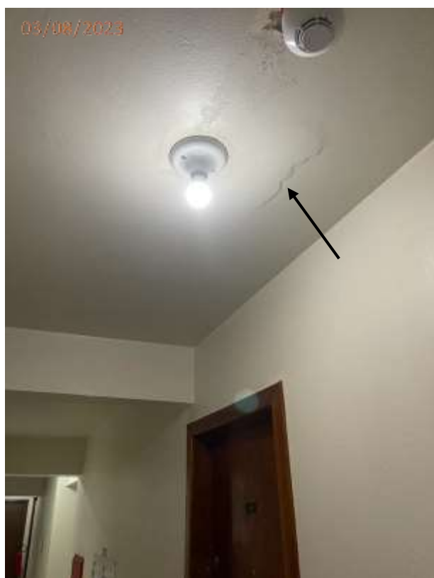
Foto 19: Descolamento de revestimento no teto do hall do 20º andar.
