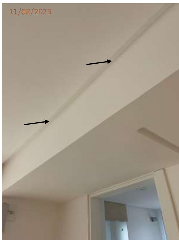
Foto 05: Trinca no teto da sala de estar.
