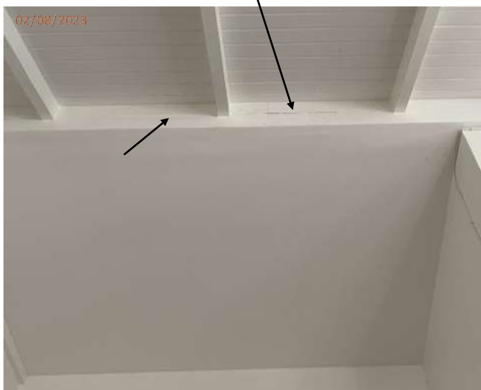
Fotos 06, 07 e 08: Trinca na parede da sala junto a porta de acesso a área íntima e junto a cobertura.
