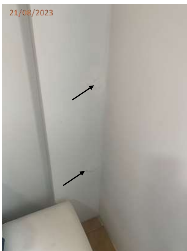
Fotos 13, 14 e 15: Trinca nas paredes do dormitório.
