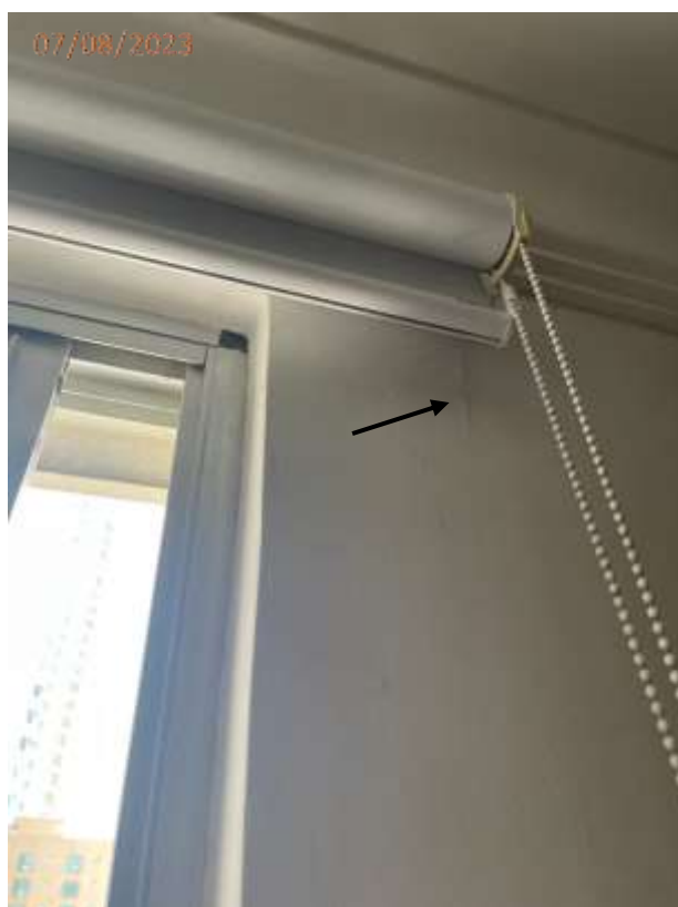
Fotos 10, 11, 12 e 13: Trinca nas paredes junto a janela e ar condicionado do dormitório.
