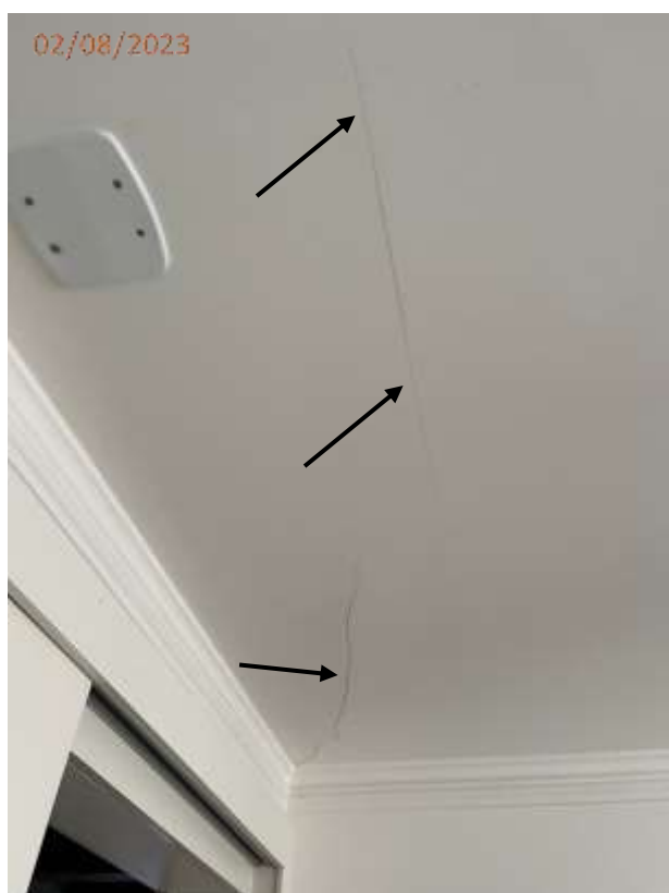
Fotos 08 e 09: Trinca no teto e vidro quebrado na janela do dormitório.
