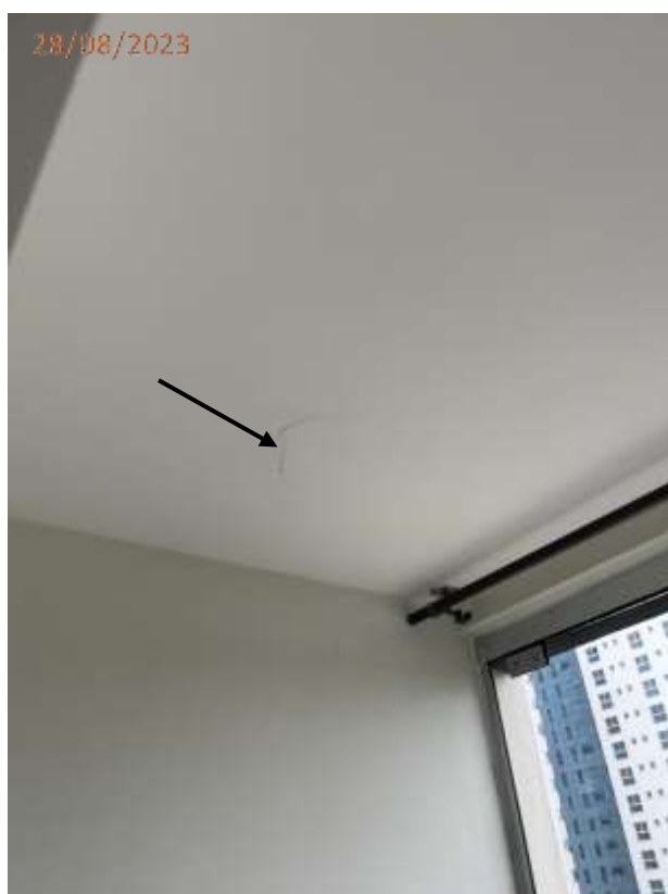
Fotos 07 e 08: Descolamento de revestimento no teto da sala.
