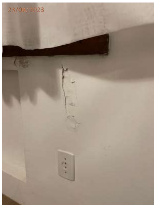
Fotos 10 e 11: Trinca e descolamento de revestimento na parede junto a janela do dormitório.
