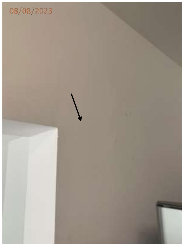
Fotos 10 e 11: Fissura na parede da cozinha junto ao vão de acesso a sala.
