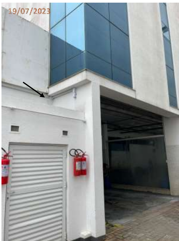
Fotos 91 e 92: Trincas nas paredes da central de gás.
