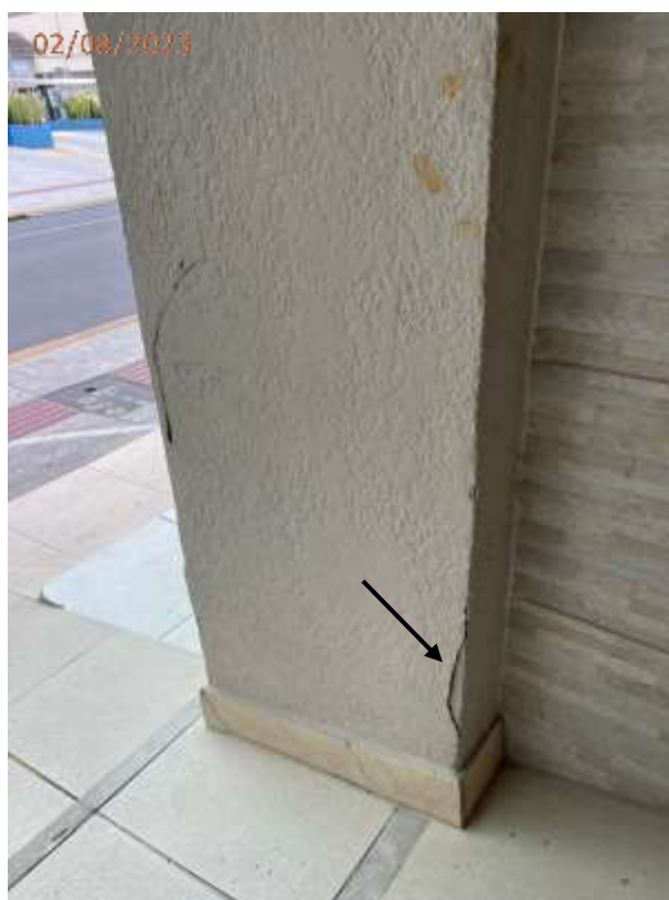
Fotos 22 e 23: Trincas nas paredes do hall de entrada do térreo.
