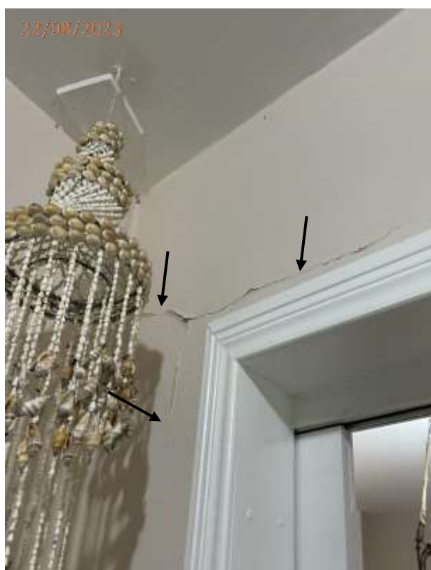
Fotos 08, 09, 10 e 11: Trinca nas paredes da área de acesso ao dormitório.
