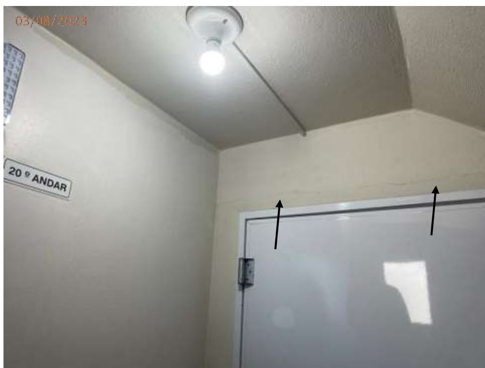
Fotos 14 e 15: Trincas na parede da escada do 20º andar.
