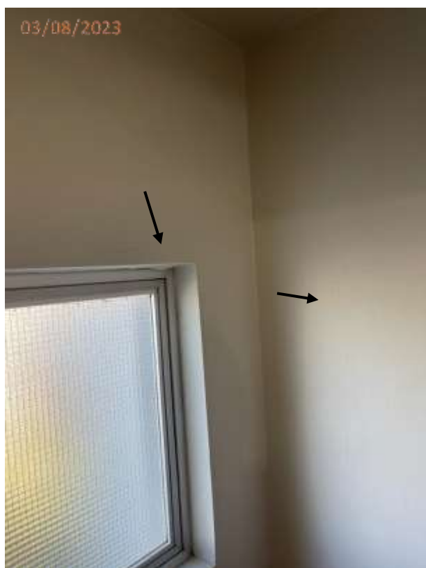
Foto 55: Fissura na parede ao lado janela na escada do 4º andar.
