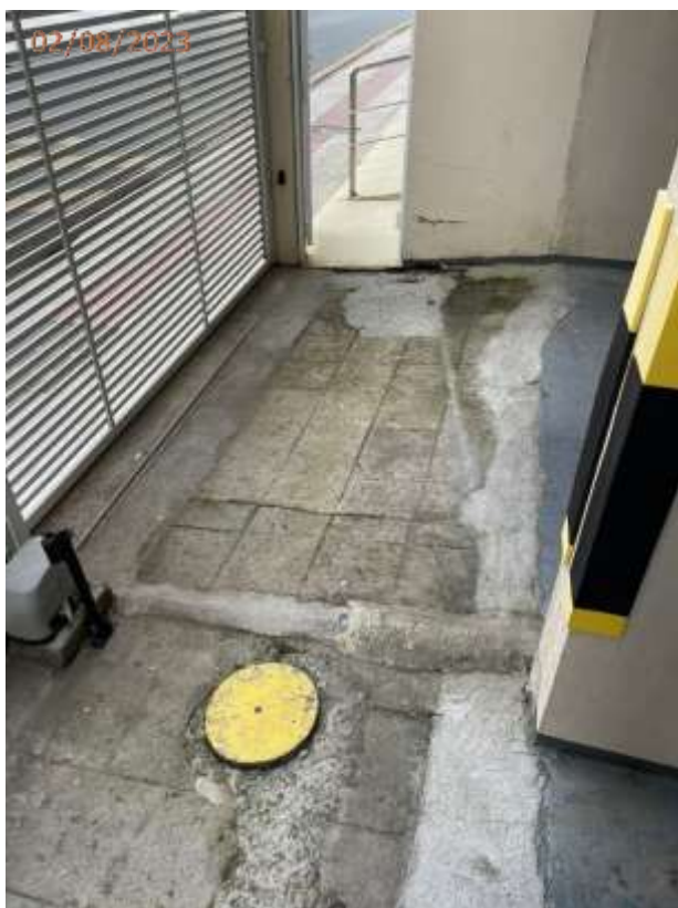
Fotos 43 e 44: Trincas e rachaduras generalizadas no piso da garagem lateral esquerda da edificação.
