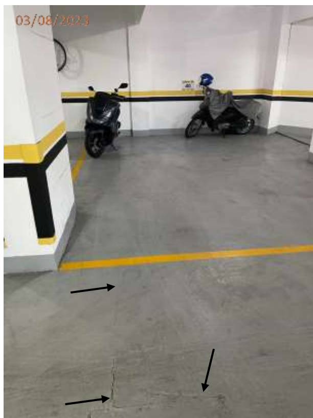
Foto 93: Trinca no piso da circulação junto a vaga V40.
