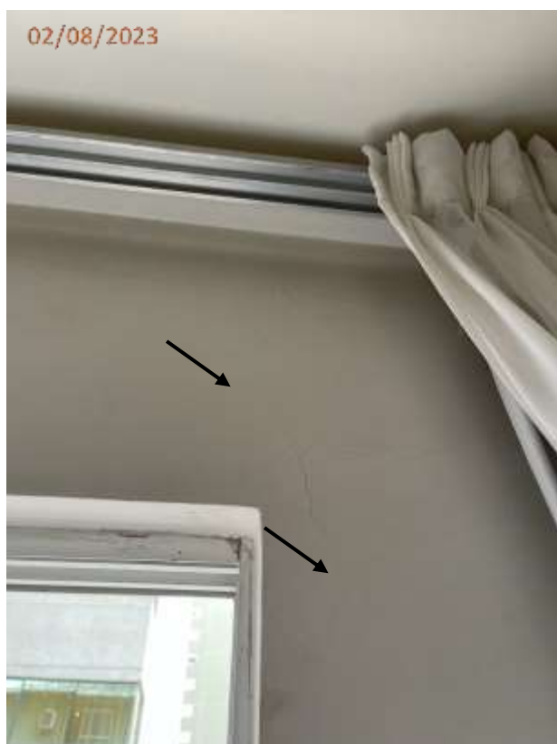
Foto 21: Fissura na parede da suíte junto a porta de acesso a sacada.
