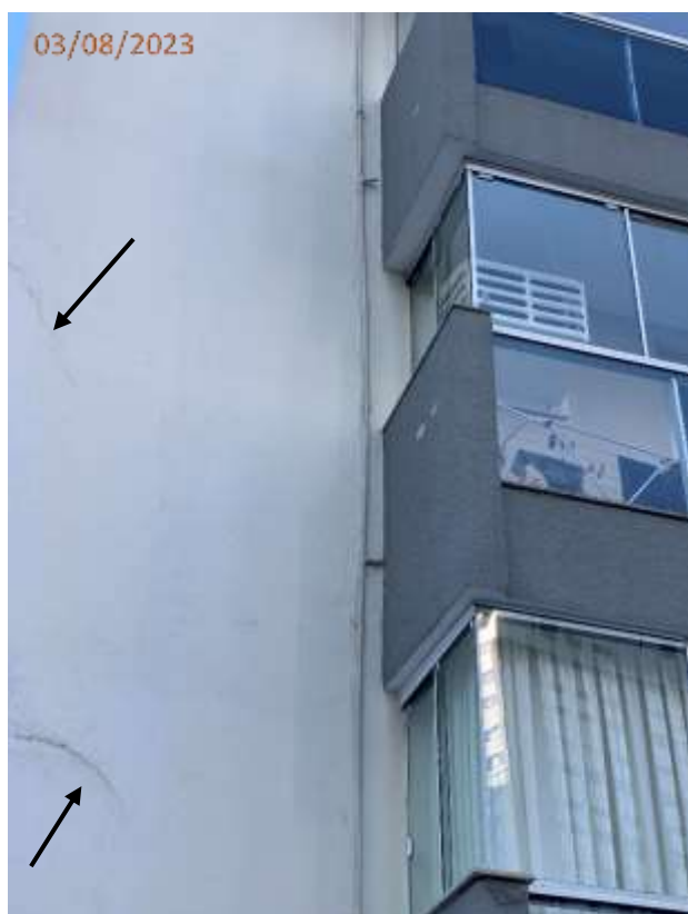
Fotos 157 e 158: Trincas na fachada lateral esquerda.
