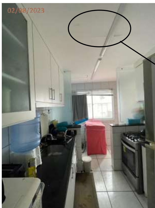
Fotos 14 e 15: Trinca no teto da cozinha.
