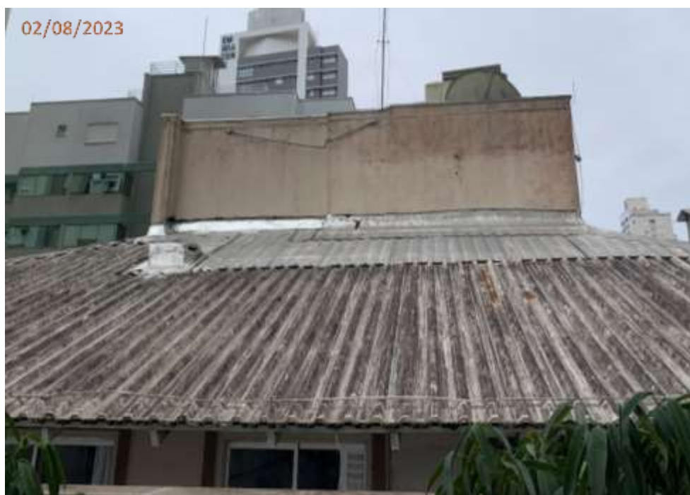
Foto 56: Trincas e sinais de desgaste do revestimento na fachada da caixa d'água.
