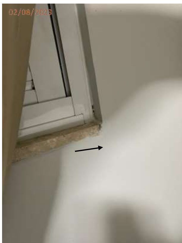
Fotos 07 e 08: Fissura na parede junto a janela do dormitório.
