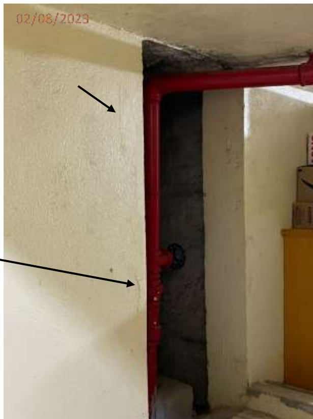
Fotos 06, 07 e 08: Trinca na parede da área de acesso ao barrilete.
