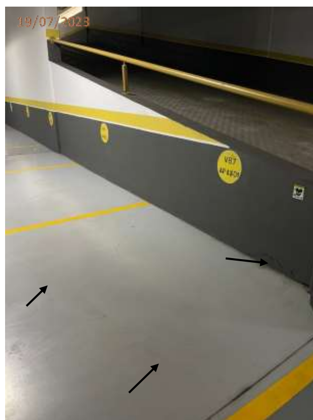
Fotos 60 e 61: Trincas no piso junto a rampa de acesso a G2 e na vaga V87.
