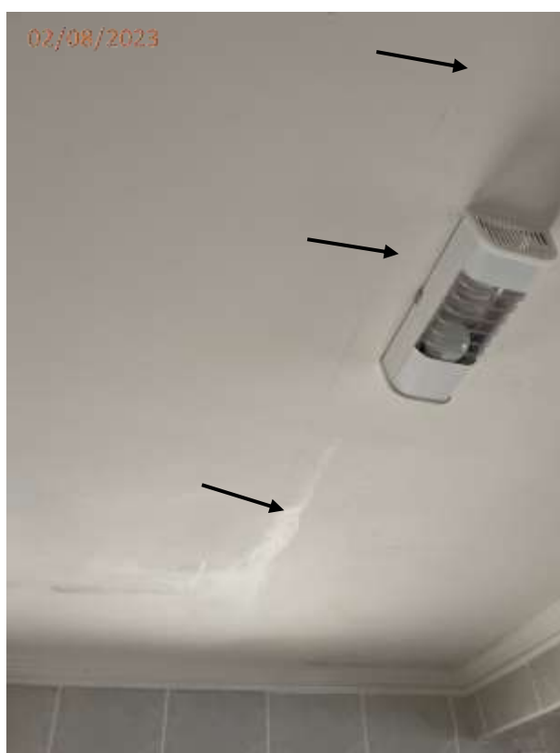
Fotos 09 e 10: Fissura no teto da cozinha.
