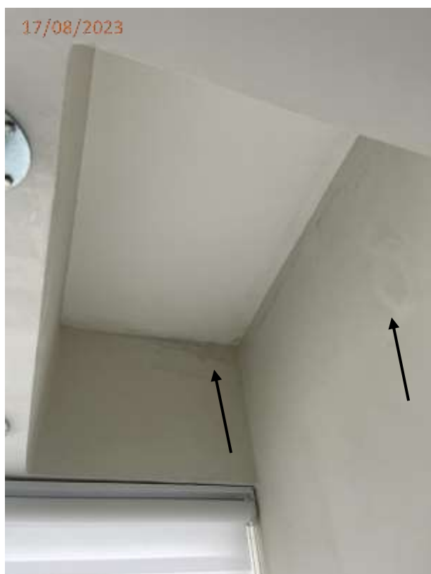
Fotos 05, 06 e 07: Trincas no teto e viga da sala de estar.
