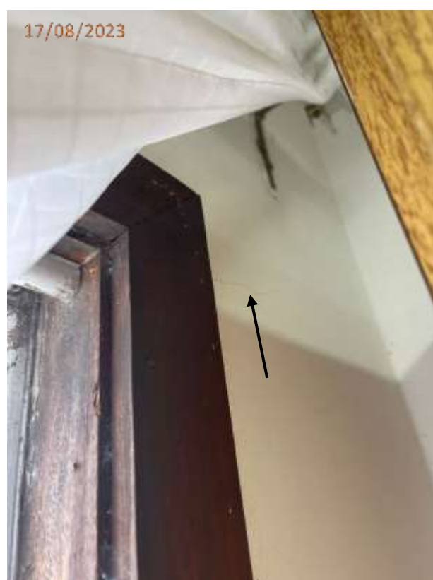
Fotos 06 e 07: Fissura na parede junto a janela da da cozinha/área de serviço.
