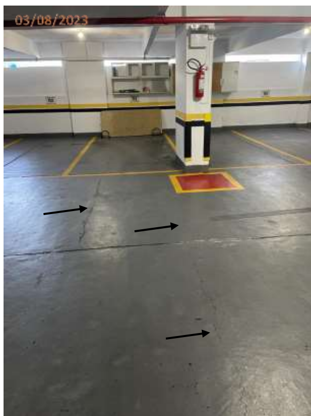
Foto 75: Trincas no piso da circulação de veículos em frente a vaga V98.
