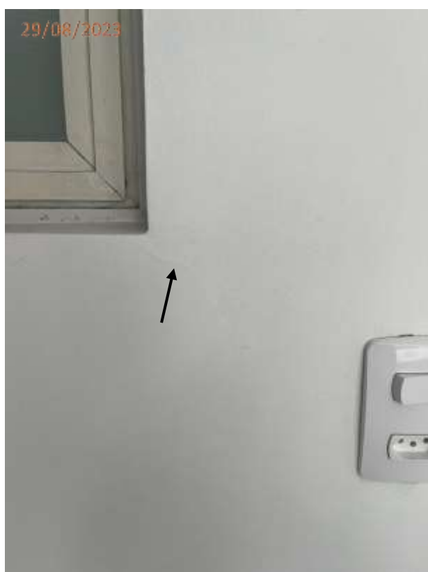
Fotos 06 e 07: Fissuras junto a janela na área de serviço.
