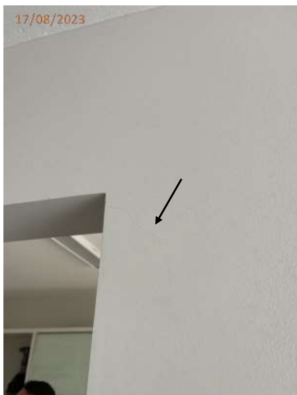
Fotos 03 e 04: Trinca junto ao vão e no teto da sala de estar.
