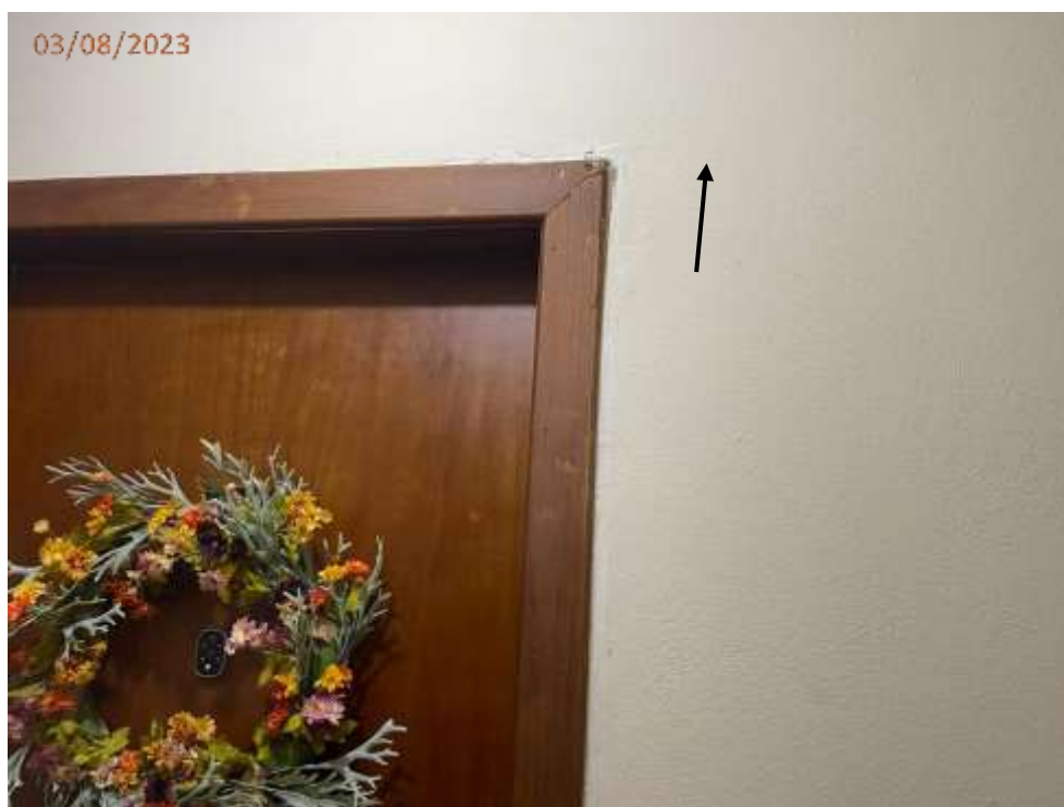
Foto 30: Fissura na parede junto a porta do Apto 165 no hall do 16º andar.
