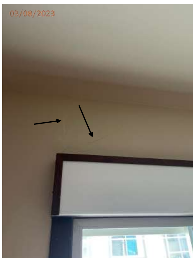
Fotos 17, 18 e 19: Trinca nas paredes junto a janela e Tv do dormitório.
