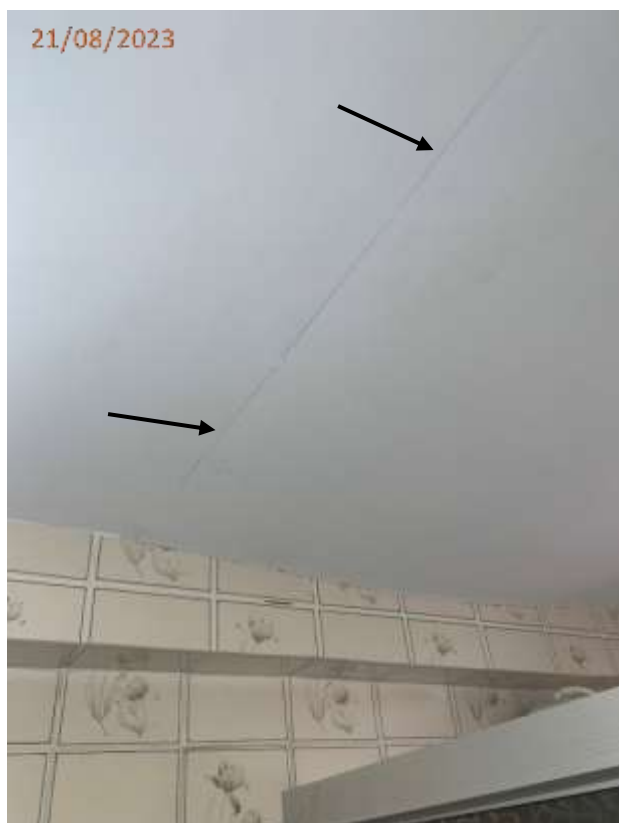
Fotos 16, 17 e 18: Trincas no teto da área do banheiro.
