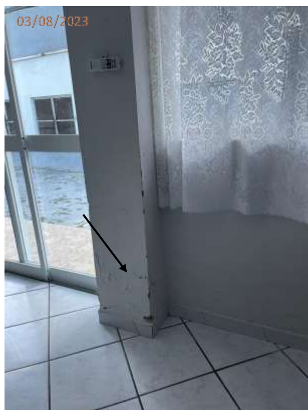
Fotos 129 e 130: Trinca e sinais de umidade na parede do salão de festas da área lateral direita da edificação.
