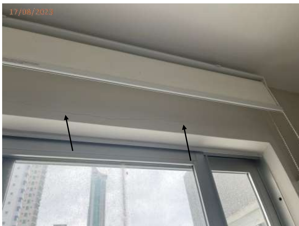
Fotos 08, 09 e 10: Trincas na parede junto a janela da área de serviço.
