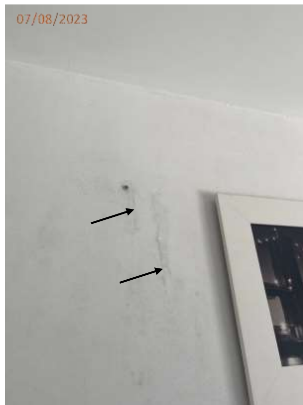
Fotos 27 e 28: Trinca na parede junto a cabeceira da cama do dormitório.
