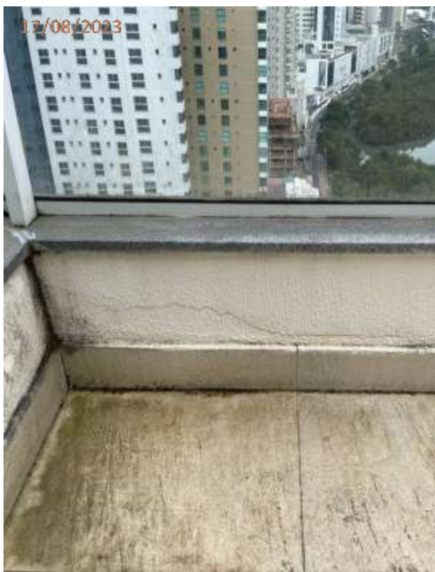
Fotos 37 e 38: Trincas no peitoril do terraço.
