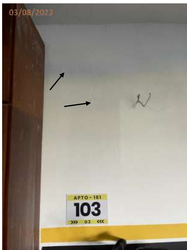
Fotos 68 e 69: Trinca na parede e pilar junto a vaga V103.
