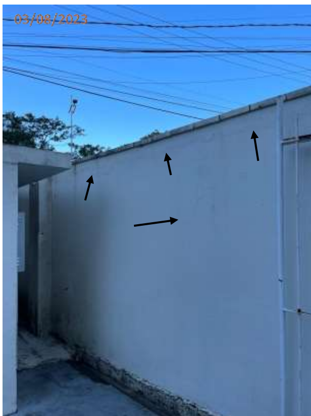
Foto 117: Trincas no muro da área externa.
