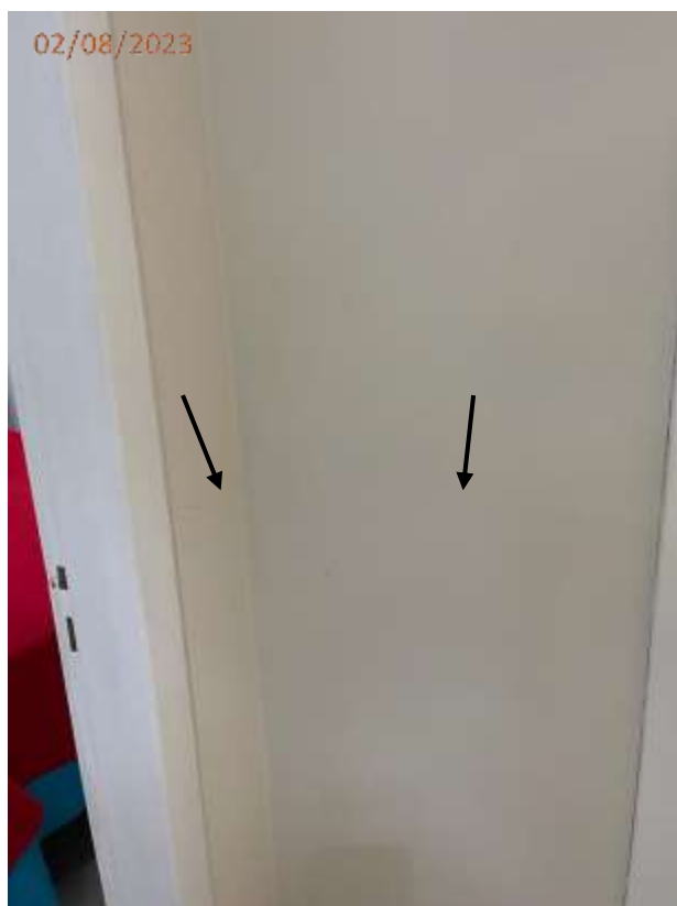
Fotos 11 e 12: Trincas na parede da circulação íntima junto a porta do dormitório e bwc.
