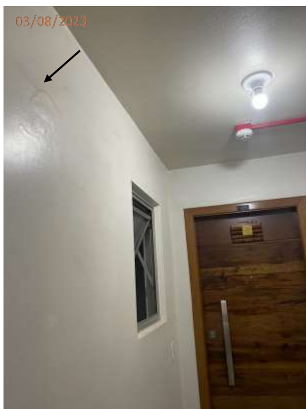
Fotos 35 e 36: Fissura na parede junto a porta do Apto 125 e na parede ao lado do Apto 121 no hall do 12º andar.
