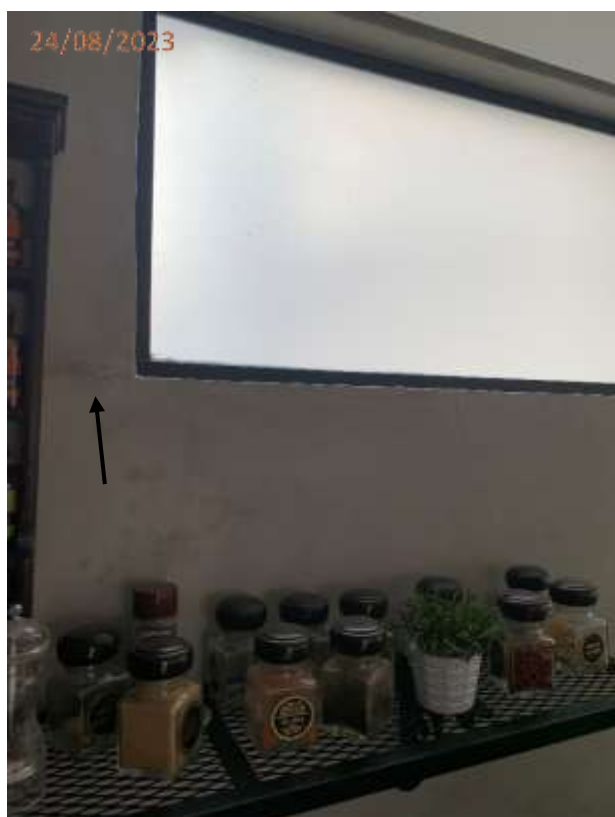
Foto 03: Fissura junto a janela da sala.
