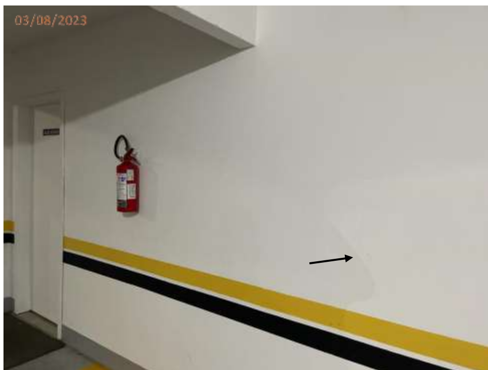
Foto 111: Trinca na parede de divisa com salão de festas.
