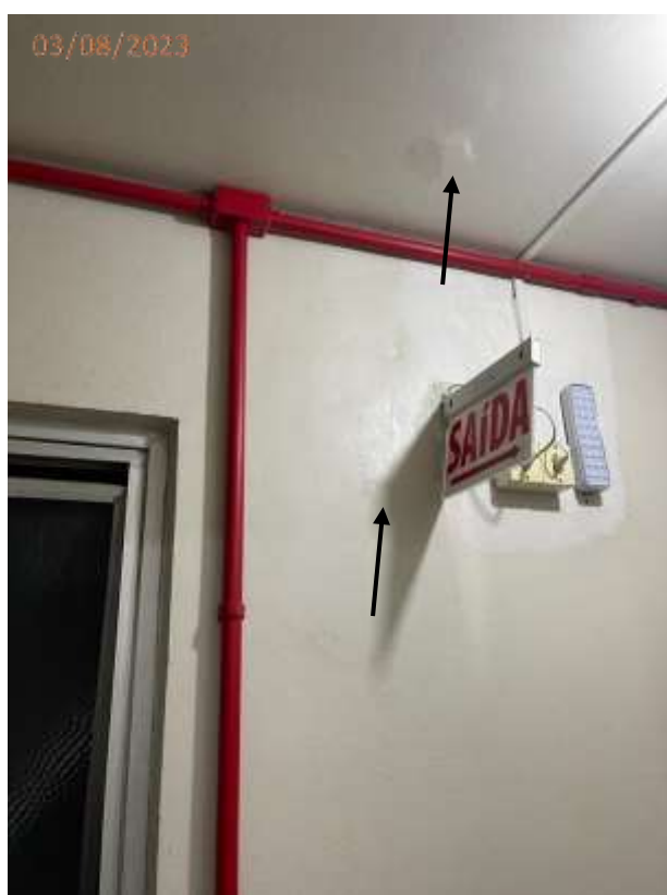
Foto 48: Trinca na parede do hall do 7º andar.
