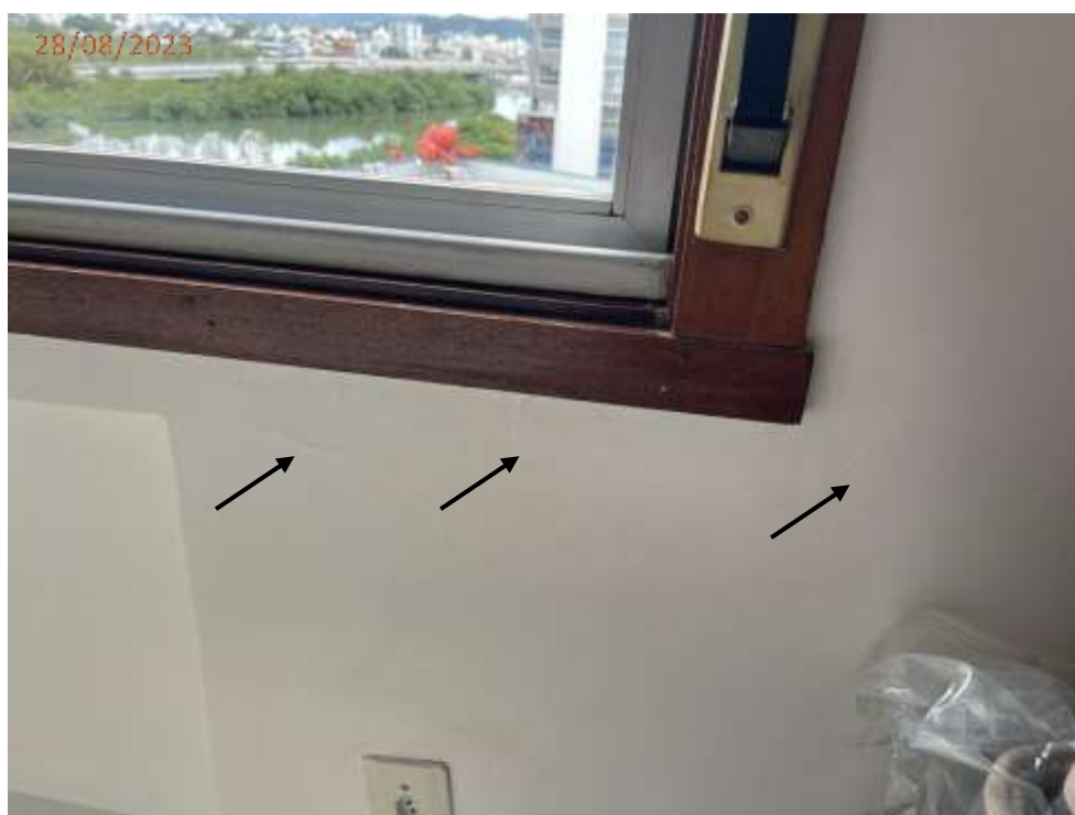
Fotos 09, 10 e 11: Fissura na parede junto ao ar condicionado e junto a janela no dormitório.
