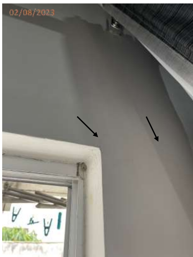
Foto 03: Fissura na parede junto a porta de acesso a sacada.
