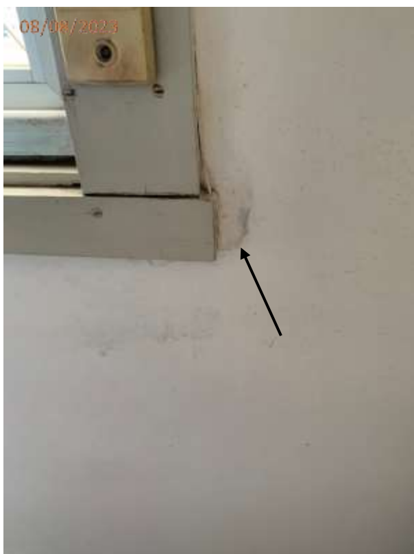
Foto 08: Trinca na parede junto a janela do dormitório.
