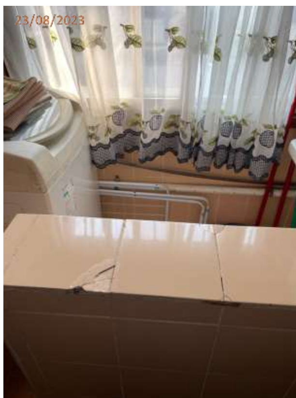
Fotos 07 e 08: Azulejos quebrado e trinta no teto da área de serviço.
