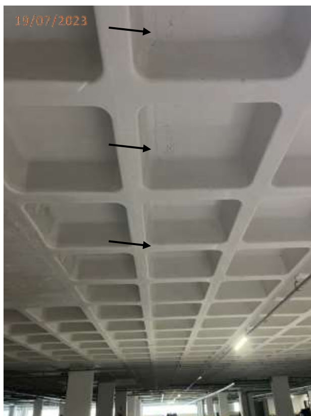
Foto 48: Trinca no teto da circulação de veículos em frente a vaga V359.
