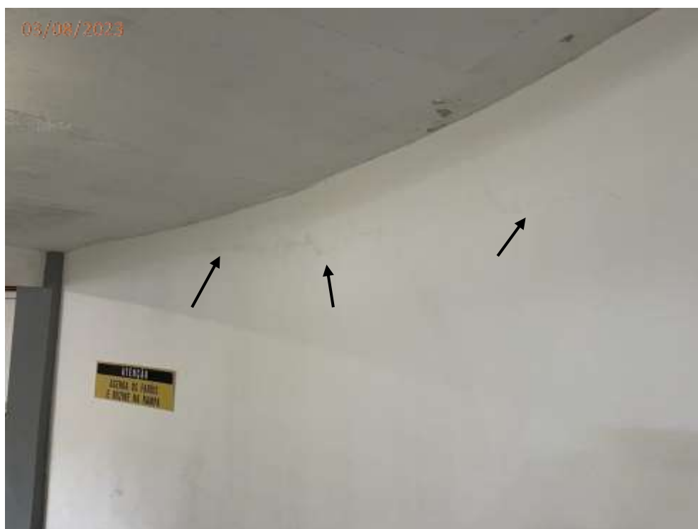
Foto 101: Trinca na parede da rampa.
