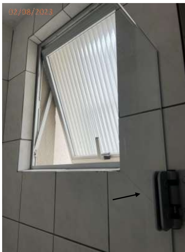
Fotos 08, 09 e 10: Trinca no teto e azulejo quebrado no banheiro social.
