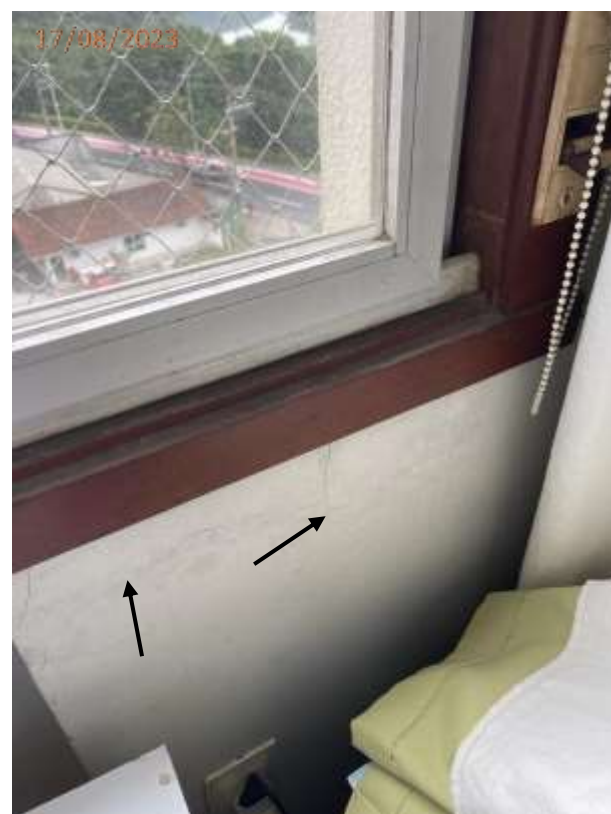
Fotos 11, 12, 13 e 14: Fissura no teto e trincas junto a janela do dormitório.
