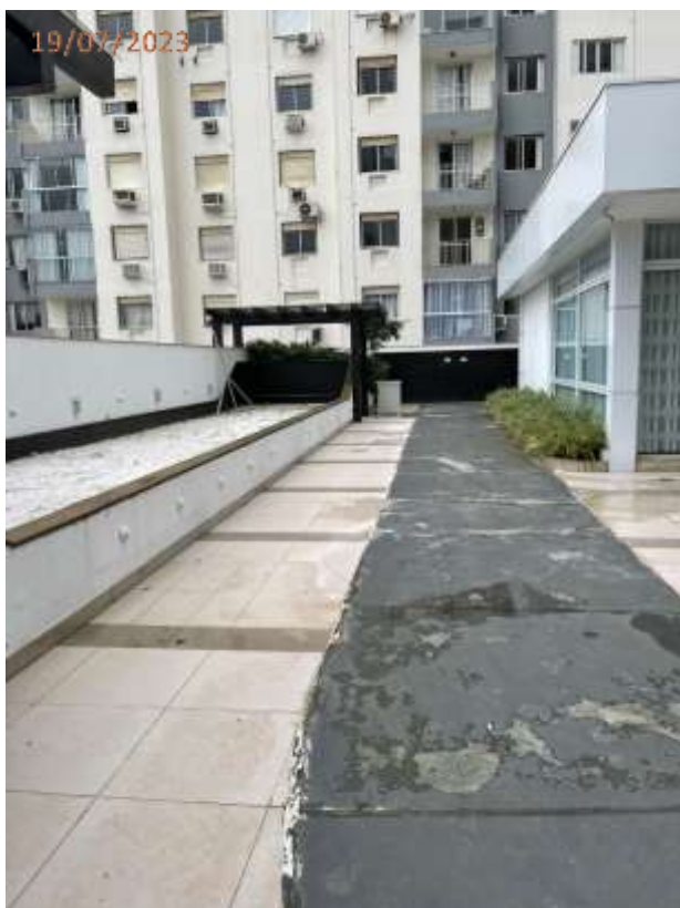
Foto 18: Descolamento de revestimento do pois de caminhada junto a cancha de bocha.
