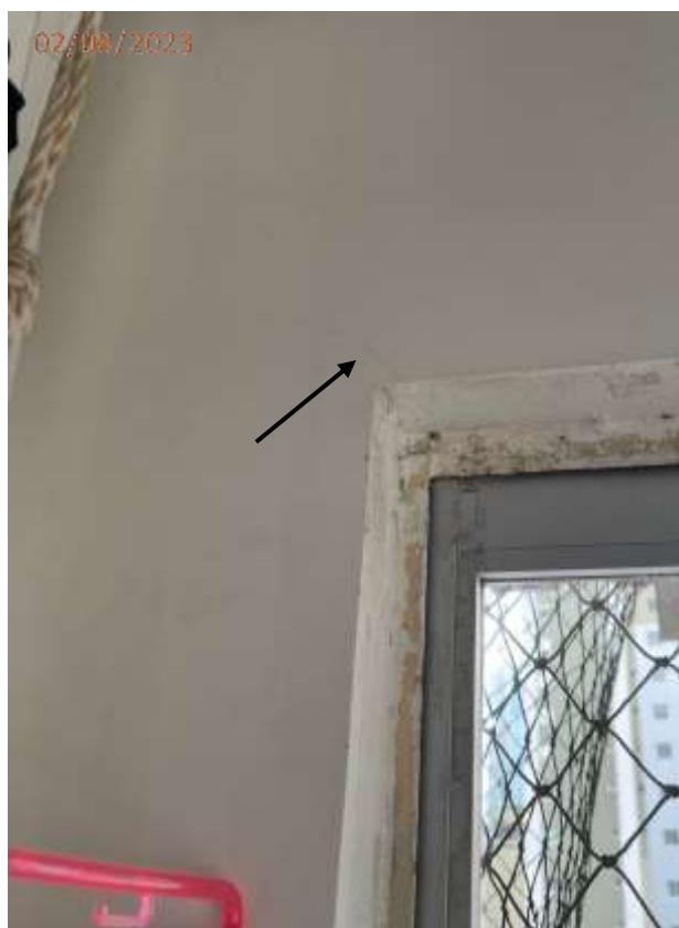
Fotos 04 e 05: Fissura na parede junto a janela frota na sala de estar.
