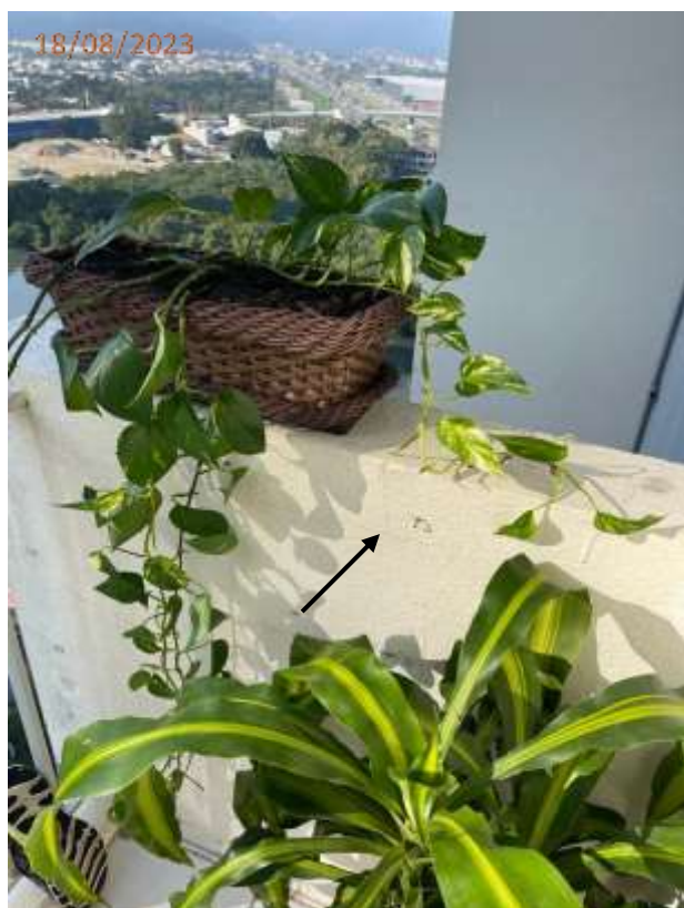
Foto 04: Trincas no peitoril da sacada.
