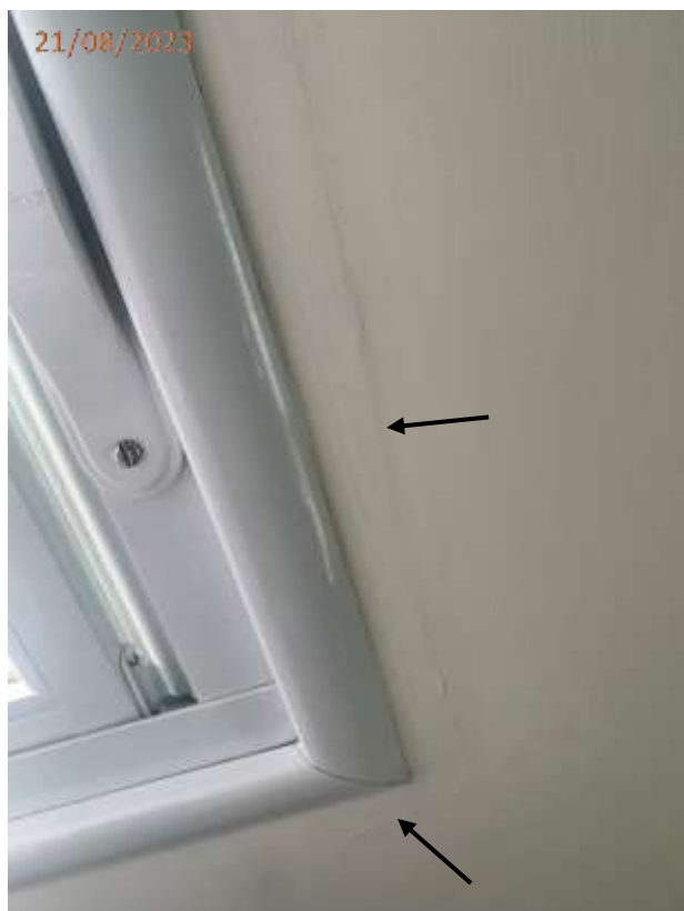
Foto 17: Trinca na parede junto a janela do dormitório.
