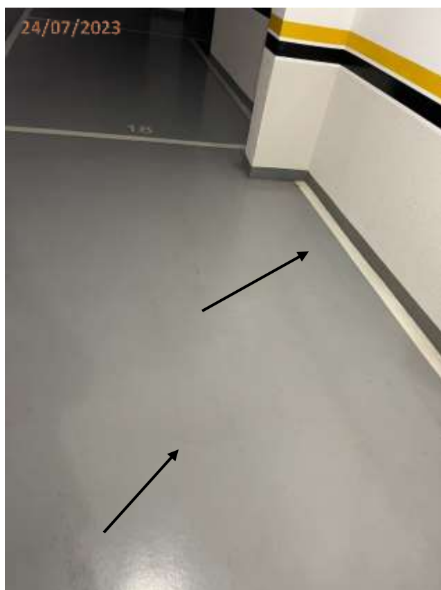
Foto 53: Trinca no piso junto a vaga V19.
