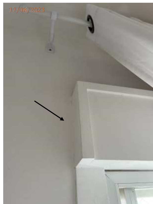
Fotos 12, 13, 14 e 15: Trinca na parede ao lado da porta e junto a janela do dormitório.
