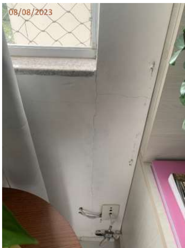
Fotos 02 e 03: Trinca na parede junto a janela da sala de estar.
