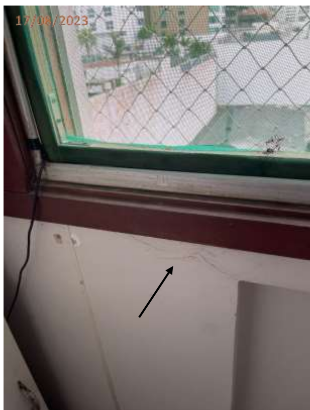
Fotos 11, 12, 13 e 14: Fissura no teto e trincas junto a janela do dormitório.
