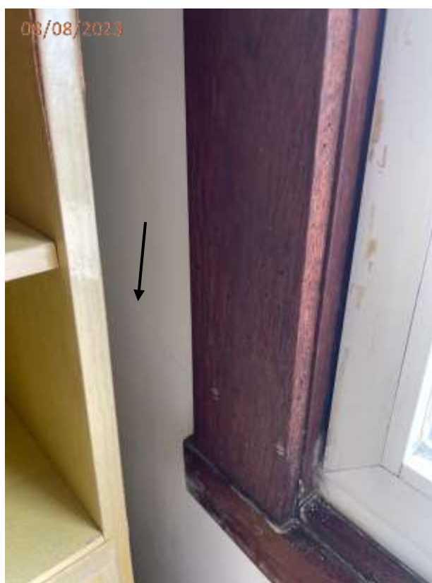
Fotos 16, 17, 18 e 19: Trinca na parede junto a cabeceira da cama e junto a janela do dormitório.
