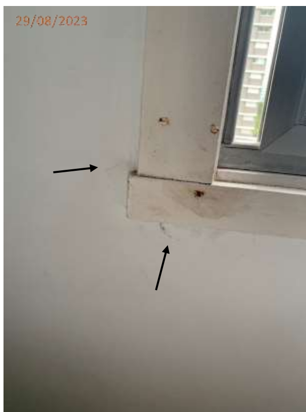
Fotos 08, 09 e 10: Trincas na parede junto a janela do dormitório.
