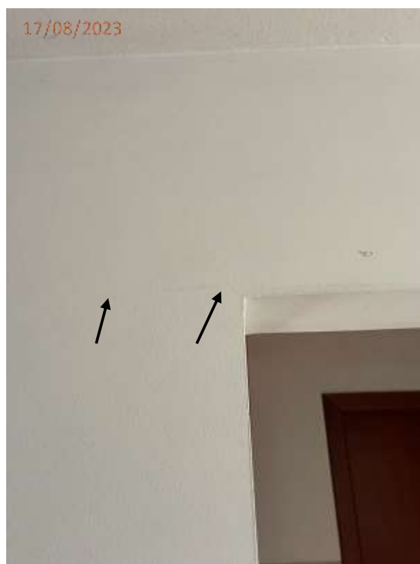
Fotos 03 e 04: Fissura na parede ao lado do quadro e junto ao vão da de acesso a área íntima.
