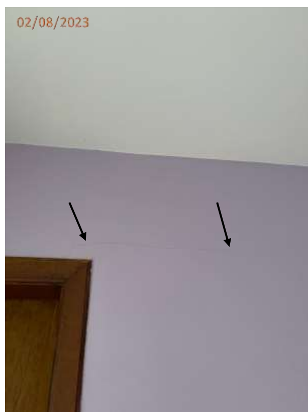
Fotos 16 e 17: Trinca na parede da dep. de empregada junto a porta.
