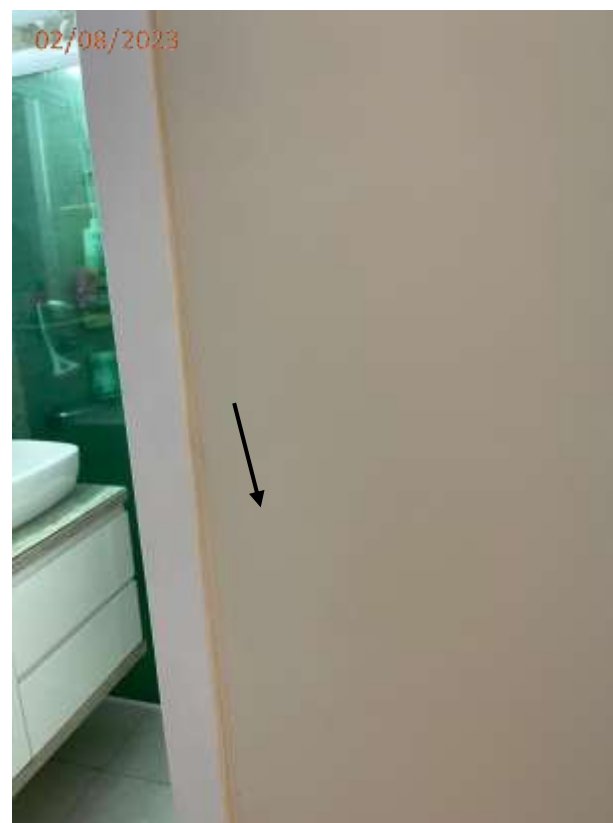
Fotos 11 e 12: Trincas na parede da circulação íntima junto a porta do dormitório e bwc.
