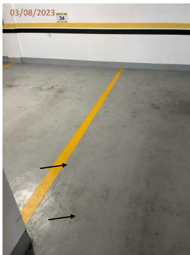
Fotos 94 e 95: Trincas no piso da circulação junto a vaga V37 e na vaga V35.
