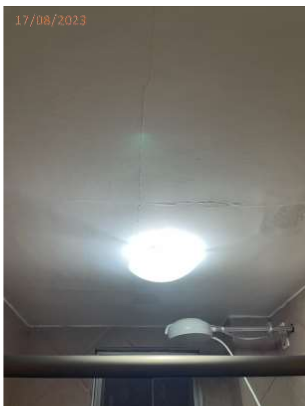
Fotos 10 e 11: Trincas no teto e decolamento de revestimento na parede do banheiro.
