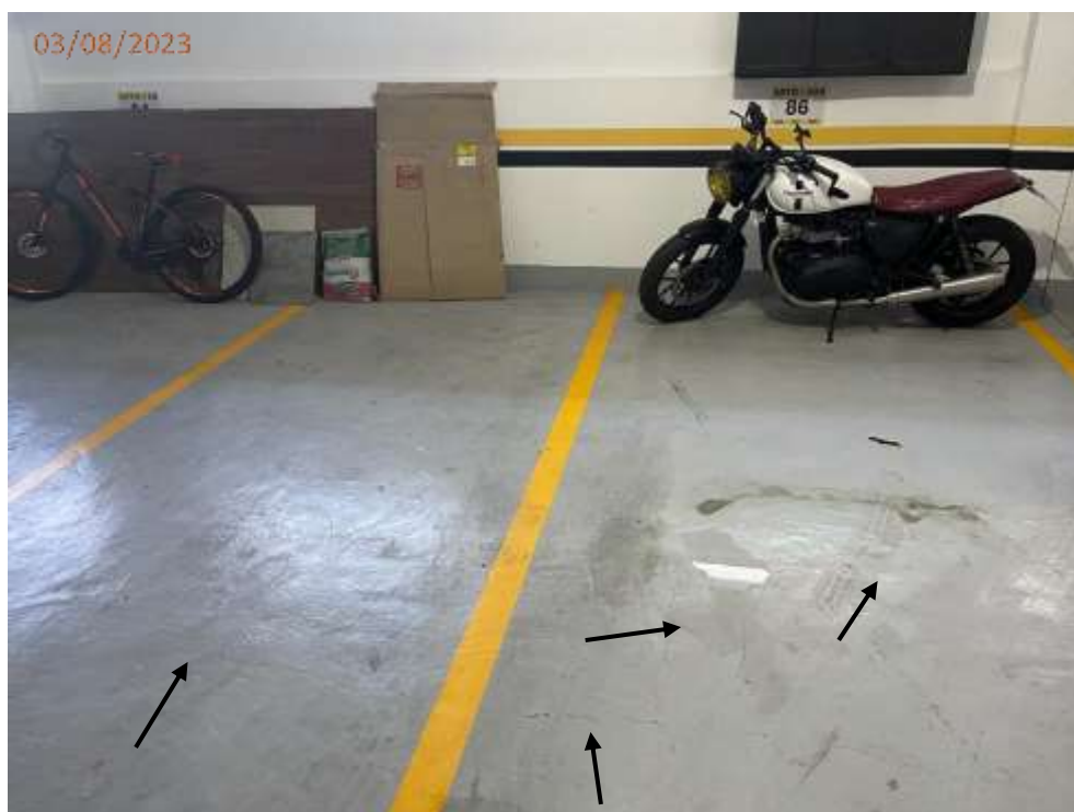
Foto 89: Trinca no piso junto a vaga V86.
