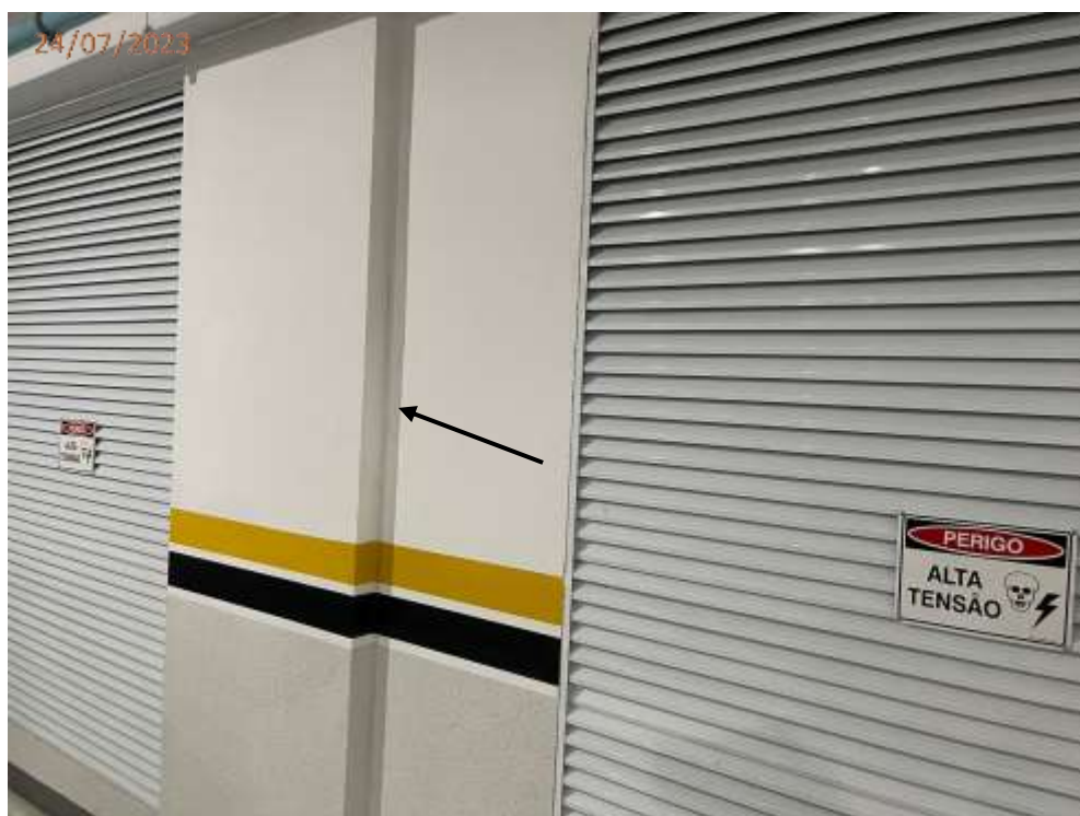
Foto 58: Trinca na parede junto ao transformador.
