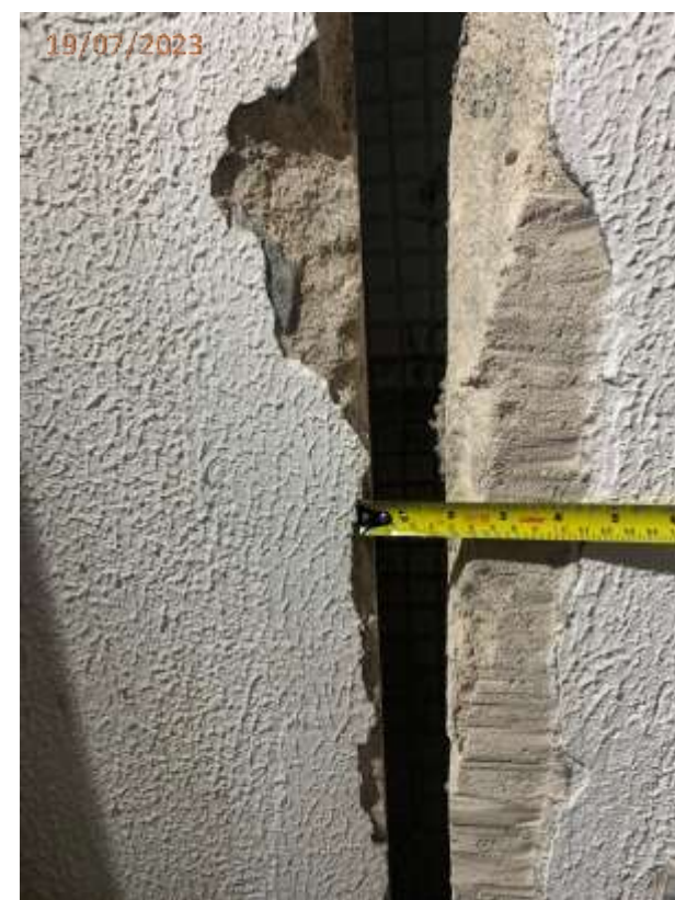
Fotos 111, 112, 113 e 114: Abertura na parede da passarela ao lado da porta de acesso da torre central.
