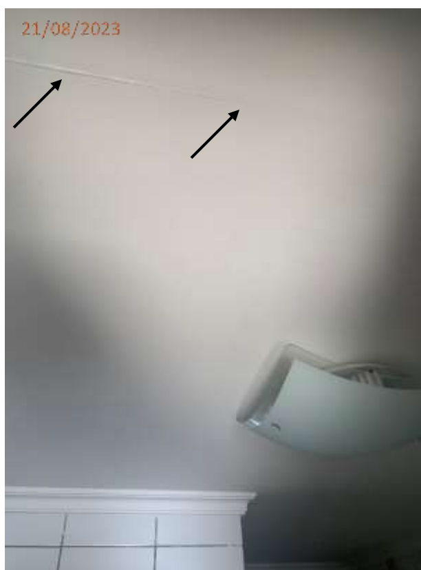
Fotos 25 e 26: Trinca no teto do banheiro da suíte.
