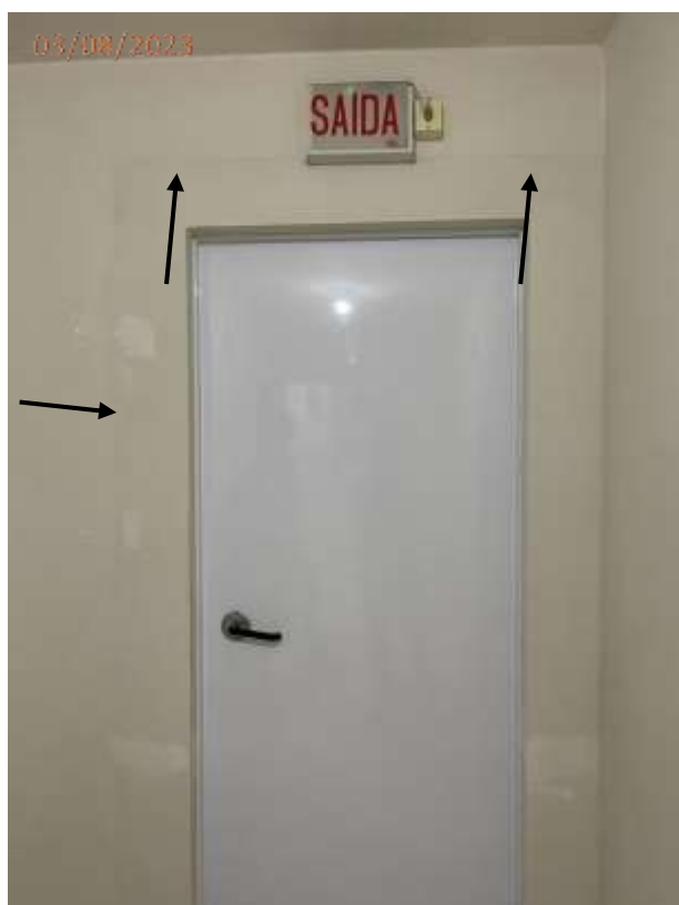
Foto 21: Trinca na parede junto a porta corta fogo no hall do 19º andar.
