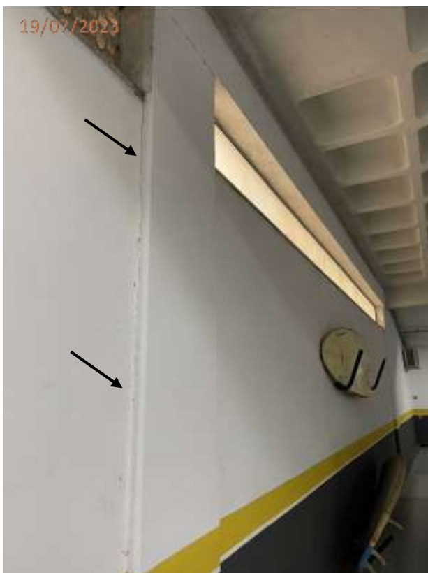
Fotos 80 e 81: Trincas na parede da circulação de veículos junto a vaga V21.
