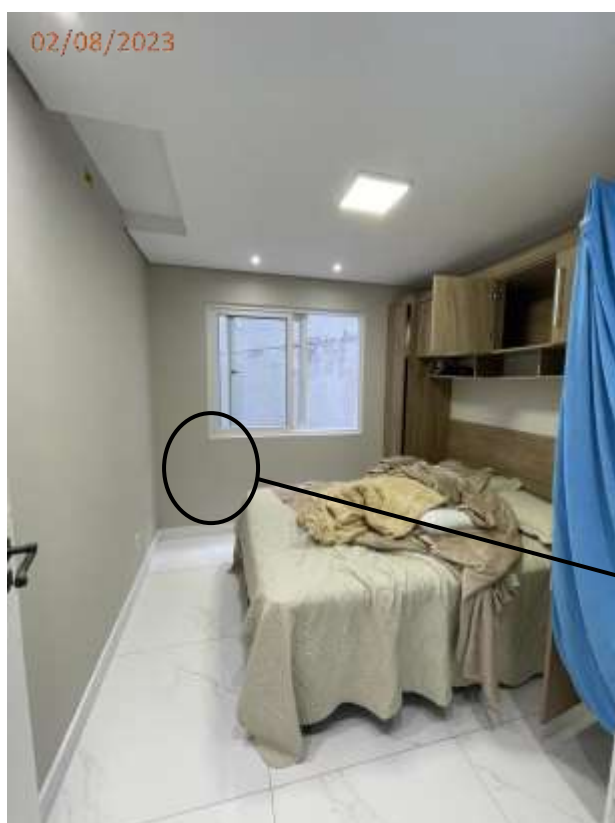
Fotos 04 e 05: Fissura na parede do dormitório junto a janela.
