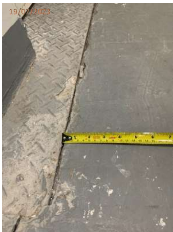
Fotos 98, 99 e 100: Afastamento do piso metálico junto a passarela na torre sul.
