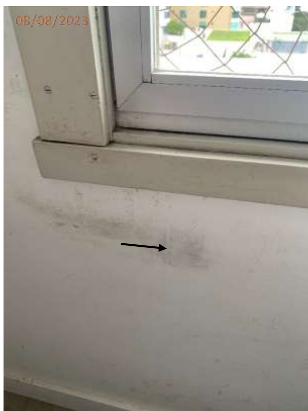
Fotos 04 e 05: Trinca na parede junto a janela do dormitório.
