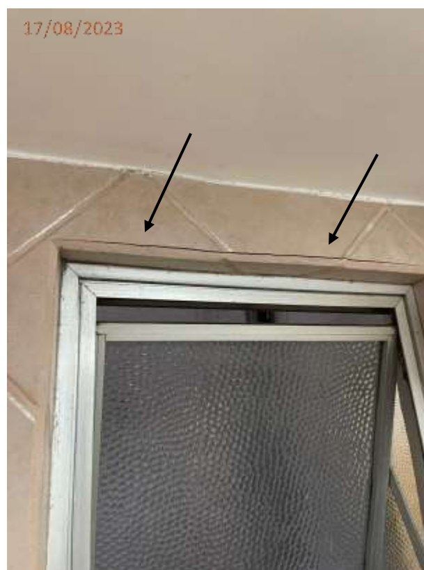
Fotos 10 e 11: Trincas no teto e decolamento de revestimento na parede do banheiro.
