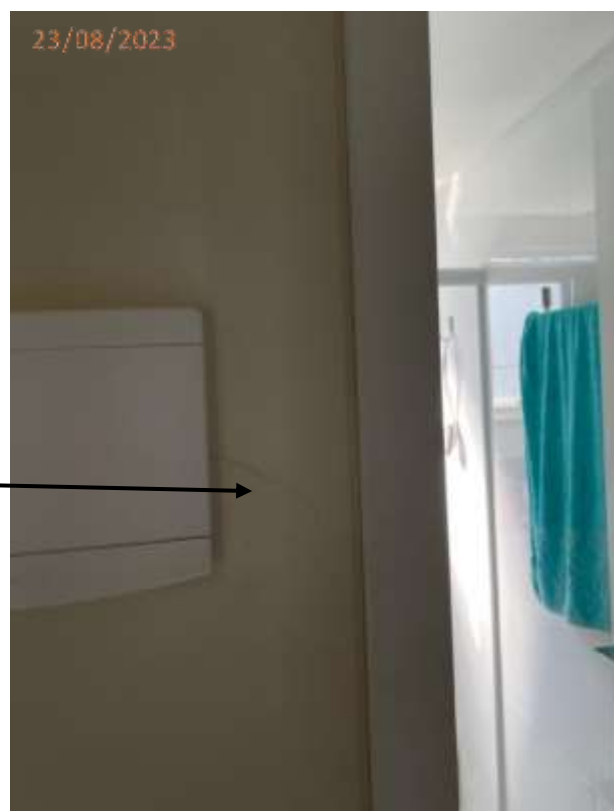
Fotos 05 e 06: Trinca na parede junto ao quadro de disjuntores na circulação íntima.
