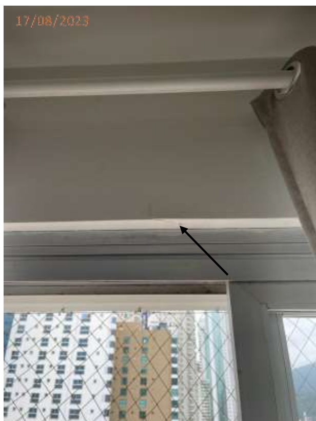
Fotos 03 e 04: Trinca na parede junto a janela da sala e junto ao guarda corpo da sacada.
