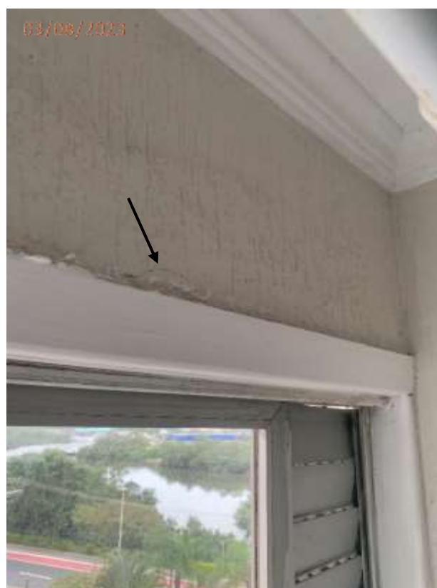
Fotos 07 e 08: fissura na parede junto a janela da cozinha/a.s.
