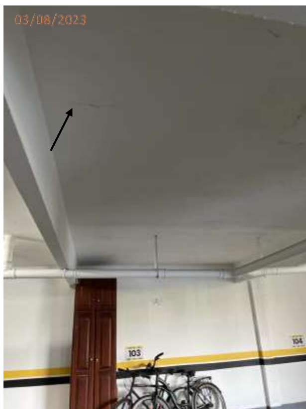
Foto 70: Trinca no teto junto a vaga V103.
