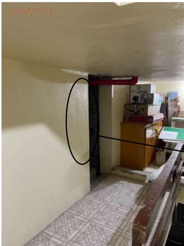
Fotos 06, 07 e 08: Trinca na parede da área de acesso ao barrilete.
