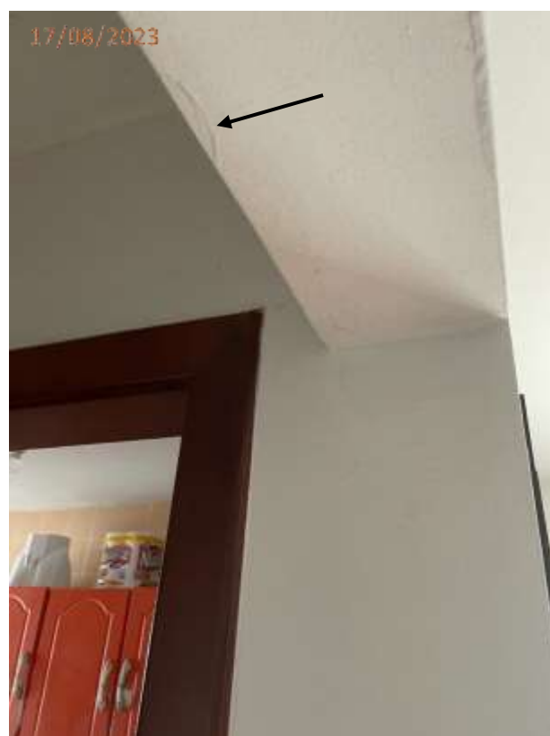
Fotos 05, 06 e 07: Trinca na parede junto a porta do bwc e fissura na viga junto a porta da cozinha na criculação.
