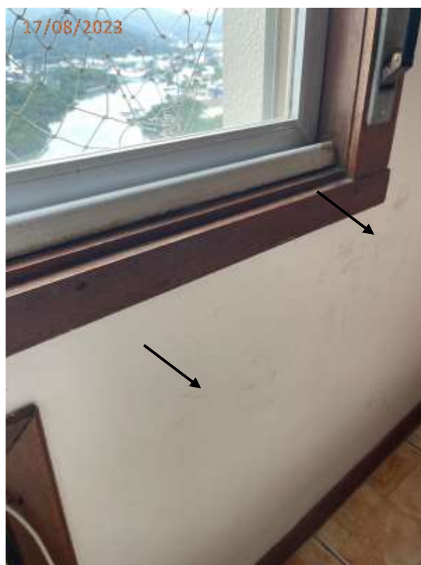
Fotos 09, 10 e 11: Trincas na parede junto a janela do dormitório.
