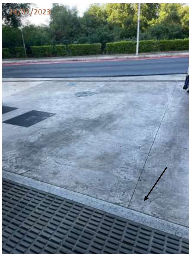
Foto 70: Trinca no piso junto ao portão da garagem térreo.
