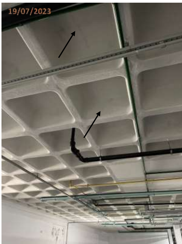
Foto 35: Trinca no teto junto a rampa de acesso a garagem G3.
