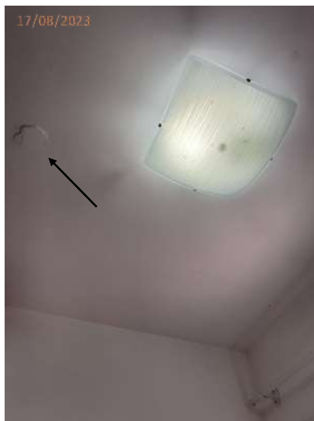
Fotos 05 e 06: Descolamento de revestimento no teto da cozinha.
