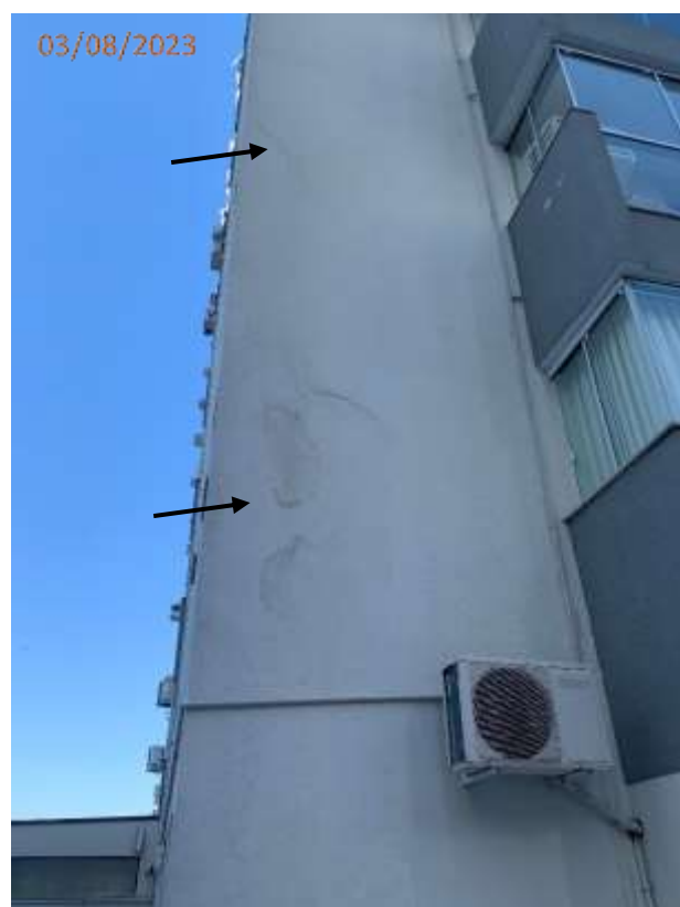
Fotos 153, 154, 155 e 156: Trincas na fachada lateral esquerda.
