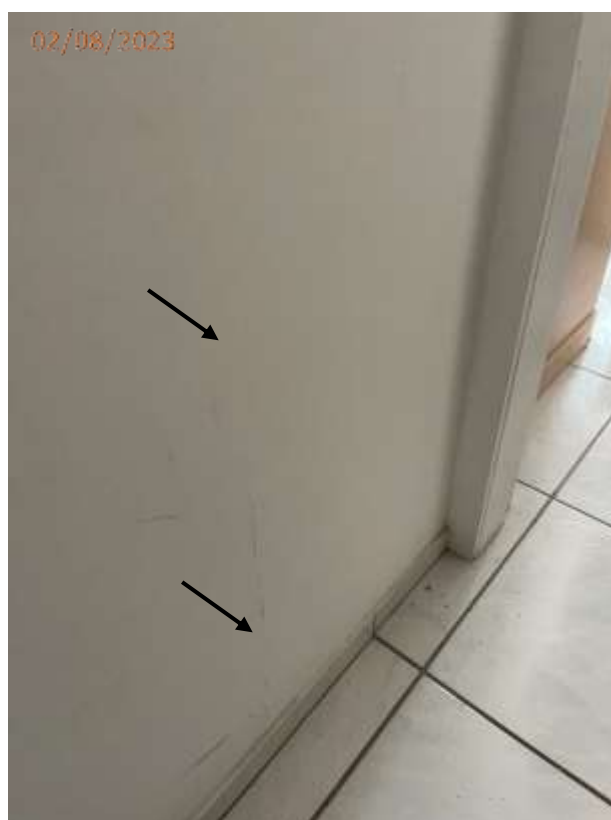
Fotos 08, 09,10 e 11: Fissura na parede junto as portas dos dormitórios, junto ao rodapé na circulação íntima.
