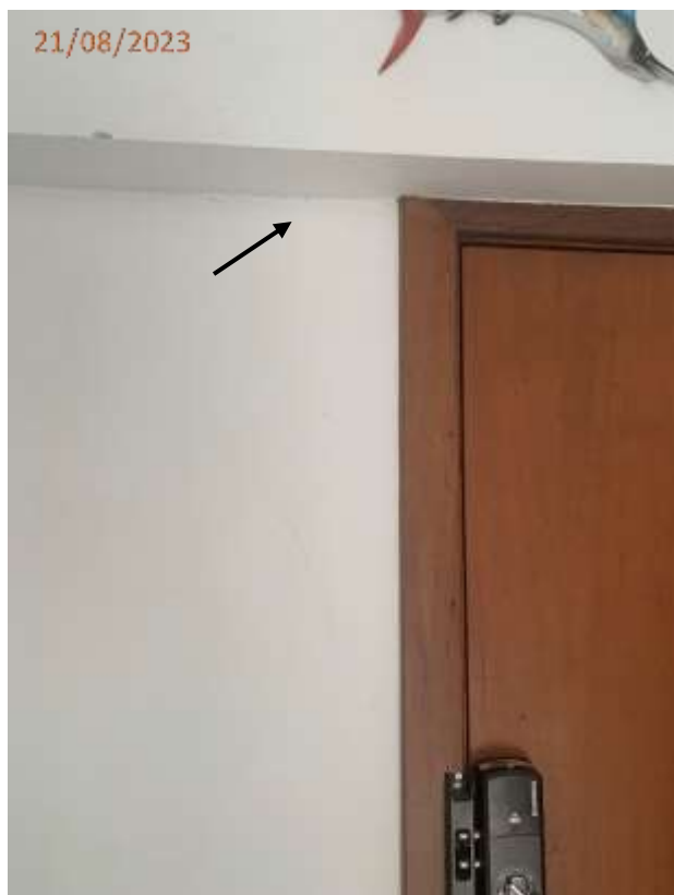
Fotos 03 e 04: Fissura na parede ao lado da porta de entrada e porta da sacada.
