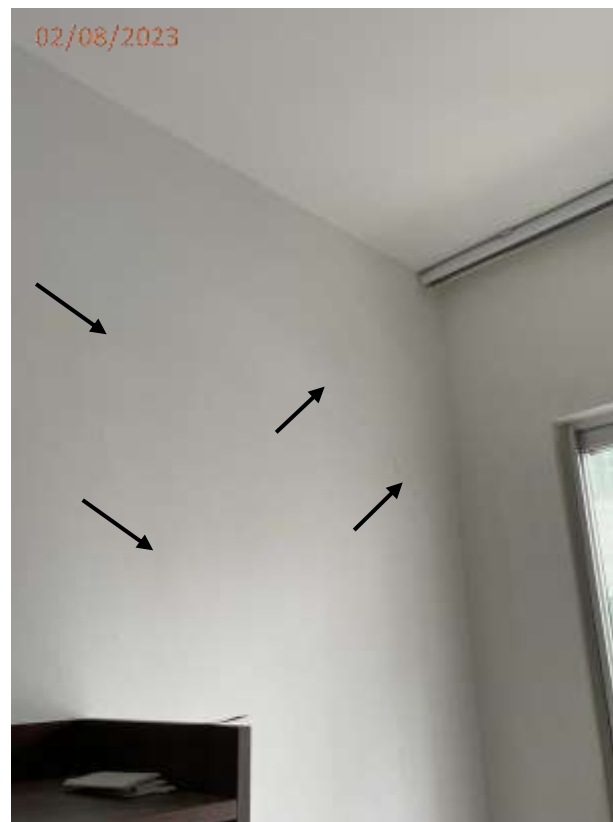
Fotos 23, 24, 25 e 26: Trinca na parede junta porta da sacada, fissura no teto e na parede ao lado da estante no dormitório.
