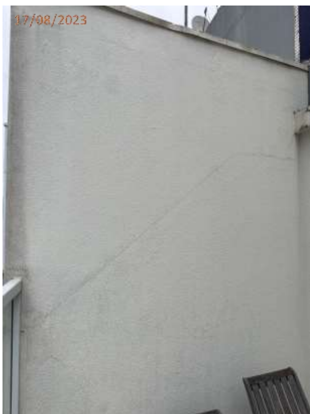
Fotos 39 e 40: Trinca nas paredes do terraço.
