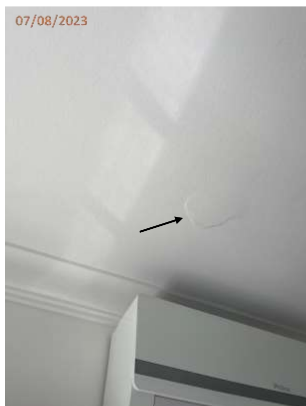
Fotos 25 e 26: Descolamento de revestimento no teto do dormitório.
