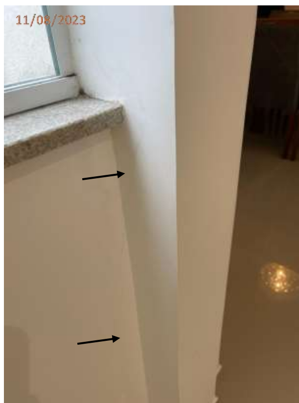
Foto 04: Fissura na parede junto ao peitoril na sala de estar.
