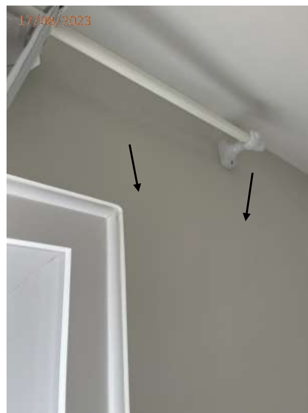
Fotos 26, 27, 28 e 29: Fissuras na parede da sala junto a porta de acesso ao terraço.
