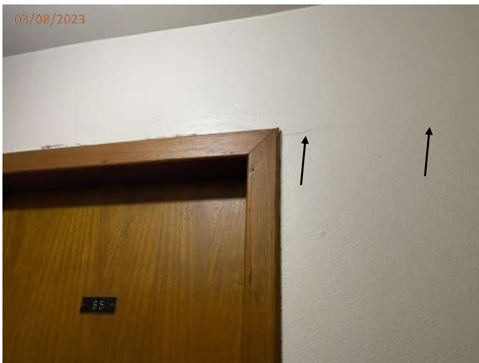
Foto 51: Fissura na parede ao lado da porta do Apto 65 no hall do 6º andar.
