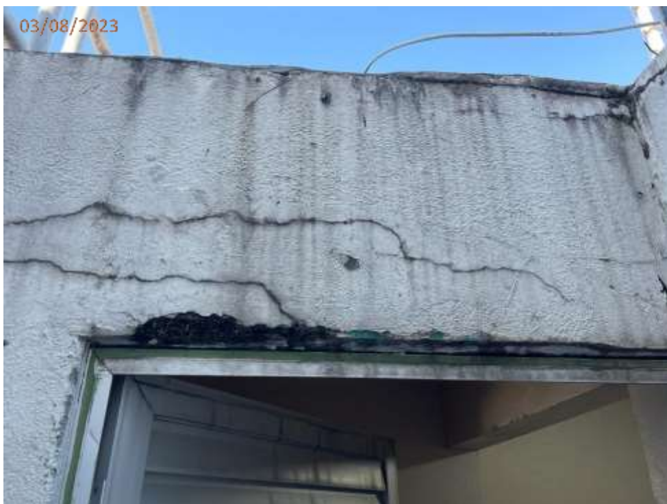
Foto 09: Rachadura e trincas na parede da área de acesso a cobertura.
