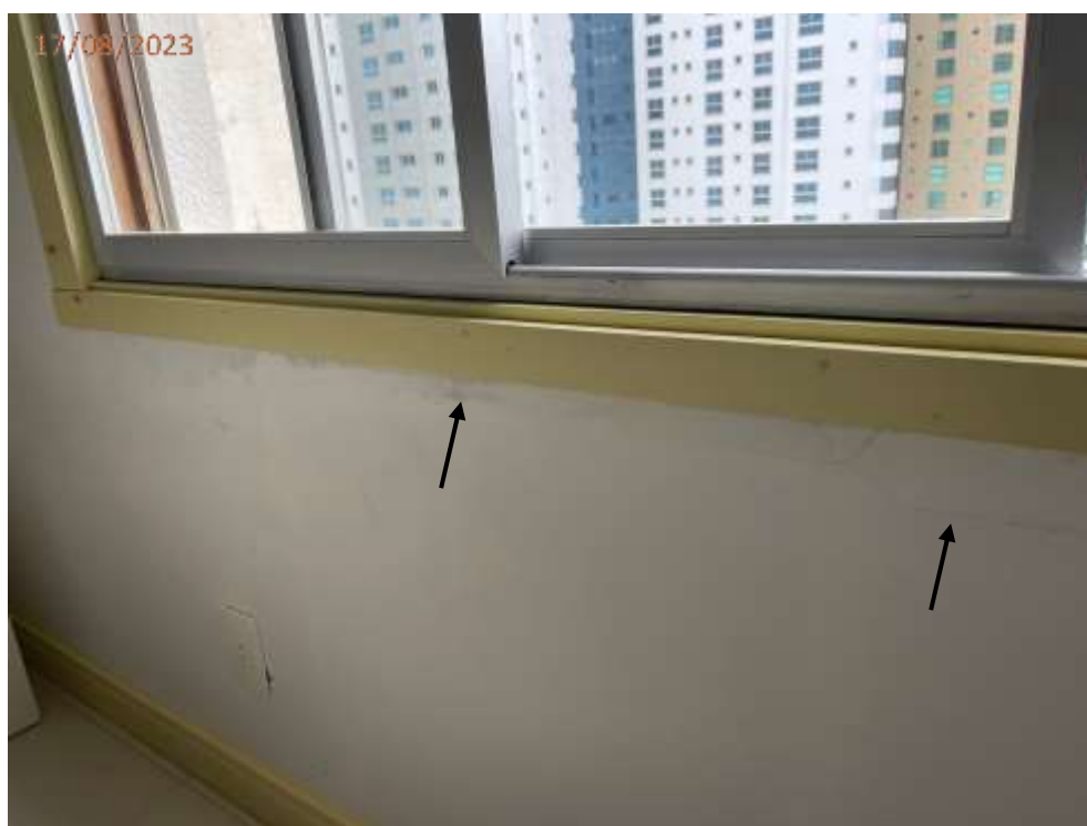
Fotos 10, 11 e 12: Trincas na parede junto a janela do dormitório.
