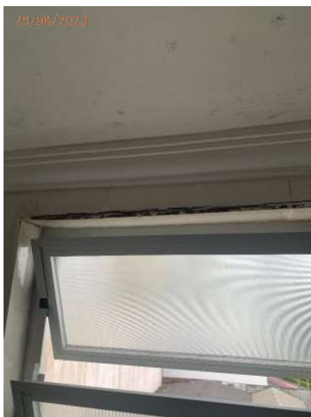
Fotos 07, 08, 09 e 10: Descolamento da moldura de gesso, descolamento de cerâmica junto a janela e umidade generalizada no teto do banheiro .
