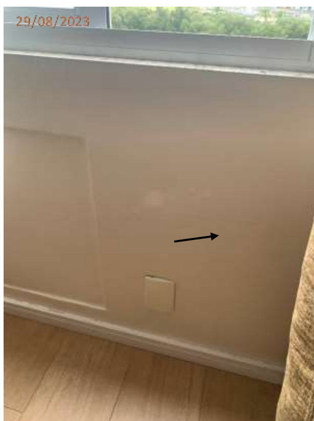
Foto 06: Fissura na parede junto a janela da sala.
