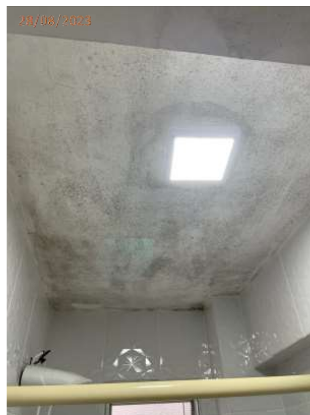
Fotos 18 e 19: Trincas e desgaste do revestimento no teto do banheiro.
