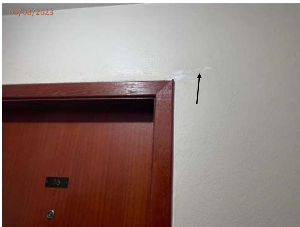
Foto 47: Fissura na parede ao lado da porta do Apto 75 no hall do 7º andar.
