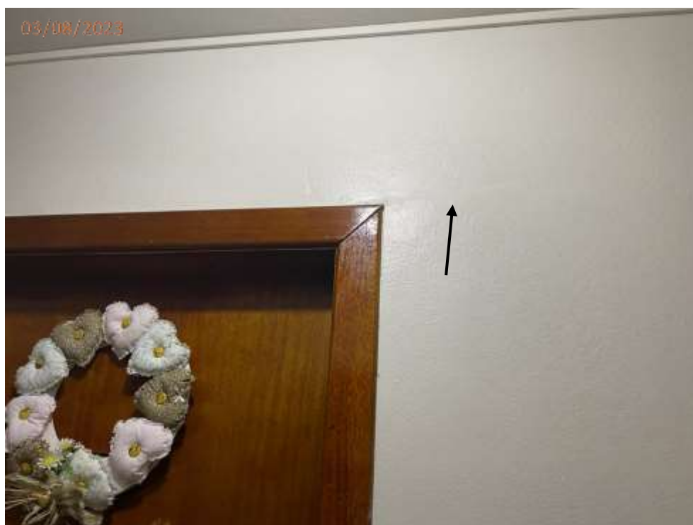
Foto 62: Fissura na parede ao lado da porta do Apto 15 no hall do 1º andar.
