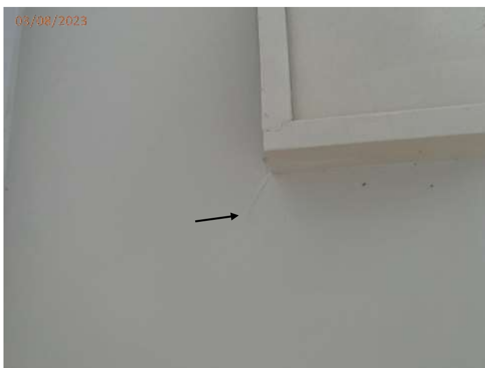
Fotos 11, 12 e 13: Trinca na parede junto a janela do dormitório.
