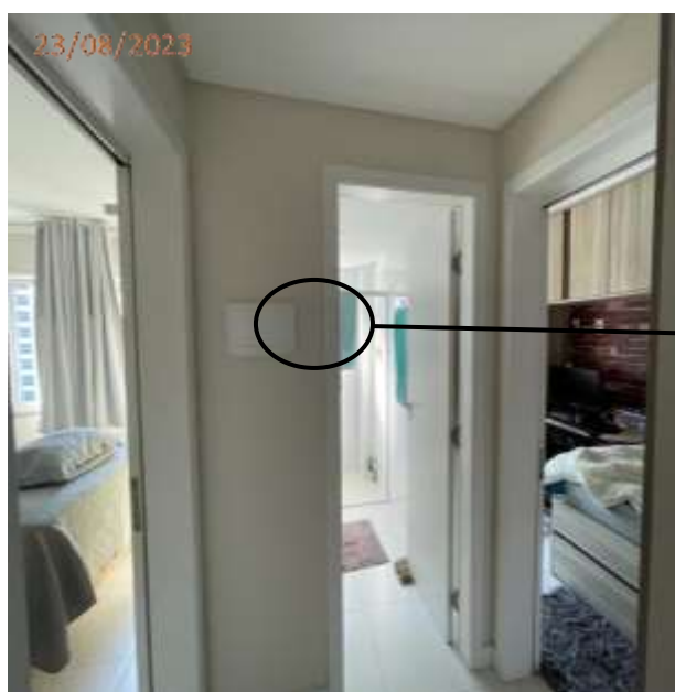
Fotos 05 e 06: Trinca na parede junto ao quadro de disjuntores na circulação íntima.
