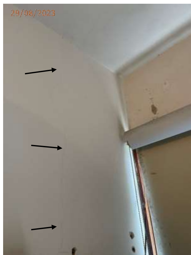
Fotos 10 e 11: Trinca na parede ao lado da janela do dormitório.
