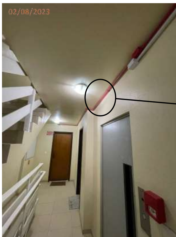
Fotos 14 e 15: Fissura no teto do hall junto a luminária.
