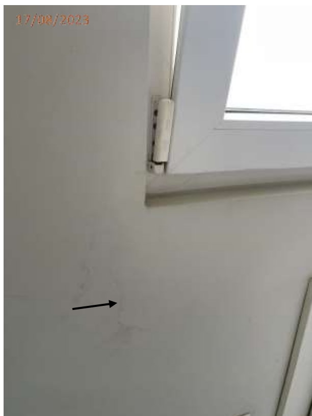
Fotos 16, 17, 18 e 19: Trinca na parede junto a porta e junto a janela do dormitório.
