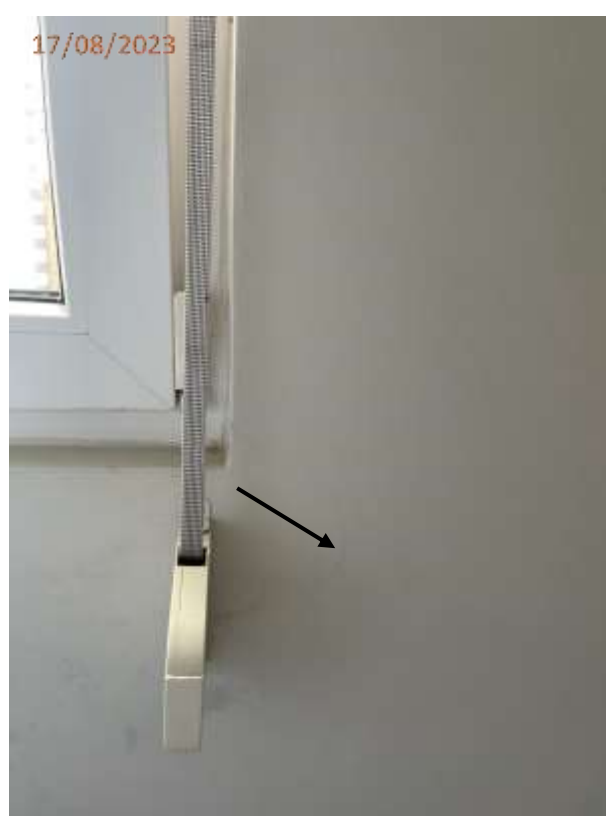
Fotos 16, 17, 18 e 19: Trinca na parede junto a porta e junto a janela do dormitório.
