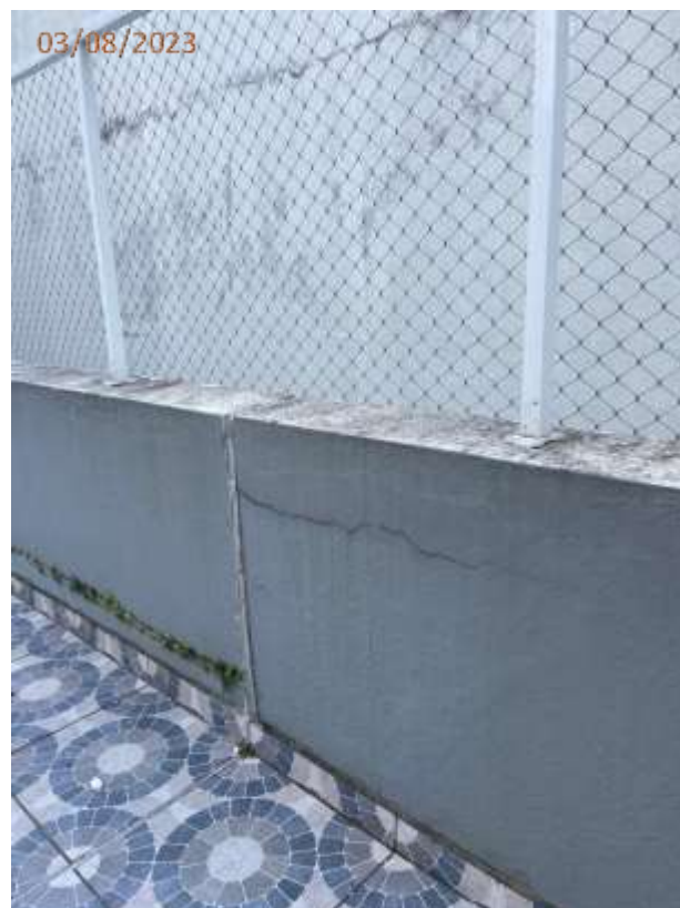
Foto 25: Trincas no peitoril do terraço.
