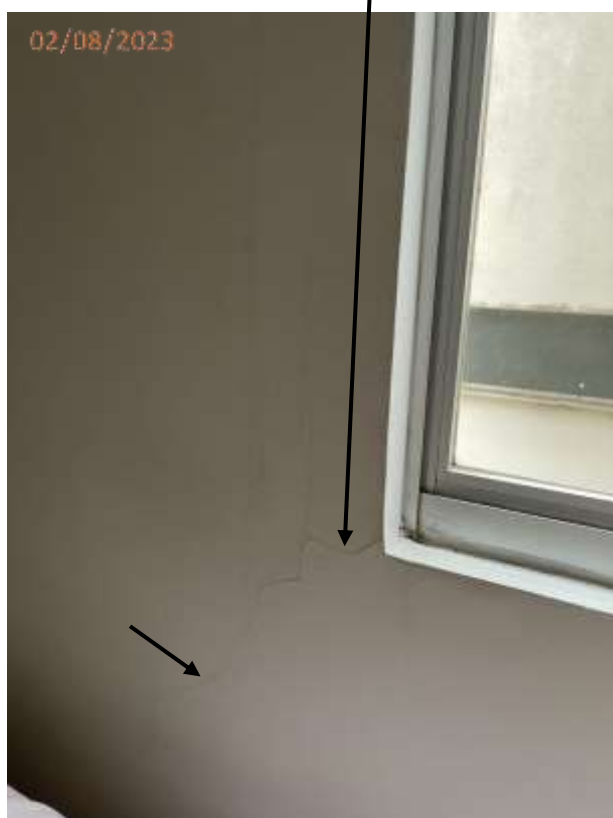
Fotos 09 e 10: Fissura na parede do dormitório junto a janela.
