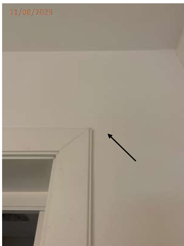
Foto 09: Fissura na parede do dormitório junto a porta.
