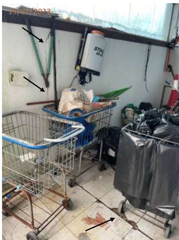
Fotos 07 e 08: Pisos cerâmicos quebrados e trincas na parede na área de apoio (depósito).
