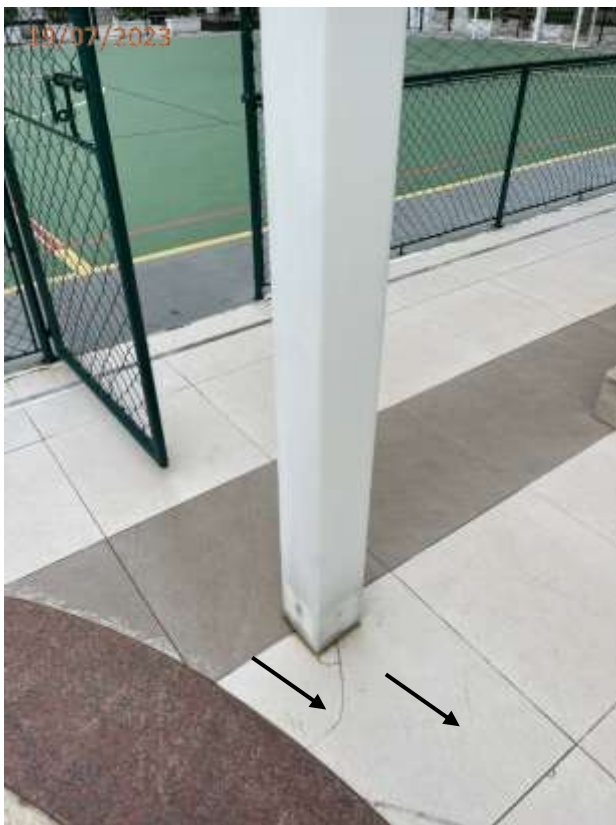
Fotos 09 e 10: Piso cerâmico quebrados na circulação entre as quadras.
