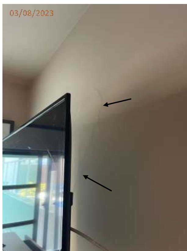
Fotos 17, 18 e 19: Trinca nas paredes junto a janela e Tv do dormitório.
