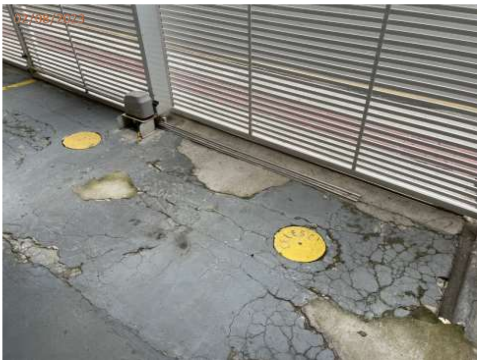
Foto 34: Trincas e rachaduras generalizadas no piso da garagem lateral esquerda da edificação.
