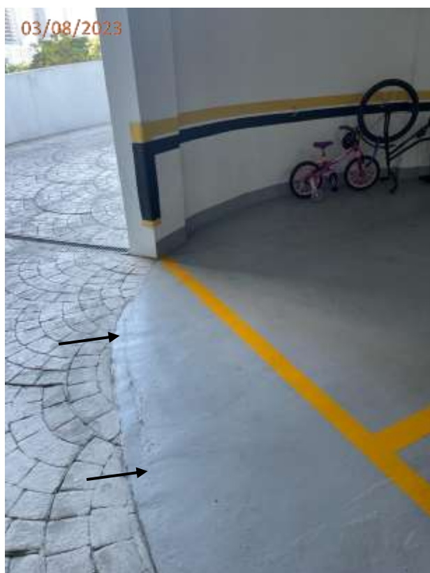
Foto 90: Trinca no piso junto a vaga V73.
