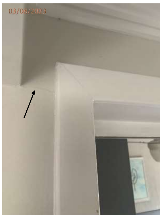
Fotos 05 e 06: fissura na parede da circulação íntima junto a porta do dormitório.
