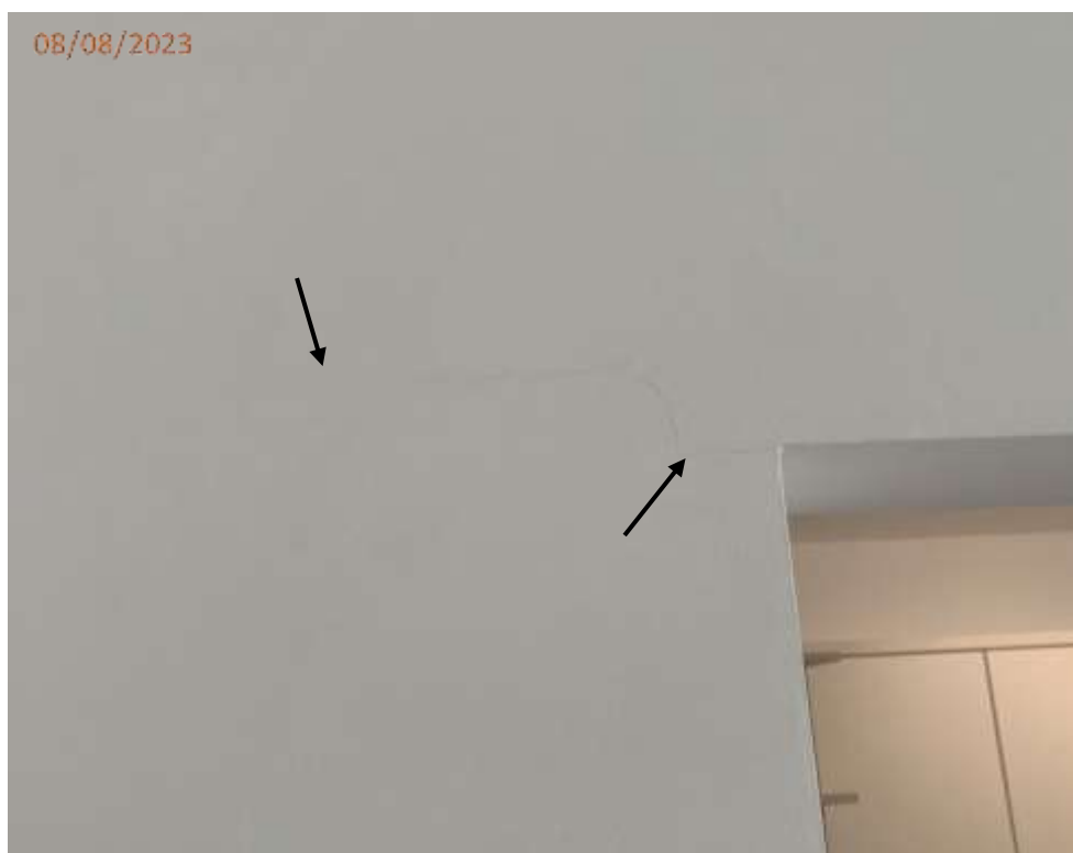
Foto 03: Trinca na parede junto ao vão de acesso a cozinha.
