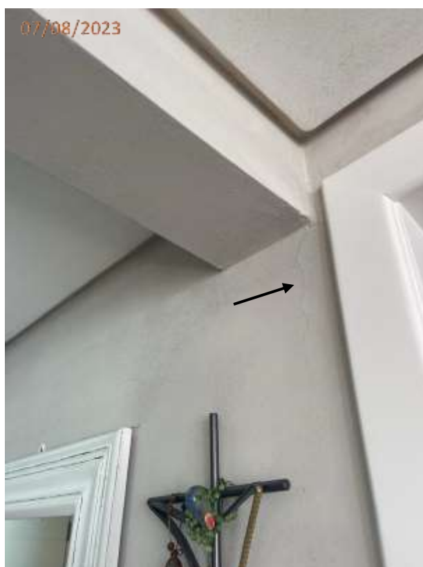
Fotos 19 e 20: Trincas na parede do hall de entrada.
