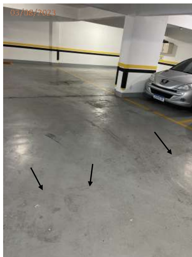
Fotos 96 e 97: Trincas no piso da circulação junto a vaga V34 e circulação junto as vagas V30/31
