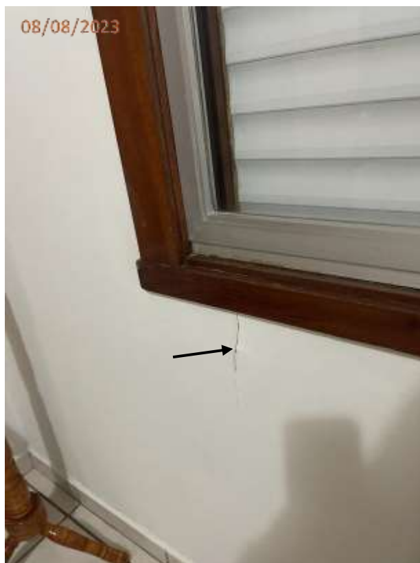
Fotos 13, 14, 15 e 16: Trinca nas paredes da suíte.
