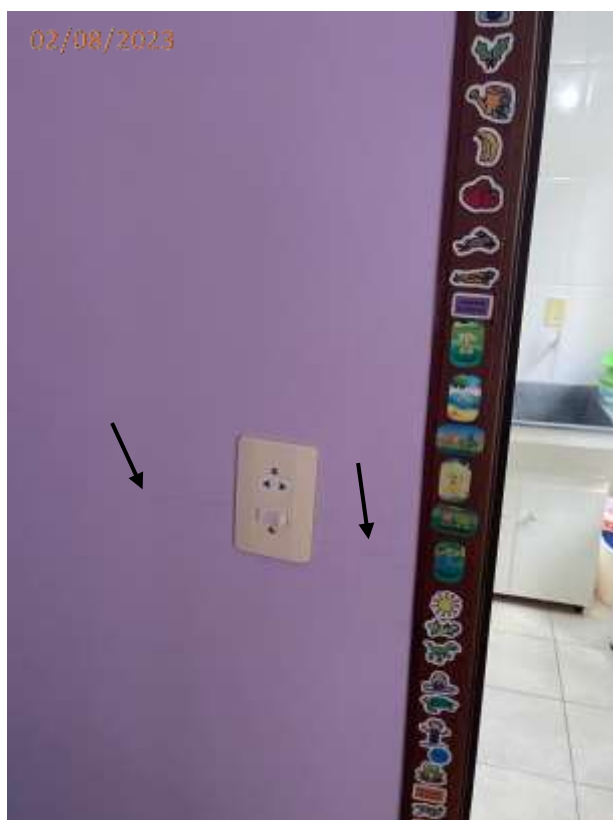
Foto 18: Trinca na parede da dep. de empregada junto ao interruptor.
