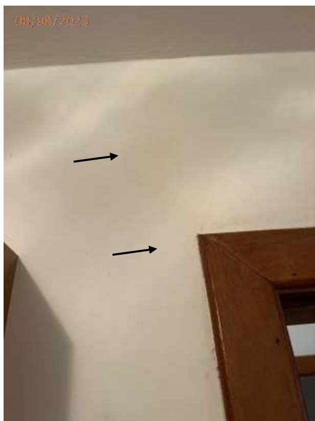
Fotos 10, 11 e 12: Trinca nas paredes do dormitório.
