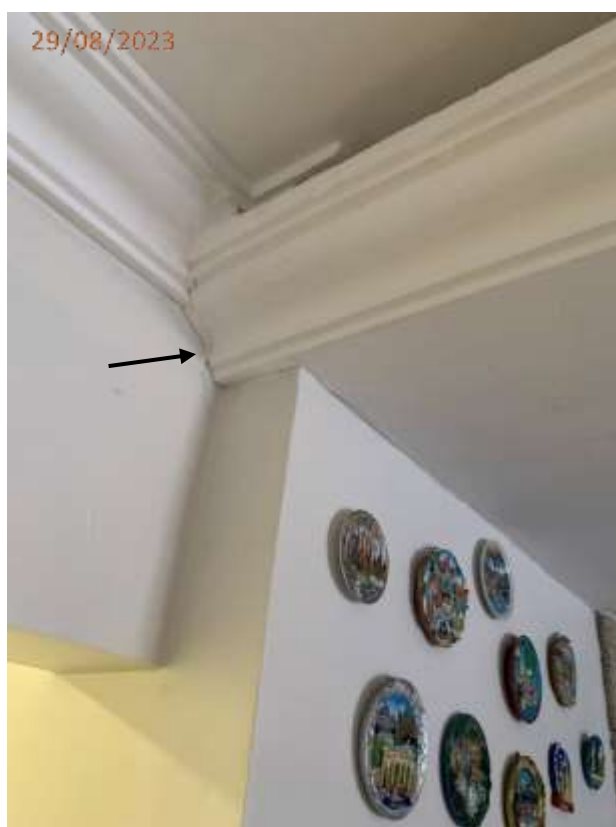
Fotos 03 e 04: Trincas junto ao teto na sala.
