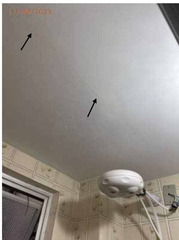
Fotos 11 e 12: Trinca no teto do banheiro.
