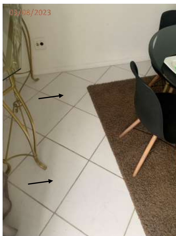
Fotos 03 e 04: Pisos da sala descolando do substrato e com som cavo (choco) ao toque.
