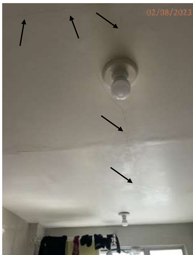
Fotos 03, 04, 05 e 06: Descolamento de azulejo e trincas no teto da cozinha/a.s.
