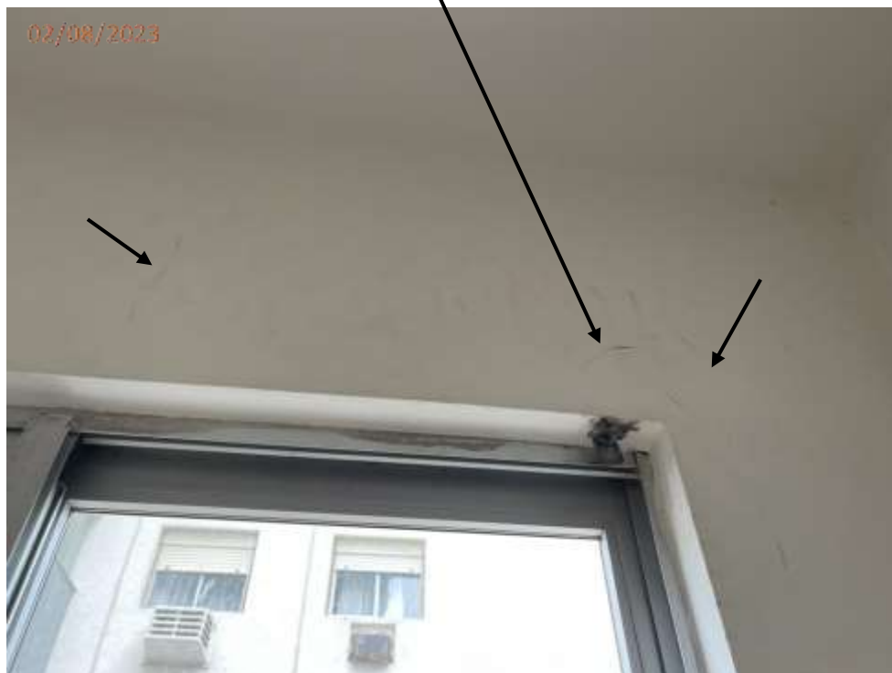
Fotos 16 e 17: Fissuras na parede junto a janela da dep. de serviço.
