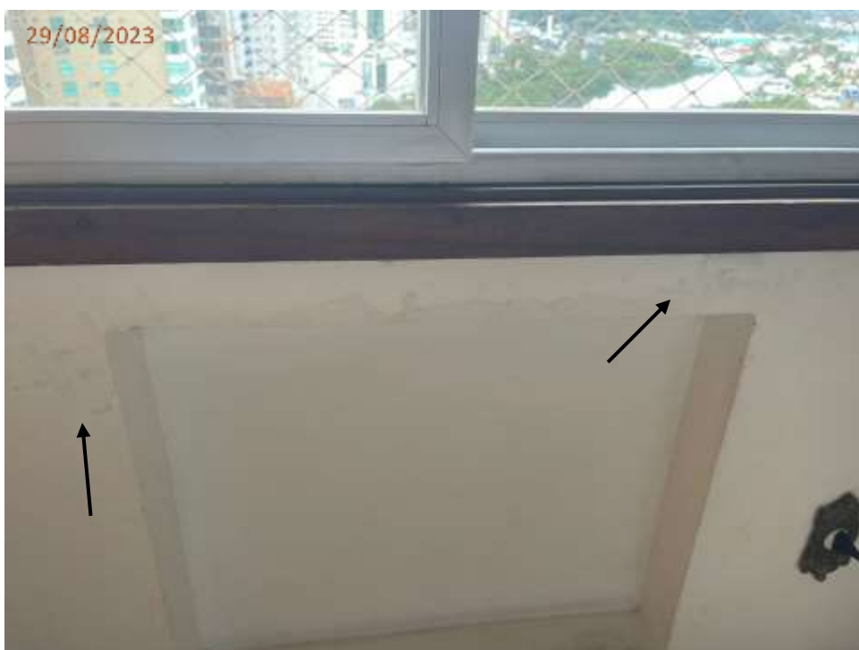
Foto 15: Trinca na parede junto a janela do dormitório.
