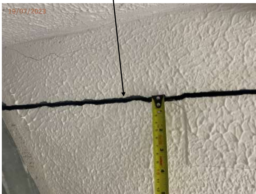
Fotos 107 e 108: Rachadura no teto da passarela torres sul/central.
