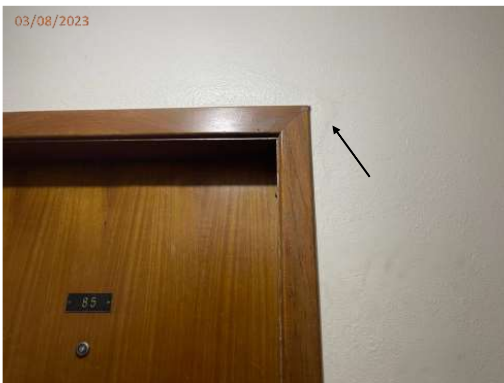
Foto 43: Fissura na parede ao lado da porta do Apto 85 no hall do 8º andar.
