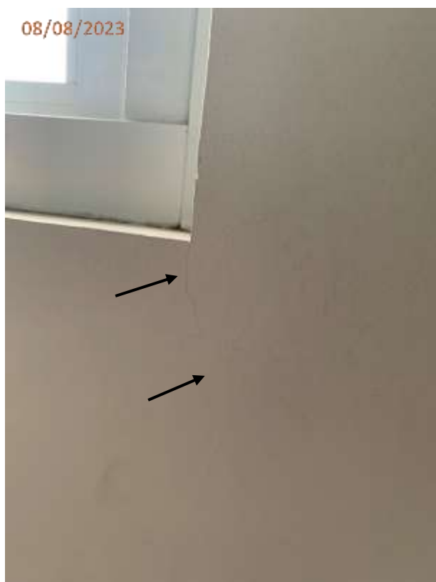
Fotos 13 e 14: Trincas na parede junto a janela da suíte.
