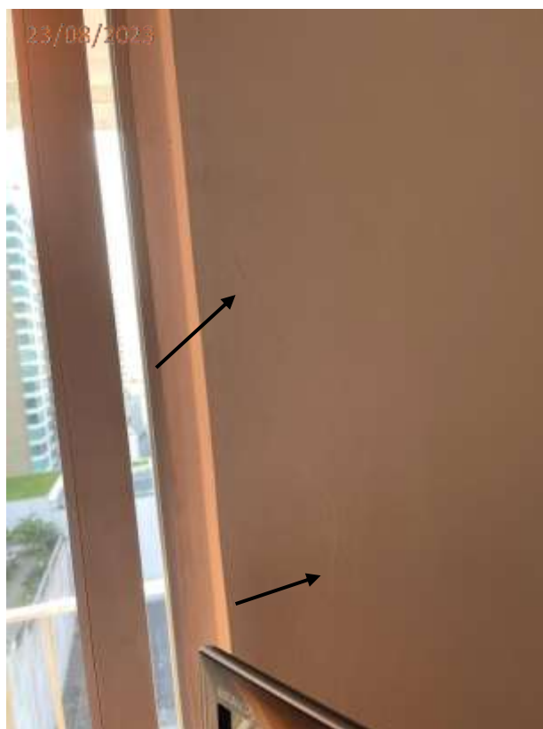
Foto 03: Trinca na parede da sala junto a porta de acesso a sacada.
