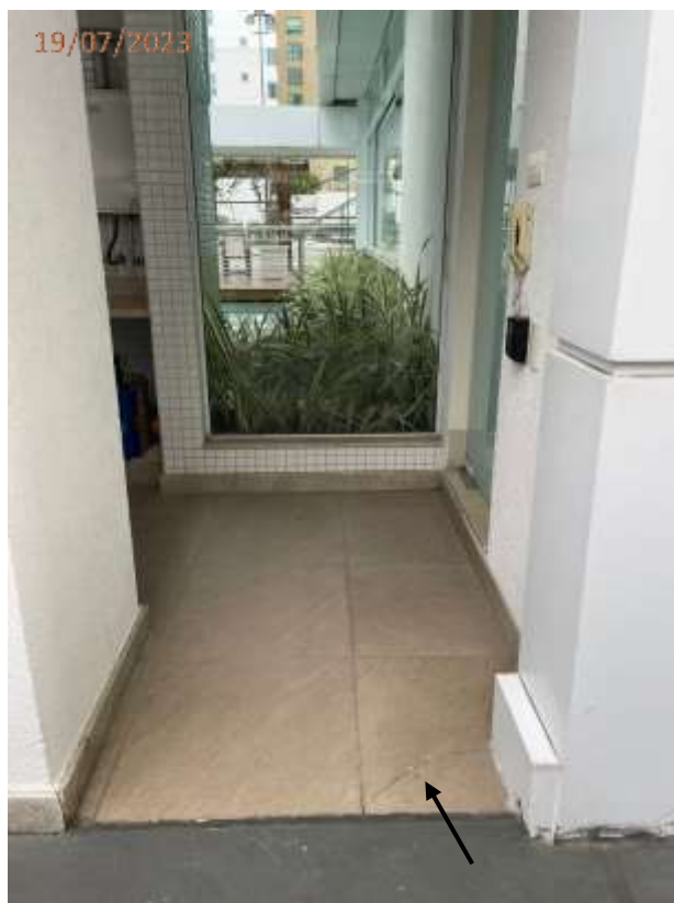
Foto 21: Piso cerâmico quebrado junto ao acesso do salão de festas.
