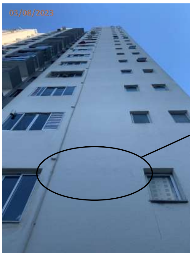
Fotos 159 e 160: Trincas na fachada do fundo divisa com terreno.
