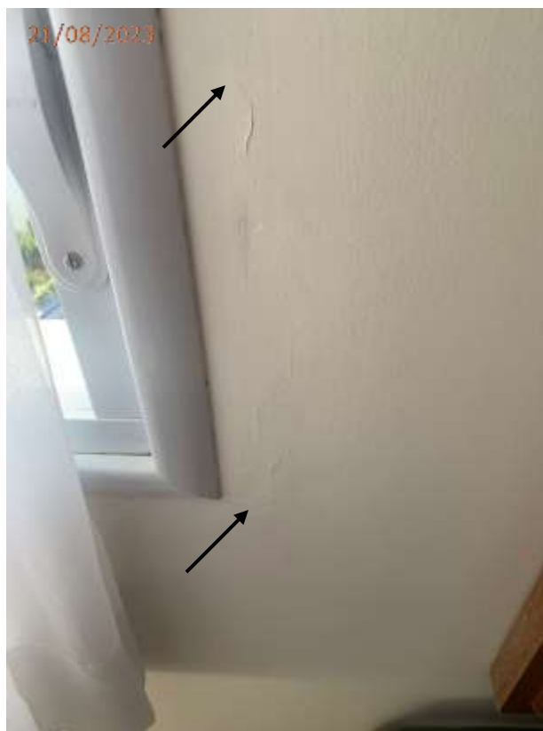
Fotos 21, 22, 23 e 24: Trincas na parede junto a porta do bwc e janela da suíte.
