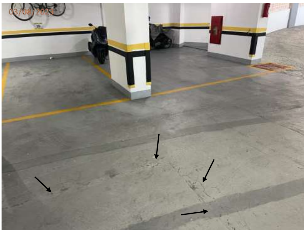
Foto 93: Trinca no piso da circulação junto a vaga V39.
