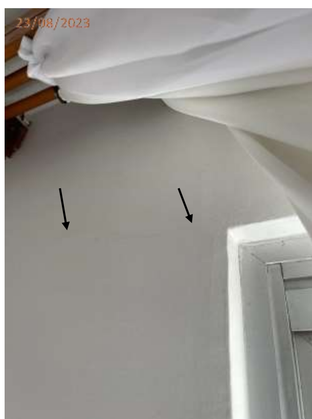
Fotos 03 e 04: Trinca na parede junto a porta de entrada e junto a porta da sacada.
