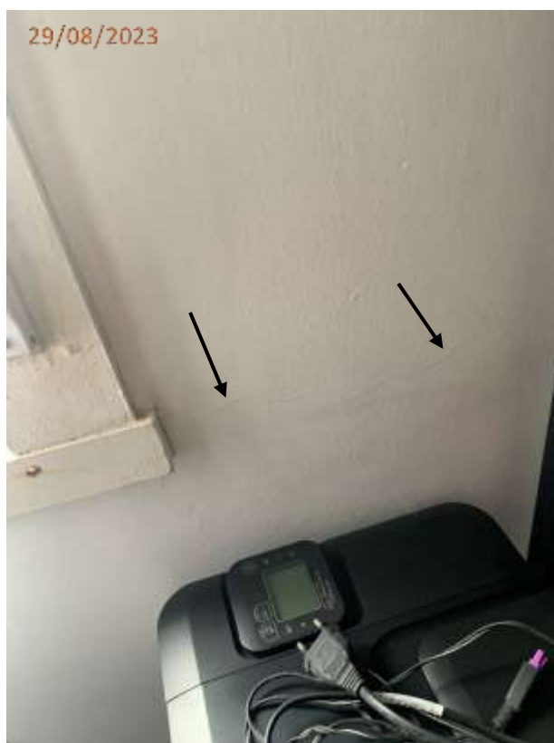
Fotos 11 e 12: Trincas na parede junto a janela do dormitório.
