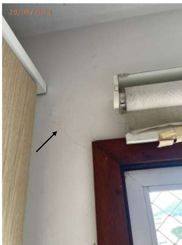
Fotos 04, 05, 06 e 07: Trinca nas paredes da junto ao vão de acesso a circulação intoma e junto a janela da sala.
