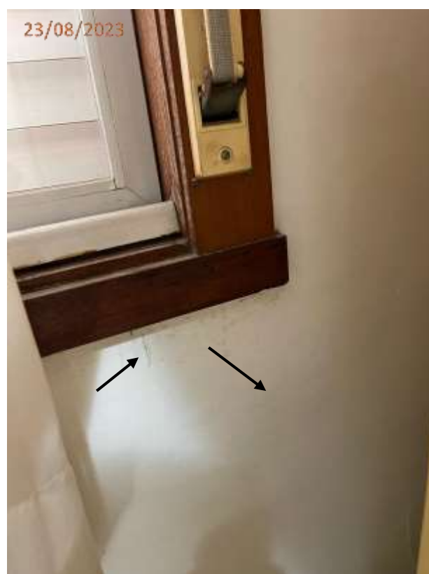
Fotos 08 e 09: Trincas na parede junto a janela do dormitório.
