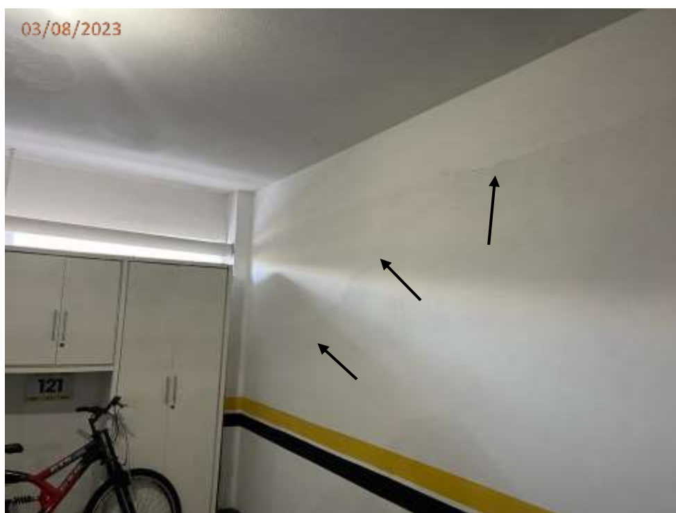
Foto 68: Trinca na parede junto a vaga V121.
