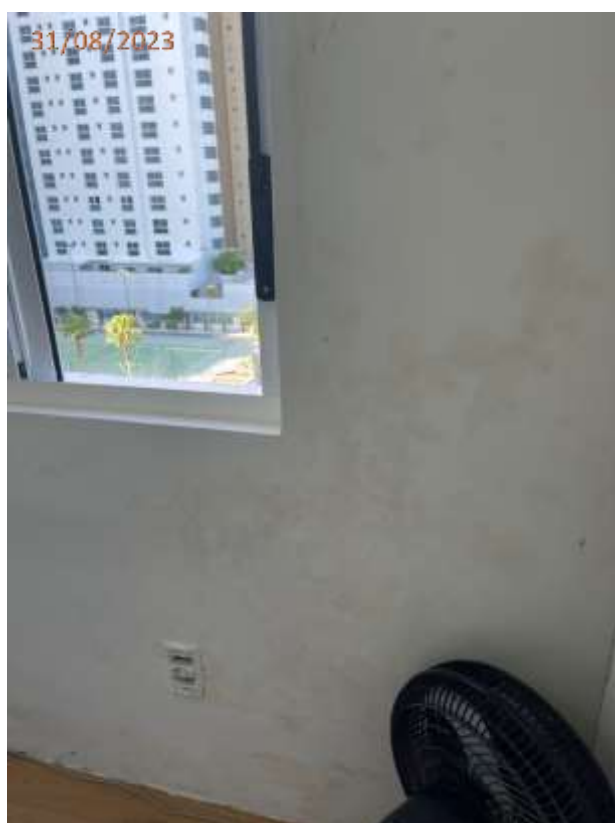
Fotos 04, 05 e 06: Trincas e sinais de umidade nas paredes do dormitório.
