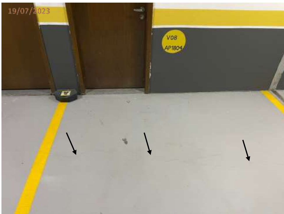
Foto 67: Trincas no piso junto a vaga V08.
