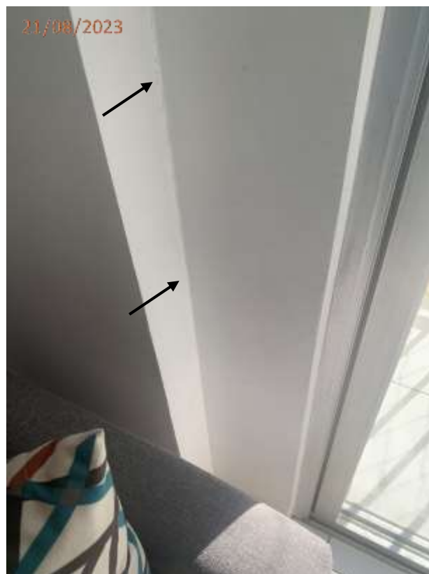
Fotos 03 e 04: Fissura na parede ao lado da porta de entrada e porta da sacada.
