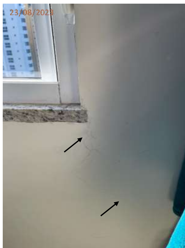
Fotos 07, 08 e 09: Trinca no teto na parede junto a janela do dormitório.
