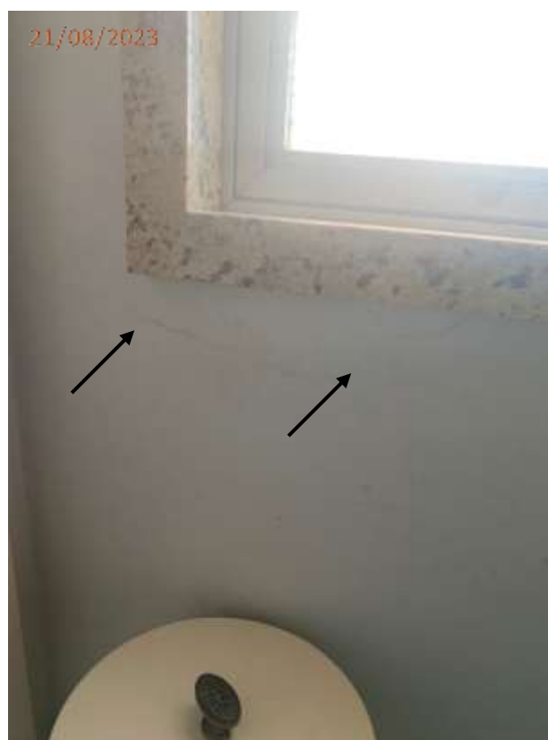
Fotos 07 e 08: Trinca na parede junto a janela na dependência de empregada.
