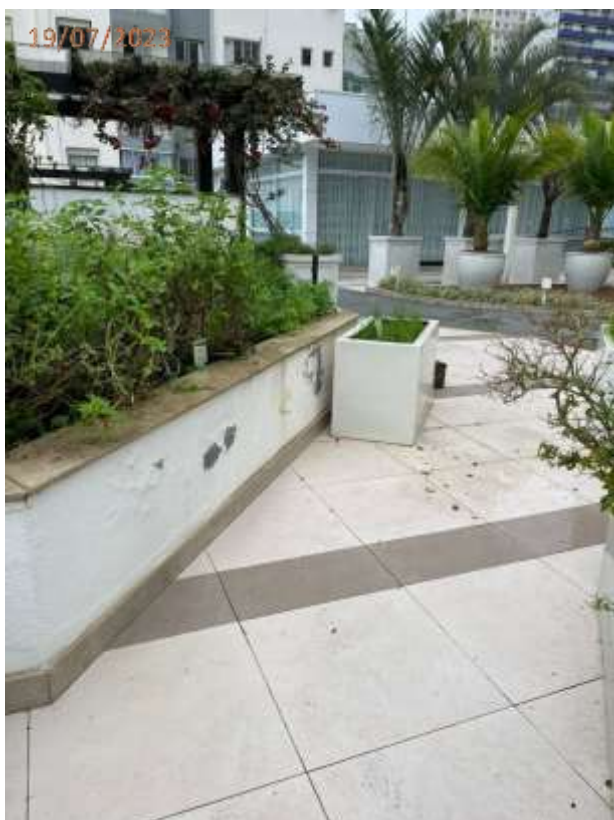
Foto 17: Descolamento de revestimento e sinais de umidade na mureta da floreira ao lado do vestiário/ acesso a escada.
