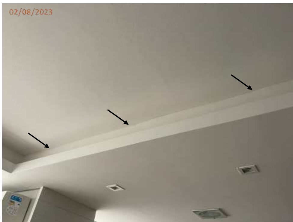
Foto 05: Fissura no encontro parede/teto na sala de estar.
