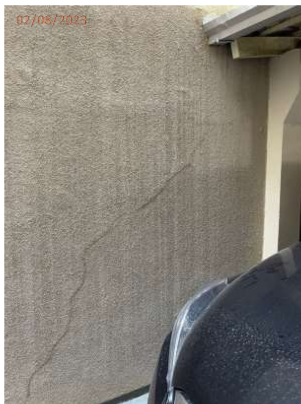
Fotos 36, 37, 38 e 39: Trincas e fissuras nas paredes da garagem lateral direita da edificação.
