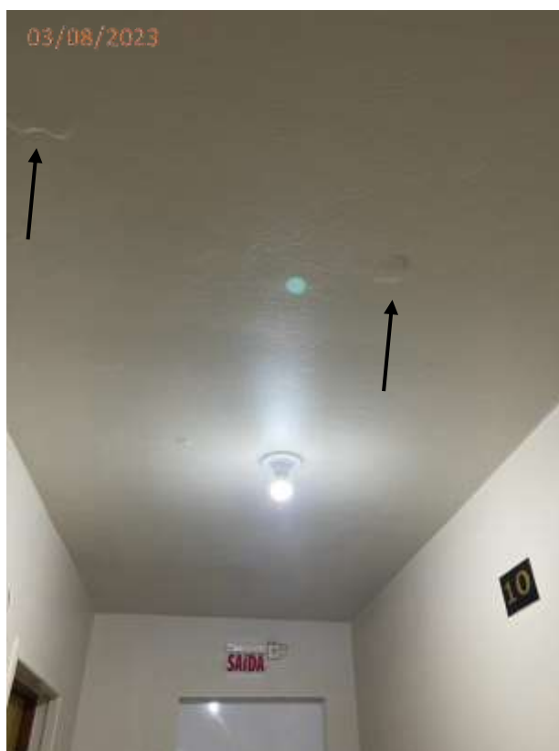
Fotos 38 e 39: Trincas e descolamento de revestimento no teto do hall do 10º andar.
