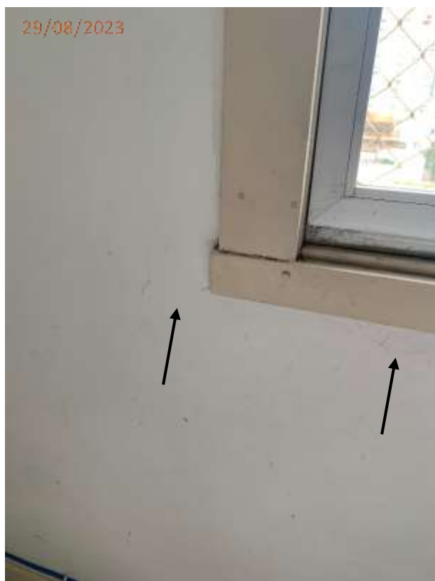
Fotos 12 e 13: Fissura na parede junto a janela do dormitório.
