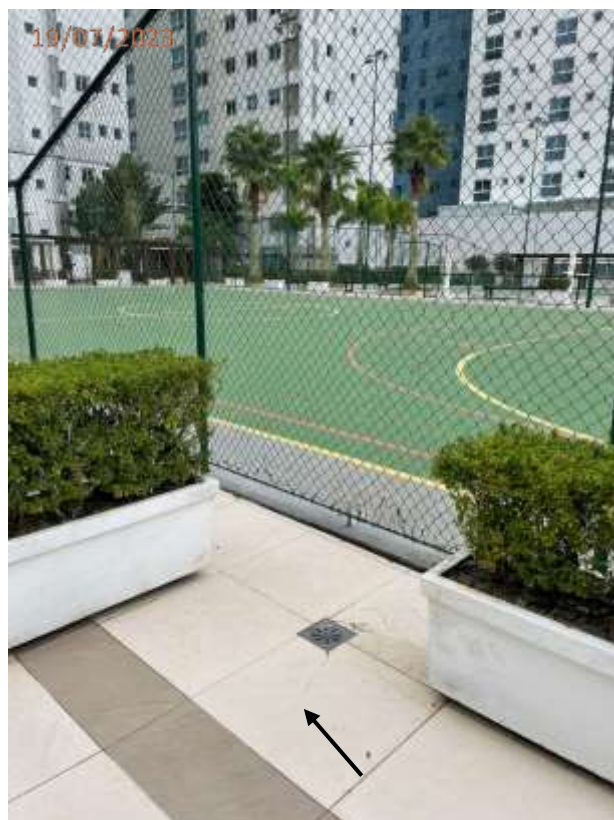
Foto 19: Piso cerâmico quebrado ao lado da quadra.
