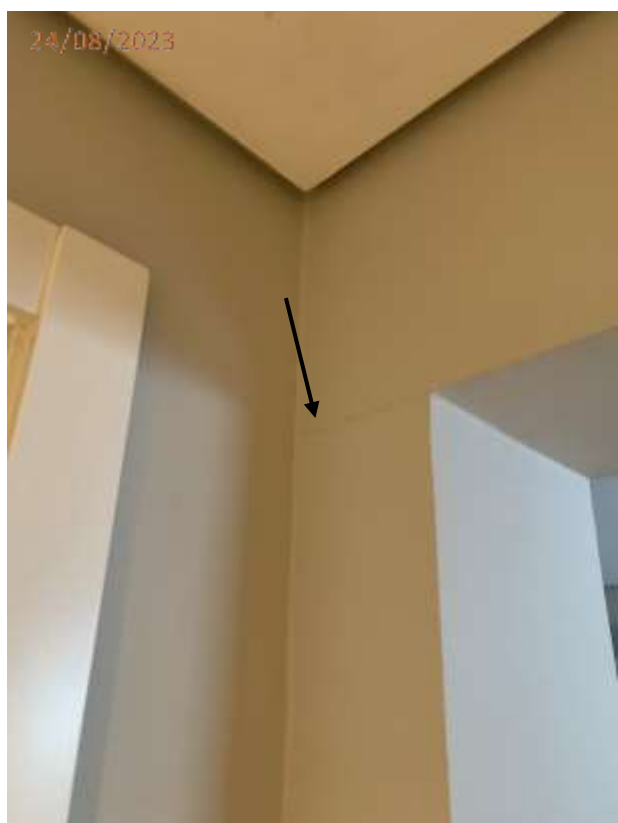
Fotos 07, 08 e 09: Trinca na parede junto ao vão de acesso a sala e na parede de divisa com bwc na circulação íntima.
