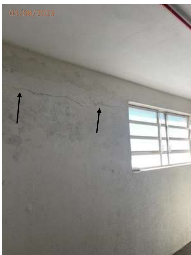
Fotos 02, 03 e 04: Trincas, sinais de umidade e desgaste em geral do revestimento na casa de máquinas dos elevadores.
