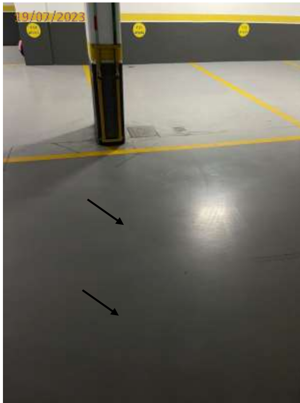
Foto 84: Trinca no piso da circulação em frente a vaga V54/55
