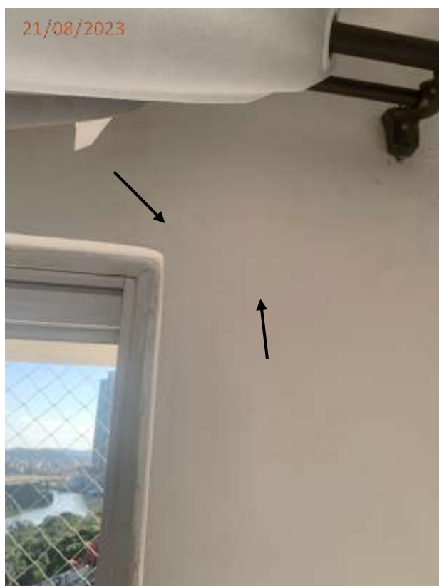
Foto 05: Fissura na parede junto a porta de acesso a sacada.
