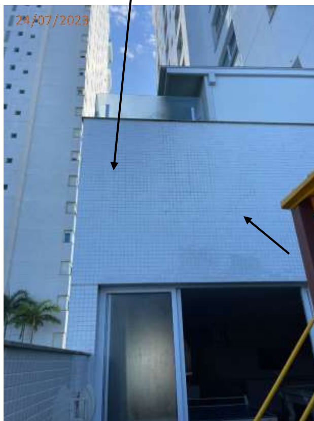
Foto 03: Fissuras na parede da fachada junto ao playground.
