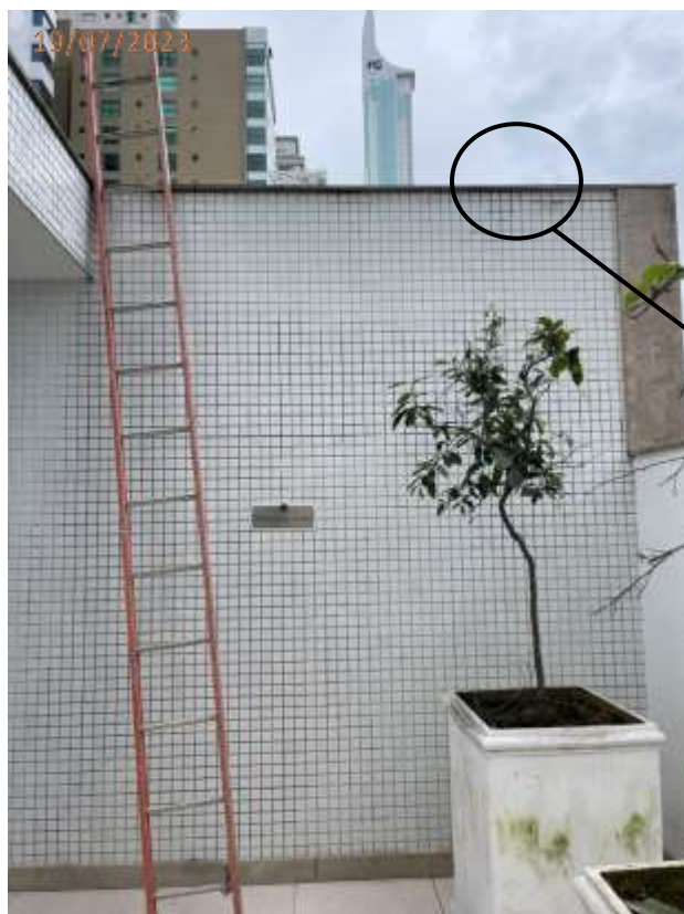
Fotos 14, 15 e 16: Descolamento e falta de cerâmica na parede do vestiário/acesso a escada.
