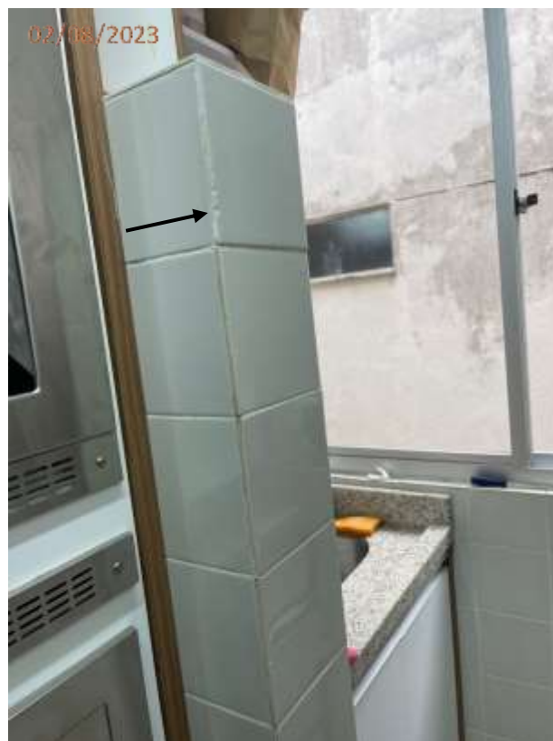
Fotos 03 e 04: Descolamento de azulejo na parede da cozinha.
