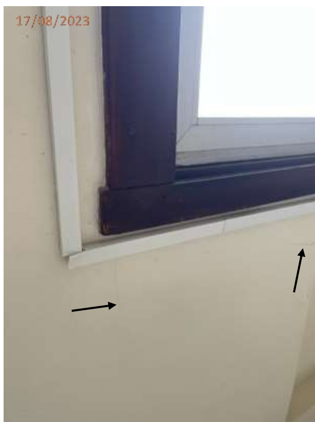
Fotos 10, 11 e 12: Trincas na parede junto a janela e ao lado da porta no dormitório.
