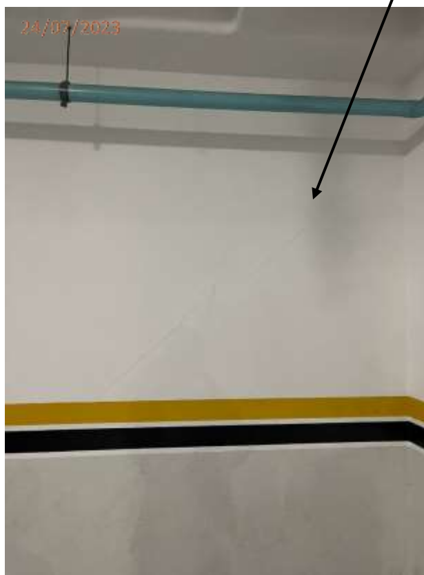
Fotos 59, 60 e 61: Trincas na parede junto a vaga V13.
