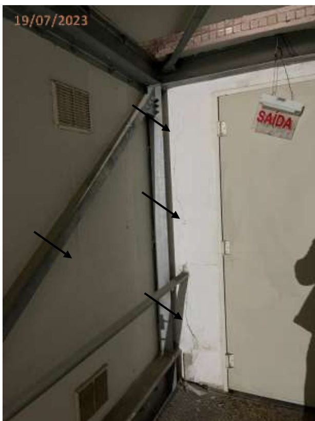
Fotos 122, 123, 124 e 125: Trincas e rachaduras na parede da passarela torres central/norte.
