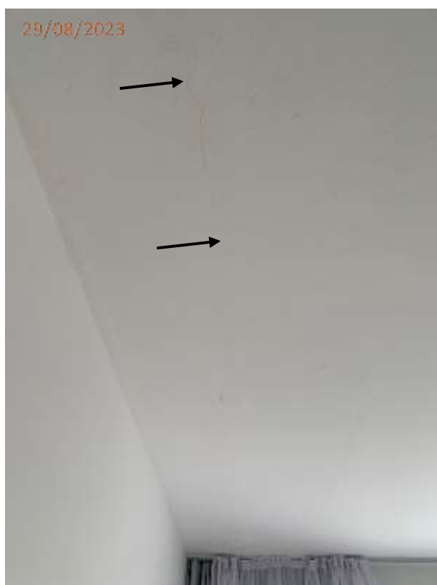
Fotos 14, 15 e 16: Trincas no teto do dormitório.
