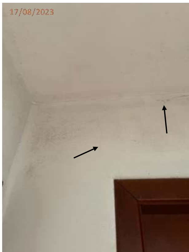
Fotos 05, 06 e 07: Trinca na parede junto a porta do bwc e fissura na viga junto a porta da cozinha na criculação.
