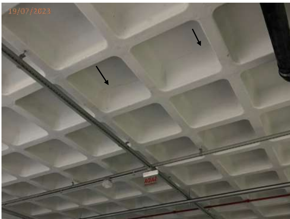
Foto 59: Trinca no teto junto a rampa de acesso a G2.
