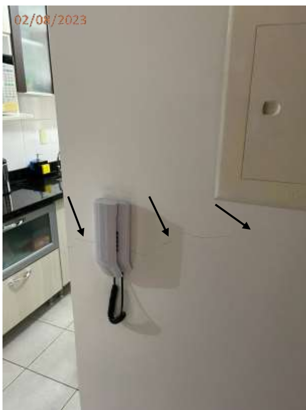
Foto 12: Trinca na parede junto ao quadro elétrico e interfone.
