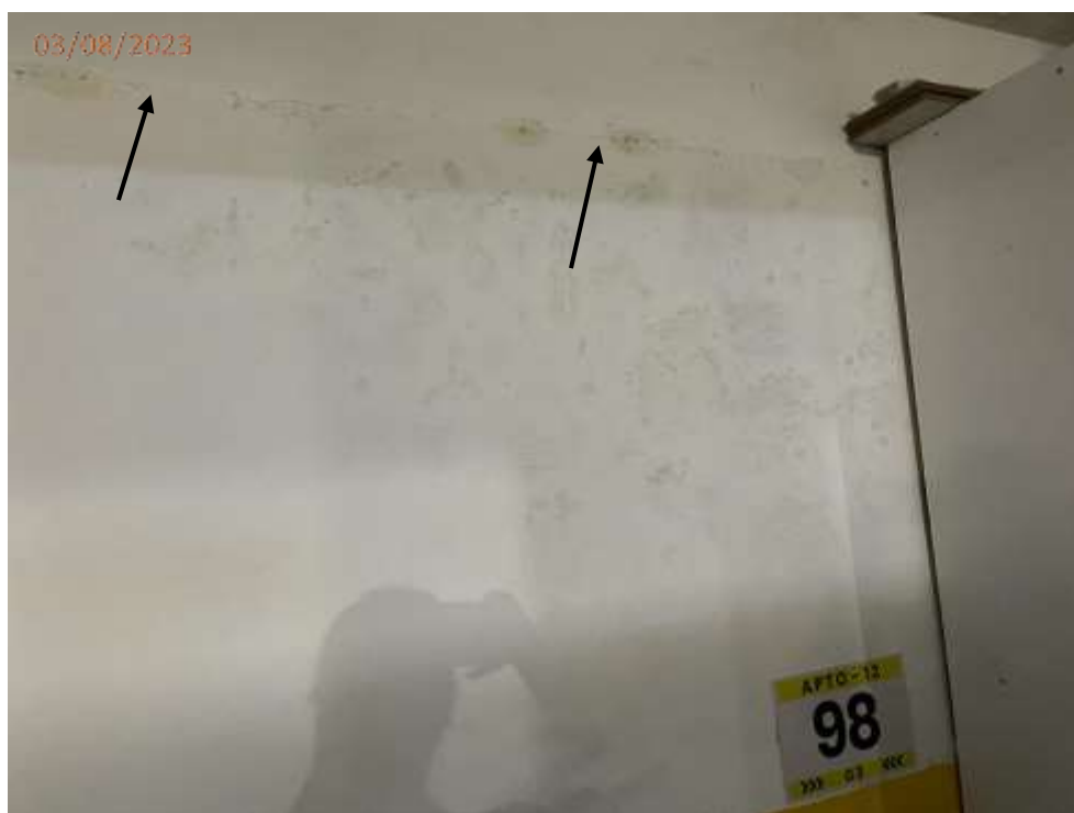
Foto 74: Trinca na parede junto a vaga V98.
