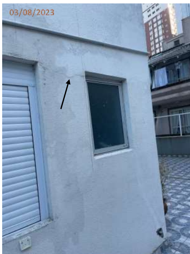
Foto 24: Trincas na parede da fachada junto ao terraço.
