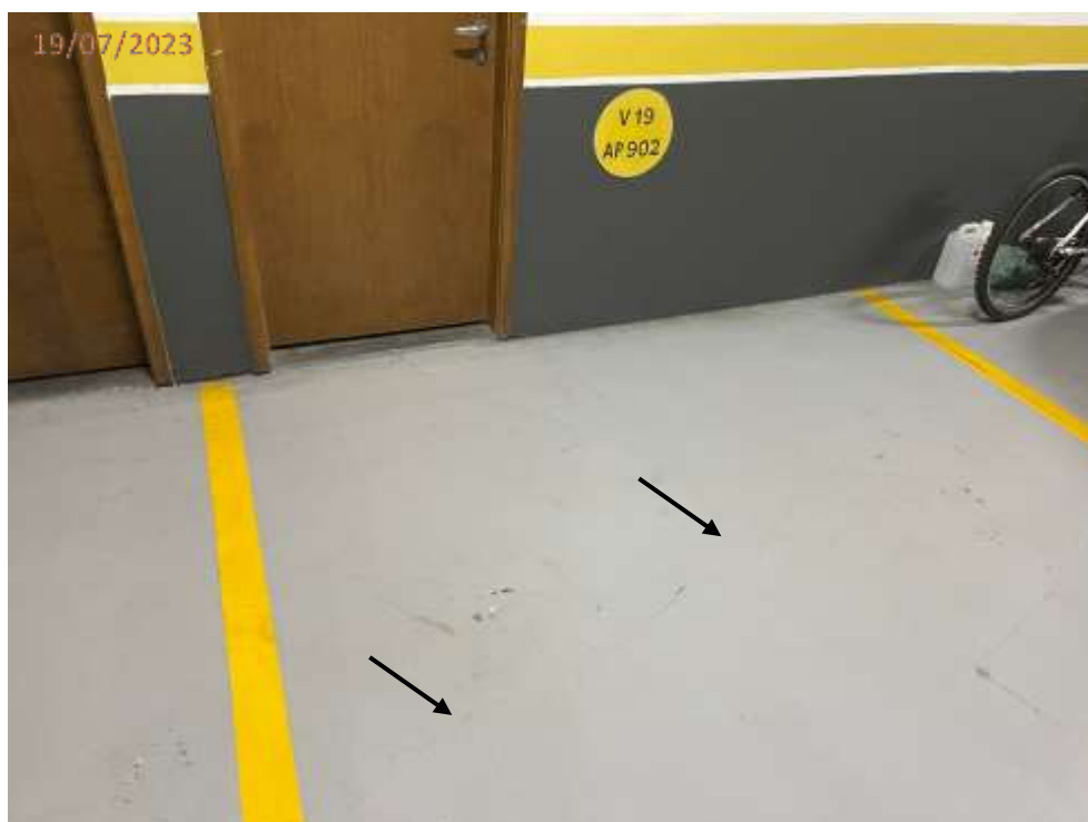
Fotos 76: Trinca piso junto a vaga V19.
