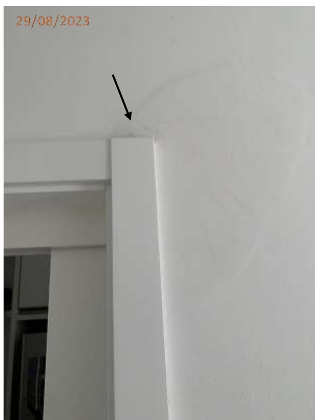
Fotos 03 e 04: Trinca nas paredes junto a porta de acesso a cozinha e porta de acesso a sacada.
