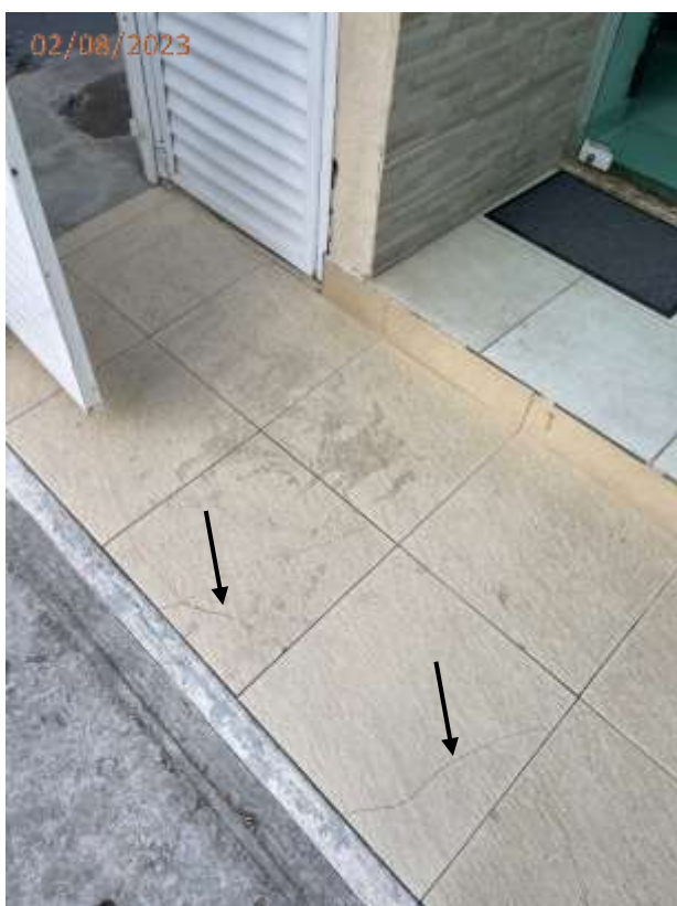
Fotos 51 e 52: Cerâmicas do piso quebradas na entrada do hall.
