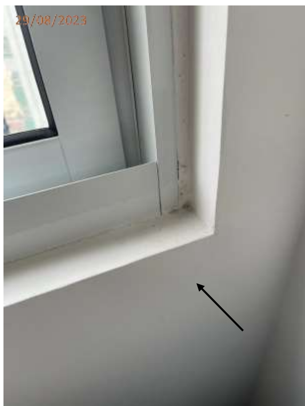
Fotos 13, 14, 15 e 16: Trinca na parede junto as janelas da suíte.
