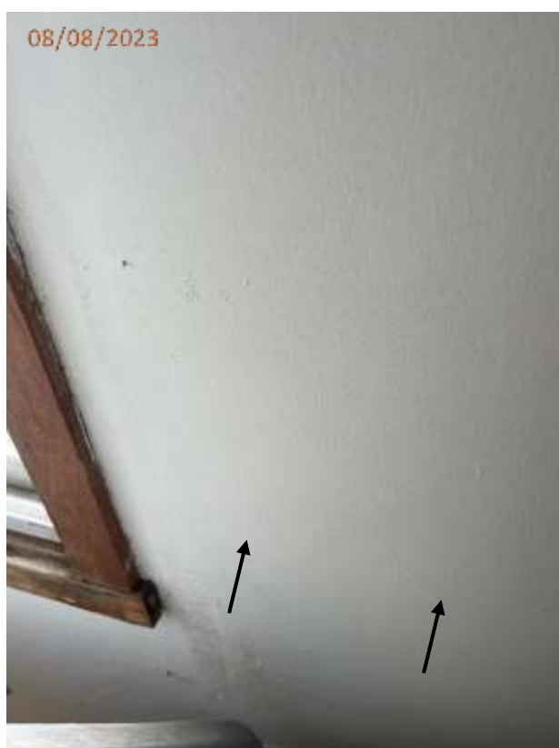
Fotos 06, 07, 08 e 09: Trincas na parede junto a janela da sala.
