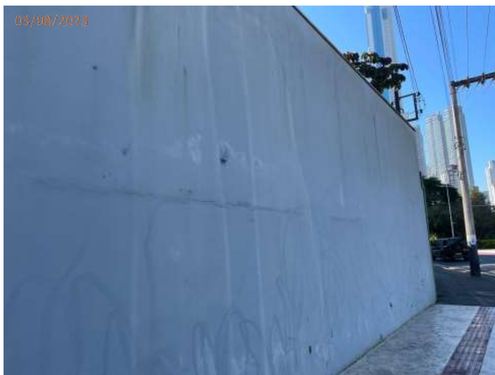
Fotos 133, 134 e 135: Trincas no muro da edificação.
