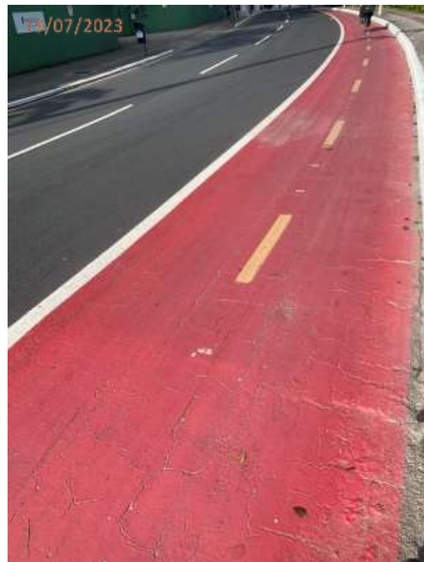
Fotos 06 e 07: Ciclo faixa da Av. Normando Tedesco apresentando rachaduras no piso.
