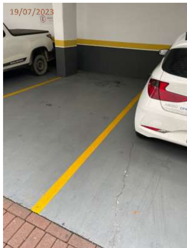
Foto 86: Rachadura no piso da vaga de visitantes.
