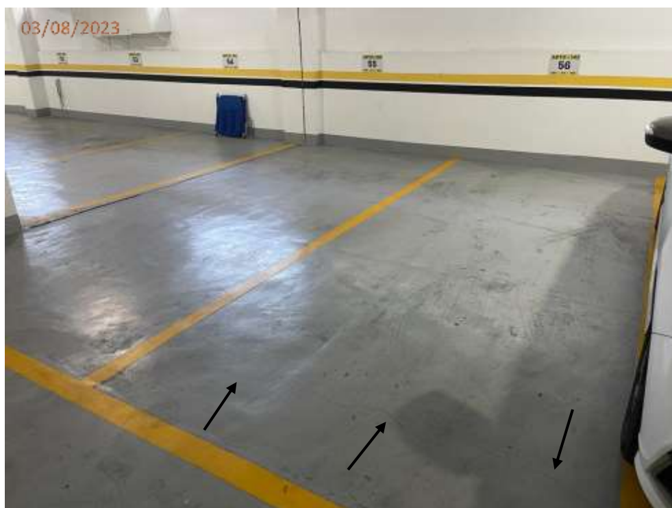
Foto 98: Trincas no piso da vaga V56.
