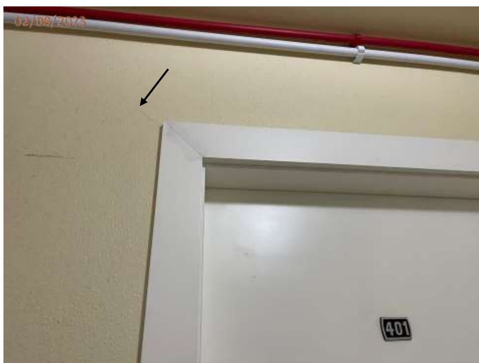
Fotos 09 e 10: Fissura nas paredes do hall junto a porta dos Aptos 504 e 401.
