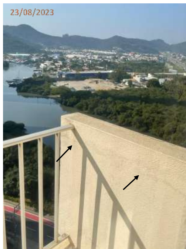
Foto 06: Trinca no peitoril da sacada.
