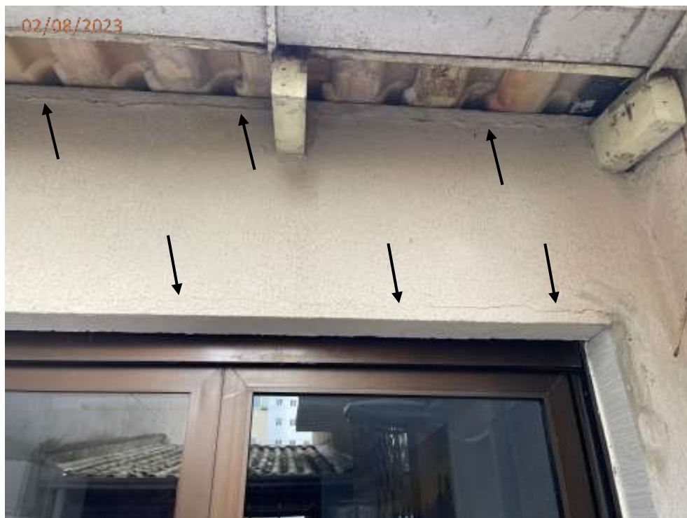
Fotos 26 e 27: Fissuras na parede da garagem junto ao salão de festas.
