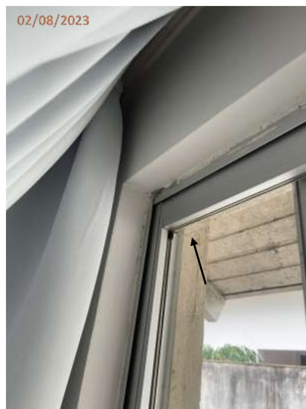
Fotos 08 e 09: Trinca no teto e vidro quebrado na janela do dormitório.
