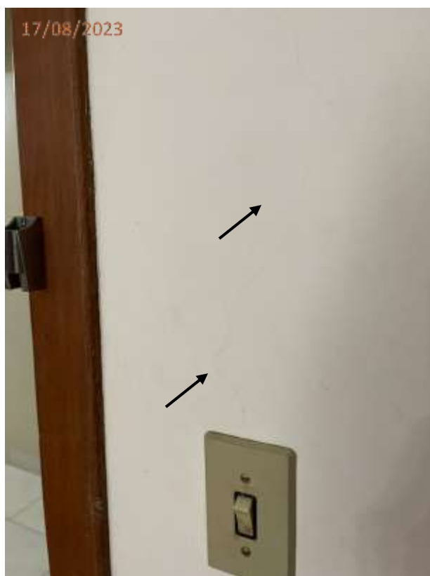
Fotos 03 e 04: Trinca nas paredes junto ao interruptos de entrada e junto a janela da sala.
