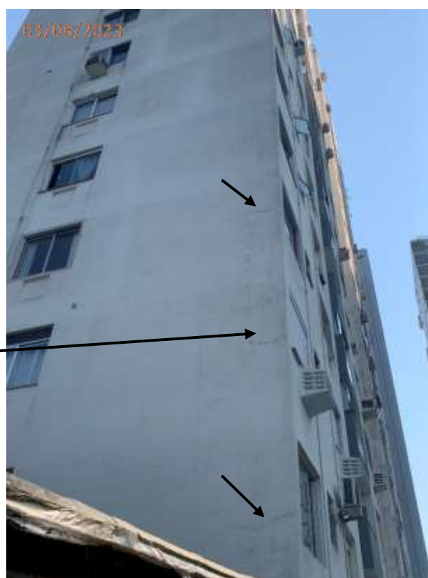
Fotos 148 e 149: Trincas e desgaste do revestimento na fachada da torre lado Av. Normando Tedesco.
