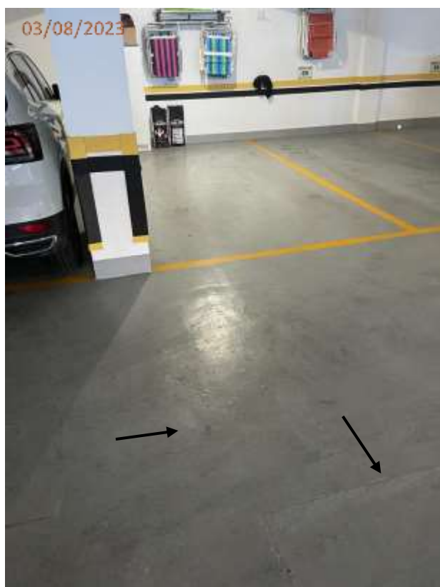
Foto 85: Trinca no piso na circulação de veículos em frente a vaga V64.
