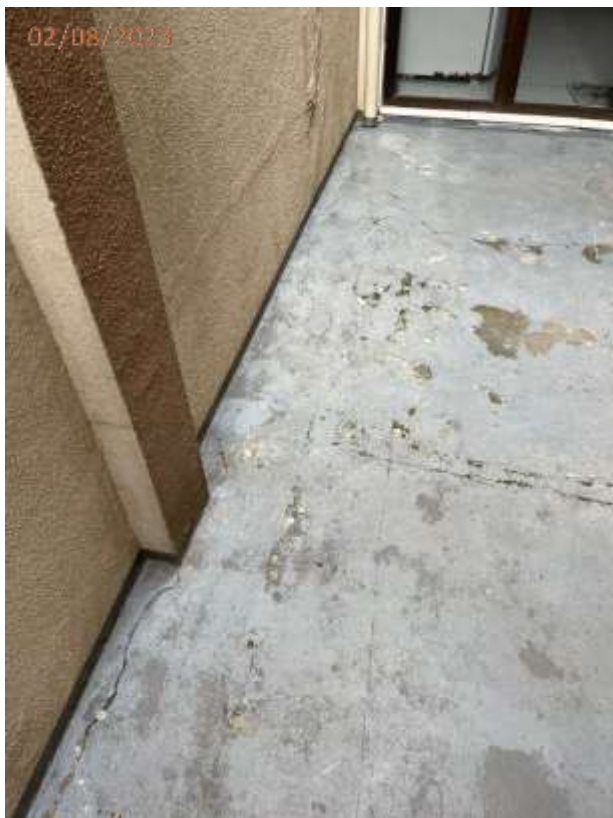
Fotos 30, 31, 32 e 33: Trincas e rachaduras generalizadas no piso da garagem lateral esquerda da edificação.
