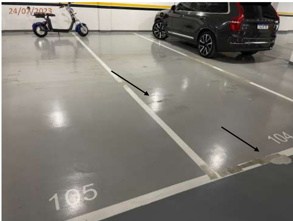
Fotos 38 e 39: Descolamento de revestimento junto ao piso da garagem;
