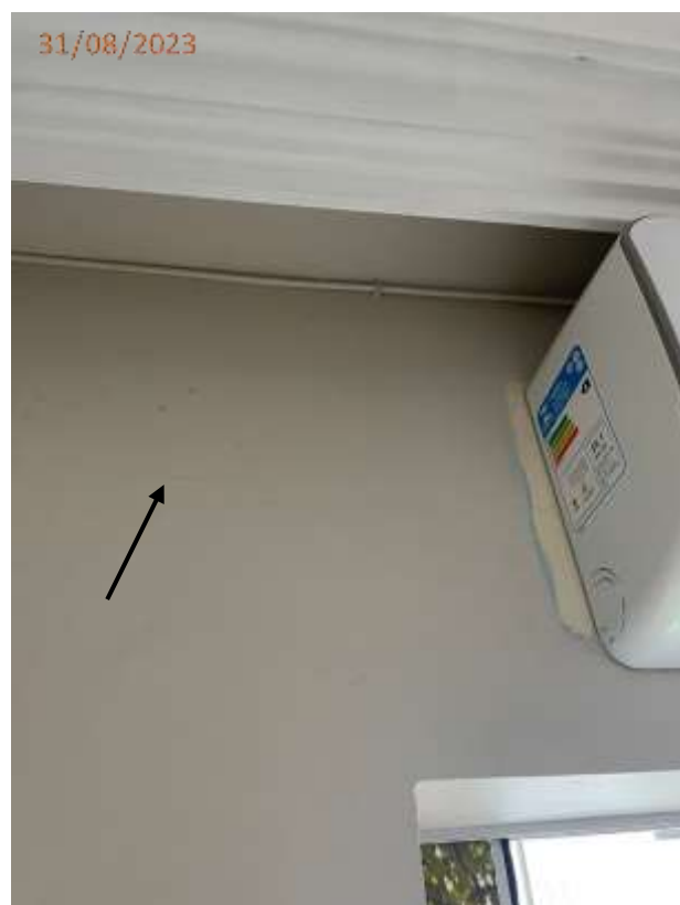
Fotos 02 e 03: Trinca na parede da sala junto a porta de acesso a sacada.
