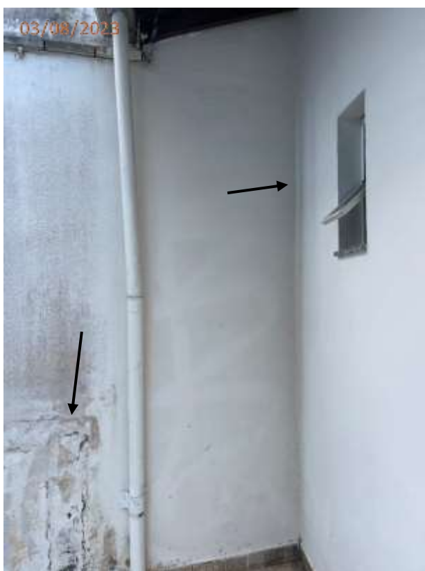
Fotos 119 e 120: Trincas na parede e muro da área externa lateral direita da edificação.
