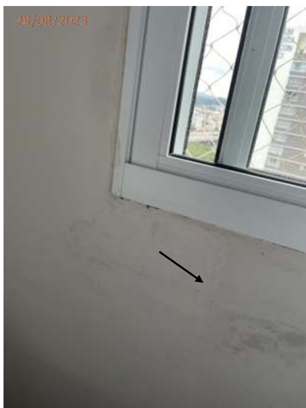
Fotos 12, 13, 14 e 15: Trincas na parede junto a janela do dormitório.
