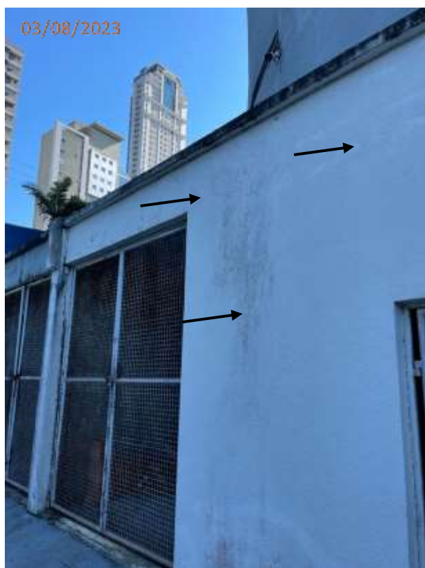
Fotos 121, 122, 123 e 124: Trincas nas paredes dos box's da área externa lateral direita da edificação.
