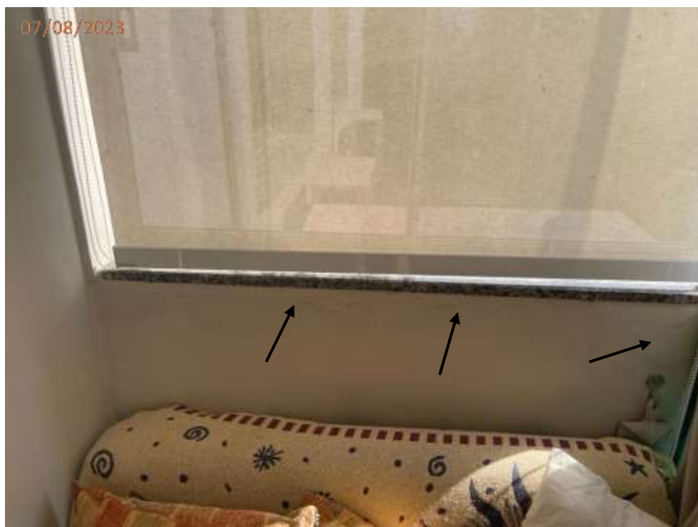
Fotos 04 e 05: Trinca na parede junto a janela da sacada.
