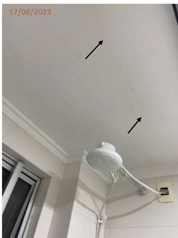
Fotos 08 e 09: Trinca no teto do banheiro.
