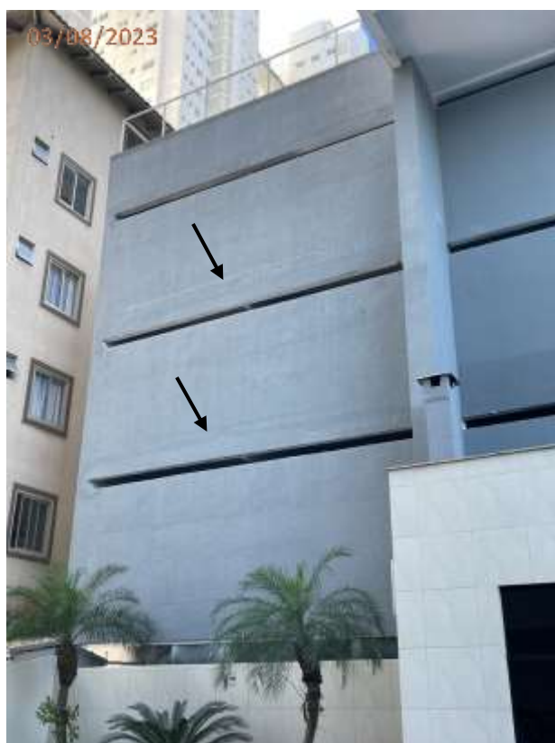
Foto 139: Trincas na fachada da garagem junto a rua 4.100.
