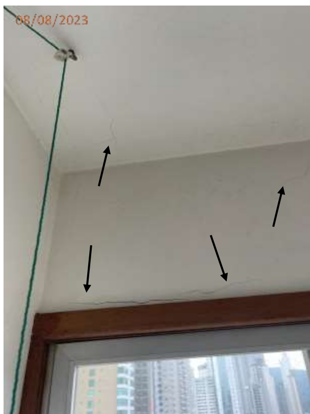
Fotos 12 e 13: Trinca na parede e teto da cozinha.
