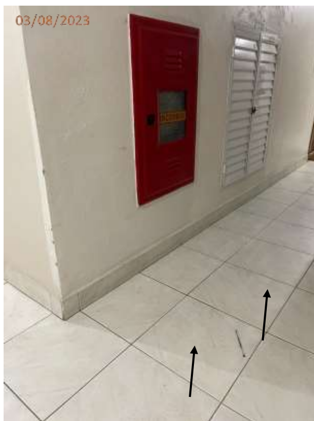
Foto 44: Som cavo (choco) ao toque nos pisos em frente a porta do elevador no hall do 8º andar.
