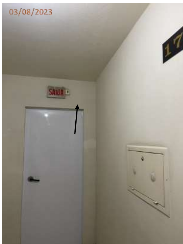
Fotos 28 e 29: Trinca na parede junto a porta corta fogo e junto ao Apto 175 no hall do 18º andar.
