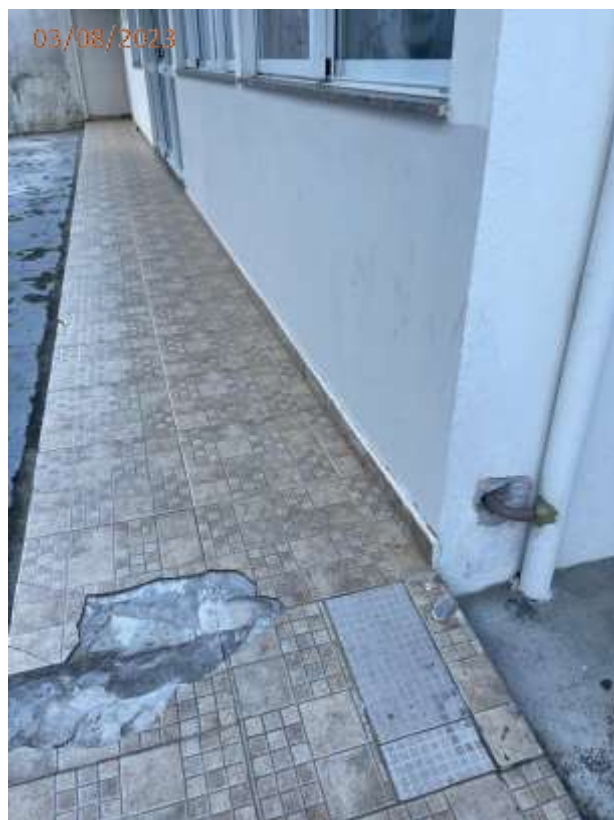
Foto 118: Pisos cerâmicos quebrados na do pátio lateral da edificação.
