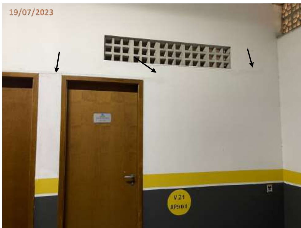
Foto 79: Trinca na parede junto a vaga V21.
