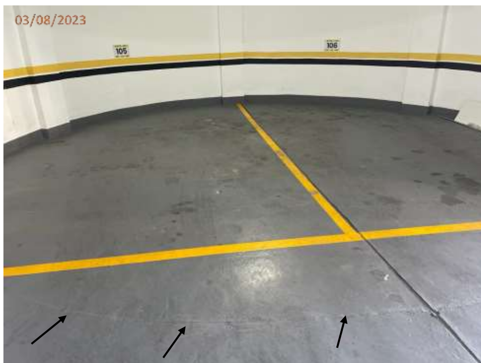
Foto 73: Trincas no piso junto a vaga V105/106.
