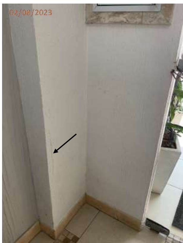
Fotos 22 e 23: Trincas nas paredes do hall de entrada do térreo.
