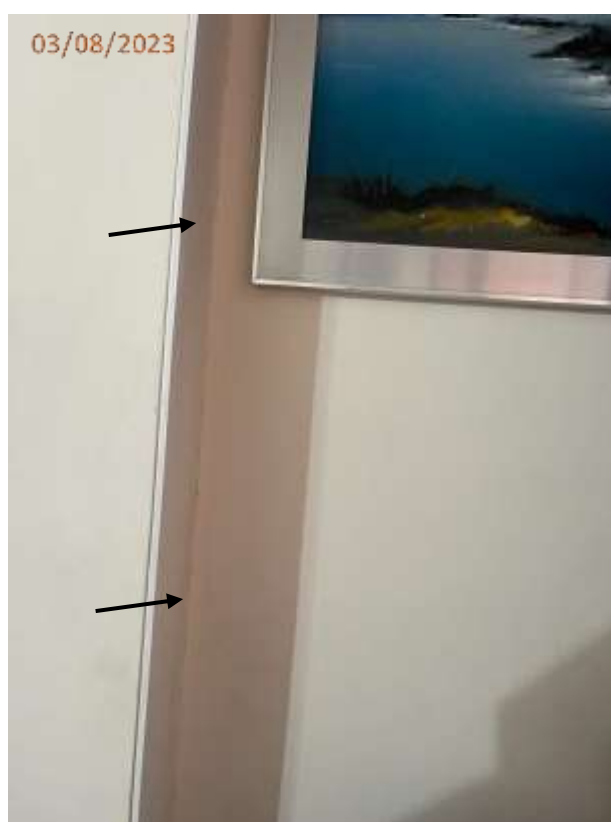
Fotos 03 e 04: Fissura na parede da sala divisa com cozinha e parede encontro pilar/alvenaria.
