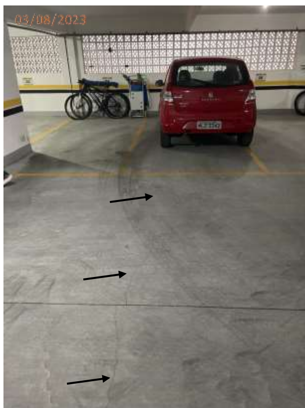
Foto 110: Trinca no piso da circulação em frente a vaga V05.
