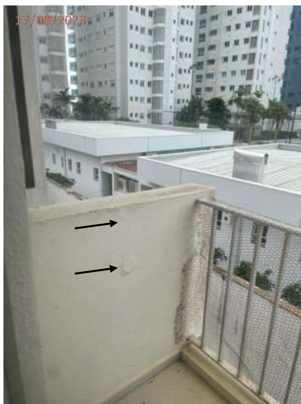
Foto 03: Trincas no guarda corpo da sacada.
