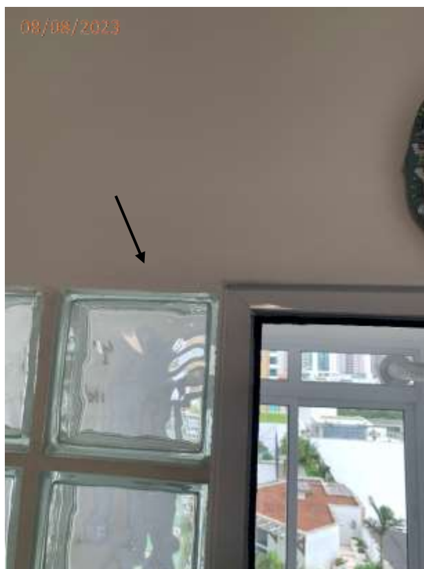
Foto 12: Fissura na parede ao lado da porta de acesso a área de serviço.
