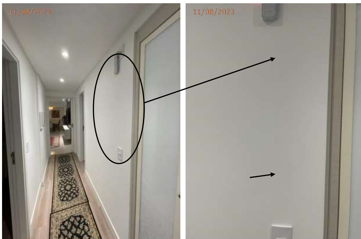
Fotos 08 e 09: Fissura na parede junto ao interruptor na circulação íntima.
