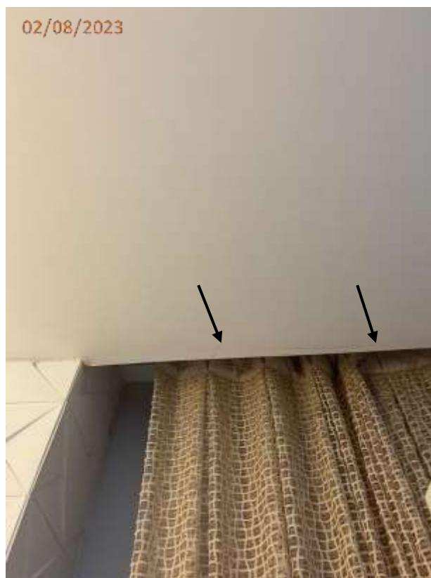
Fotos 02 e 03: Fissura no teto da sala junto a entrada do Apto.
