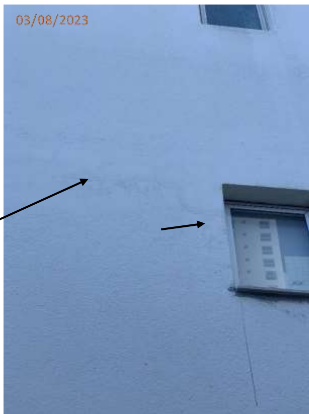
Fotos 159 e 160: Trincas na fachada do fundo divisa com terreno.
