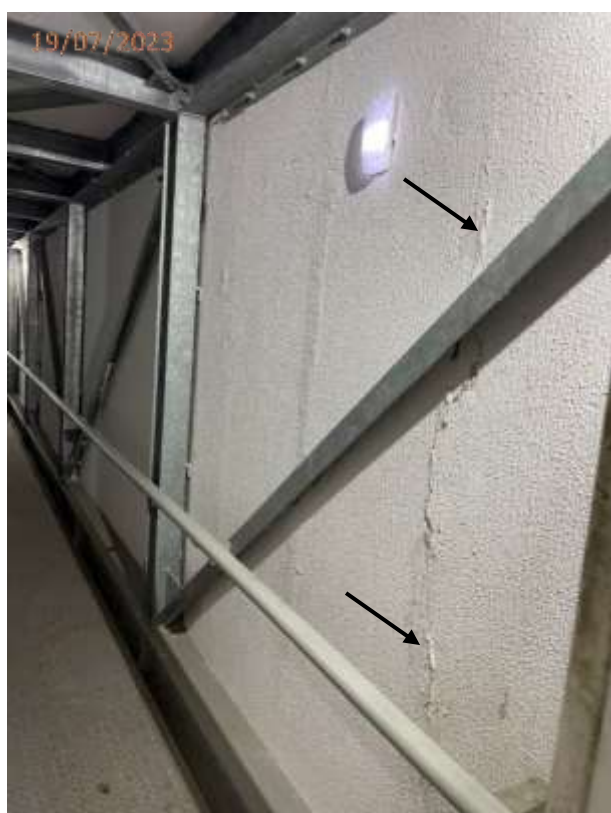
Fotos 109 e 110: Trincas e rachaduras na parede da passarela torres sul/central.
