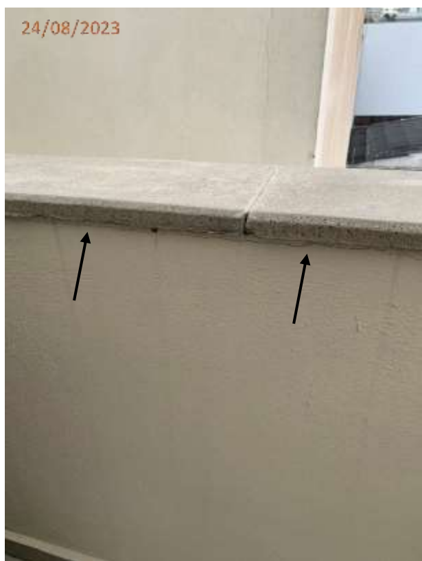
Fotos 13, 14, 15 e 16: Trincas no peitoril e muro do terraço.
