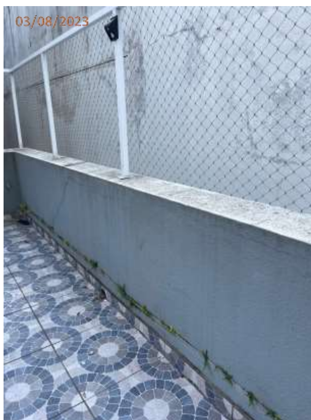
Fotos 26 e 27: Trincas generalizadas no peitoril do terraço.
