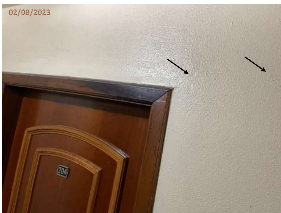
Fotos 11 e 12: Fissura na parede do hall junto a porta do Apto 204.
