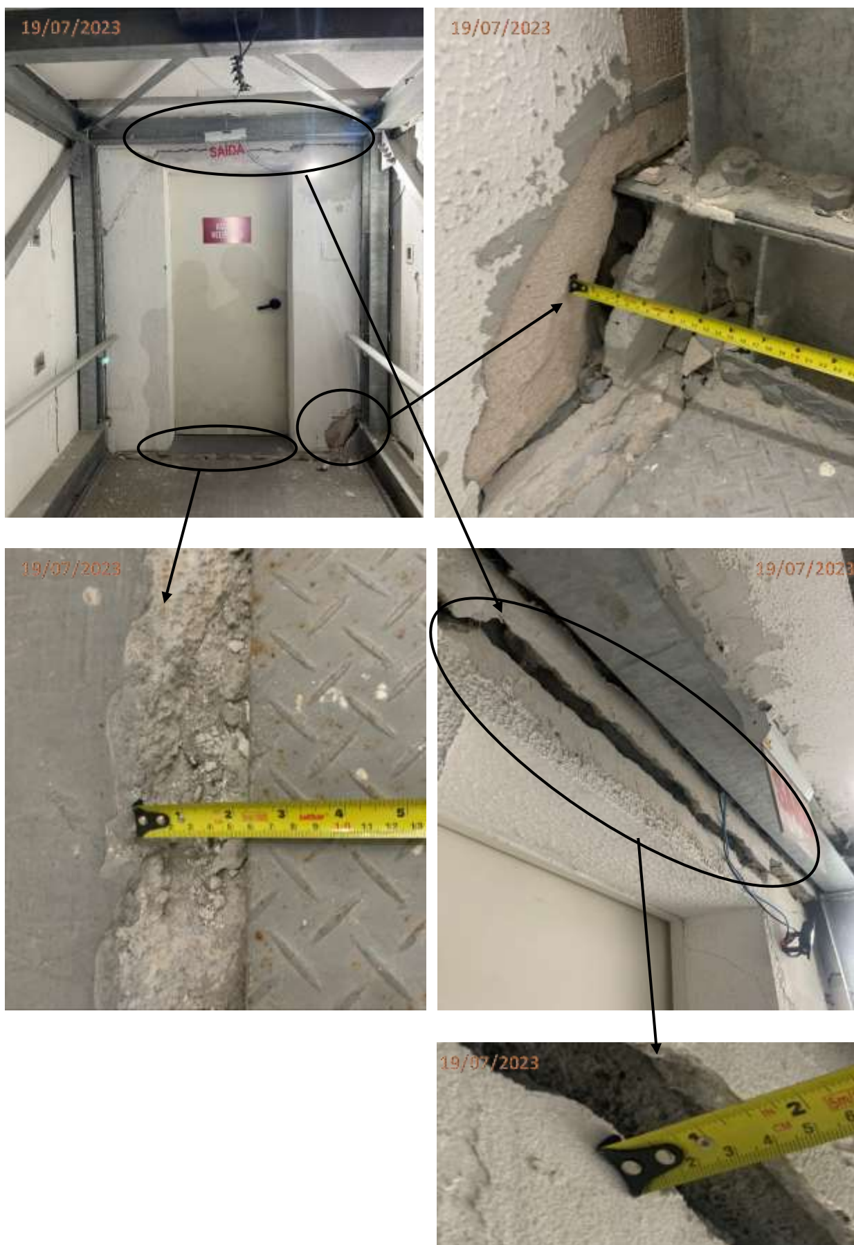
Fotos 115, 116, 117 e 118: Abertura na parede e piso da passarela junto a porta de acesso da torre central.
