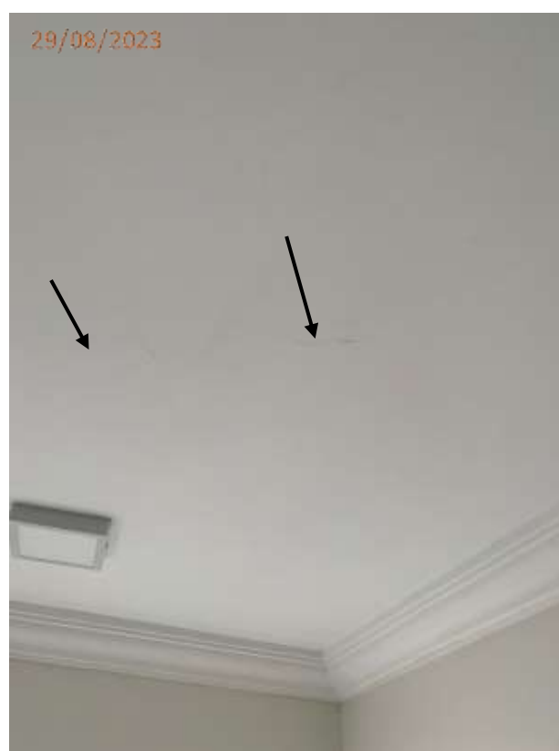
Fotos 07, 08, 09 e 10: Trinca nas paredes e teto do dormitório.
