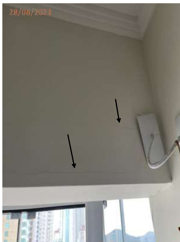
Fotos 03 e 04: Trinca na parede junto a porta de entrada e junto a janela da sala.
