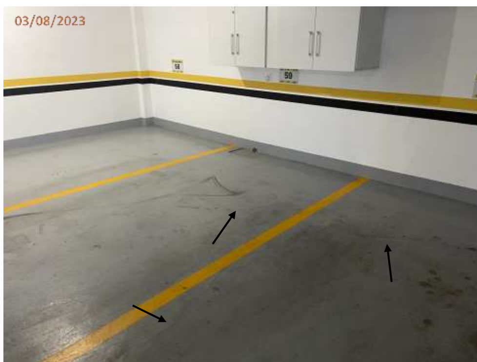
Fotos 87 e 88: Trincas no piso junto as vagas V62 e V60/59.
