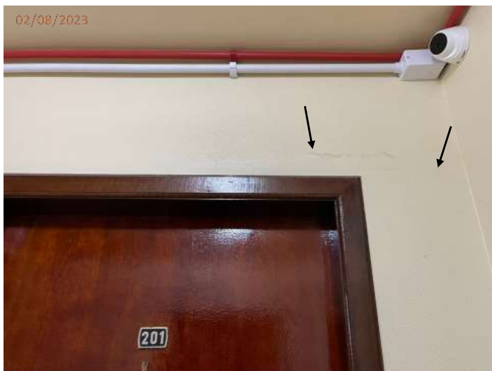
Foto 13: Fissura na parede do hall junto a porta do Apto 201.
