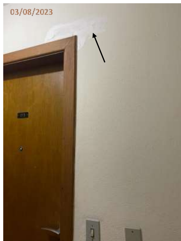
Fotos 28 e 29: Trinca na parede junto a porta corta fogo e junto ao Apto 175 no hall do 18º andar.
