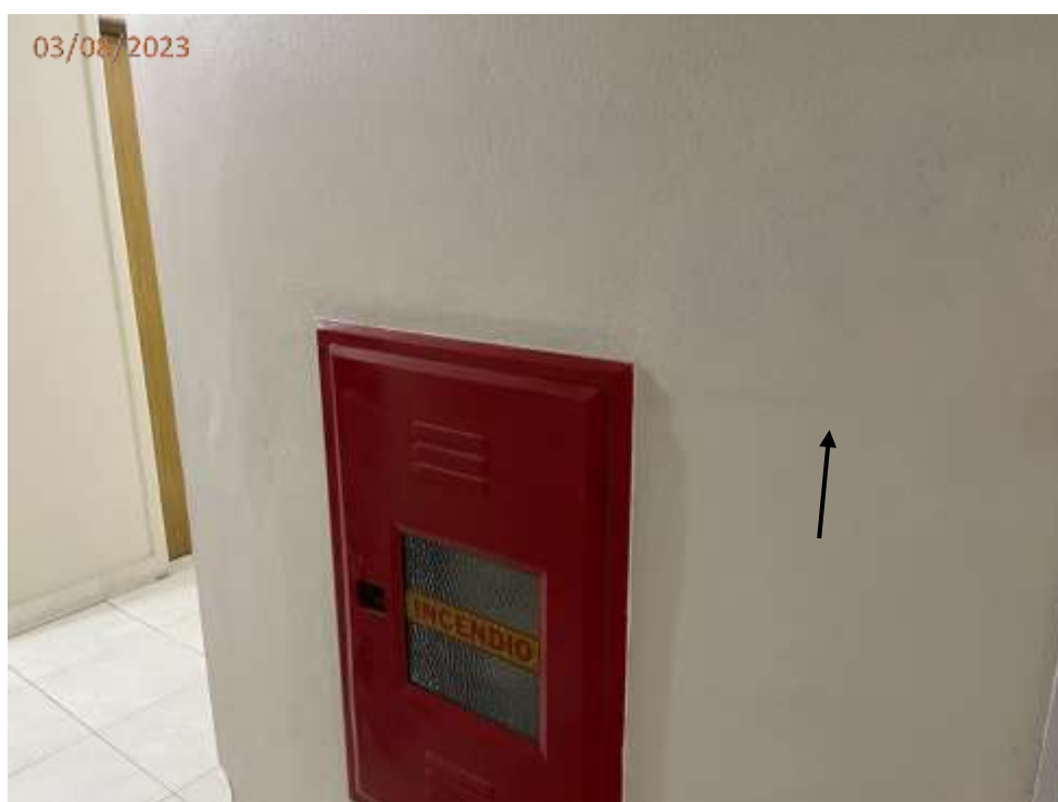
Fotos 26 e 27: Trinca na parede junto a porta do Apto 185 e junto ao hidrante no hall do 18º andar.
