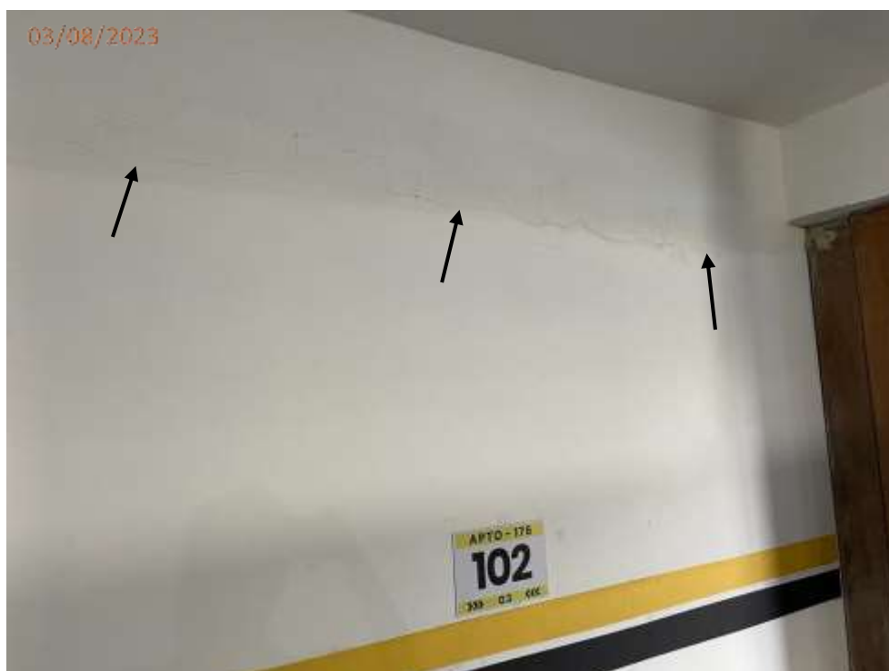
Foto 67: Trinca na parede junto a vaga V102.
