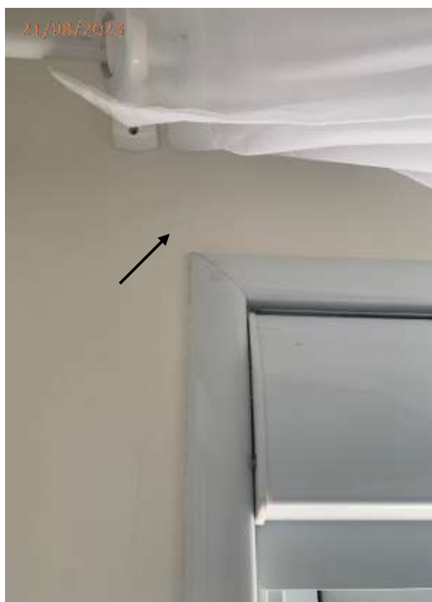
Fotos 13, 14, 15 e 16: Trincas na parede junto ao interruptos e janela do dormitório.
