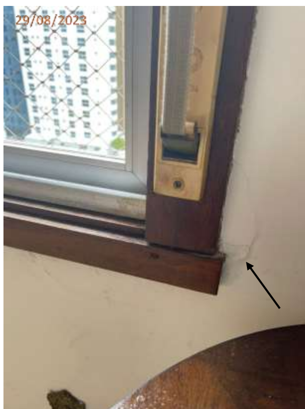
Fotos 12, 13 e 14: Trinca na parede ao lado do interruptor e da janela do dormitório.
