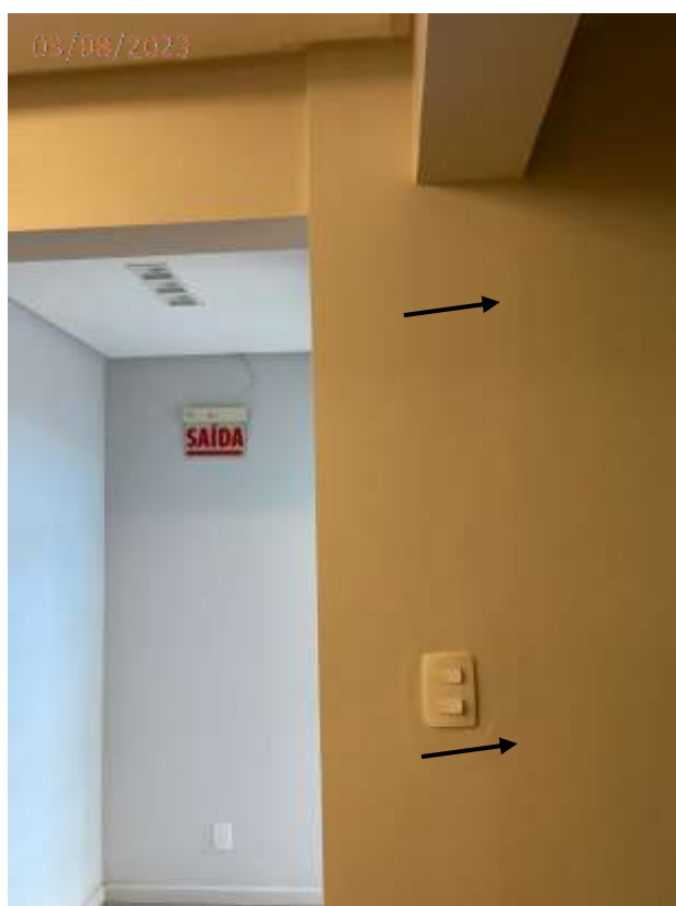
Foto 113: Fissura na parede do salão de festas.
