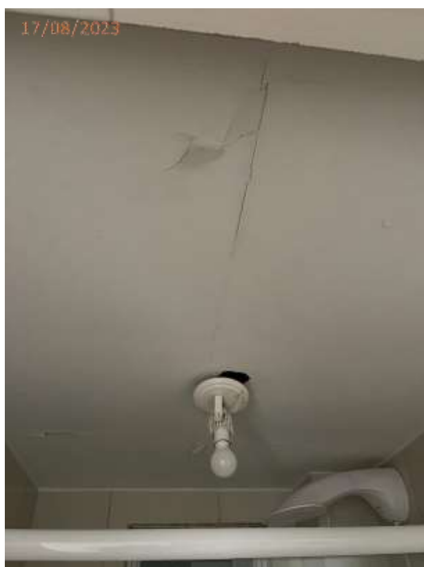
Fotos 08 e 09: Trincas no teto do banheiro.
