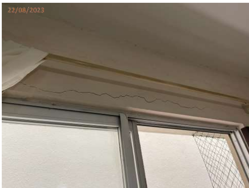
Foto 05: Rachadura na parede sobre a porta da sacada.
