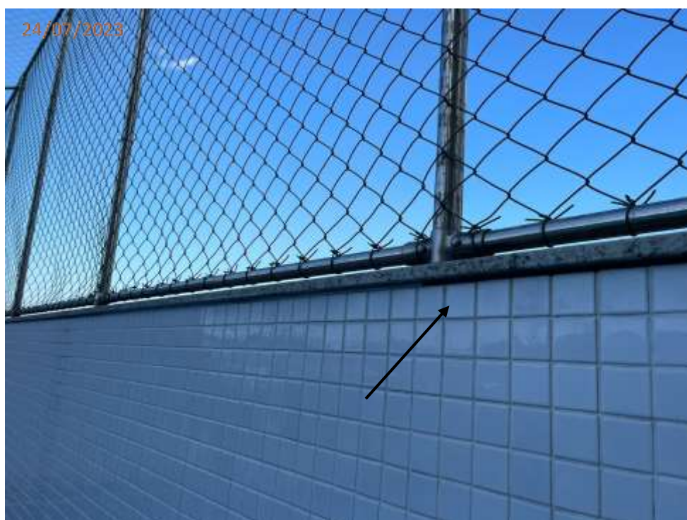
Foto 24: Falha no rejunte junto a soleira na quadra.
