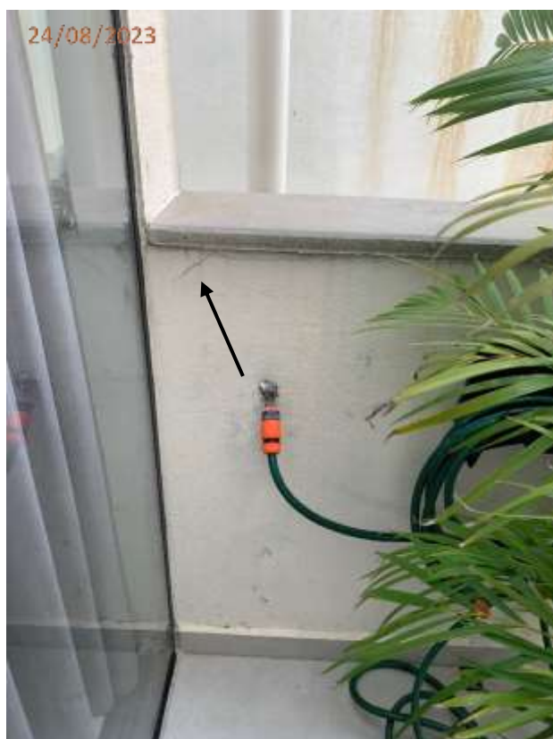
Foto 17: Trinca no peitoril do terraço.
