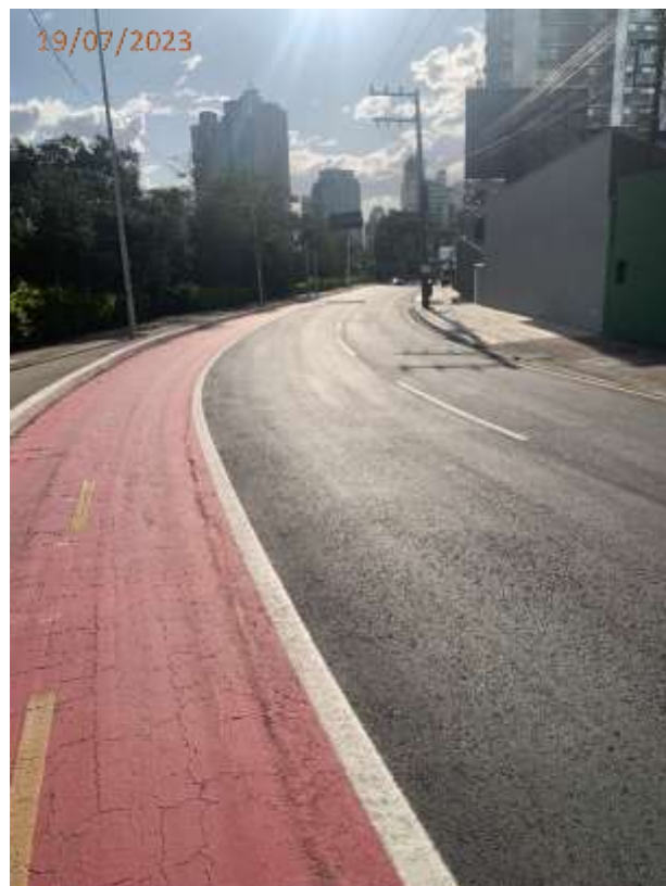
Fotos 12, 13, 14 e 15: Ciclo faixa da Av. Normando Tedesco apresentando rachaduras no piso.
