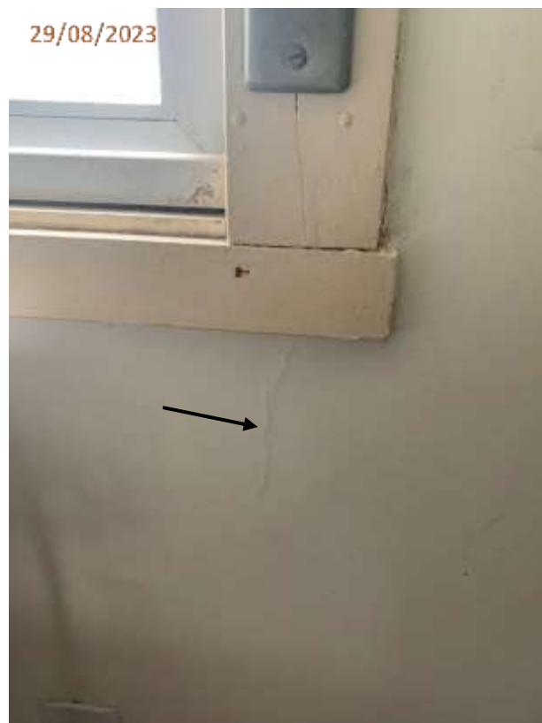
Fotos 08 e 09: Fissura na parede junto a janela do dormitório.
