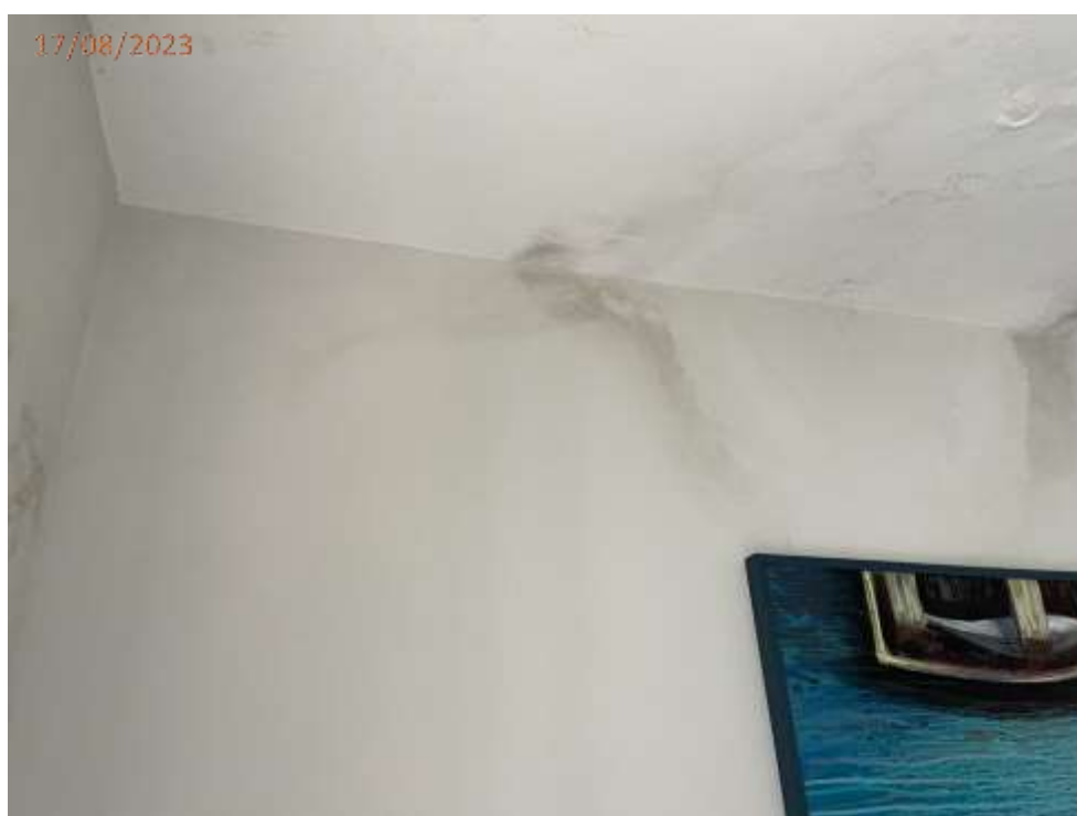
Fotos 20, 21 e 22: Trincas no teto e na parede do dormitório.
