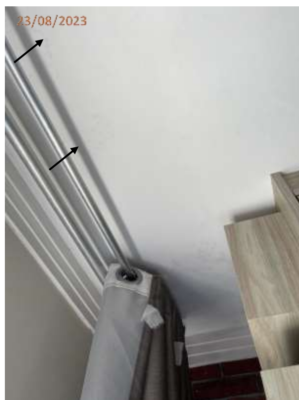
Fotos 12, 13 e 14: Trinca na parede junto a janela e no teto do dormitório.
