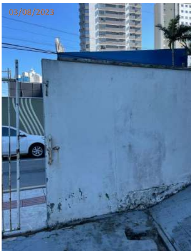
Foto 127: Trincas no muro lateral direito da edificação.
