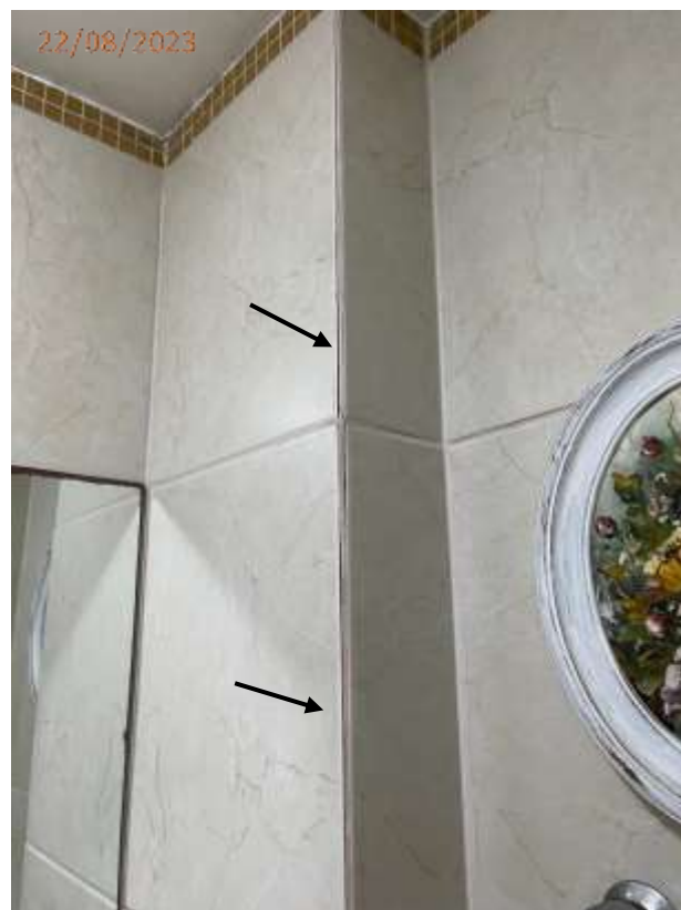
Fotos 12, 13, 14 e 15: Vidro da janela quebrado, trincas no teto e descolamento de azulejo no banheiro.
