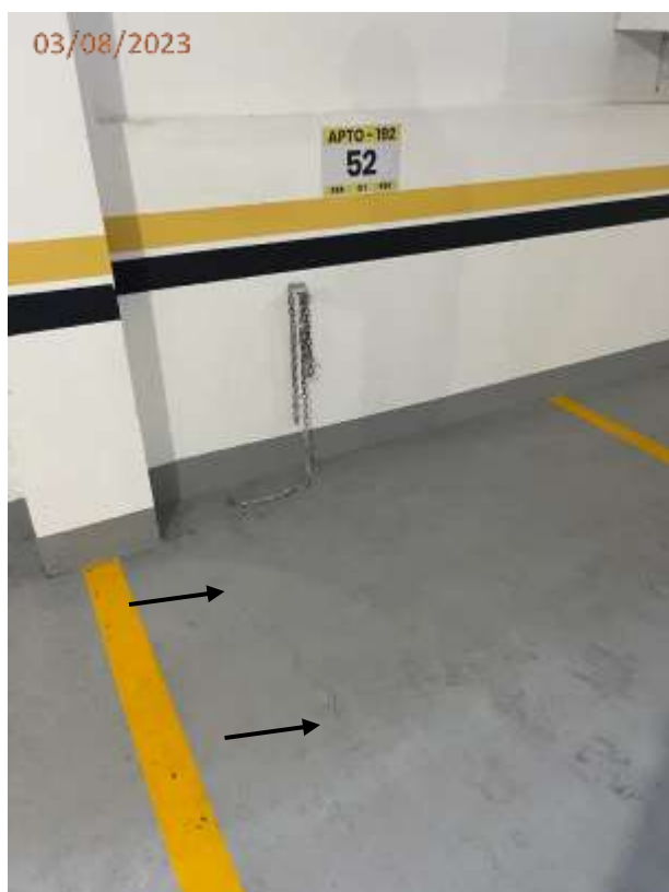
Foto 99: Trincas no piso da vaga V52.
