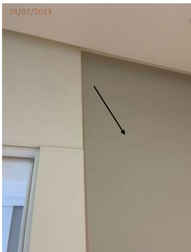
Foto 11: Fissura na parede ao lado da porta do fraldário.
