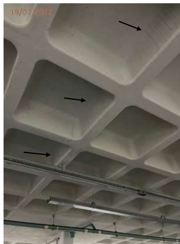
Fotos 45 e 46: Trinca no teto da circulação de veículos em frente a vaga V332.
