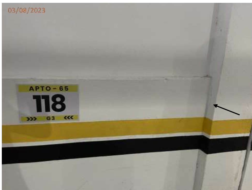
Foto 67: Trinca na parede junto a vaga V118.
