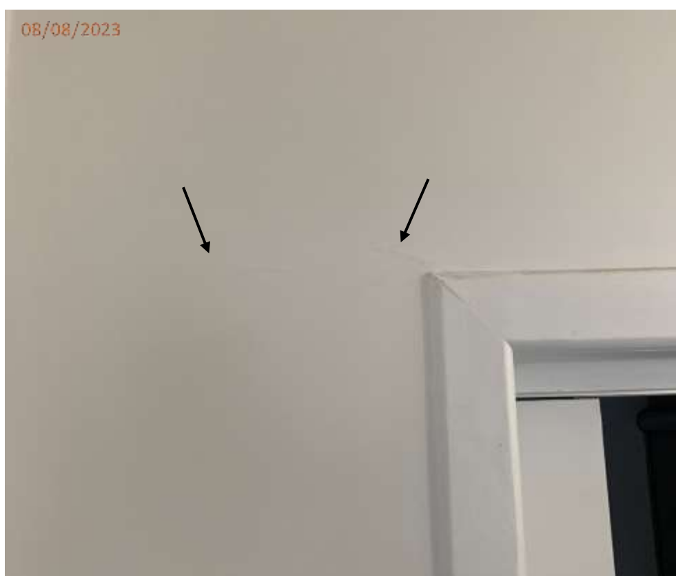
Fotos 04 e 05: Fissura na parede da circulação íntima junto a porta do banheiro.
