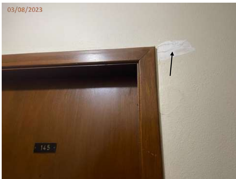
Foto 33: Fissura na parede junto a porta do Apto 145 no hall do 14º andar.
