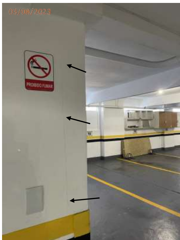
Foto 65: Trinca na parede ao lado do hall.
