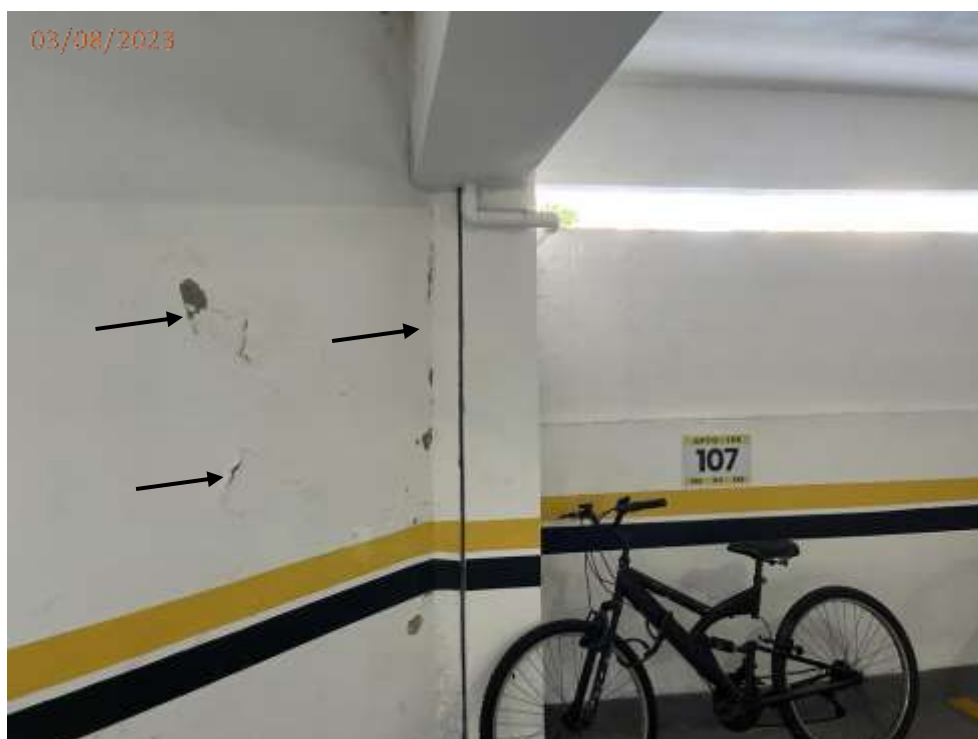
Foto 72: Trinca na parede junto a vaga V107.
