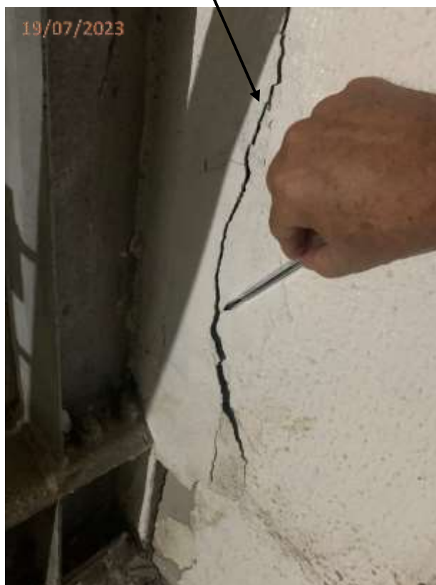
Fotos 128, 129 e 130: Rachaduras na parede da passarela entre a torres central/norte.
