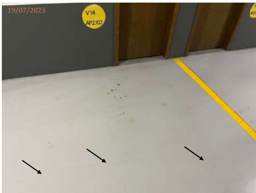
Fotos 72 e 73: Trincas no piso junto as vagas V13 e V14.
