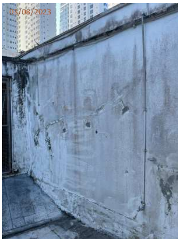
Fotos 119 e 120: Trincas na parede e muro da área externa lateral direita da edificação.
