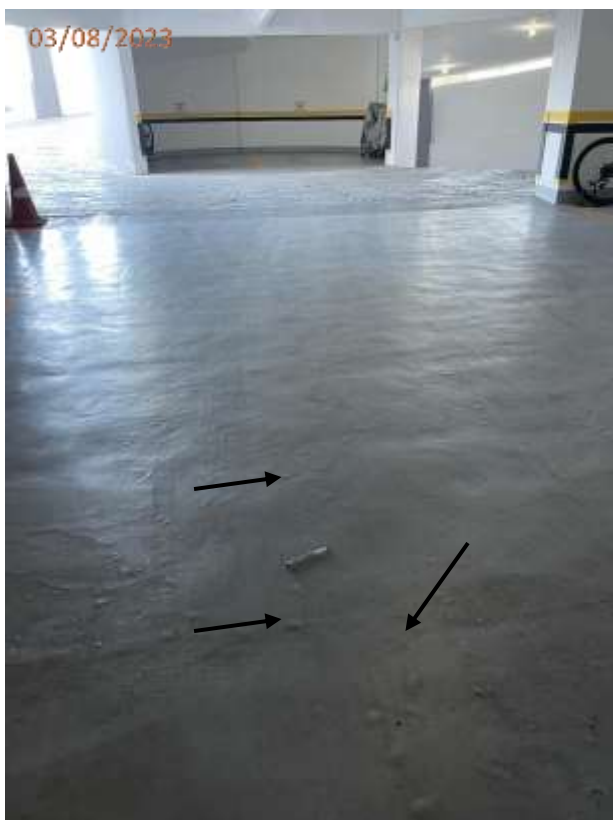
Foto 81: Trincas no piso na circulação de veículos em frente a vaga V71.
