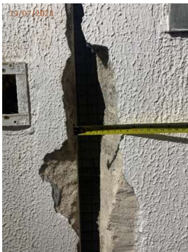
Fotos 111, 112, 113 e 114: Abertura na parede da passarela ao lado da porta de acesso da torre central.
