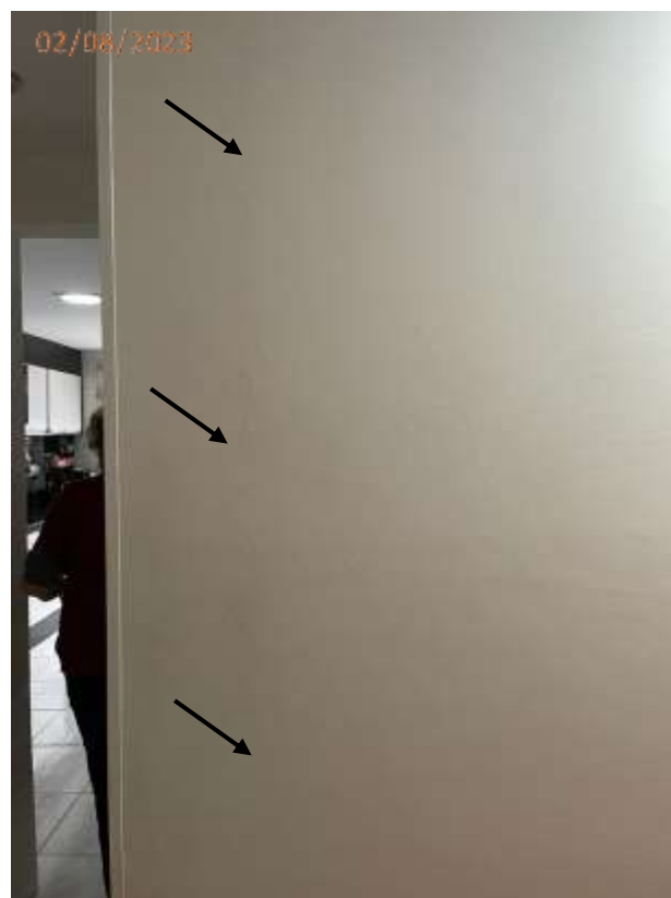
Fotos 03, 04, 05 e 06: Fissura na parede da sala junto a janela, trinca na viga, fissura junto ao interruptor e na parede junto a cozinha.
