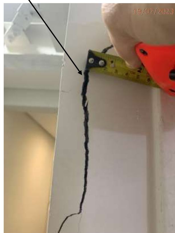
Fotos 101, 102, 103 e 104: Trincas e rachaduras na parede de acesso a passarela torres sul/central.
