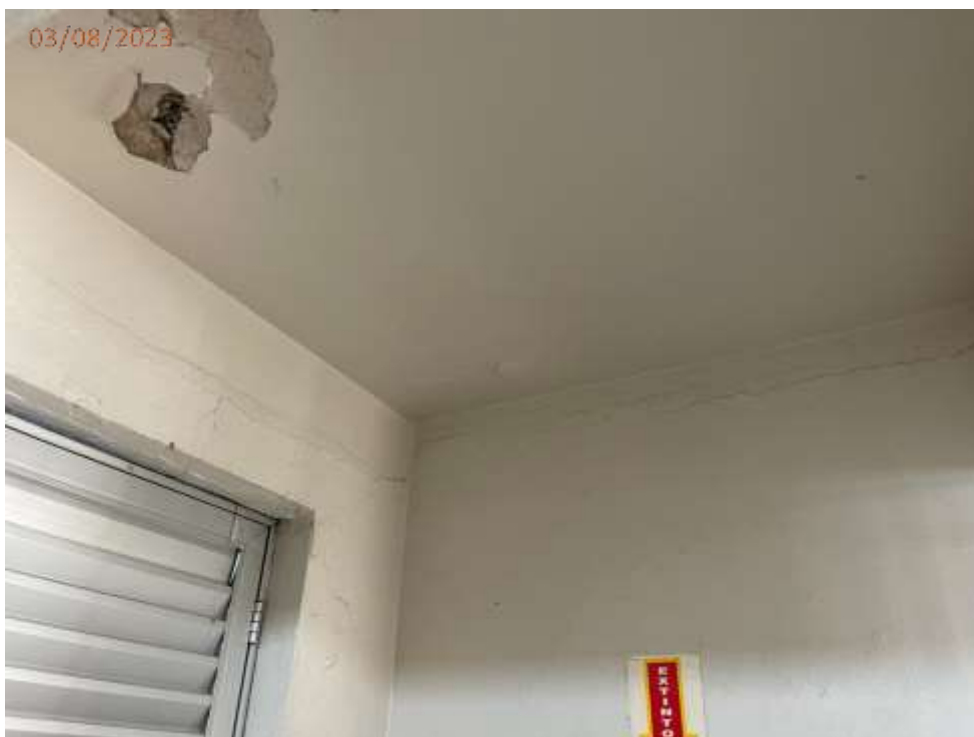
Foto 12: Trinca na parede e descolamento de revestimento no teto no hall de acesso a cobertura.
