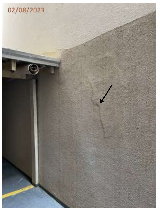
Fotos 40 e 41: Trincas nas paredes da garagem lateral direita da edificação.
