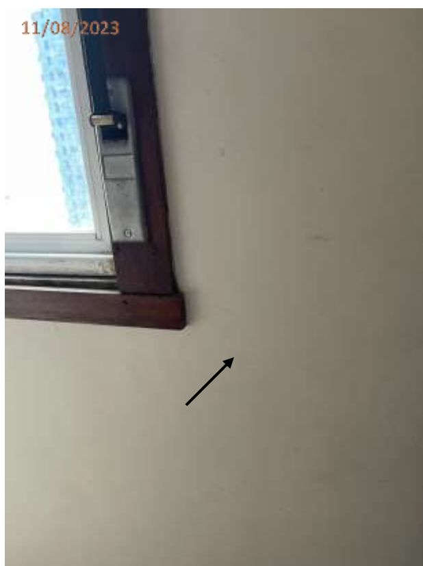
Fotos 11 e 12: Fissura na parede junto a janela do dormitório.
