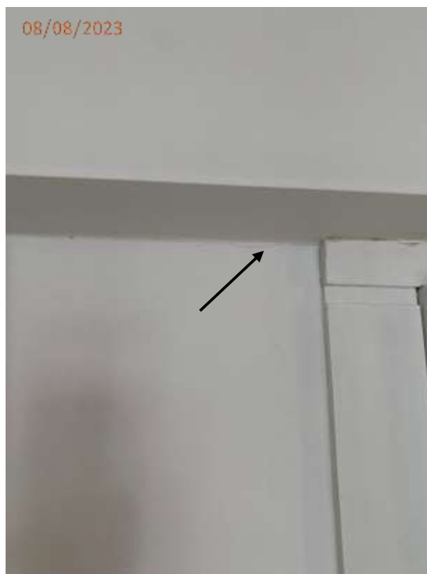
Fotos 02 e 03: Trinca na parede da sala junto a porta de entrada do Apto.
