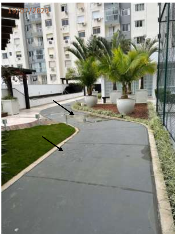
Foto 11: Trincas e acúmulo de água no piso na área de caminhada.
