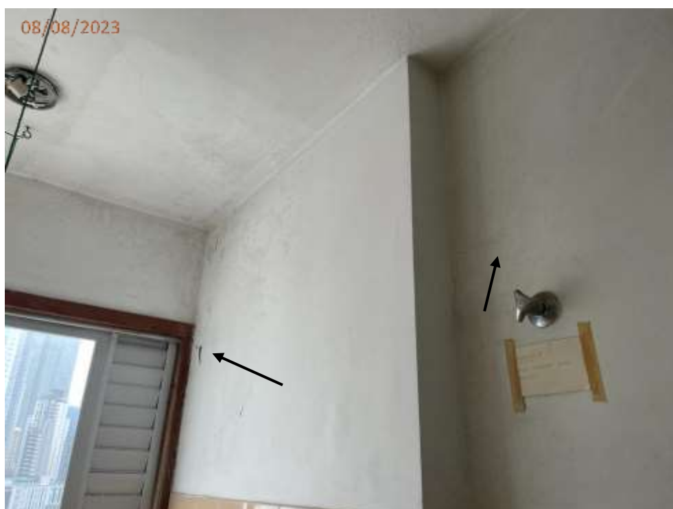
Fotos 10 e 11: Trinca na parede da cozinha.
