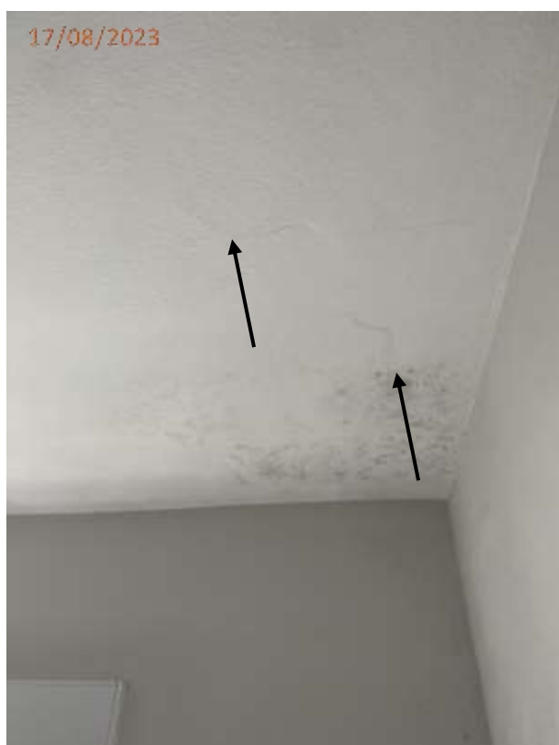
Fotos 13, 14 e 15: Trinca no teto e na parede junto a janela do dormitório.
