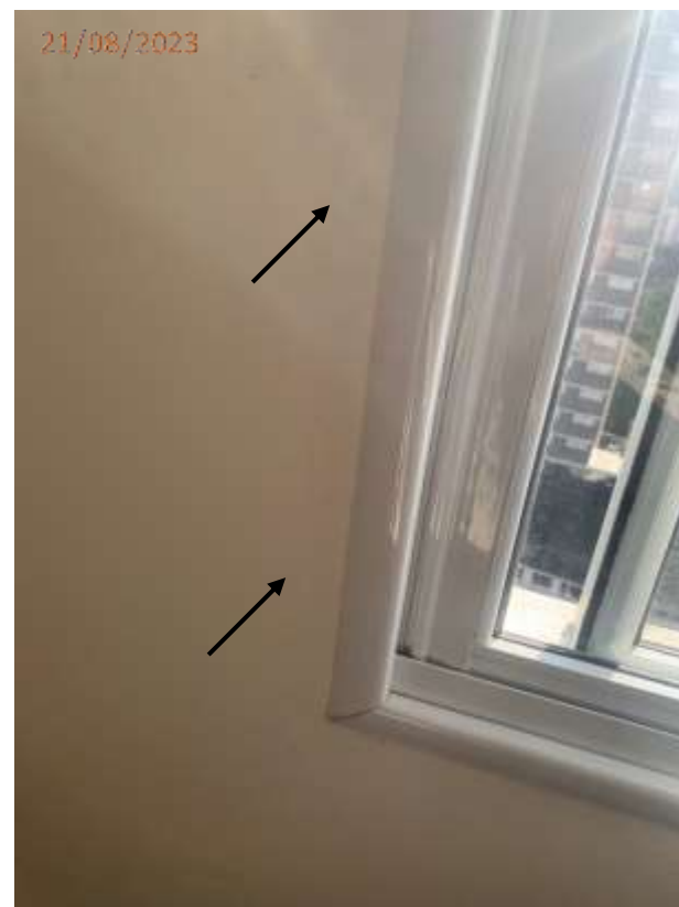
Fotos 21, 22, 23 e 24: Trincas na parede junto a porta do bwc e janela da suíte.
