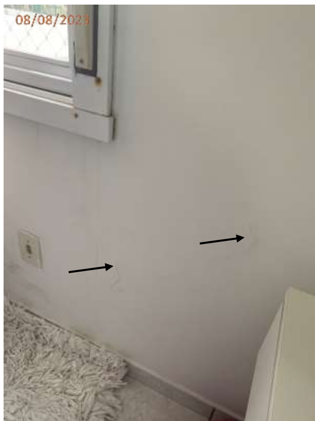
Fotos 08, 09 e 10: Trinca na parede junto a porta e junto a janela do dormitório.
