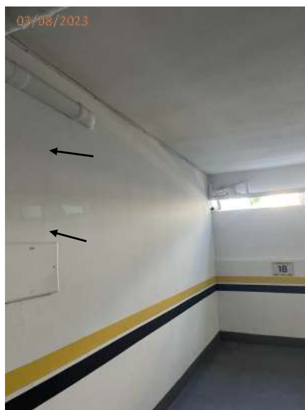
Foto 66: Trinca na parede junto a vaga V18.
