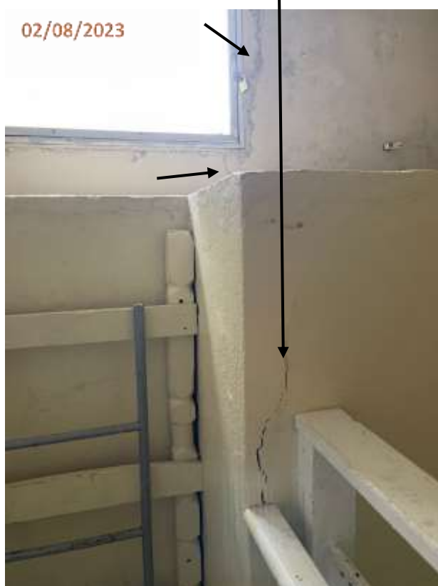
Fotos 02, 03 e 04: Trincas e fissuras nas paredes da área de acesso a cobertura e casa de máquinas do elevador.
