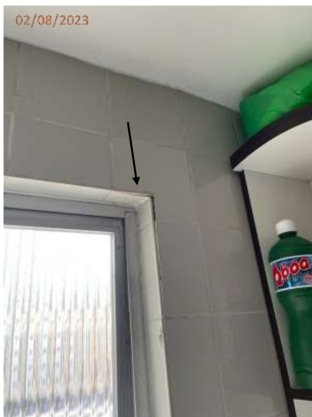
Foto 07: Descolamento de azulejo junto a janela da área d serviço.
