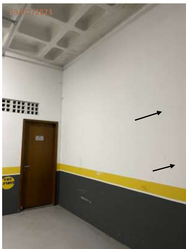
Fotos 68 e 69: Trinca na parede da vaga V09 e parede da escada.
