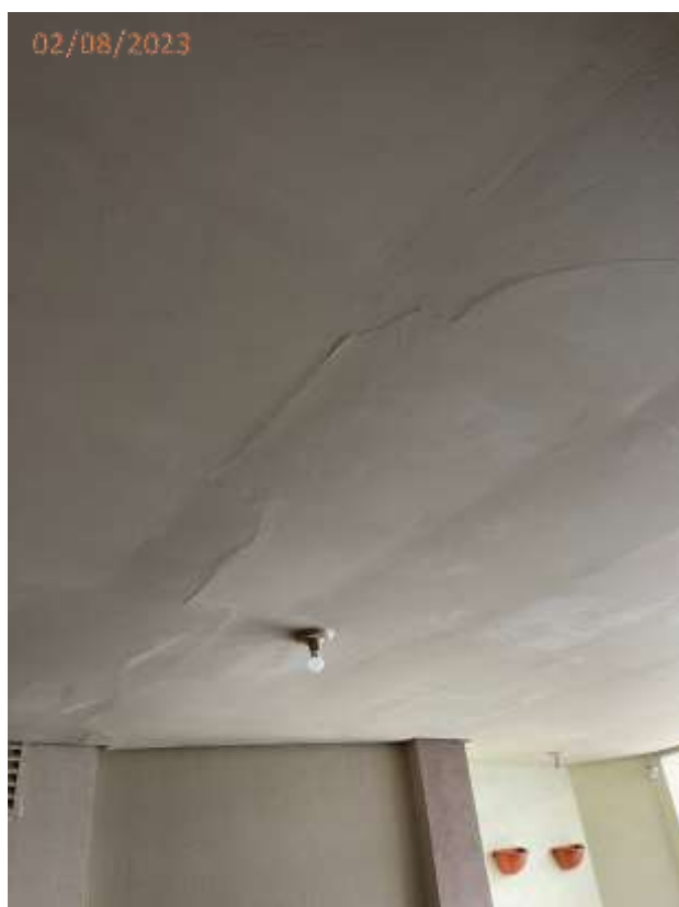
Foto 28: Trincas no teto da garagem lateral esquerda da edificação.
