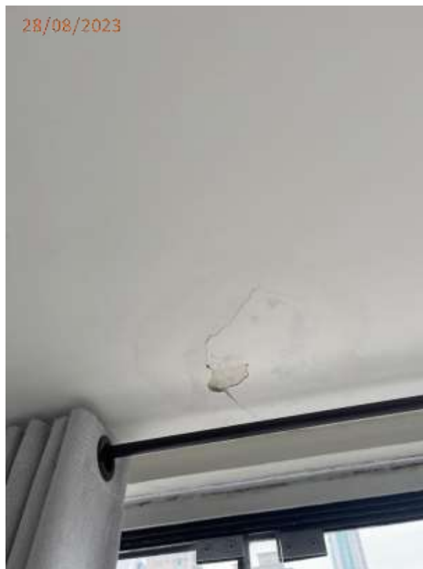
Fotos 07 e 08: Descolamento de revestimento no teto da sala.
