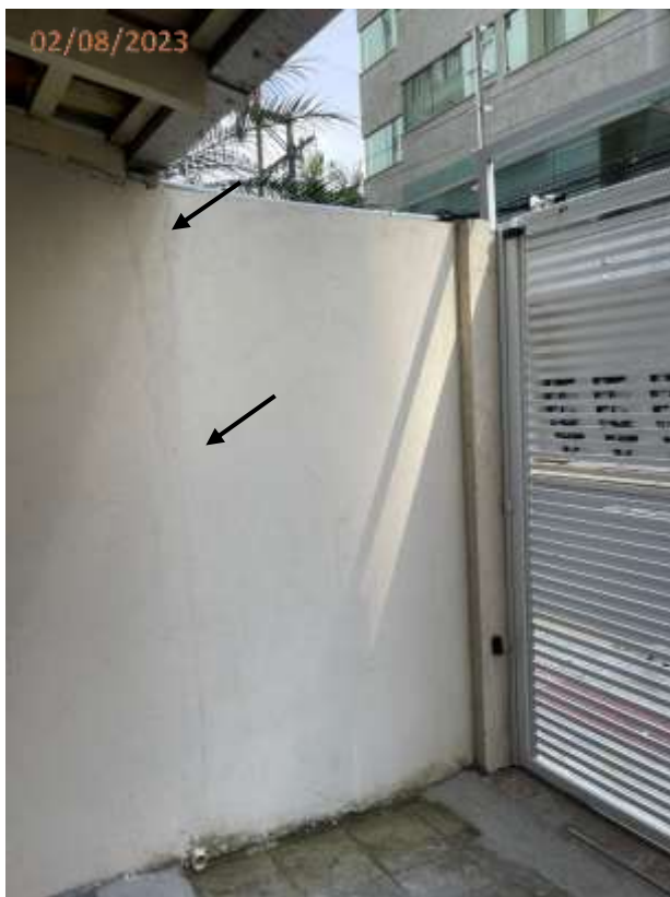
Foto 44: Trinca na parede do muro da garagem lateral esquerda da edificação.
