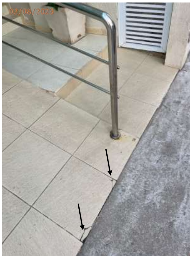
Fotos 51 e 52: Cerâmicas do piso quebradas na entrada do hall.
