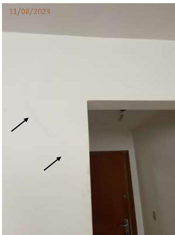
Fotos 05, 06 e 07: Trinca nas paredes junto a janela e vão do hall.
