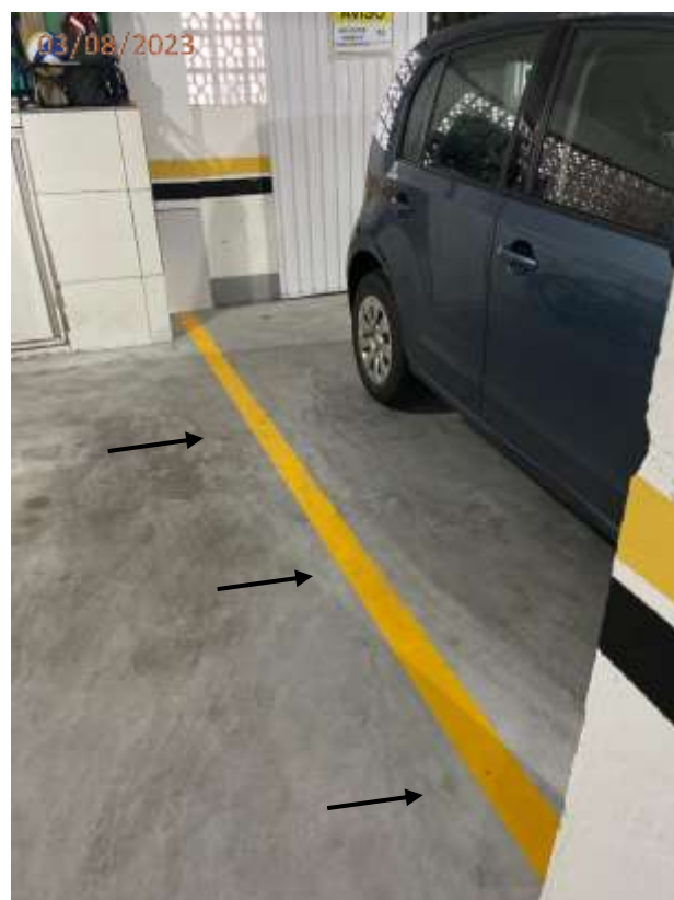
Foto 105: Trinca no piso da vaga V12.
