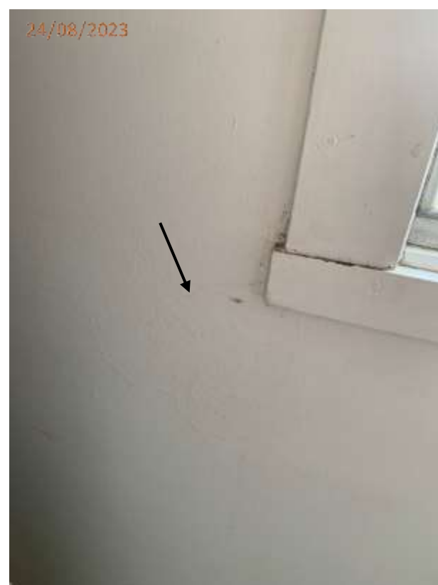
Fotos 07 e 08: Fissura na parede junto a porta e junto a janela do dormitório.
