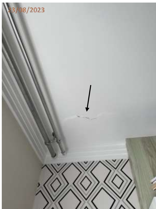
Fotos 07, 08 e 09: Trinca no teto na parede junto a janela do dormitório.
