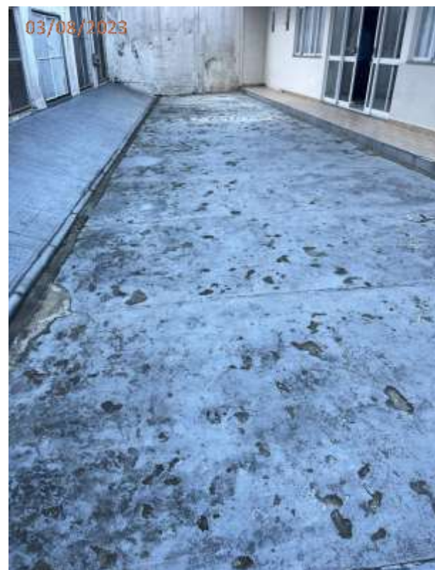
Foto 128: Trincas e rachaduras generalizadas no piso do pátio lateral direito da edificação.
