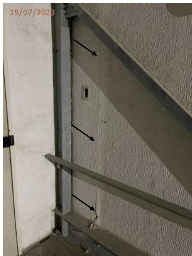
Fotos 122, 123, 124 e 125: Trincas e rachaduras na parede da passarela torres central/norte.
