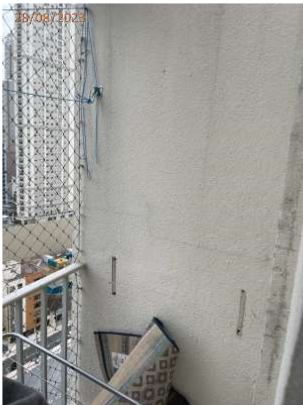
Foto 05: Trincas na parede da sacada.
