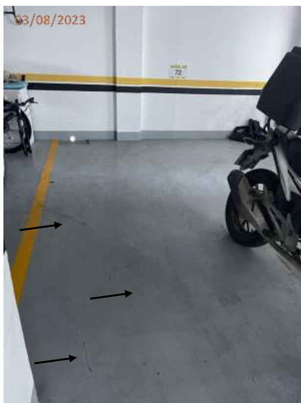
Foto 79: Trincas no piso junto a vaga V72.
