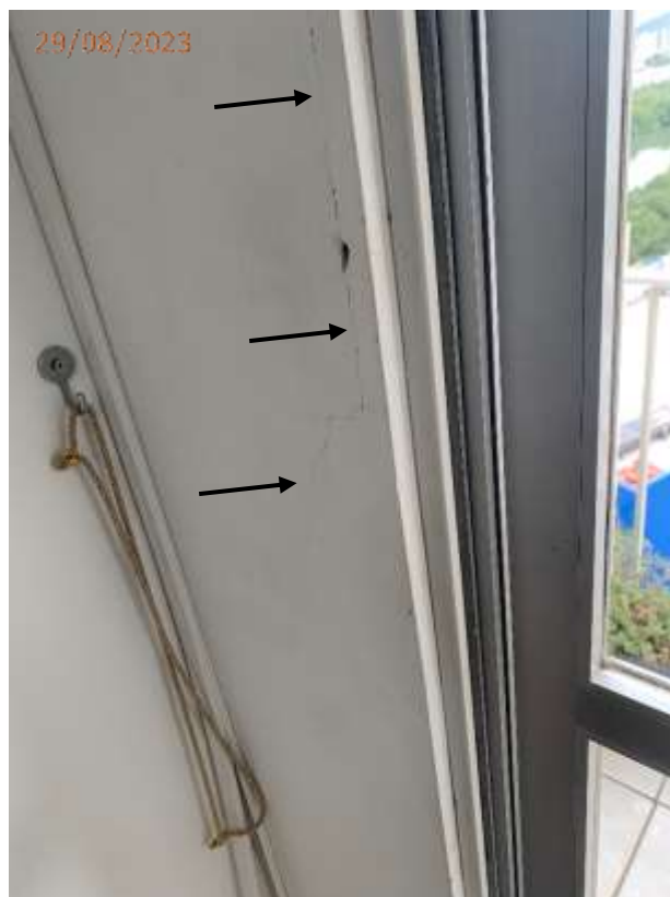
Fotos 03 e 04: Trinca nas paredes junto a porta de acesso a cozinha e porta de acesso a sacada.
