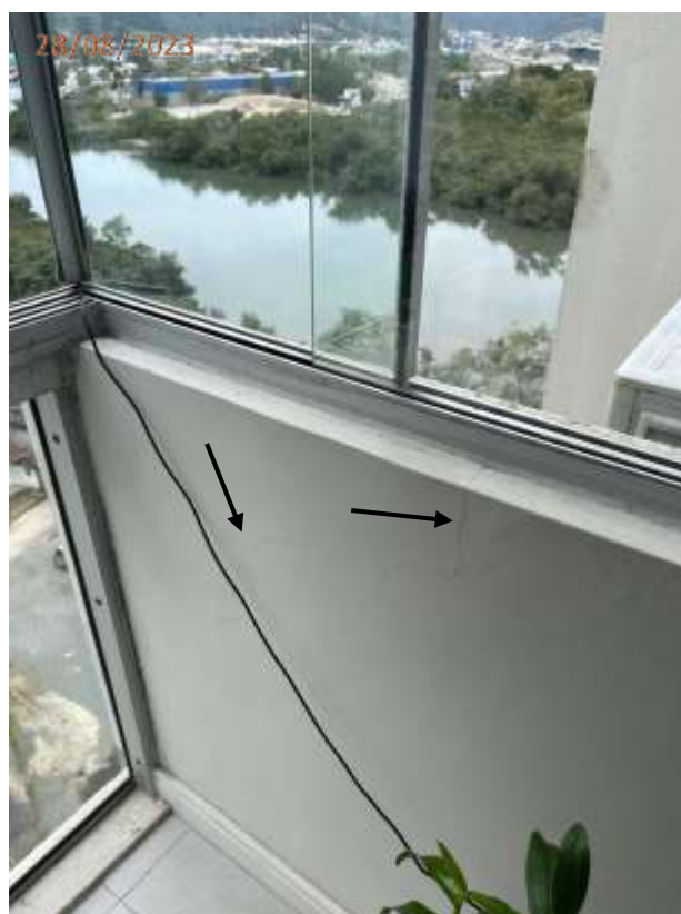
Fotos 05 e 06: Trinca na parede junto ao ar condicionado e junto a janela da sala.
