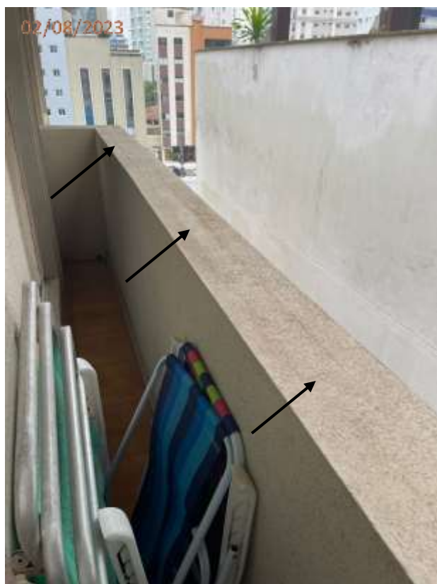
Fotos 20 e 21: Trinca no peitoril da sacada da sala de estar.
