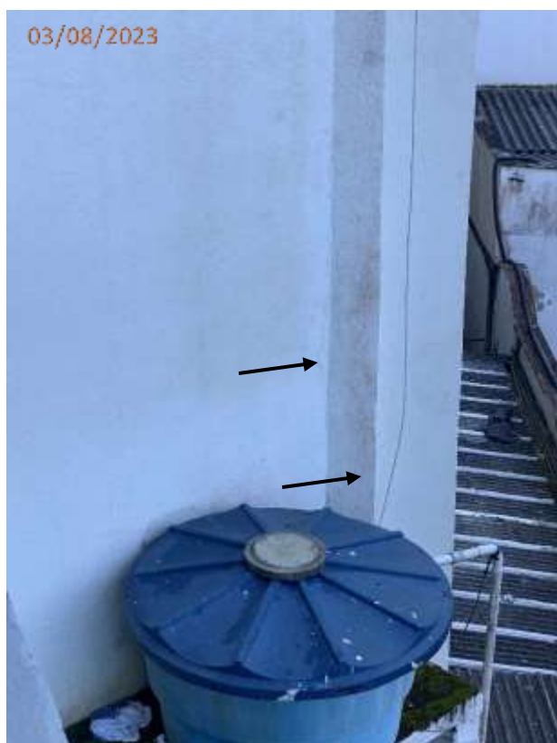
Foto 147: Trincas na fachada da garagem junto ao terreno.
