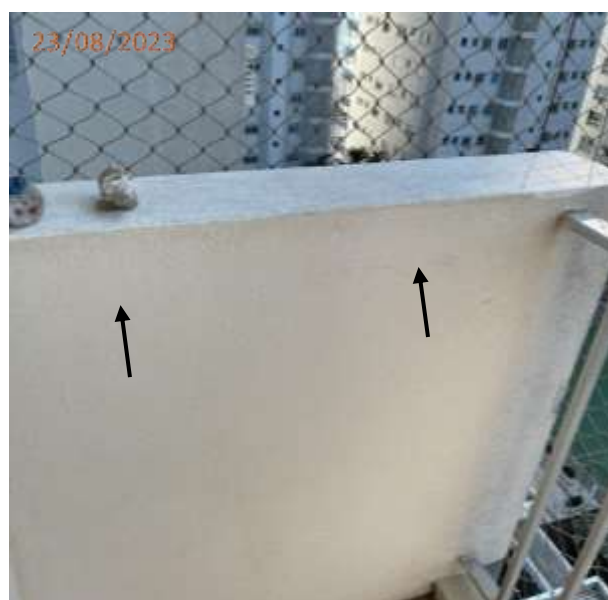
Foto 04: Trinca no peitoril da sacada.
