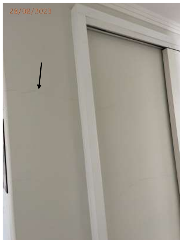
Fotos 16 e 17: Trincas na parede junto aos quadros na ante sala e junto a porta de acesso ao banheiro.
