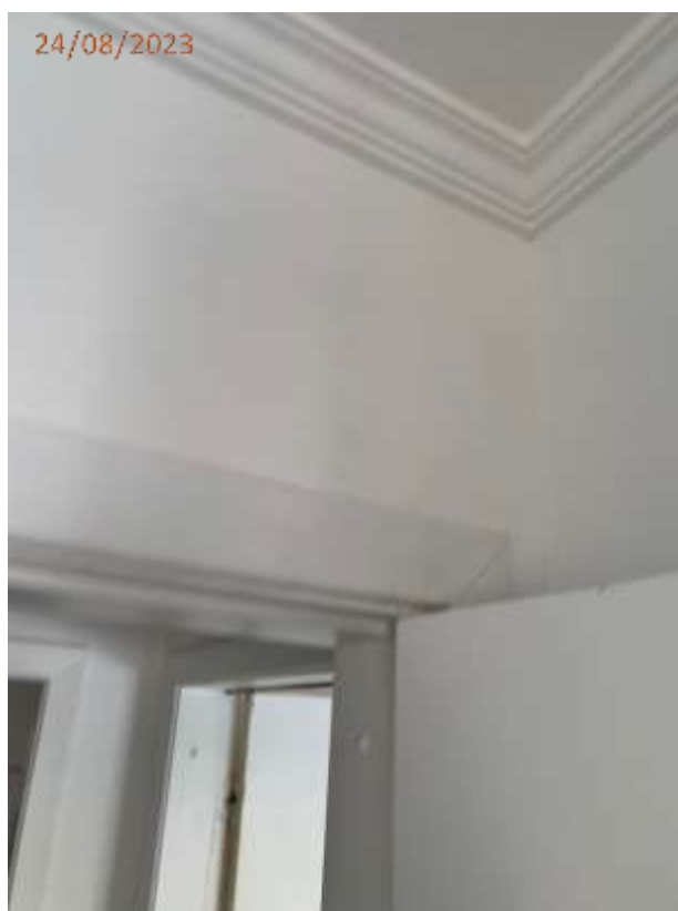
Fotos 07 e 08: Fissura na parede junto a porta e junto a janela do dormitório.
