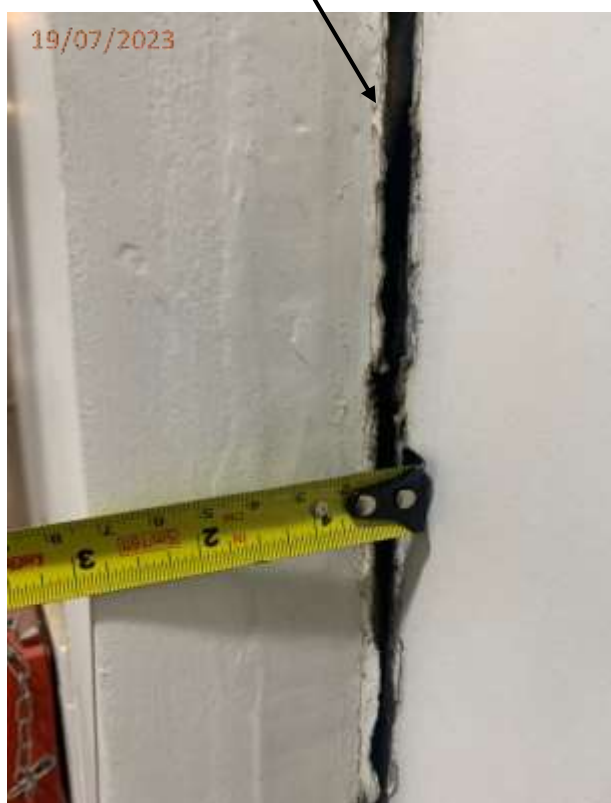
Fotos 105 e 106: Rachadura na parede de acesso a passarela torres sul/central.
