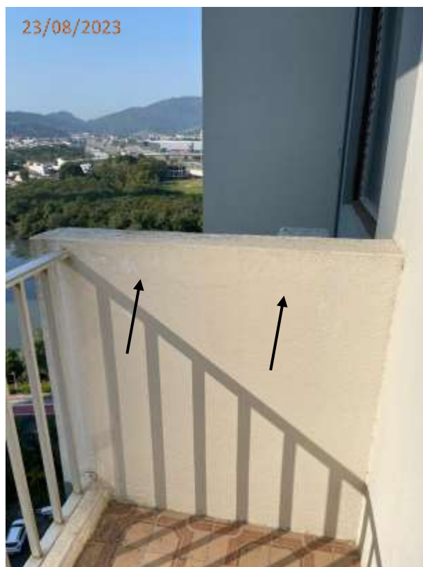
Foto 04: Trinca na peitoril da sacada.
