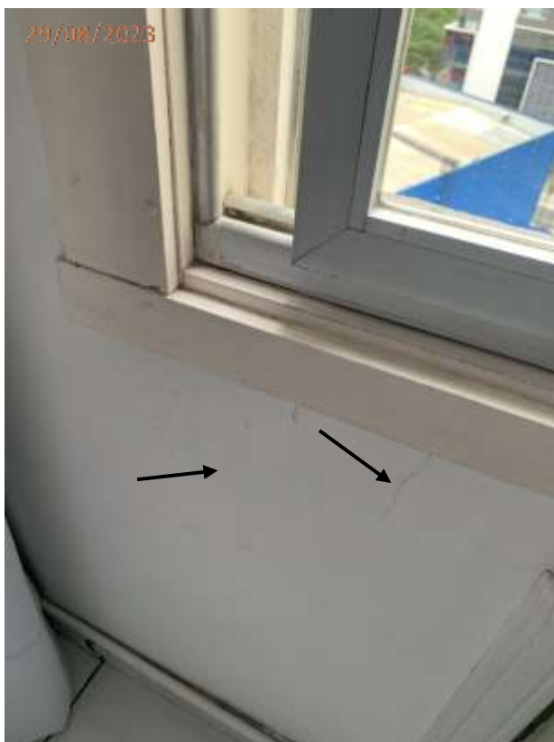
Fotos 17 e 18: Trincas na parede junto a janela do dormitório.
