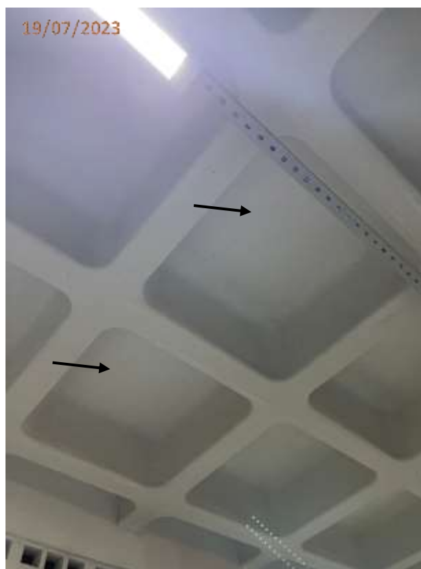
Fotos 50 e 51: Trinca no teto da circulação de veículos em frente a vaga V244.
