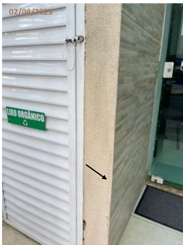
Foto 53: Fissura na parede junto a porta da lixeira.
