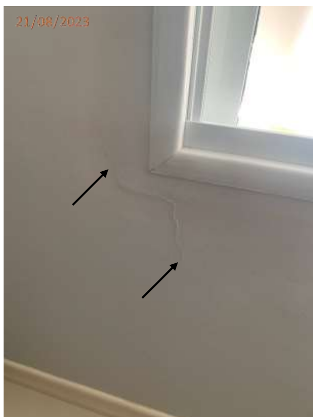
Fotos 19 e 20: Trincas na parede junto e janela e cama do dormitório.
