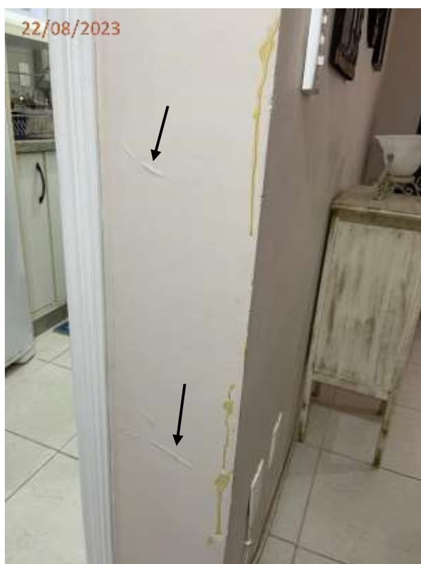
Fotos 03 e 04: Trinca na parede junto a porta de entrada e trinca na parede junto porta da cozinha.
