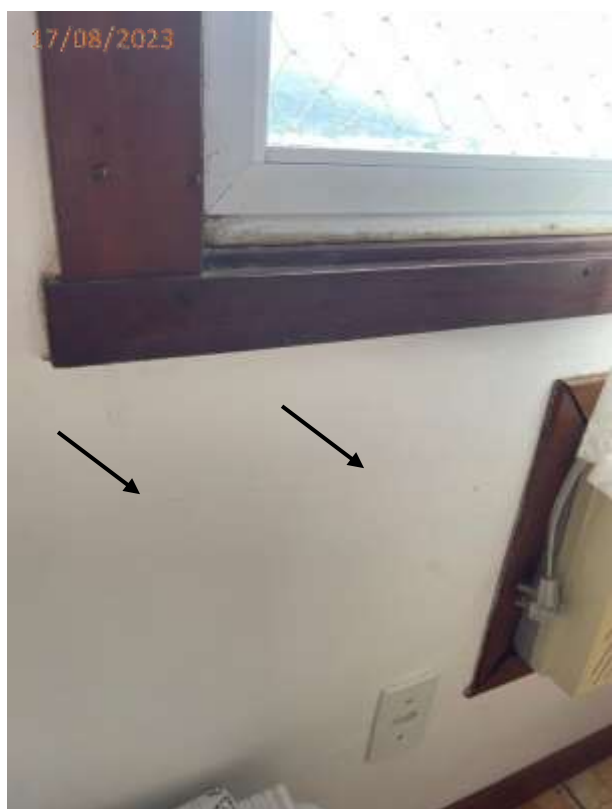
Fotos 09, 10 e 11: Trincas na parede junto a janela do dormitório.
