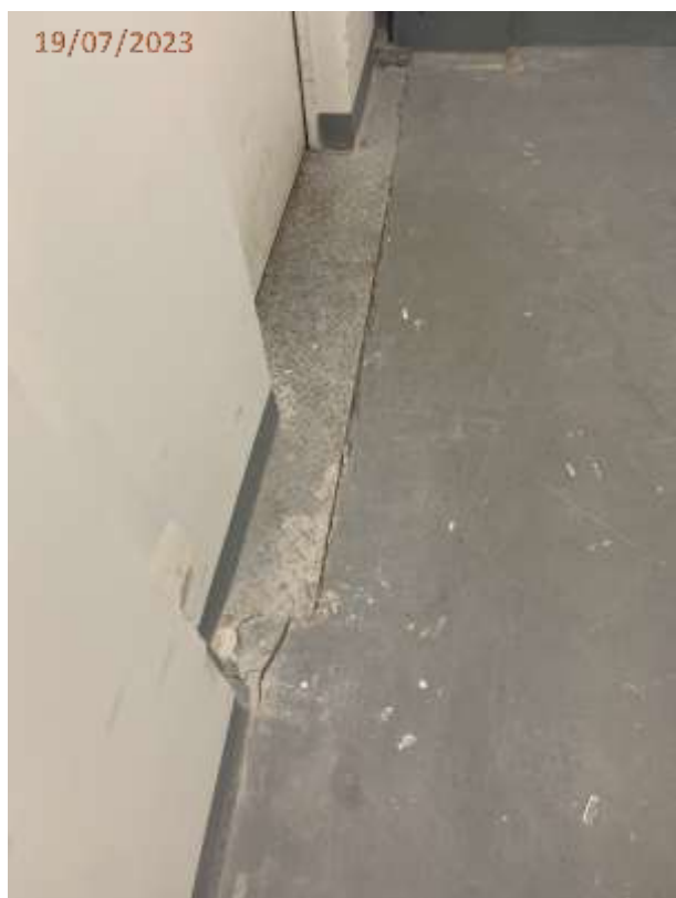
Fotos 98, 99 e 100: Afastamento do piso metálico junto a passarela na torre sul.
