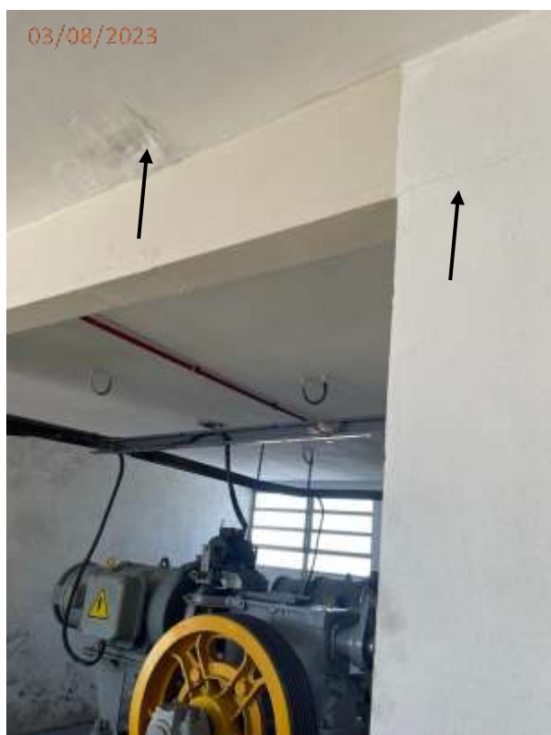
Foto 05: Trinca na parede da casa de máquina dos elevadores.
