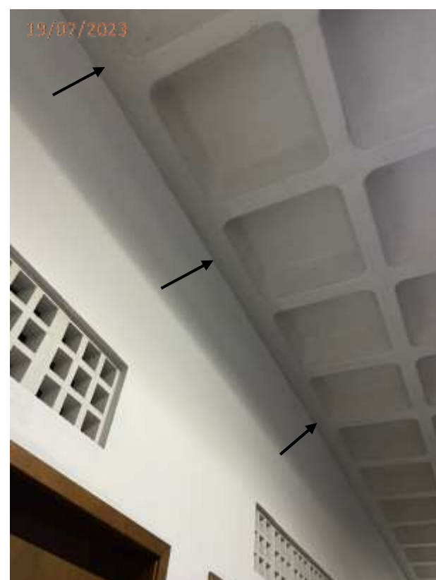
Fotos 71: Trinca no teto junto as vagas V10, V11 e V12.
