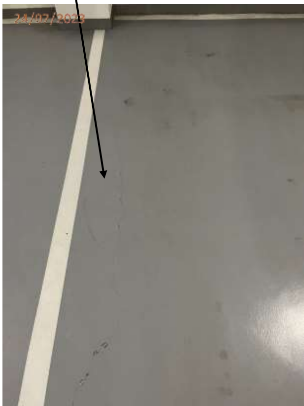
Foto 64: Trinca no piso junto a vaga V11.
