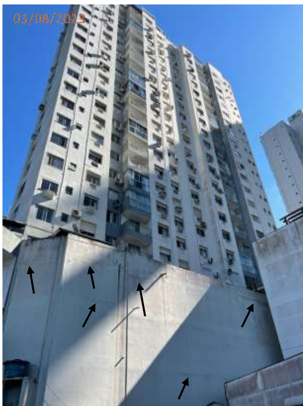
Foto 141: Trincas na fachada da garagem junto ao terreno.
