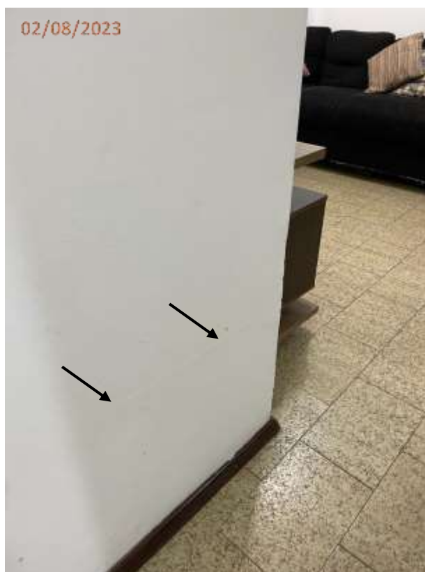
Fotos 05, 06, 07 e 08: Fissura nas paredes da circulação íntima.
