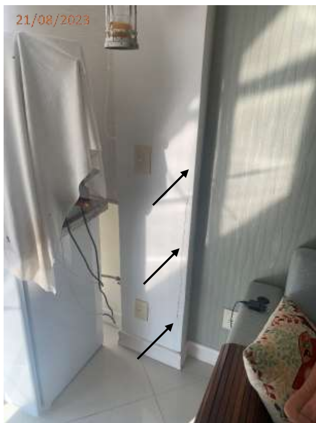
Fotos 03 e 04: Trinca no pilar e fissura na parede junto a janela da sala.
