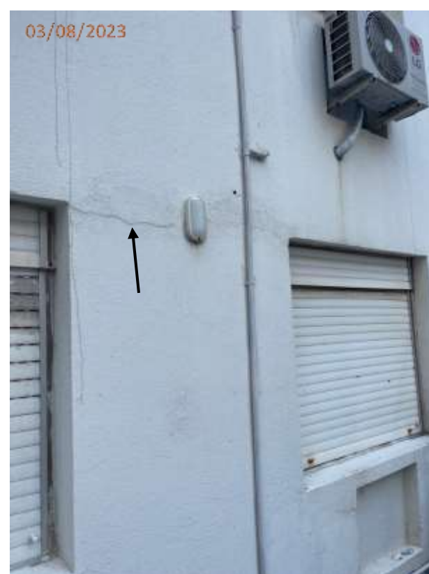
Fotos 28, 29, 30 e 31: Trincas na parede da fachada junto ao terraço.
