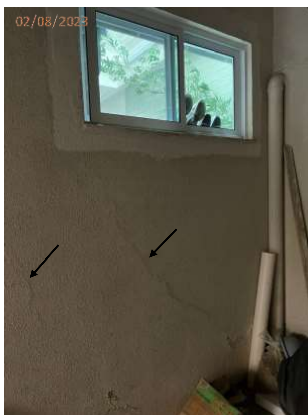
Fotos 40 e 41: Trincas nas paredes da garagem lateral direita da edificação.
