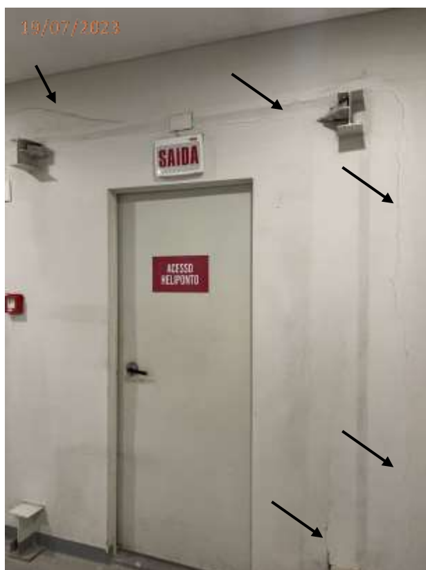
Foto 131: Trincas e rachaduras na parede junto a porta de acesso a passarela torre sul/central.
