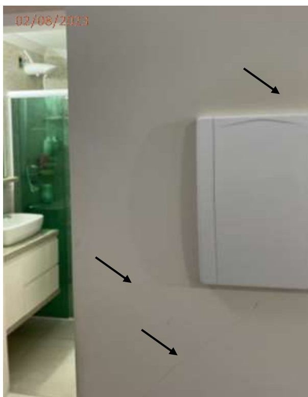
Foto 04: Trincas na parede da sala junto ao quadro elétrico.
