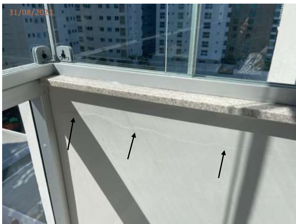
Fotos 03 e 04: Trinca nas paredes junto a janela da sala de estar.
