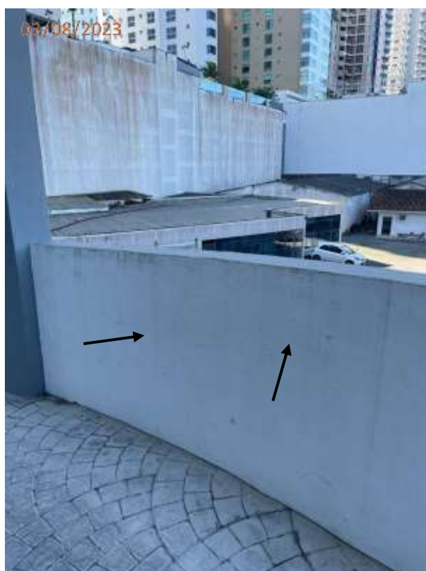
Fotos 74, 75, 76 e 77: Trincas e fissuras na parede da rampa da garagem.
