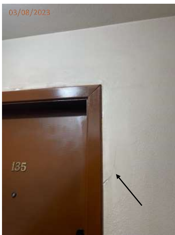
Foto 34: Fissura na parede junto a porta do Apto 135 no hall do 13º andar.
