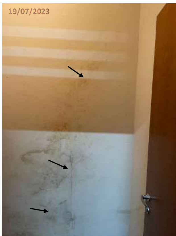
Fotos 28, 29 e 30: Trincas nas paredes do box da vaga V471.
