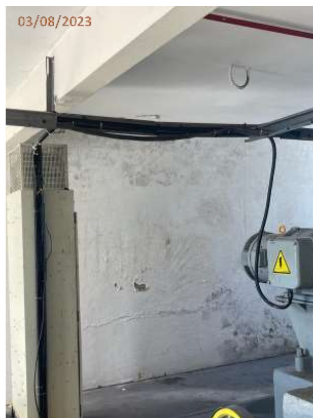
Fotos 02, 03 e 04: Trincas, sinais de umidade e desgaste em geral do revestimento na casa de máquinas dos elevadores.
