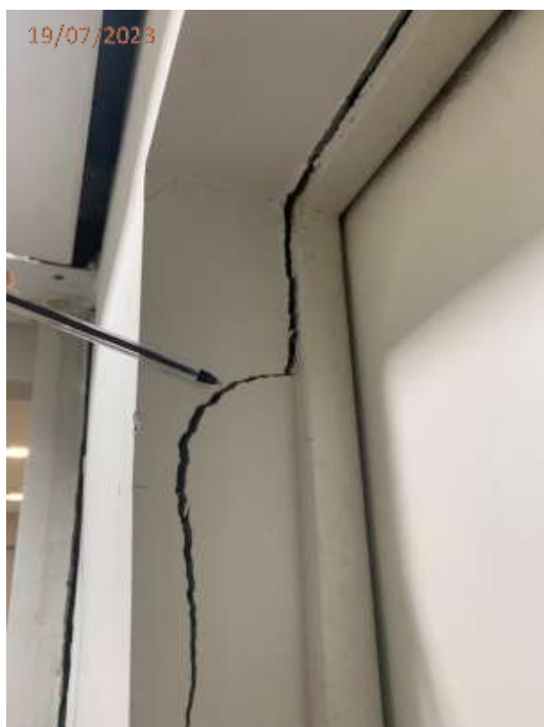
Fotos 101, 102, 103 e 104: Trincas e rachaduras na parede de acesso a passarela torres sul/central.
