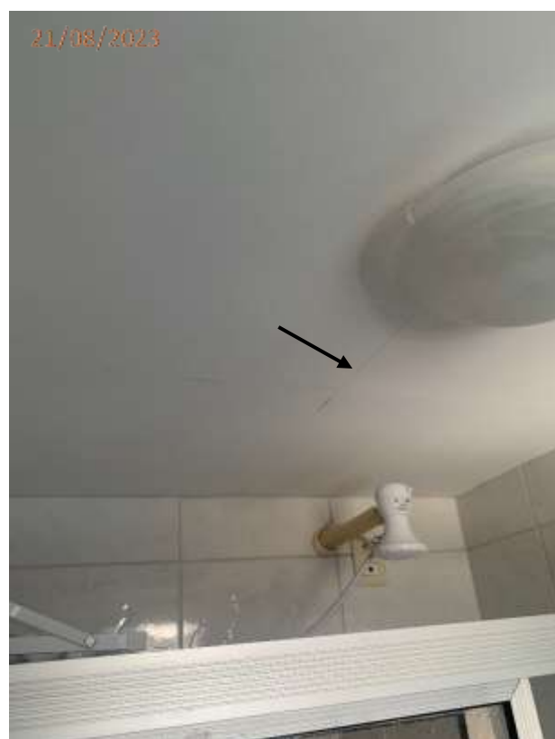
Fotos 09 e 10: Trinca no teto do banheiro da dependência de empregada.
