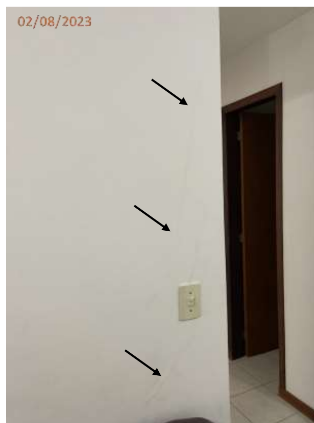
Fotos 05 e 06: Trinca nas paredes da sala junto ao armário e interruptor.
