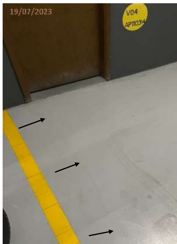
Fotos 65 e 66: Trincas no piso junto da circulação de veículos em frente a vaga V04 e vaga V04.
