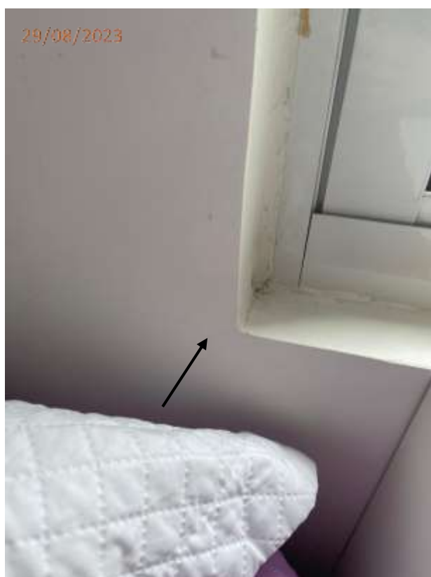
Fotos 11 e 12: Trinca junto a janela do dormitório.
