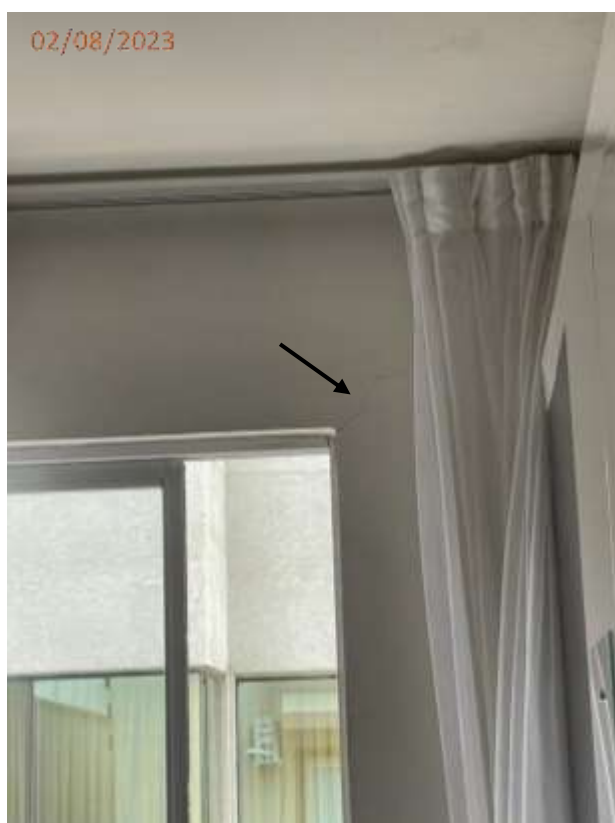
Fotos 23 e 24: Trinca na parede do dormitório junto a porta de acesso a sacada.
