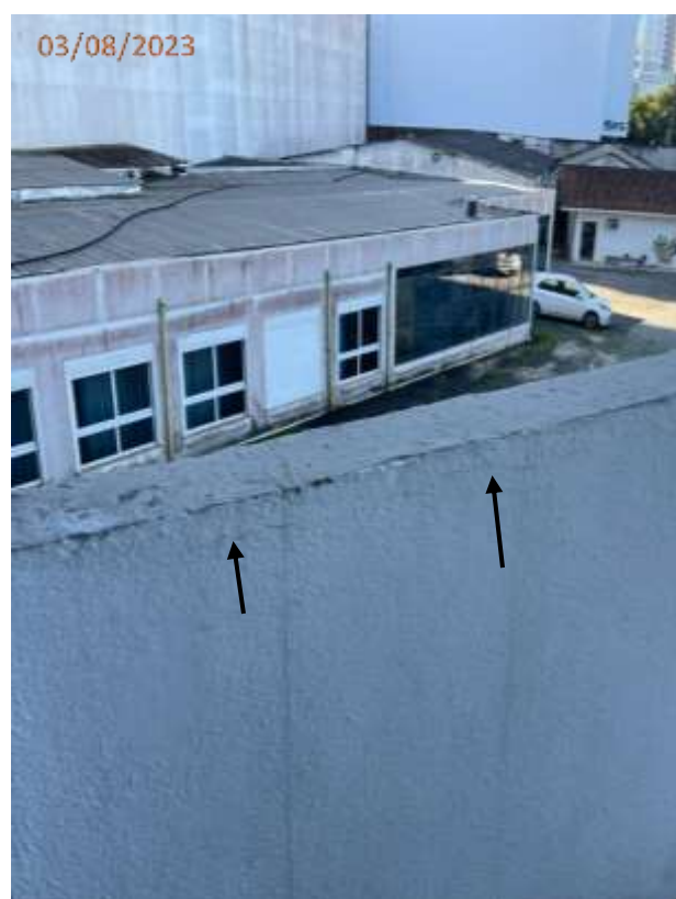
Fotos 74, 75, 76 e 77: Trincas e fissuras na parede da rampa da garagem.
