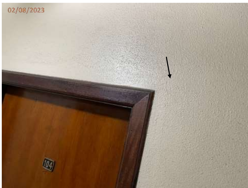
Foto 16: Fissura na parede do hall junto a porta do Apto 104.
