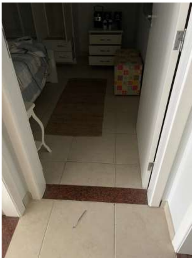
Foto 07: Piso da circulação com som cava (choco) ao toque.
