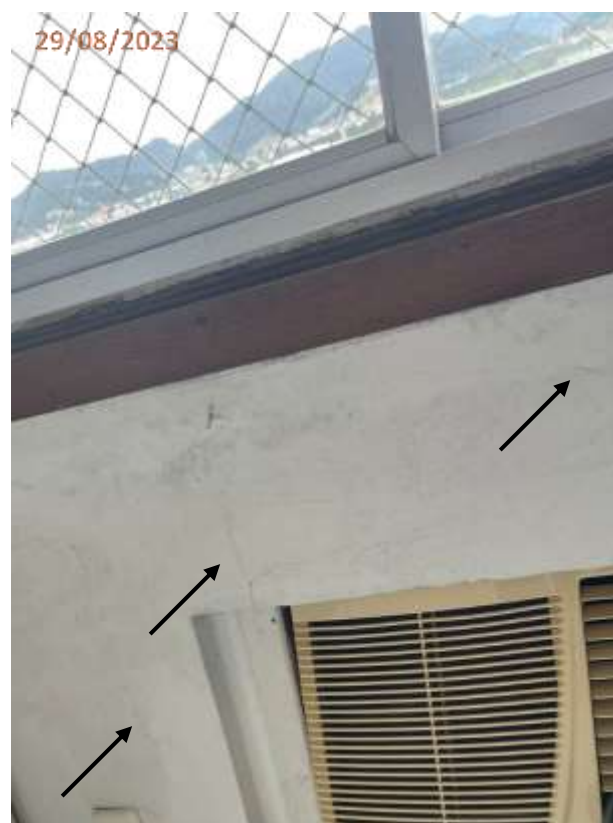
Fotos 04, 05, 06 e 07: Trinca nas paredes da junto ao vão de acesso a circulação intoma e junto a janela da sala.
