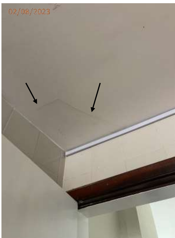
Fotos 03, 04, 05 e 06: Descolamento de azulejo e trincas no teto da cozinha/a.s.
