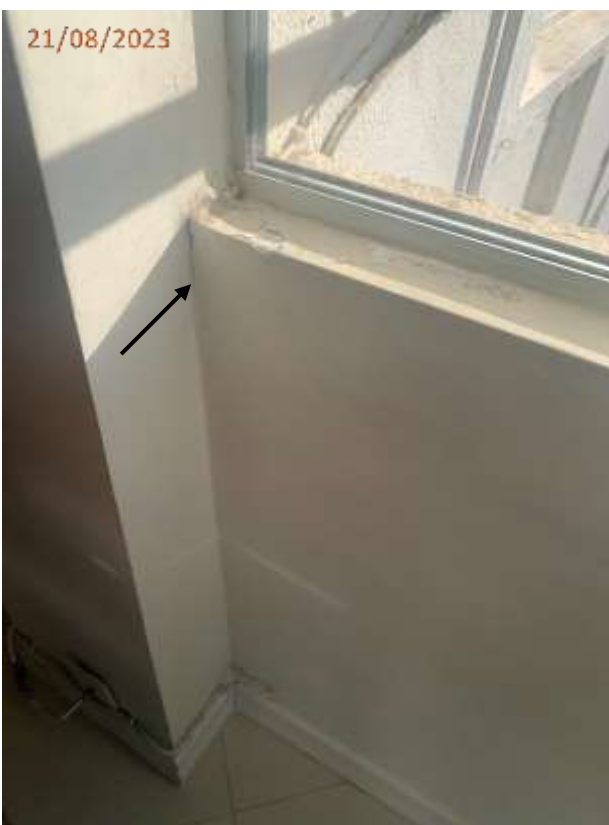
Fotos 03 e 04: Trinca no pilar e fissura na parede junto a janela da sala.
