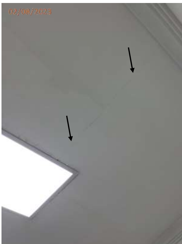
Fotos 47 e 48: Trincas no teto da sala comercial.
