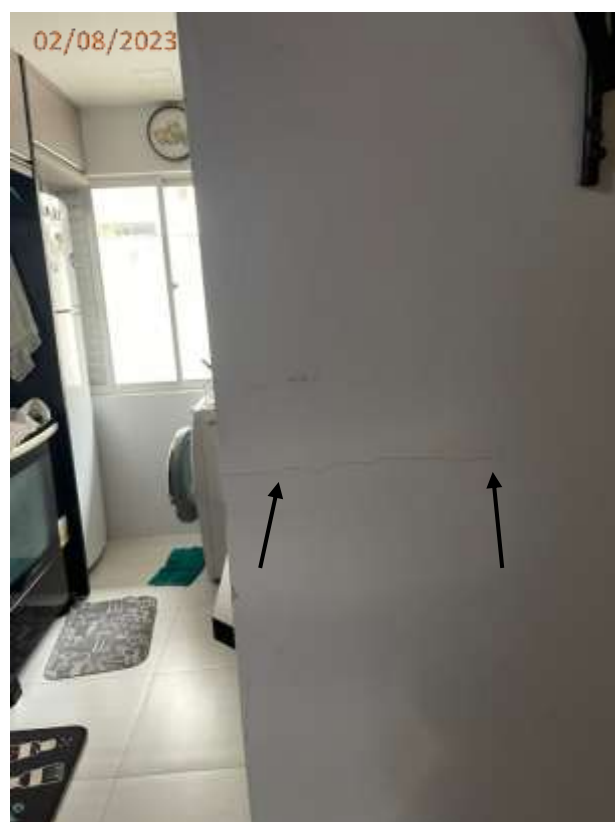
Fotos 04 e 05: Trinca na parede junto ao acesso a área de serviço.
