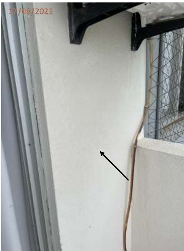
Fotos 03 e 04: Trinca na parede junto a janela da sala e junto ao guarda corpo da sacada.
