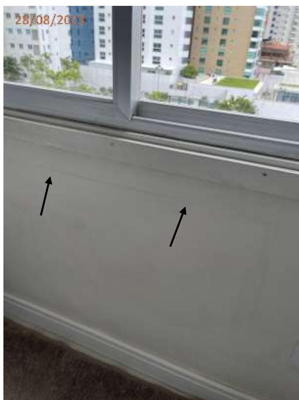
Fotos 20 e 21: Trinca na parede junto a janela do dormitório.
