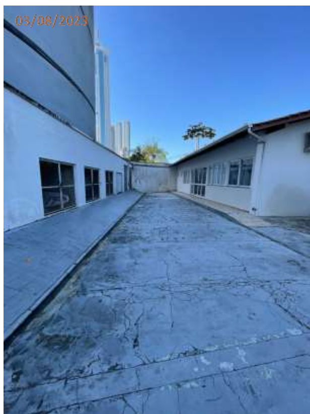
Foto 115: Trincas e rachaduras generalizadas no piso do pátio lateral direito da edificação.
