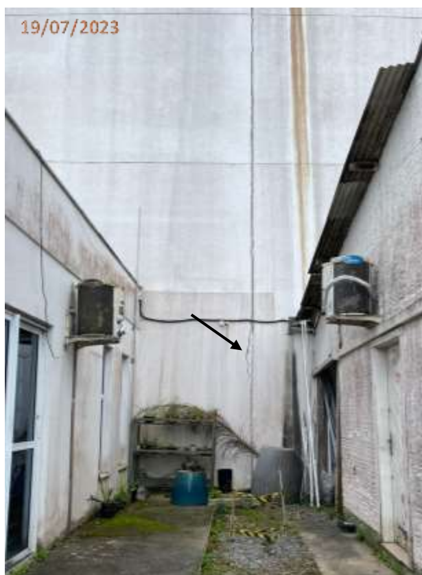
Foto 96: Rachadura junto a junta de dilatação na fachada do fundo divisa com terreno.
