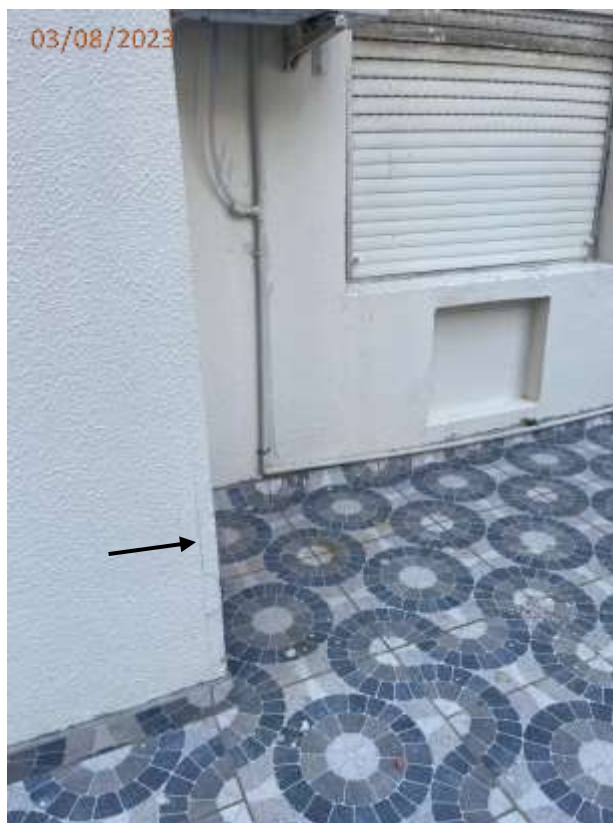
Fotos 28, 29, 30 e 31: Trincas na parede da fachada junto ao terraço.
