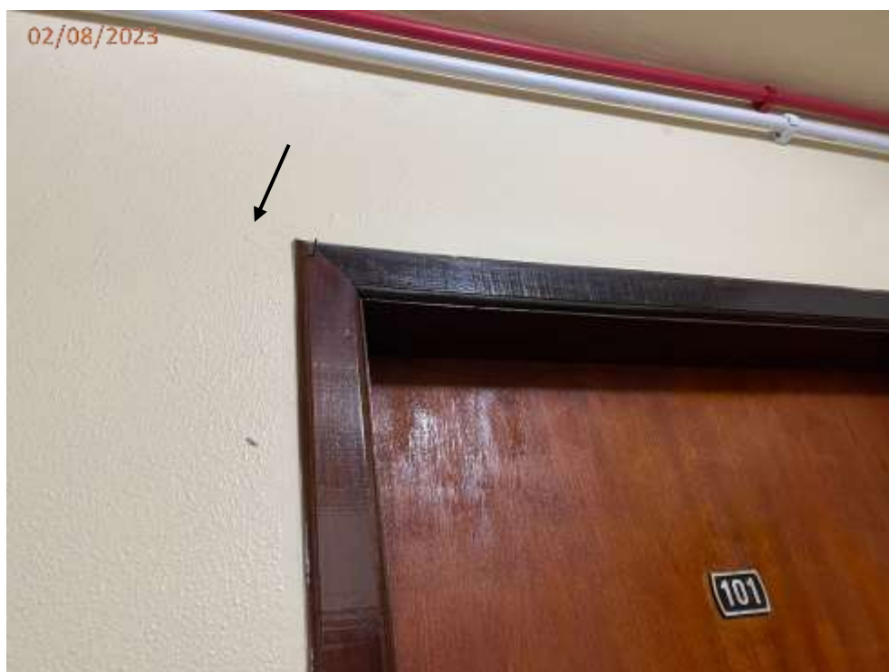
Foto 18: Fissura na parede do hall junto a porta do Apto 101.
