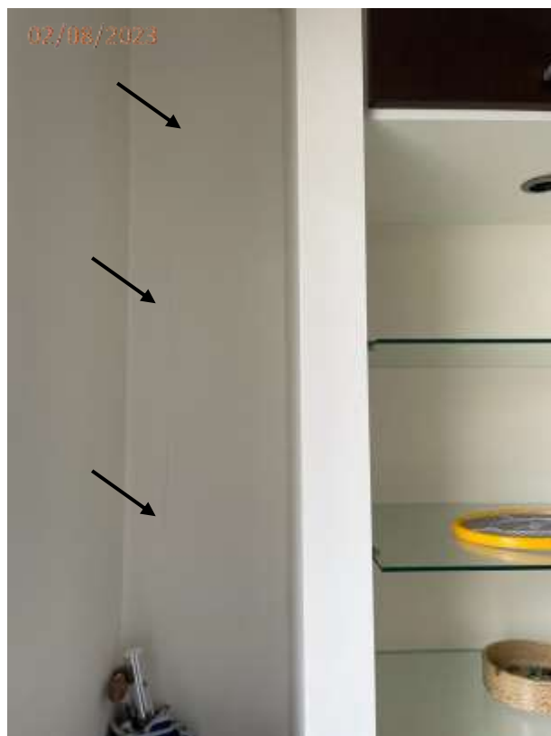
Fotos 05 e 06: Fissura na parede junto a porta da sacada e junto a estante na sala de estar.
