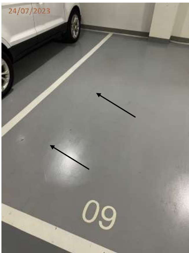
Foto 65: Trinca no piso junto a vaga V09.
