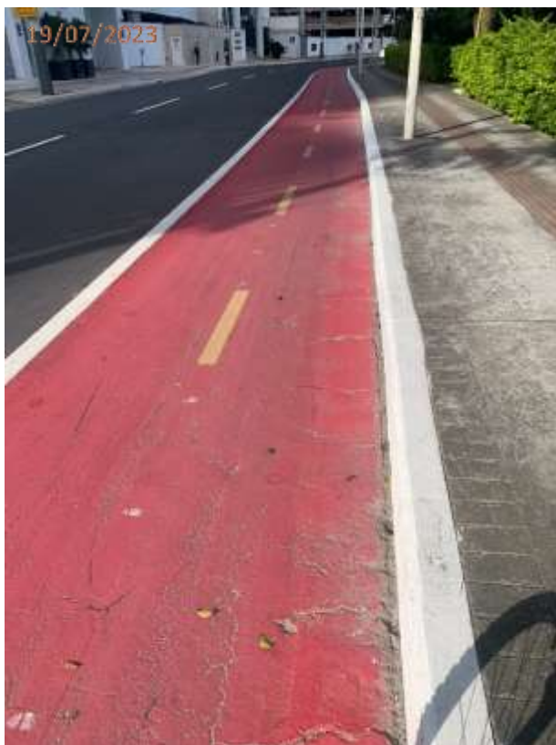
Fotos 08, 09, 10 e 11: Ciclo faixa da Av. Normando Tedesco apresentando rachaduras no piso.
