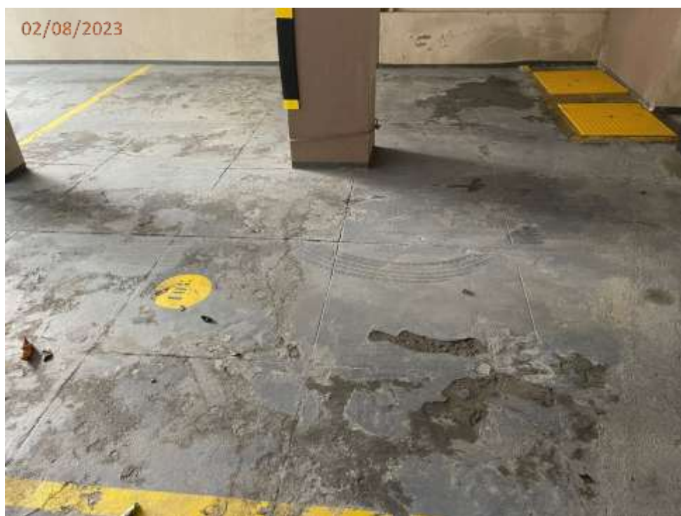
Foto 42: Trincas e rachaduras generalizadas no piso da garagem lateral esquerda da edificação.
