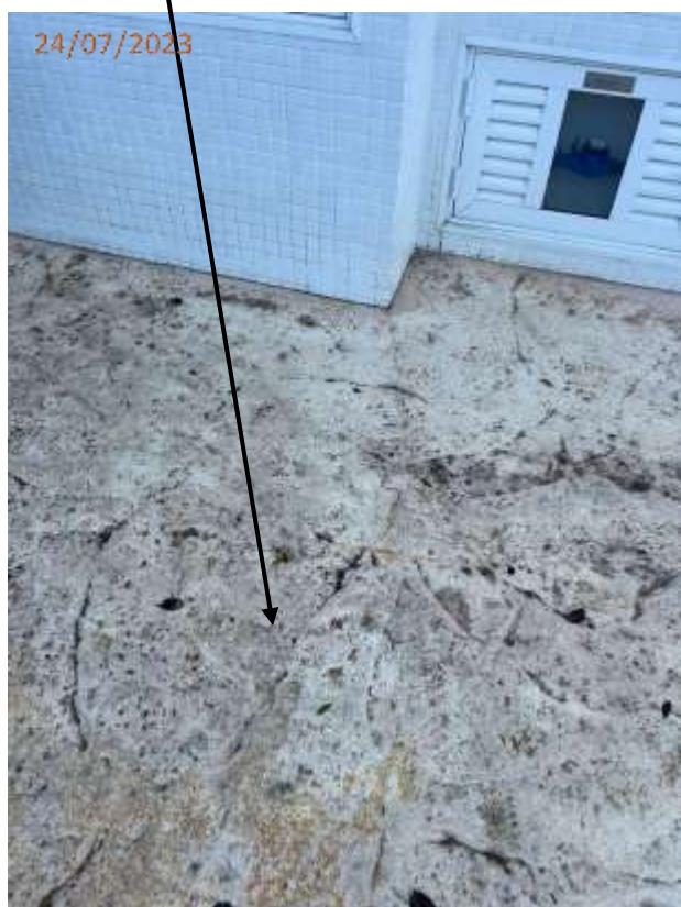
Foto 75: Piso trincado junto a calçada.
