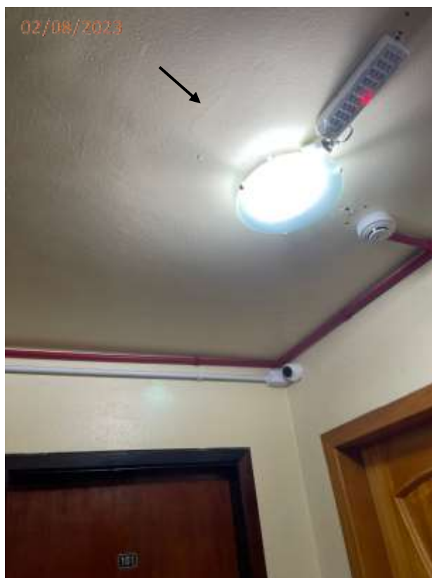
Foto 17: Fissura no teto do hall do 1º andar junto a luminária.
