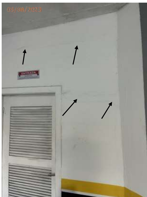
Foto 102: Trinca na parede junto ao depósito ao lado da rampa.
