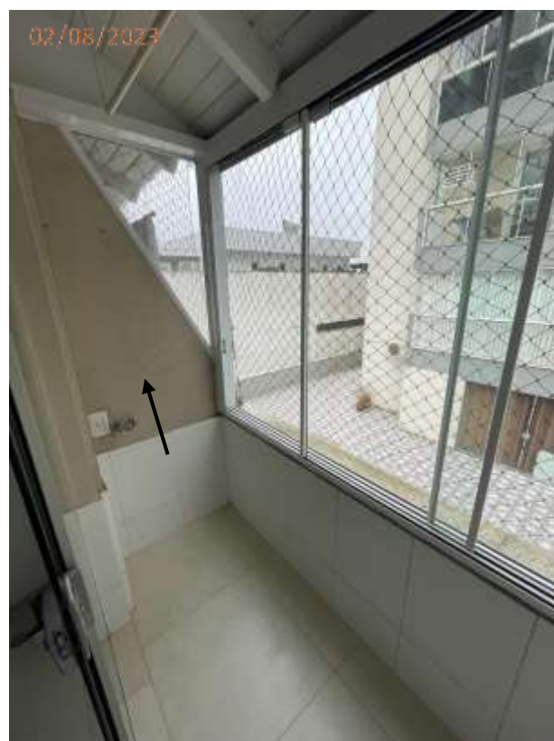
Foto 06: Trinca na parede da sacada.
