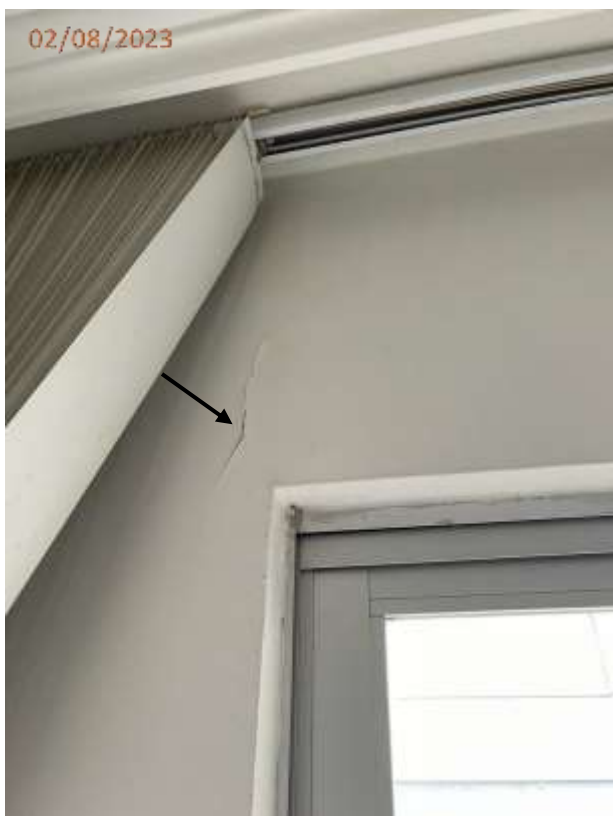
Fotos 05 e 06: Fissura na parede junto a porta da sacada e junto a estante na sala de estar.
