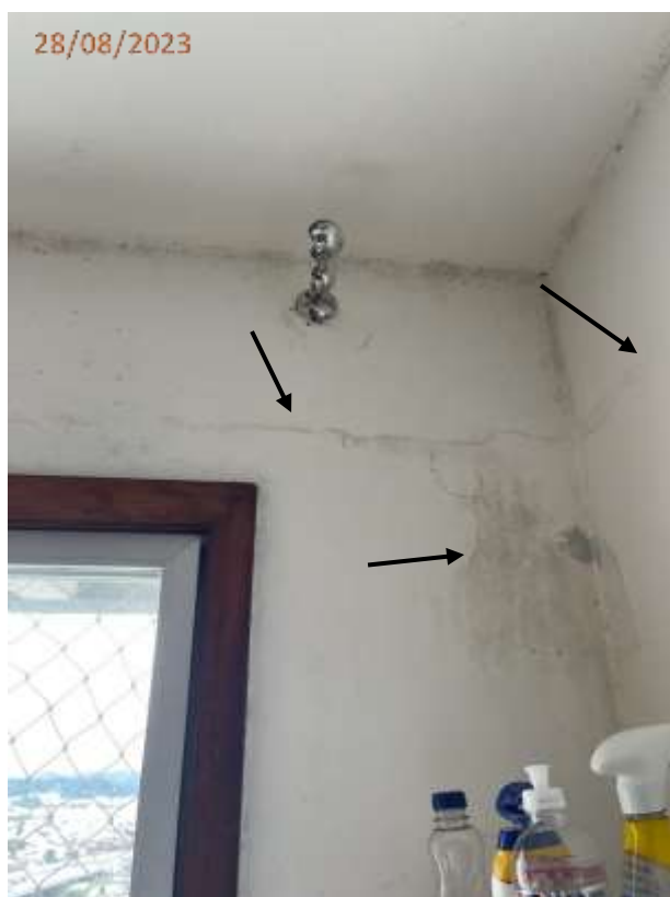
Fotos 08 e 09: Trinca na parede junto a janela da área de serviço.
