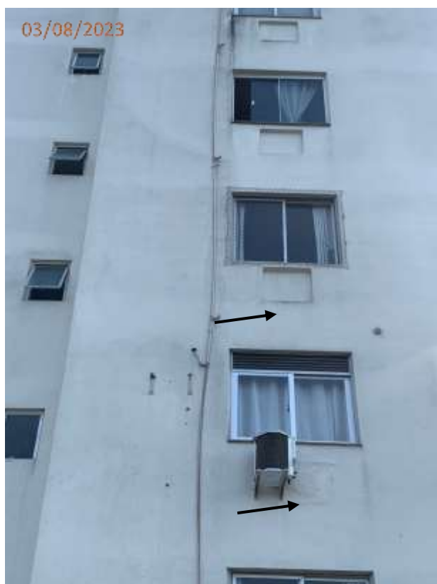
Fotos 150, 151 e 152: Trincas na fachada lateral direita (lateral junto a Av. Normando Tedesco).
