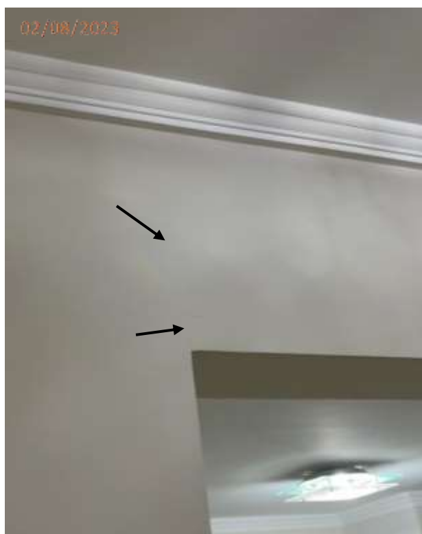
Foto 03: Fissura na parede da sala junto ao vão de acesso a cozinha.
