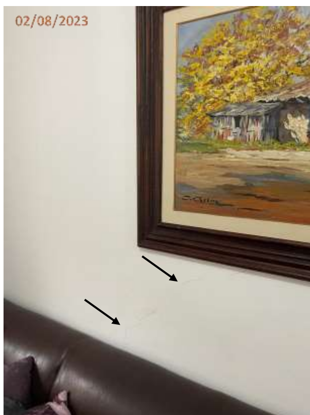
Foto 08: Trinca na parede da sala junto ao sofá/quadro.
