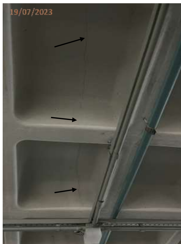
Fotos 43 e 44: Trinca no teto da circulação de veículos em frente a vaga V342.
