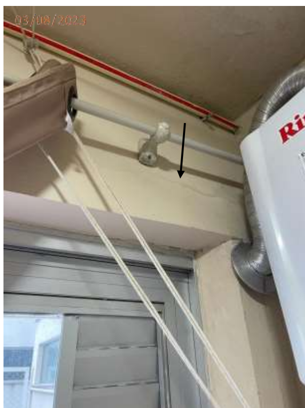
Fotos 09, 10 e 11: Trinca nas paredes da área de serviço.
