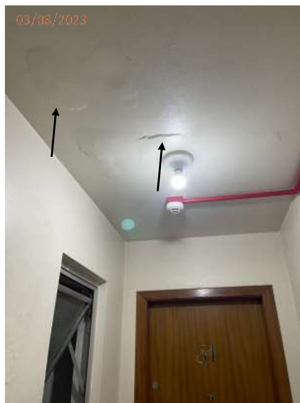
Foto 45: Descolamento de revestimento no teto ao lado da porta do Apto 81 no hall do 8º andar.
