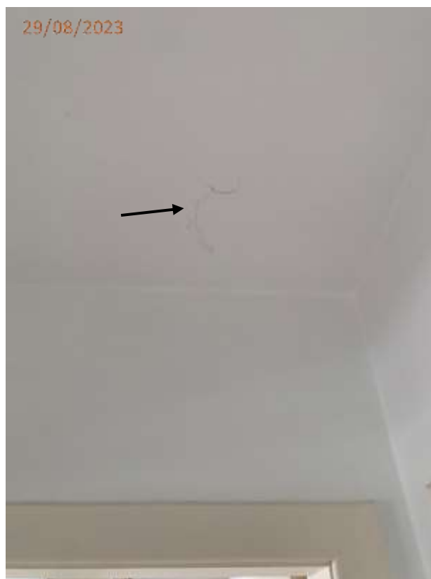
Fotos 06 e 07: Trinca no teto junto a porta de acesso ao dormitório.
