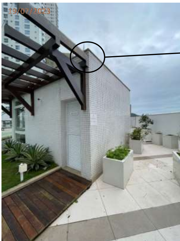
Fotos 12 e 13: Descolamento de cerâmica parede do vestiário feminino.
