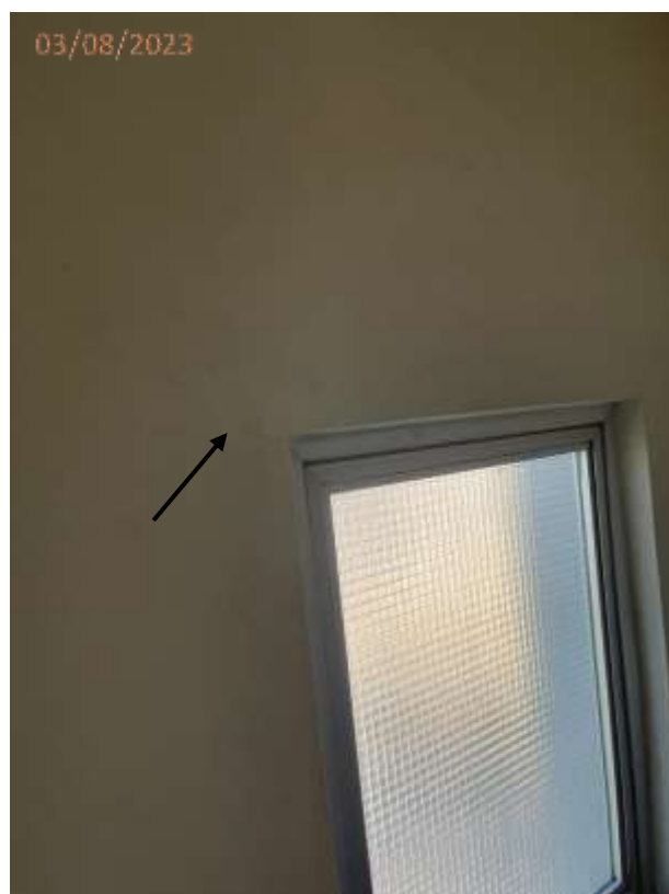
Foto 20: Trinca na parede junto a janela da escada do 19º andar.
