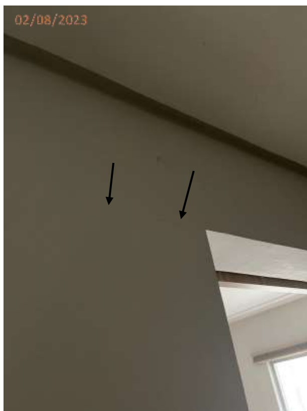
Foto 07: Fissura na parede da circulação de acesso aos dormitórios.
