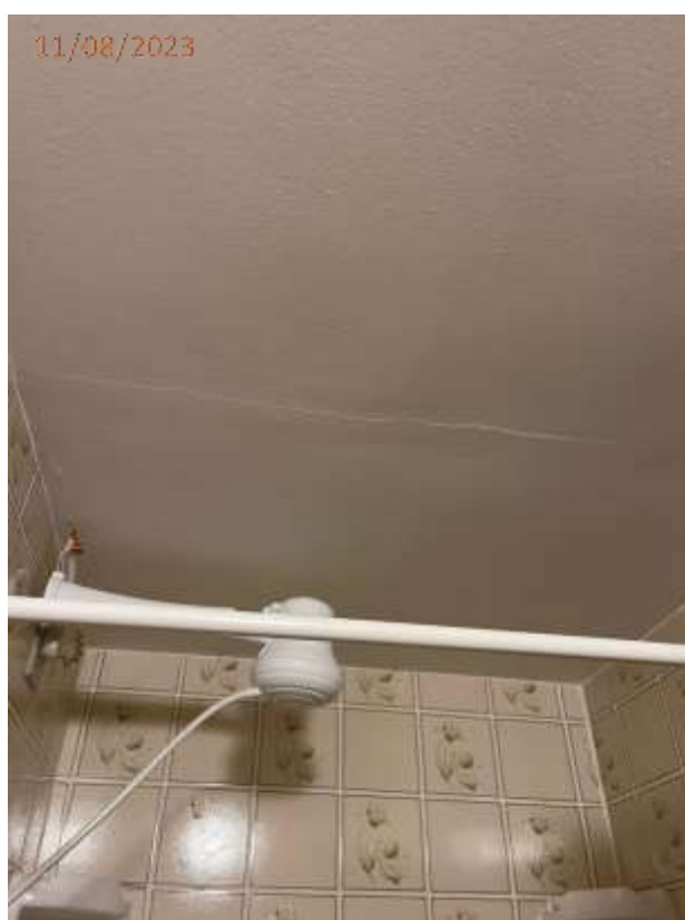
Fotos 08 e 09: Trinca no teto do banheiro.
