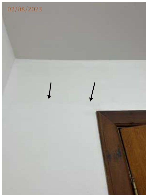
Fotos 03 e 04: Fissura nas paredes da sala junto ao espelho e porta de entrada do Apto.
