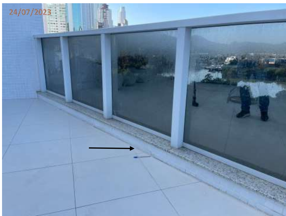
Foto 22: Trinca no rodapé cerâmico junto ao guarda corpo.
