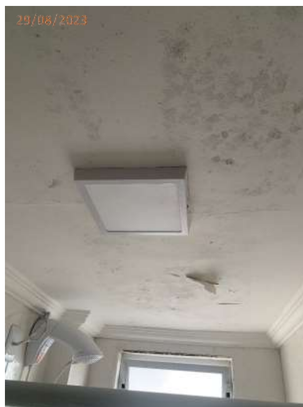
Fotos 07, 08, 09 e 10: Descolamento da moldura de gesso, descolamento de cerâmica junto a janela e umidade generalizada no teto do banheiro .
