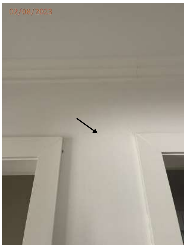
Fotos 08, 09,10 e 11: Fissura na parede junto as portas dos dormitórios, junto ao rodapé na circulação íntima.
