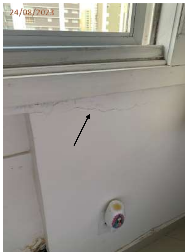
Fotos 09 e 10: Trinca na parede junto a porta e junto a janela da suíte.
