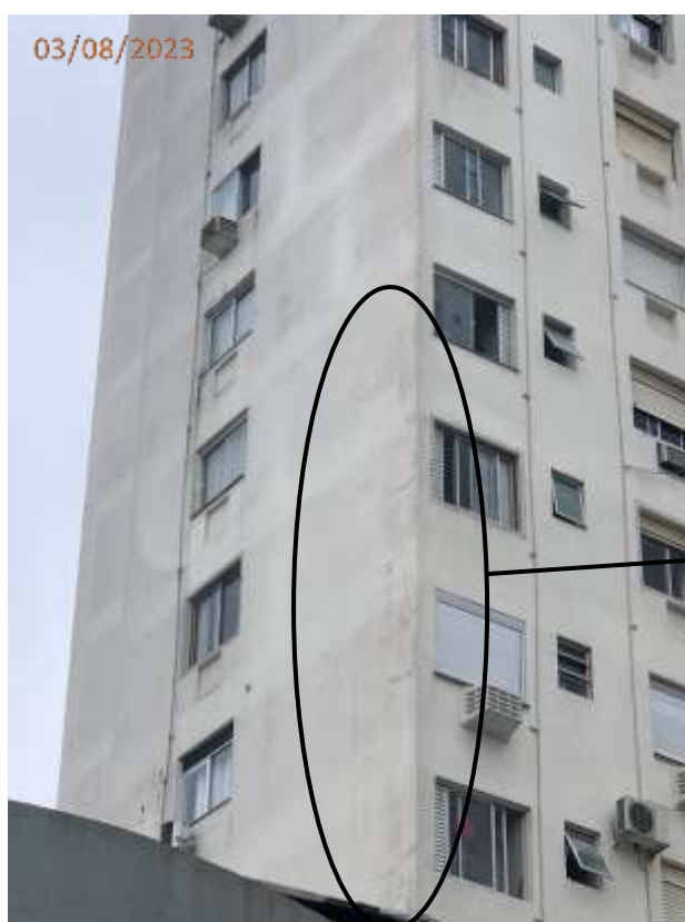
Fotos 148 e 149: Trincas e desgaste do revestimento na fachada da torre lado Av. Normando Tedesco.
