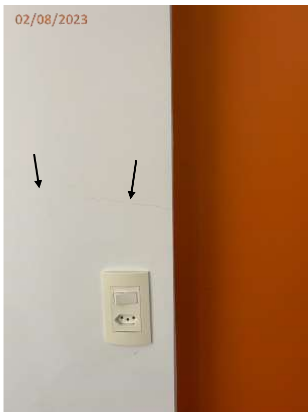
Fotos 03, 04, 05 e 06: Fissura na parede da sala junto a janela, trinca na viga, fissura junto ao interruptor e na parede junto a cozinha.
