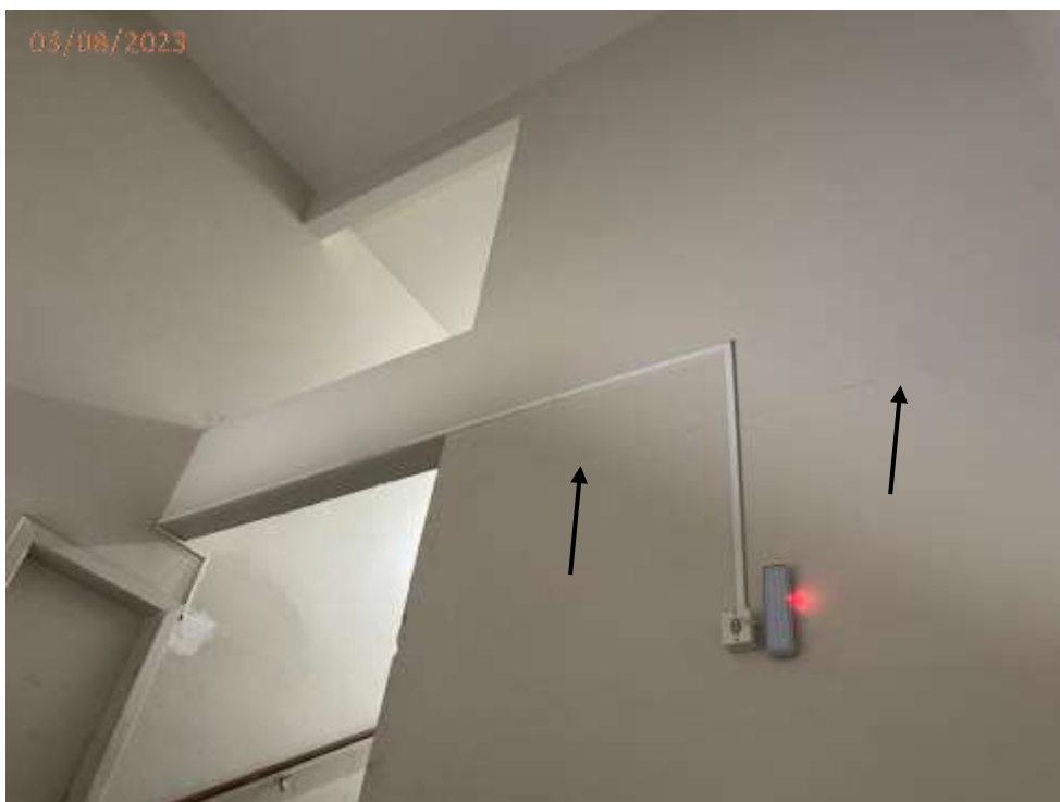
Foto 13: Trinca na parede na escada de acesso a cobertura.
