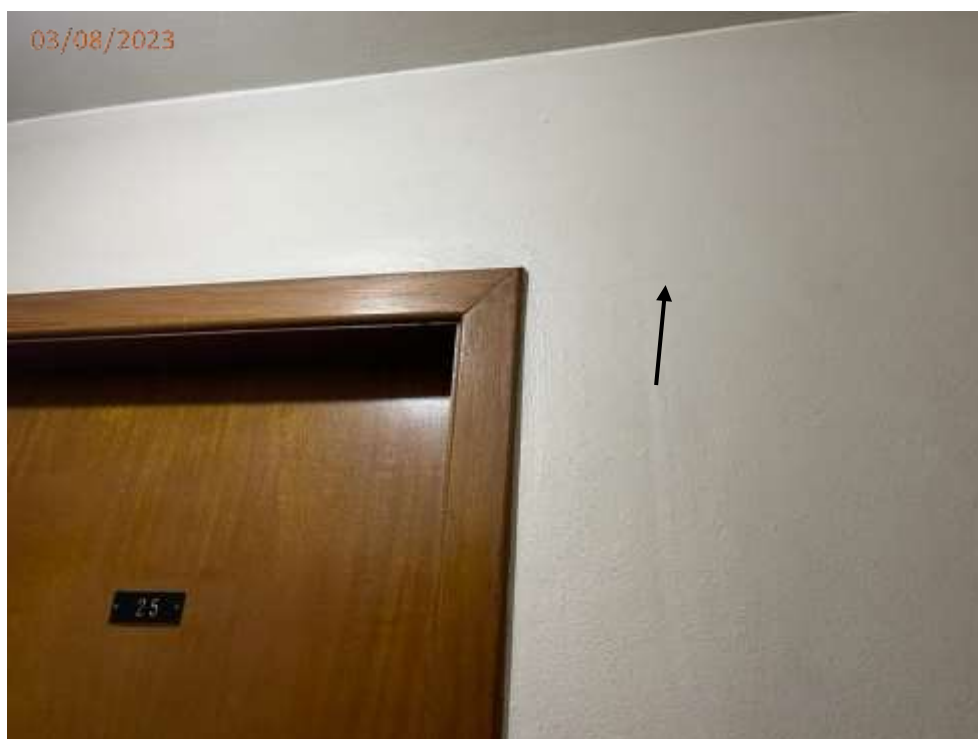
Foto 60: Fissura na parede ao lado da porta do Apto 25 no hall do 2º andar.
