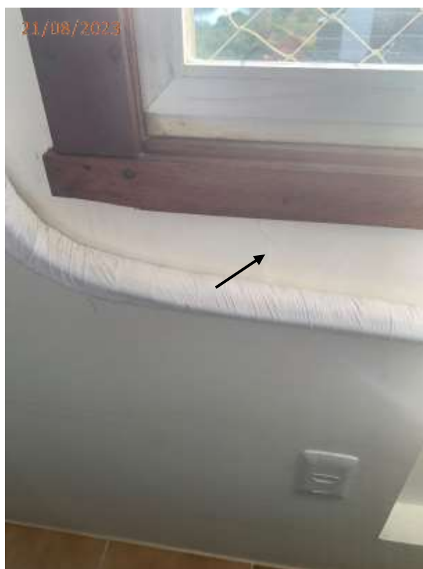
Fotos 11 e 12: Trinca na parede junto a janela do dormitório.
