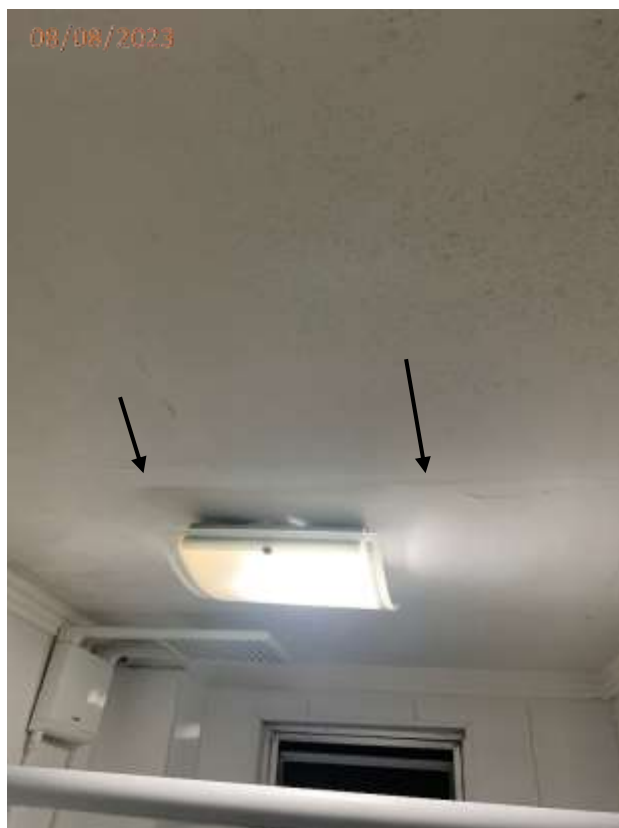
Fotos 11 e 12: Trinca no teto do banheiro.
