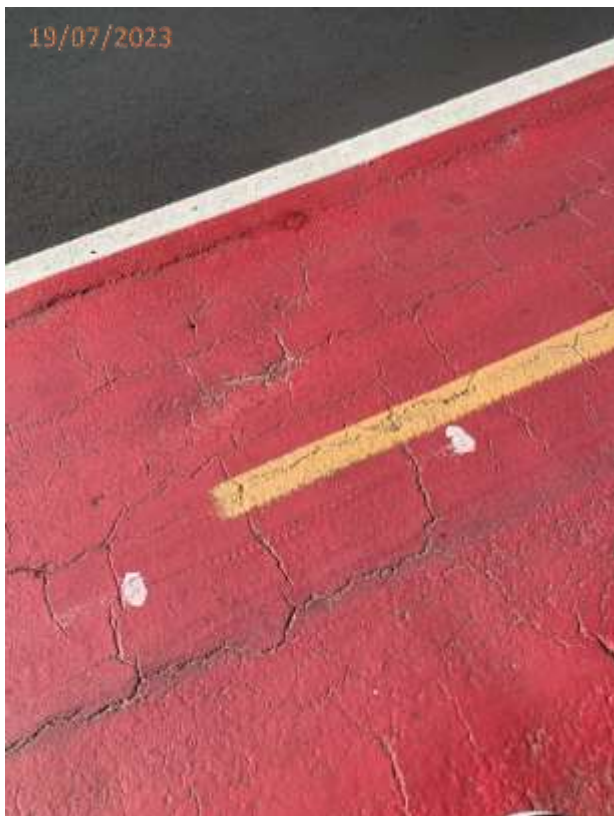
Fotos 06 e 07: Ciclo faixa da Av. Normando Tedesco apresentando rachaduras no piso.
