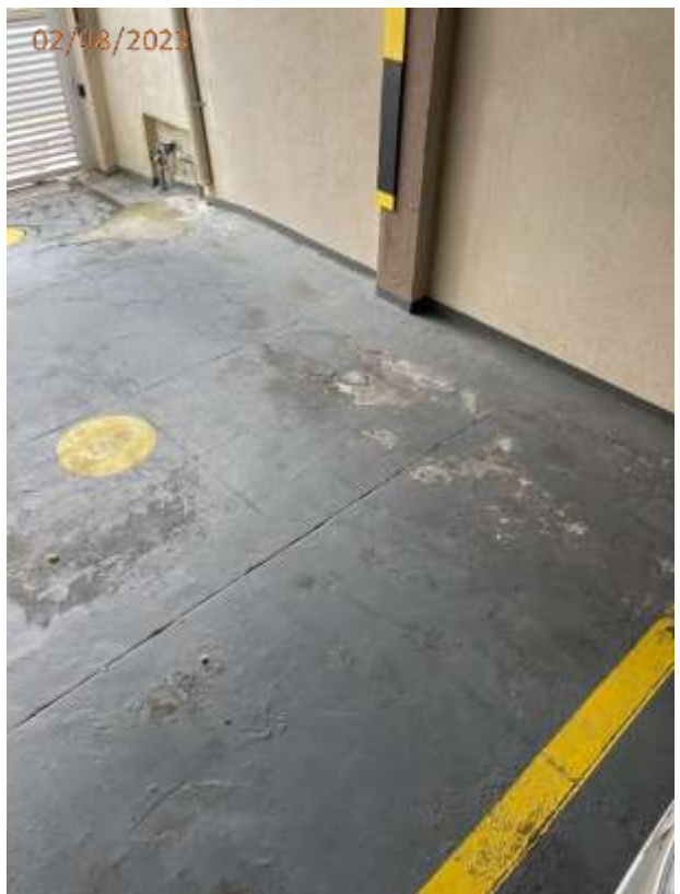
Fotos 30, 31, 32 e 33: Trincas e rachaduras generalizadas no piso da garagem lateral esquerda da edificação.
