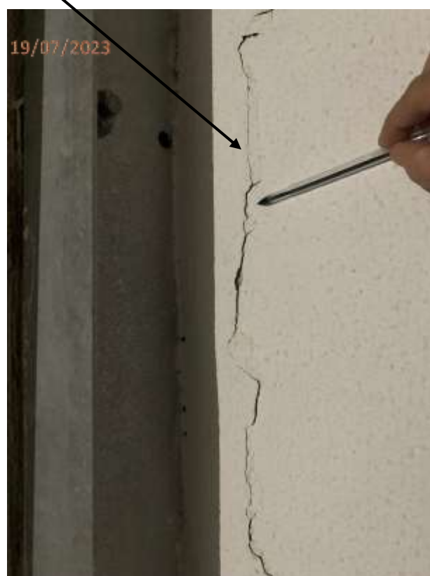
Fotos 128, 129 e 130: Rachaduras na parede da passarela entre a torres central/norte.
