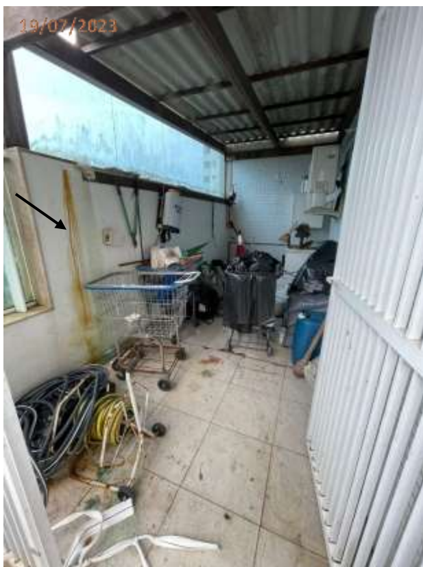
Fotos 07 e 08: Pisos cerâmicos quebrados e trincas na parede na área de apoio (depósito).
