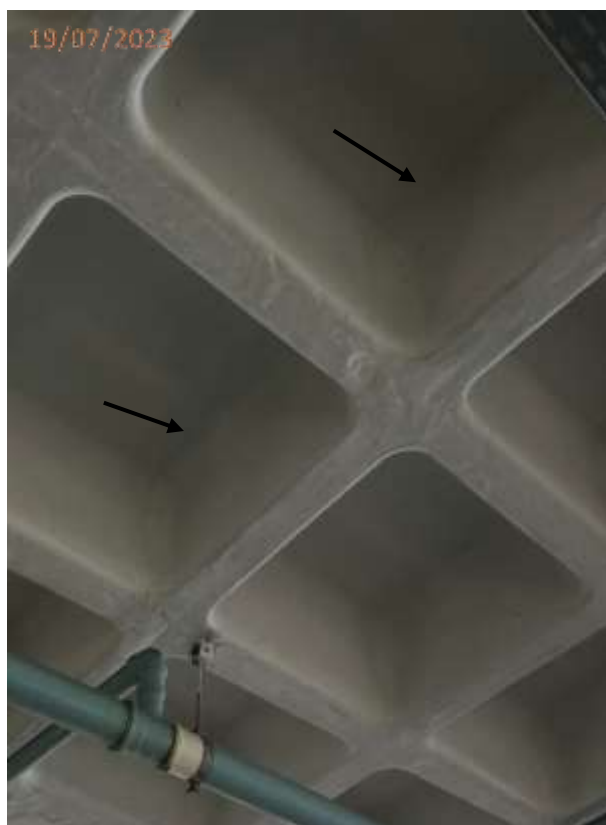
Fotos 41 e 42: Trinca no teto da circulação de veículos em frente a vaga V374.
