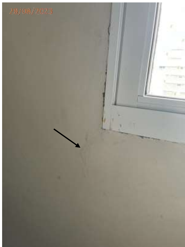
Fotos 23 e 24 Trincas na parede junto a janela do dormitório.
