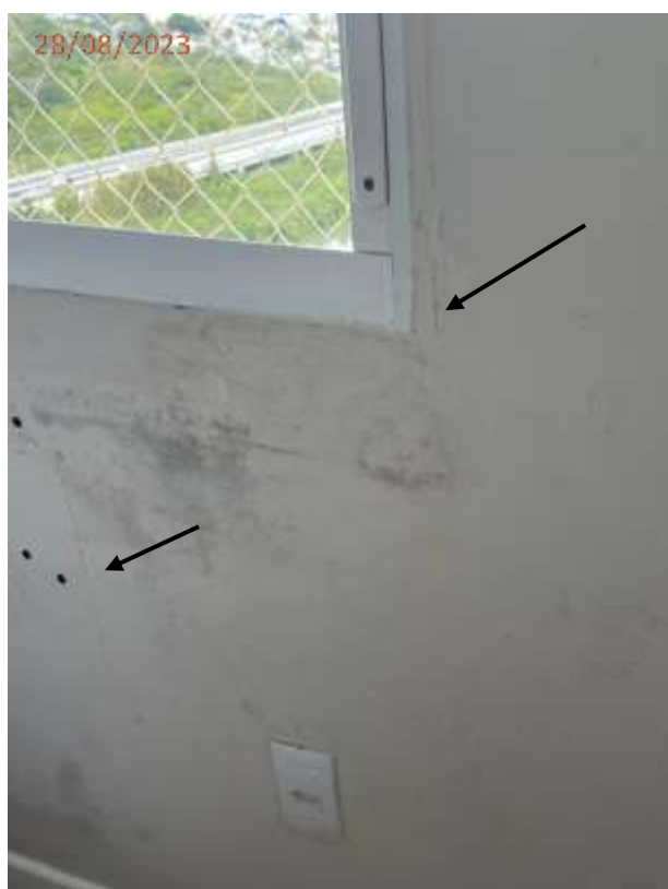
Fotos 12, 13, 14 e 15: Trincas na parede junto a janela do dormitório.
