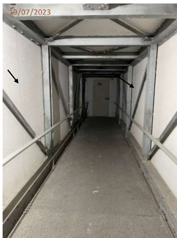
Fotos 120 e 121: Trincas e rachaduras na parede da passarela da torre central/norte.
