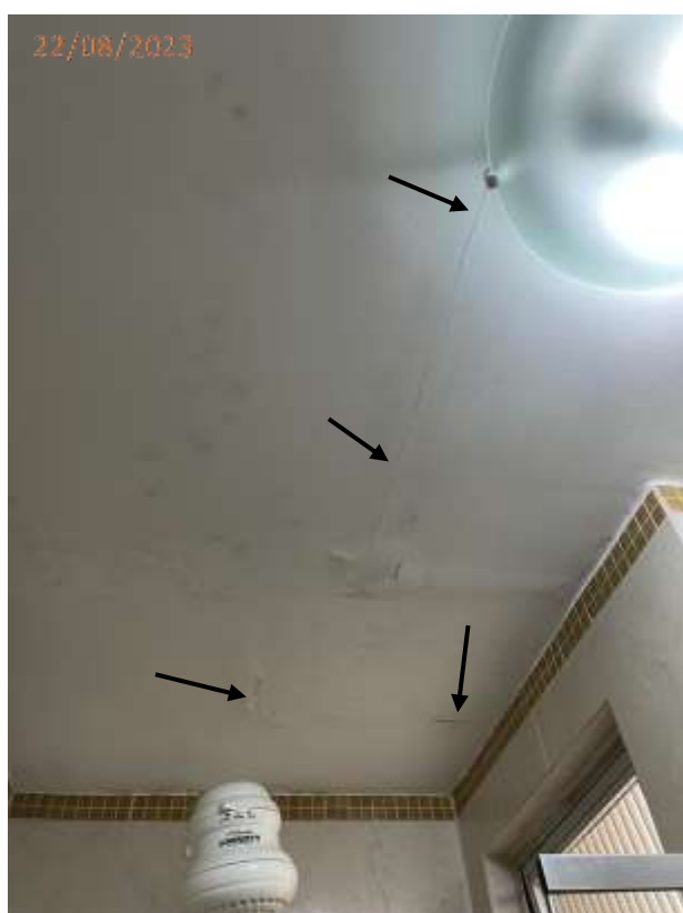
Fotos 12, 13, 14 e 15: Vidro da janela quebrado, trincas no teto e descolamento de azulejo no banheiro.
