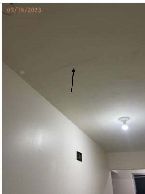
Fotos 31 e 32: Fissura na parede junto a porta do Apto 155 e no teto do hall do 15º andar.
