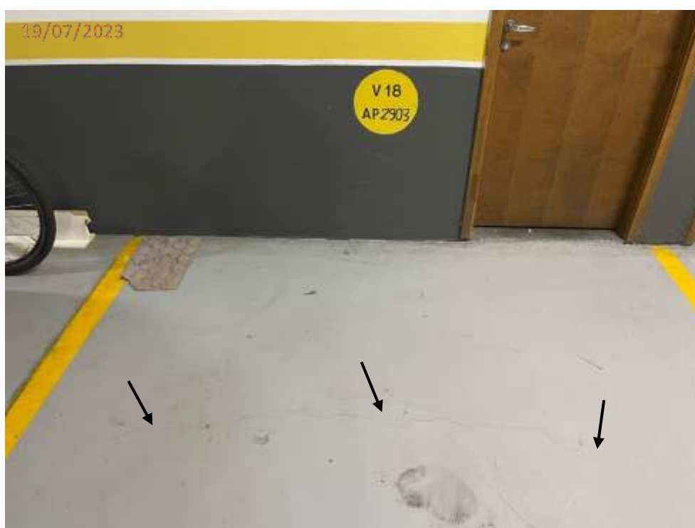
Fotos 75: Trinca piso junto a vaga V18.
