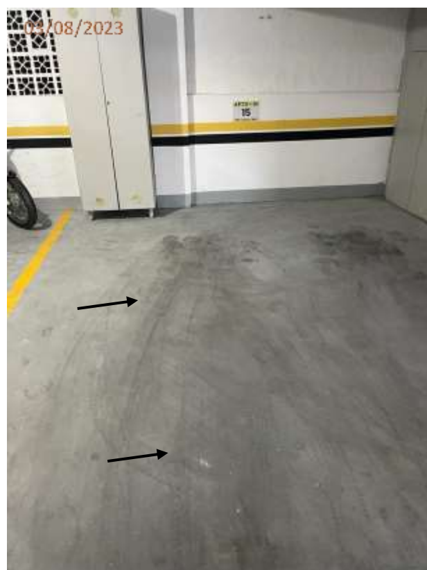
Foto 105: Trinca no piso da vaga V15.
