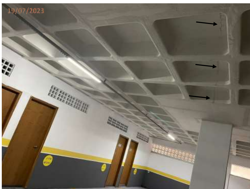
Foto 56: Trinca no teto junto a vaga V173.
