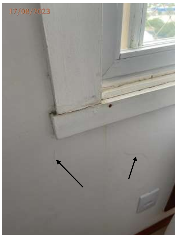
Fotos 12, 13, 14 e 15: Trinca na parede ao lado da porta e junto a janela do dormitório.
