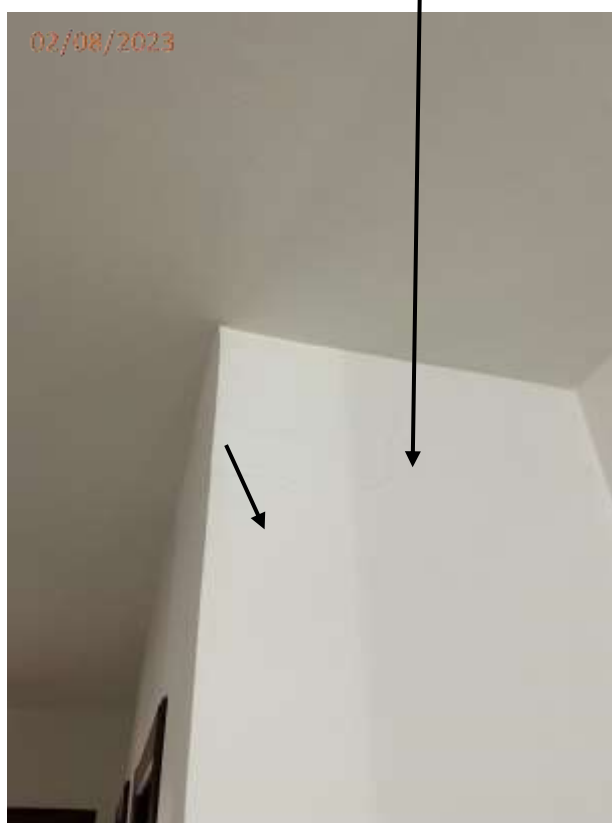
Fotos 09, 10 e 11: Fissura nas paredes da circulação íntima.
