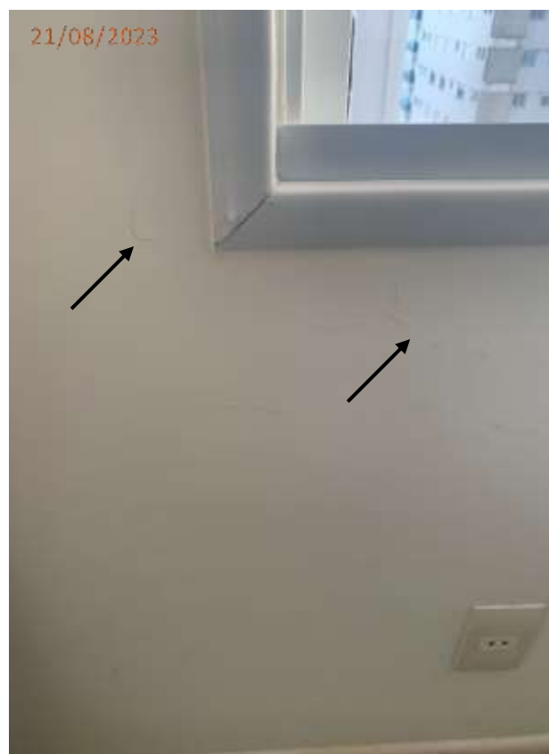
Fotos 13, 14, 15 e 16: Trincas na parede junto ao interruptos e janela do dormitório.
