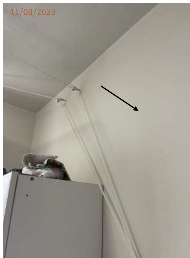
Fotos 04, 05 e 06: Fissura na parede junto a porta da cozinha e na parede da área de serviço.
