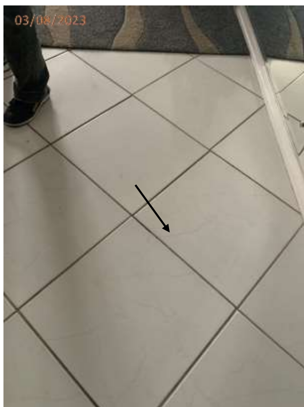
Fotos 03 e 04: Pisos da sala descolando do substrato e com som cavo (choco) ao toque.
