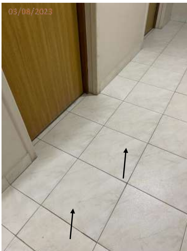
Foto 42: Som cavo (choco) ao toque nos pisos em frente a porta do elevador no hall do 9º andar.
