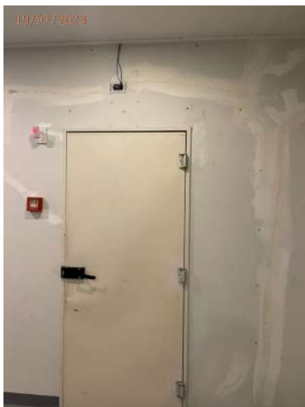
Foto 119: Trincas na parede junto a porta da passarela na torre central.
