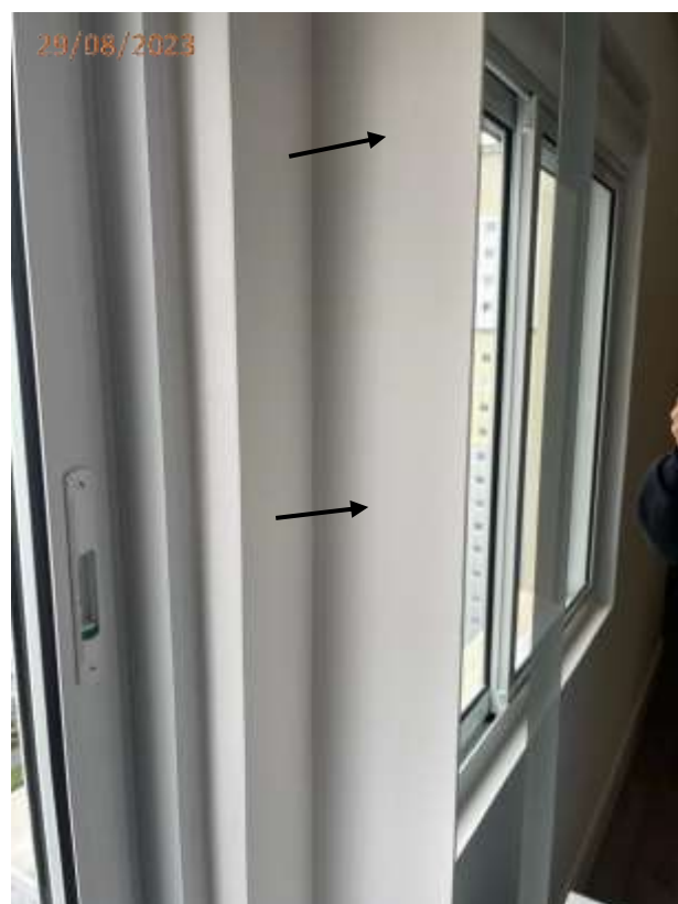
Fotos 13, 14, 15 e 16: Trinca na parede junto as janelas da suíte.
