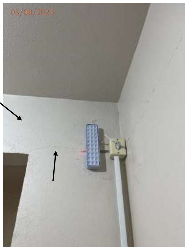
Fotos 10 e 11: Fissura na parede no hall de acesso a cobertura.
