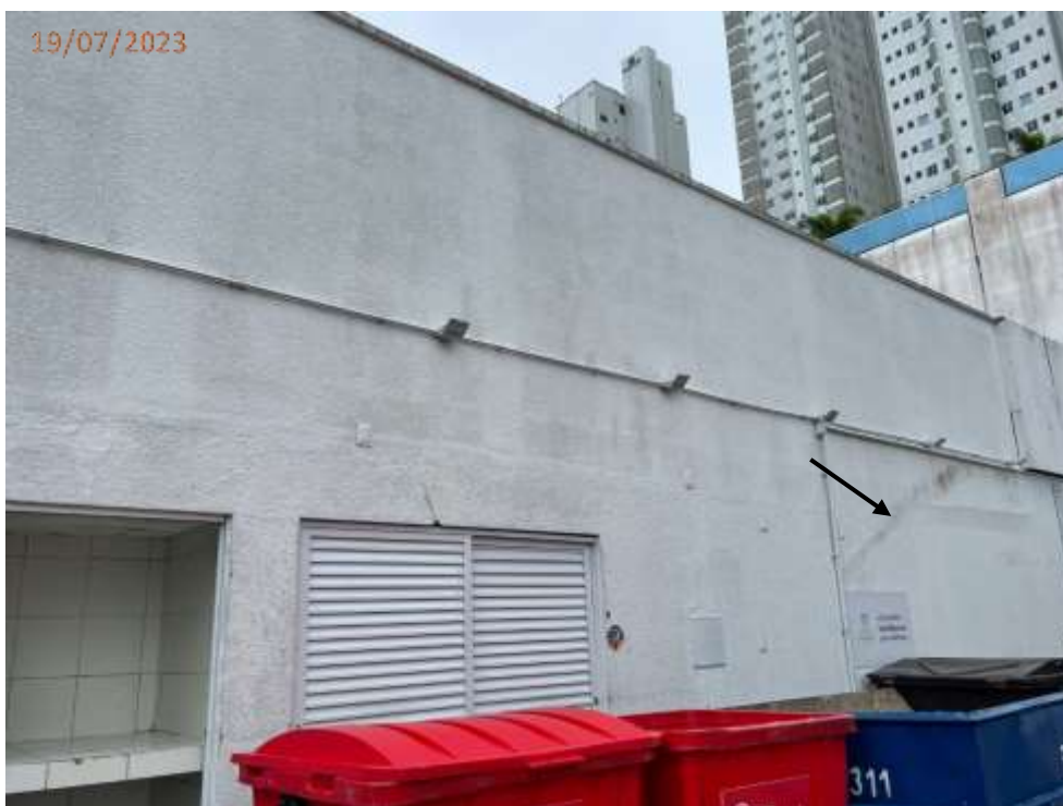
Foto 93: Trincas na parede da lixeira.
