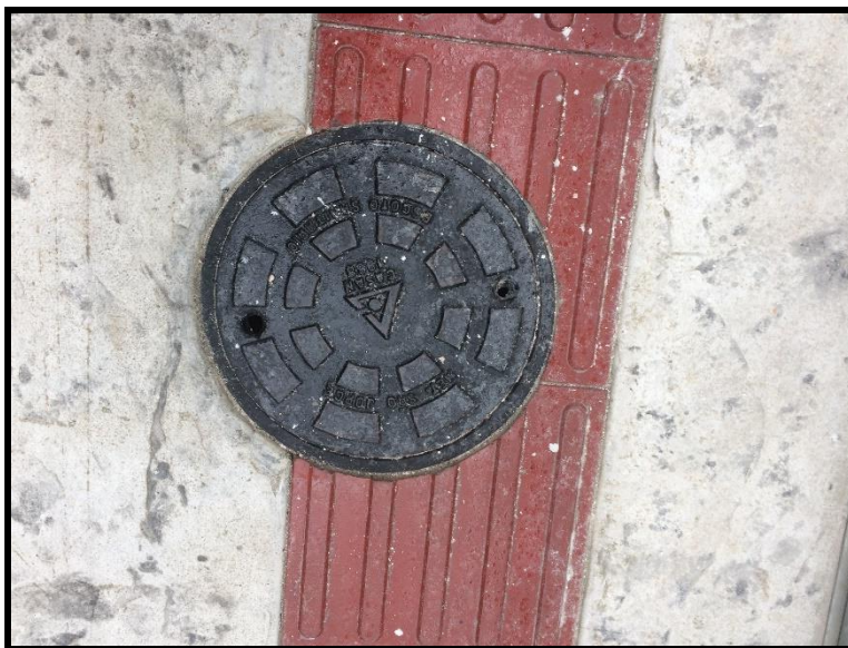
Figura 4 Ilustração da caixa de inspeção da rede coletora de esgoto.
