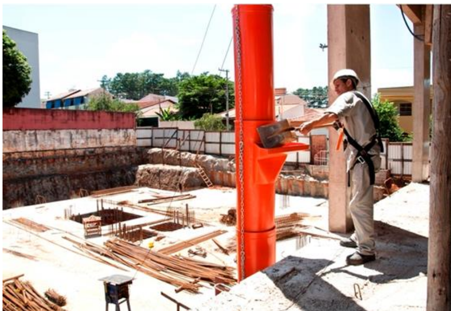
Figura 5 - Imagem Ilustrativa do transporte interno que será utilizado dos resíduos na obra.
