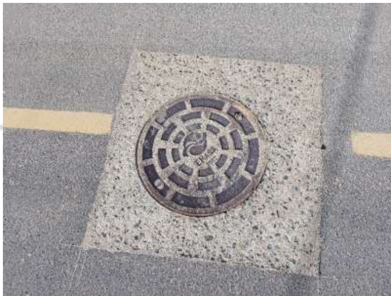
Figura 56. Visualização da caixa de passagem da rede de esgoto sanitário na Rua Aqueduto.
