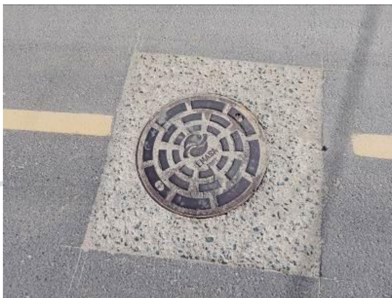
Figura 52. Visualização da caixa de passagem da rede de esgoto sanitário na Rua Aqueduto. (Registro em: 26/10/2021)
