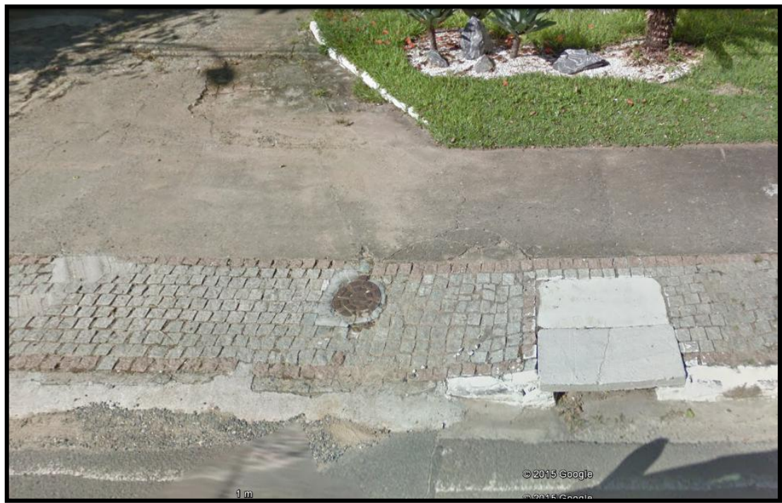
FIGURA 38– BOCA DE LOBO (DRENAGEM PLUVIAL) E REDE COLETORA DE ESGOTOS DOMÉSTICOS.
