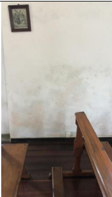
Foto 24 - Umidade ascendente na parede interna face sul, imagem registrada em 13/09/2023.
