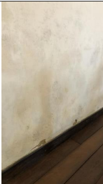
Foto 42 - Imagem face norte interna, registrada em 13/09/2023. Umidade ascendente na parede.
