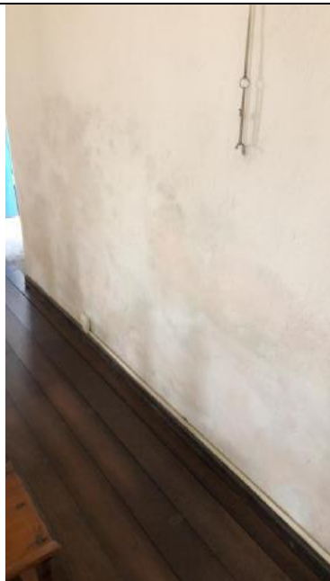
Foto 25 - Umidade ascendente na parede interna face sul, imagem registrada em 13/09/2023.
