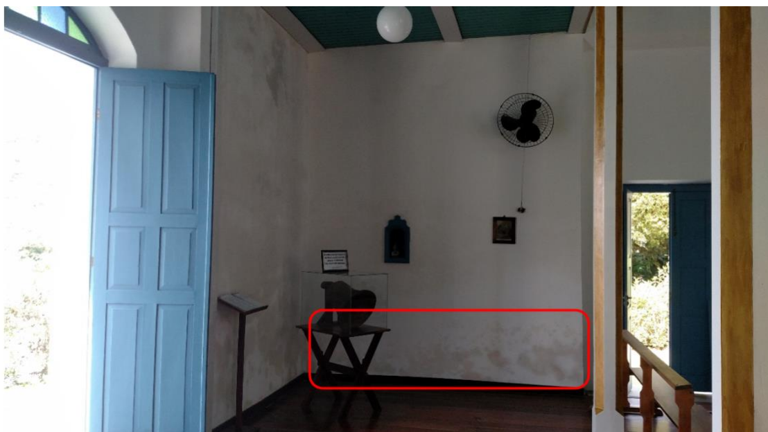
Foto 18 – Imagem face leste interna, registrada em (26/08/2017). Umidade na alvenaria proveniente do solo por capilaridade.
