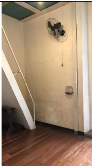
Foto 34 - Imagem face leste interna, registrada em 13/09/2023. Umidade ascendente nas paredes.
