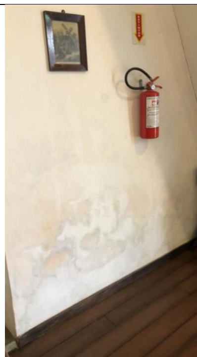
Foto 39 - Imagem face norte interna, registrada em 13/09/2023. Umidade ascendente na parede.
