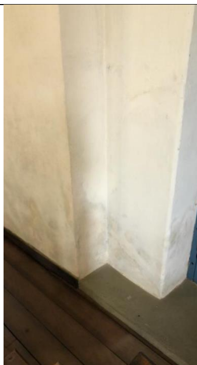
Foto 40 - Imagem face norte interna, registrada em 13/09/2023. Umidade ascendente na parede.
