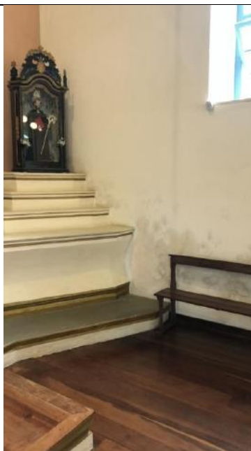
Foto 45 - Imagem face norte interna, registrada em 13/09/2023. Umidade ascendente na parede.
