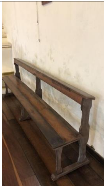
Foto 43 - Imagem face norte interna, registrada em 13/09/2023. Umidade ascendente na parede.
