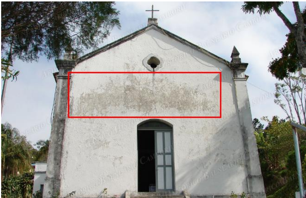
Foto 2 - Foto do arquivo histórico datada do ano de 2006, fica evidente o descolamento com pulverulência da pintura da fachada frontal da capela em função da ação das intempéries.
