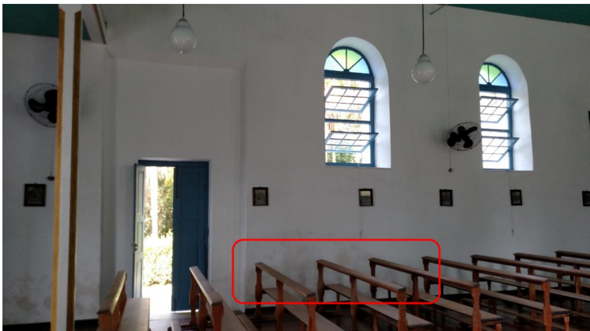
Foto 20 - Imagem face sul interna, registrada em 26/08/2017. Umidade na alvenaria proveniente do solo por capilaridade.
