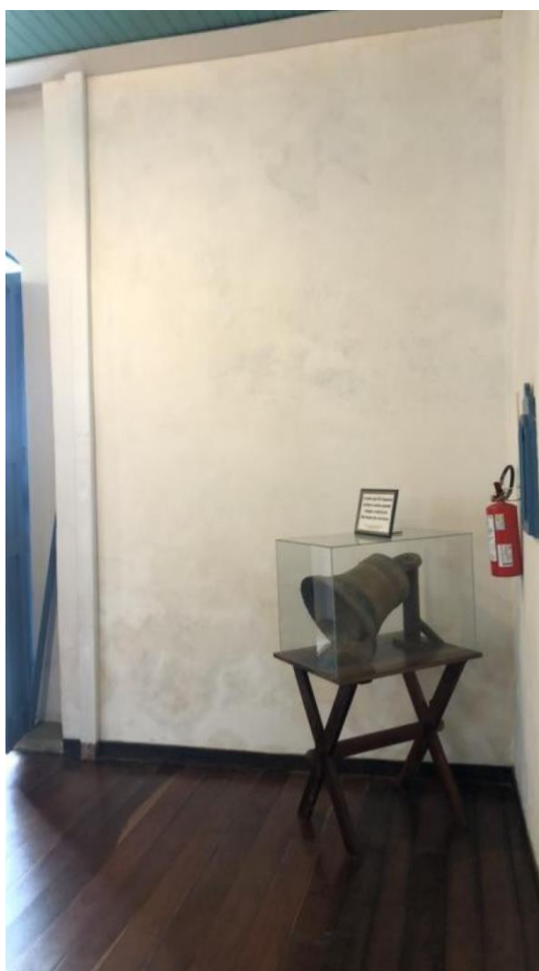
Foto 19 – Imagem face leste interna, registrada em 13/09/2023, umidade por capilaridade.
