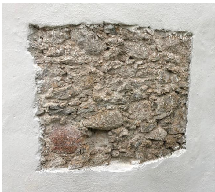
Foto 1 - Parede de pedras empilhadas com revestimento de argamassa composta por cal e areia. Imagem registrada em 13/09/2023.
