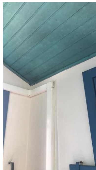
Foto 65 - Forro de madeira necessita de pintura, apresenta coloração heterogênea.
