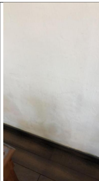
Foto 41 - Imagem face norte interna, registrada em 13/09/2023. Umidade ascendente na parede.
