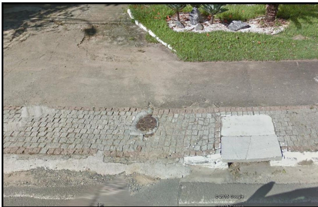
FIGURA 28– BOCA DE LOBO (DRENAGEM PLUVIAL) E REDE COLETORA DE ESGOTOS DOMÉSTICOS.
