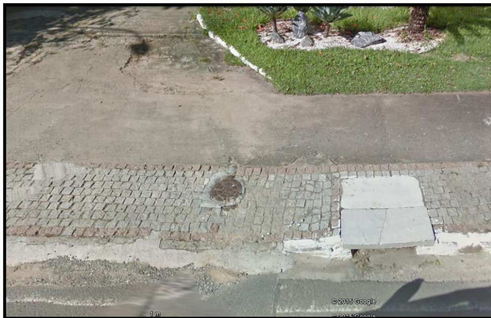
Figura 19– Boca de lobo (drenagem pluvial) e Rede Coletora de esgotos domésticos
