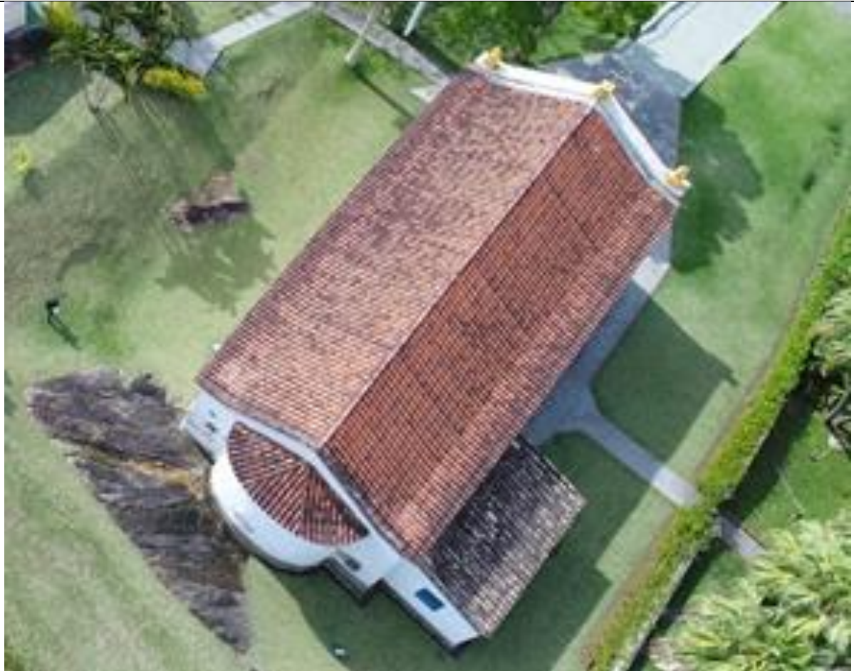
Vista aérea telhas cerâmicas do tipo francesa.
