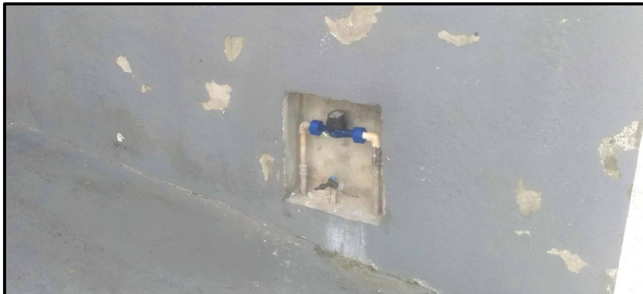
FOTO 6. Exemplo de registro instalado em uma edificação na rua 2400 (Fonte: Autor)
