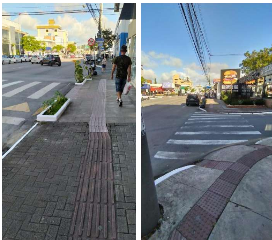
Figura 9 – Exemplos de utilização errônea do piso podotátil na 4ª Av.
