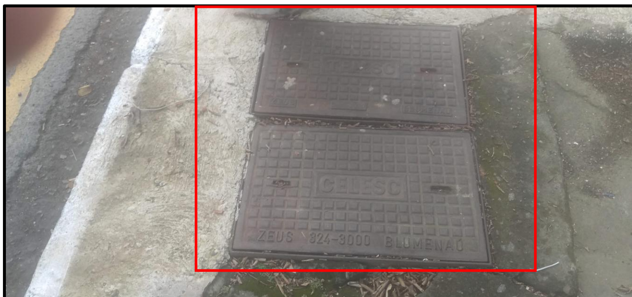
FOTO 12. Caixa de inspeção rede energia elétrica Rua 2300 (Fonte: Autor)
