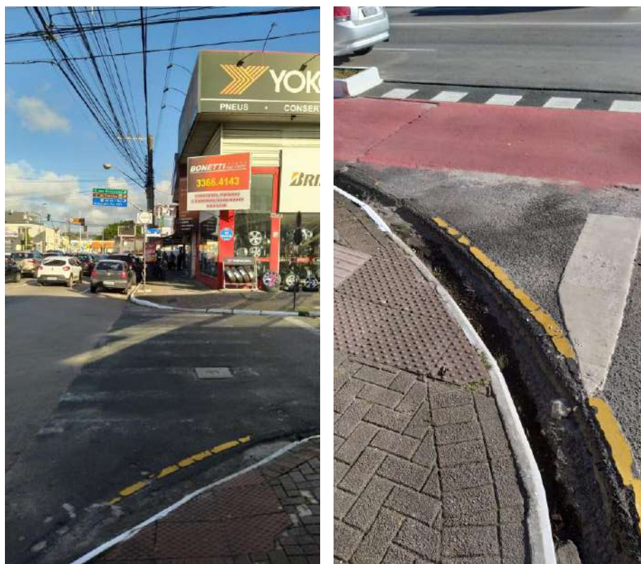
Figura 10 – Problemas nas travessias: drenagem comprometendo a acessibilidade e travessia desgastada
