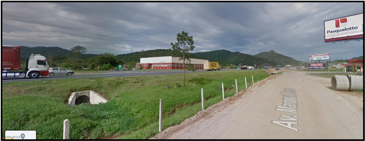
IMAGEM 8. - Vista do bueiro que conduz as águas sob a BR 101 (sentido L – O) até a vala de drenagem (entre a BR e a Marginal Oeste) – Fonte: Google Street View/2018.
