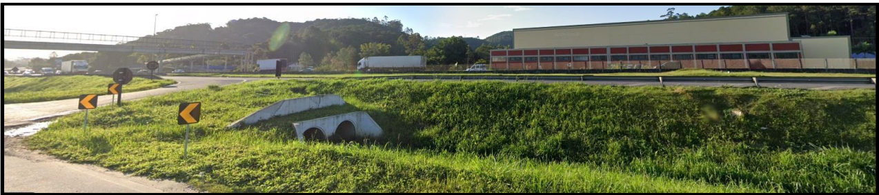
IMAGEM 9. - Vista da vala de drenagem (entre a Br 101 e a Marginal Oeste) conduzindo as águas até o curso de água mais próximo, conforme demonstrado no Mapa 1 (replicado a seguir) – Fonte: Google Street View/2018.
