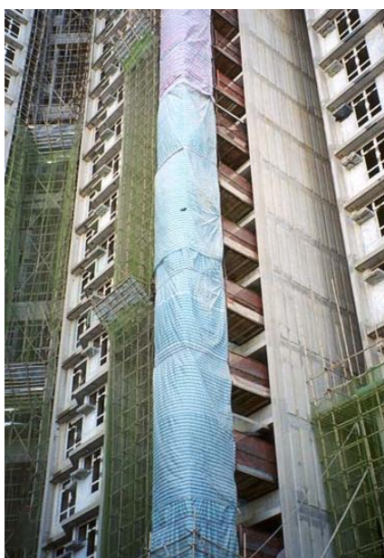
Figura 4. Duto de descarga de resíduos protegido por tela
