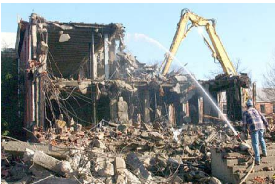
Figura 1. Aspersão de água na fase de demolição
