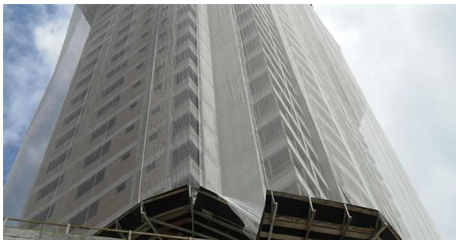
Figura 5. Tela de proteção durante fase de construção
