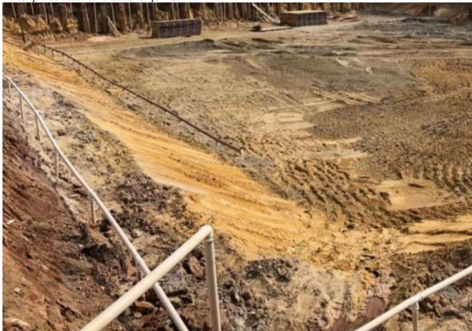
Figura 21. Execução do rebaixamento do lençol freático.
