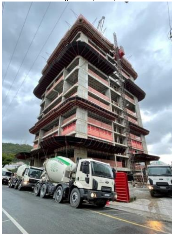
Figura 28. Estacionamento caminhões e bomba concretagem torre (Setor A).
