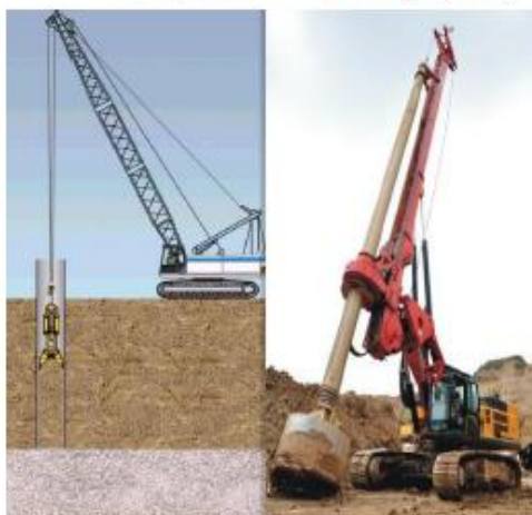
1- Escavação no trecho em solo (caçamba).
