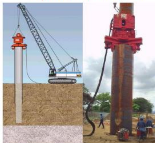
2- Inserção da camisa metálica no pré-furo.
