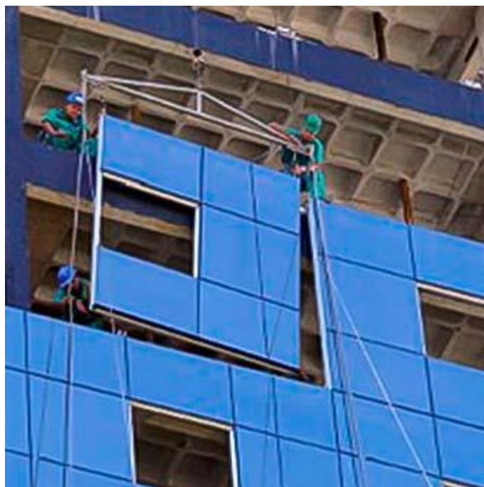
Exemplo de aplicação de fachada unitizada em vidro.
