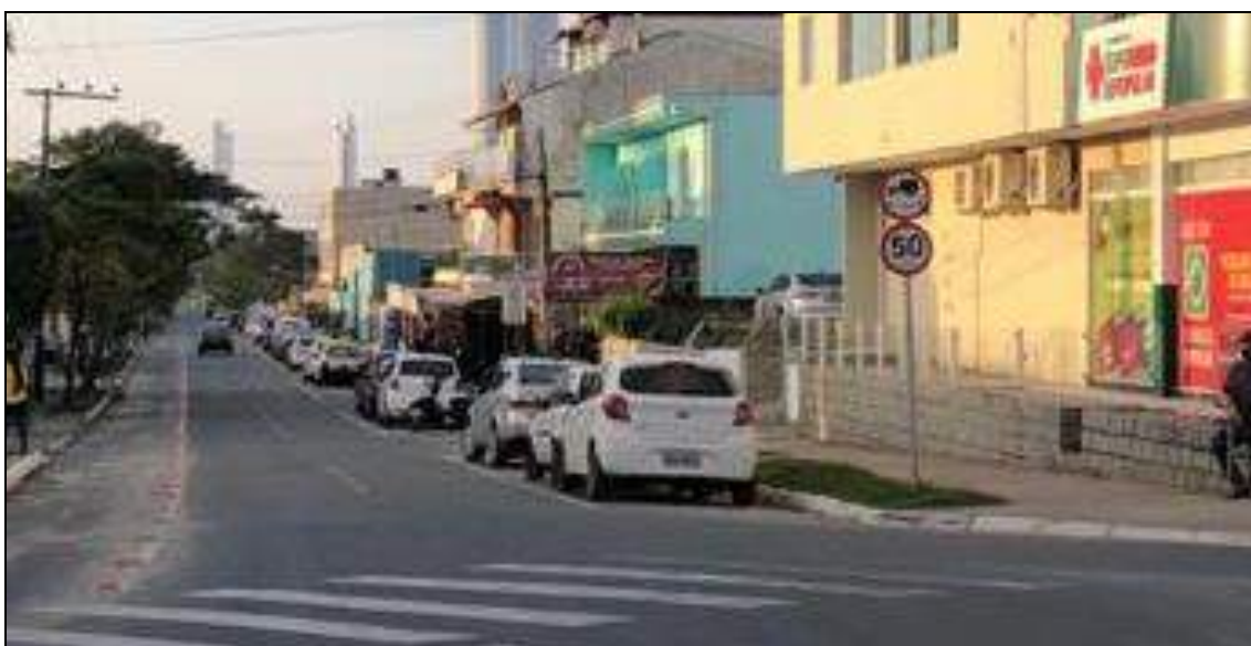
Figura 102 – Sinalização vertical de regulamentação de Comprimento máximo permitido dos veículos (12m) – Rua Doralice Linhares Bernardes. Fonte: Autor, 2020.
