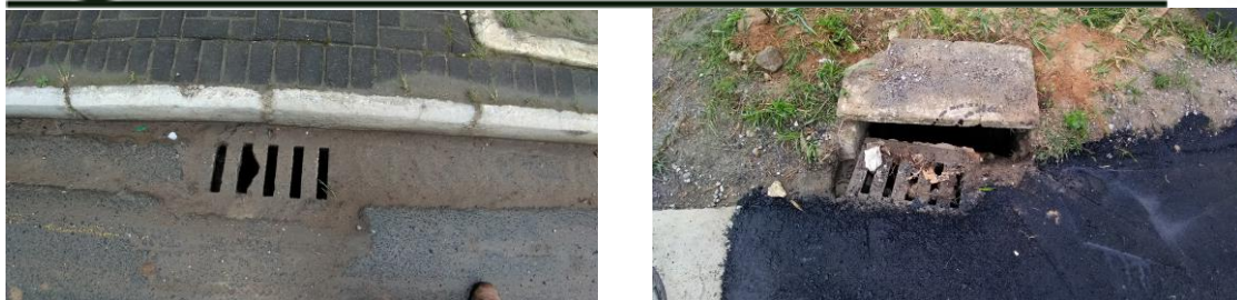
Figura 77 – Componentes do sistema de drenagem pluvial existentes na José Honorato da Silva. Fonte: Autor, 2020.
