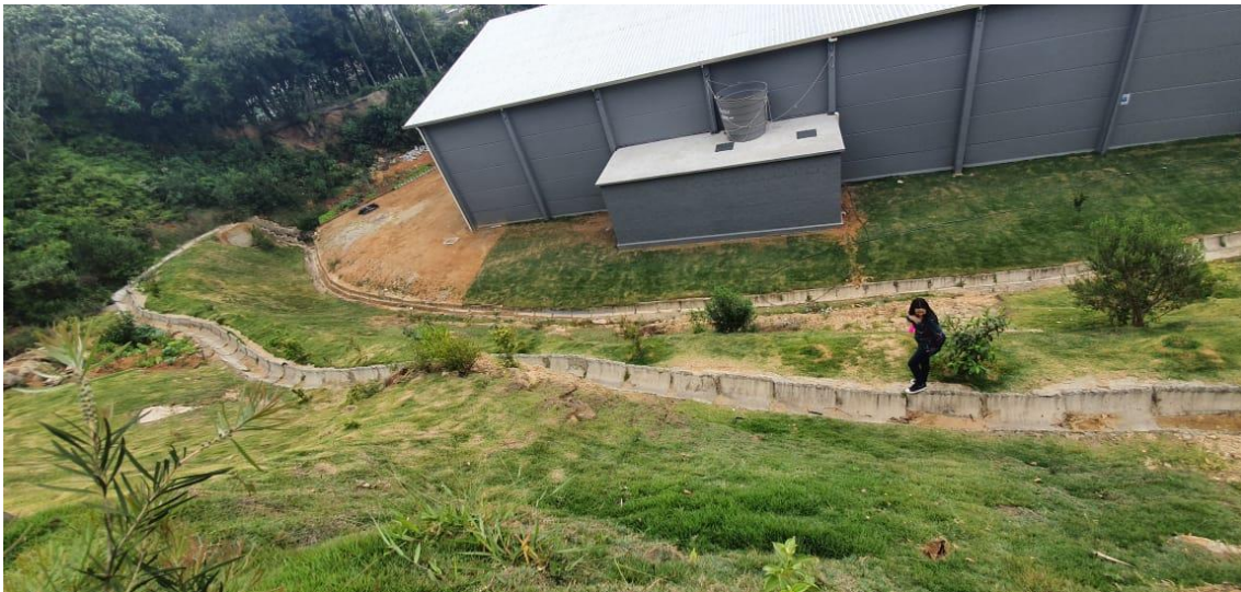
Figura 17. Valetas de proteção de corte e manutenção do revestimento vegetal com gramíneas no talude.
