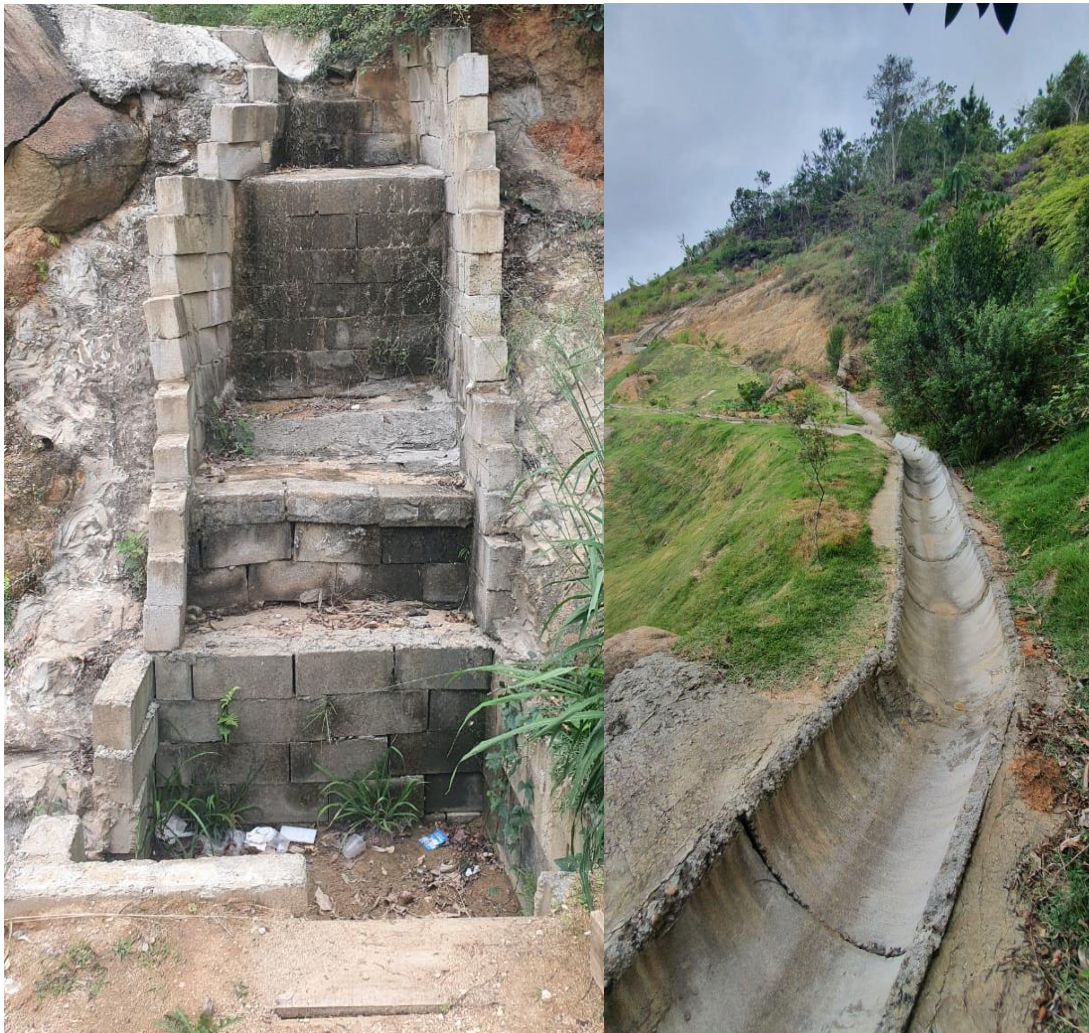
Figura 18. Dispositivos de drenagem pluvial instalados.
