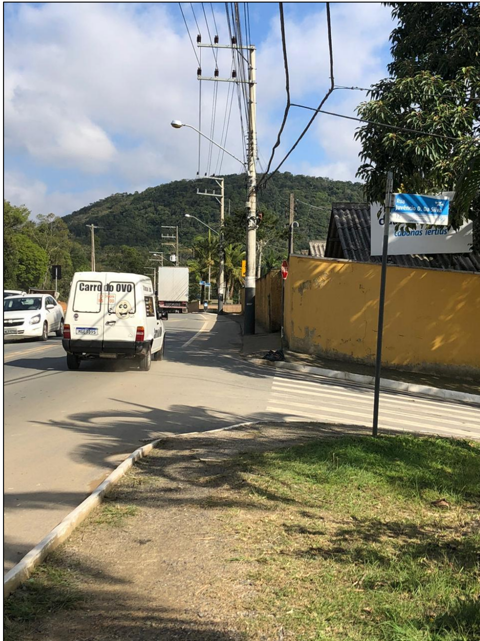
Figura 11: Falta de sinalização vertical e passeio inexistente.
