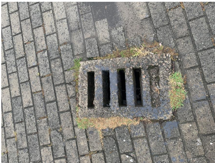
Figura 41. Bocas de lobo localizadas no interior do terreno. Fonte: do autor, 2020.
