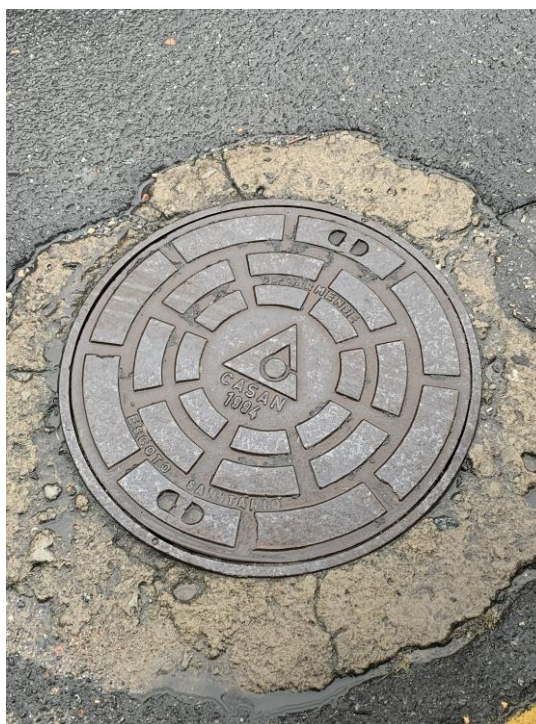
Figura 40. Visualização da caixa de inspeção da rede de esgoto sanitário em frente ao empreendimento. Fonte: do autor, 2020.
