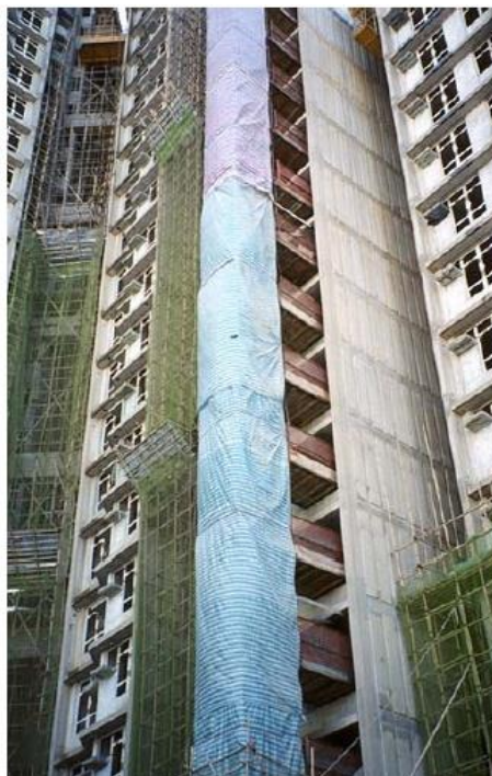
FIGURA 135 - EXEMPLO DUTO DE DESCARGA DE ENTULHO PROTEGIDO POR TELA.
