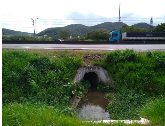
Figura 95 – Componentes do sistema de drenagem pluvial existentes na Av. Marginal Oeste. Fonte: Autor, 2020.
