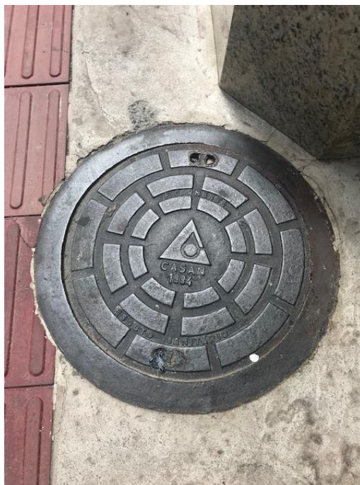
Figura 48. Visualização da caixa de inspeção da rede coletora de esgoto sanitário do empreendimento. Fonte: do autor, 2019.
