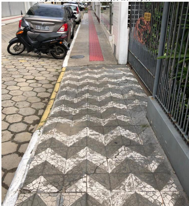
Figura 11: Falta de sinalização tátil no piso.
