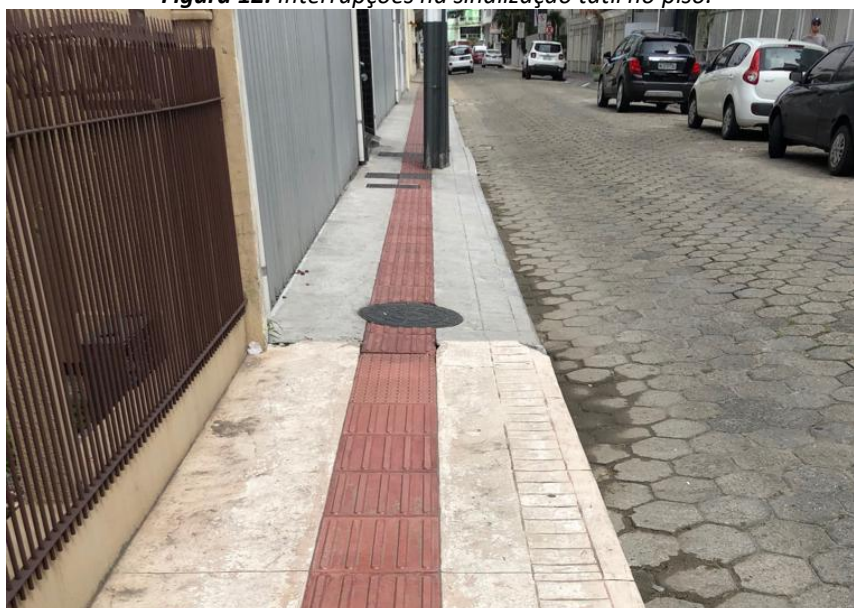
Figura 12: Interrupções na sinalização tátil no piso.
