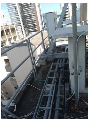
ESTEIRAMENTO METÁLICO
