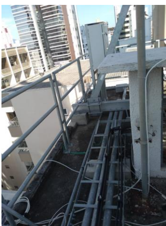
ESTEIRAMENTO METÁLICO
