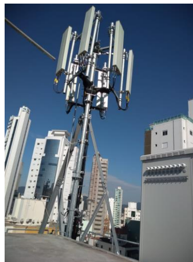
MASTRO MMETÁLICO
