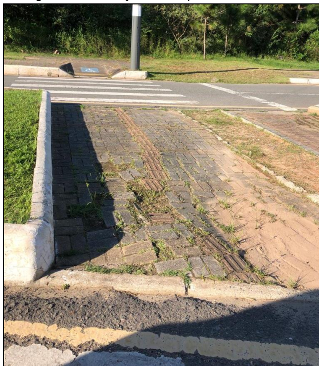
Figura 25: Sinalização tátil de piso em mau estado.
