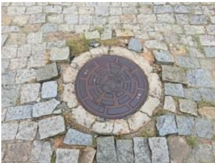
Figura 40. Visualização da caixa de passagem da rede de esgoto sanitário na Rua Aqueduto.
