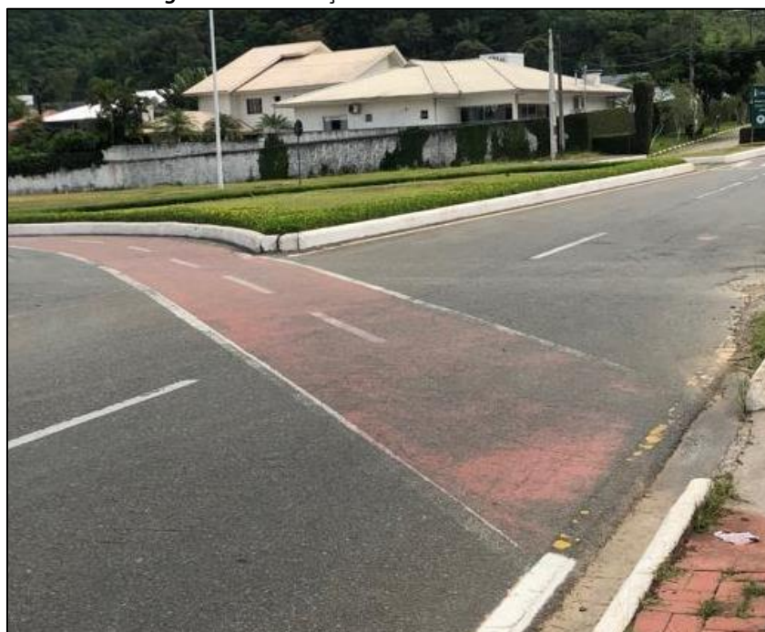
Figura 12: Sinalização horizontal em mau estado.
