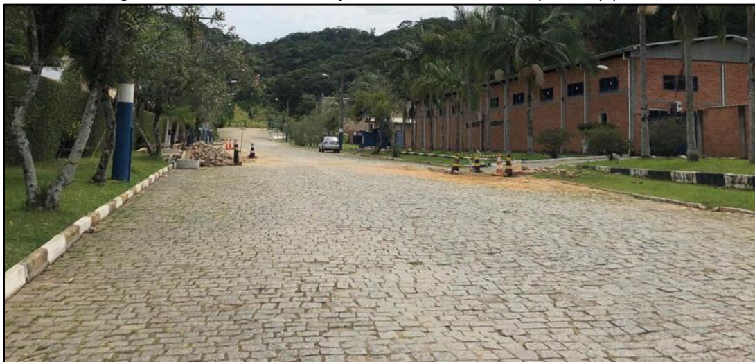
Figura 13: Ausência de sinalização horizontal em via com paralelepípedo.
