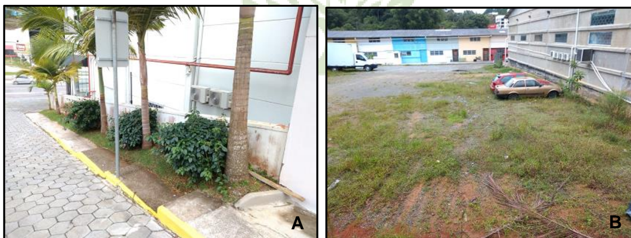
Figura 27. Imagem com comprovação de utilização e adoção de pisos permeáveis: A - pavimentação em piso intertravado de concreto (Paver) proporcionando alta permeabilidade; B- solo recoberto por e vegetação reasteira.
