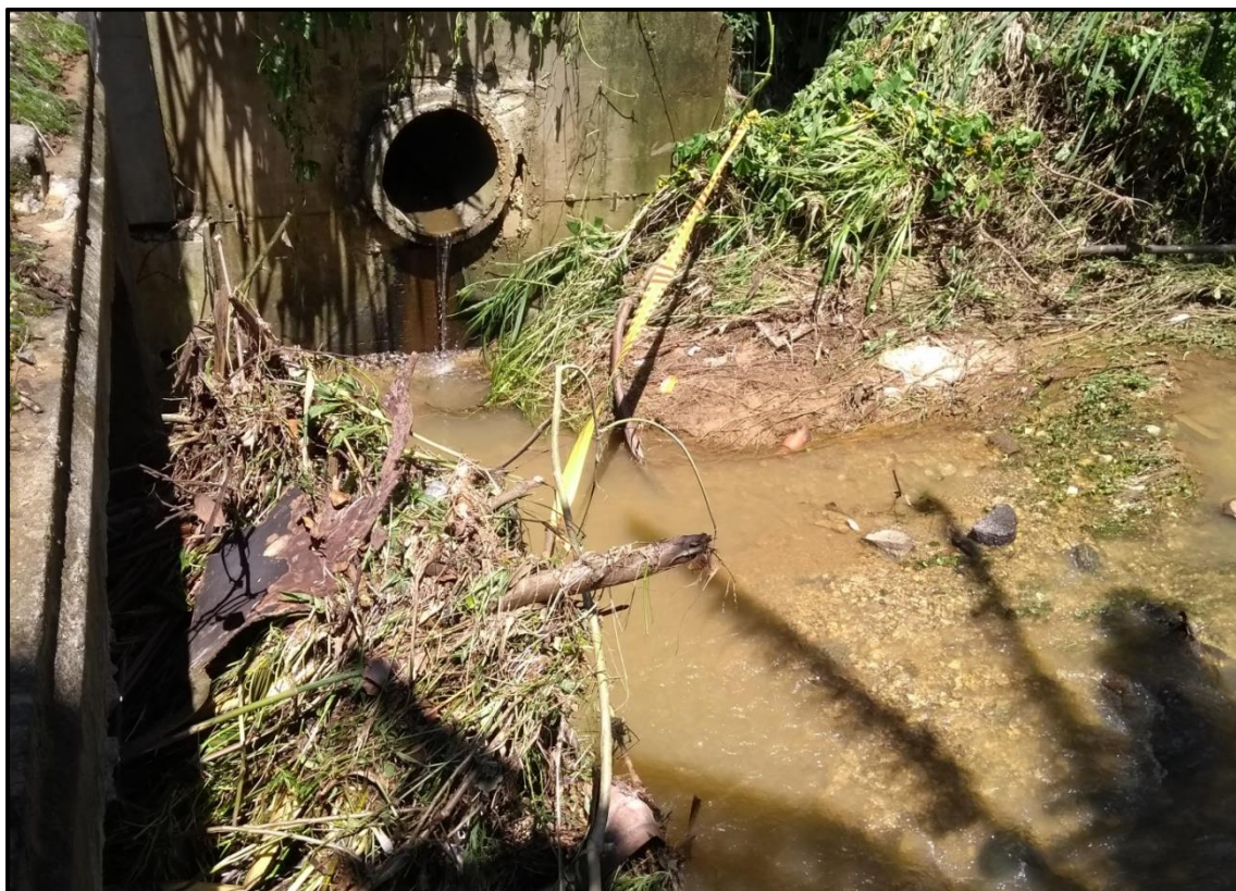
Figura 56. Registro fotográfico após fortes chuvas, em 12/02/2018, mostrando entulhos obstruindo a galeria pluvial que corta a Av. Calos Drumond de Andrade, ocasionando represamentos dos volumes de montante (acima), que resultam em alagamentos nos Bairros Praia Brava, Praia dos Amores e Ariribá.,
