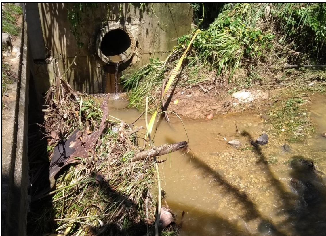
Figura 43. Registro fotográfico após fortes chuvas, em 12/02/2018, mostrando entulhos obstruindo a galeria pluvial que corta a Av. Calos Drumond de Andrade, ocasionando represamentos dos volumes de montante (acima), que resultam em alagamentos nos Bairros Praia Brava, Praia dos Amores e Ariribá.,
