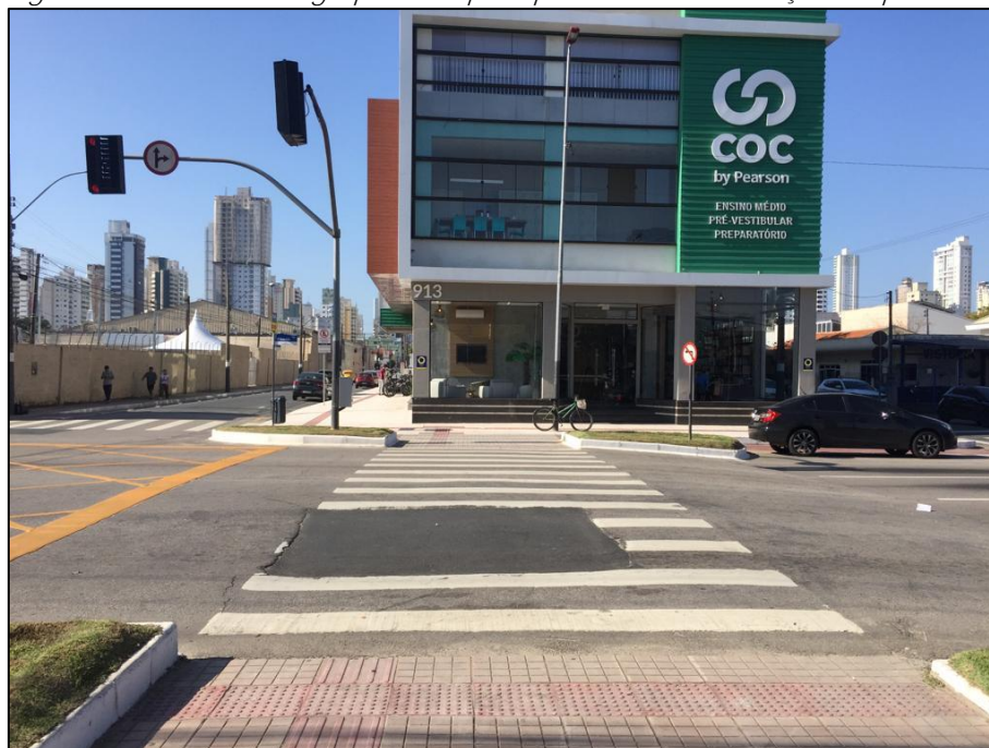
Figura 33: Ausência de grupo focal para pedestre na interseção do posto 01.
