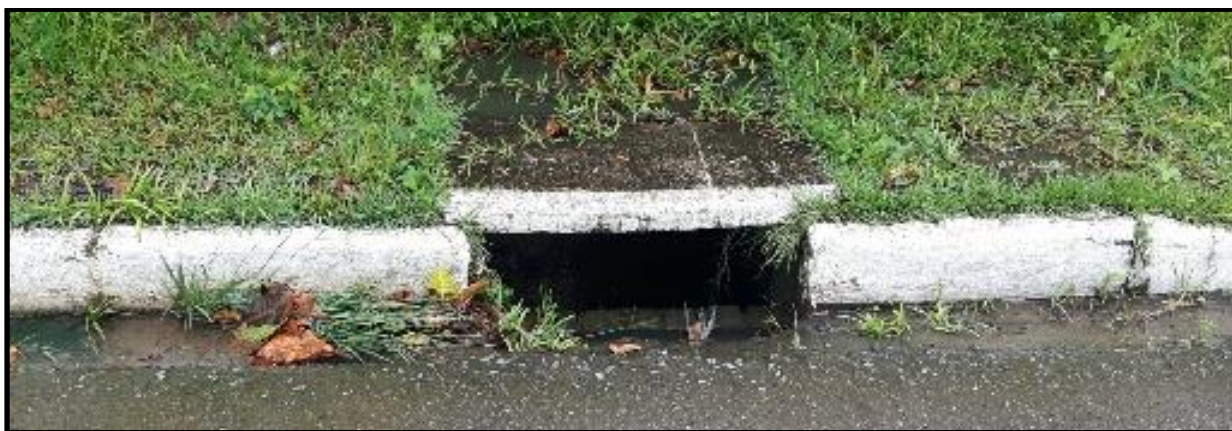
Figura 49 - Ilustração da boca de lobo, sistema público de drenagem de águas pluviais, próximo ao empreendimento em estudo.
