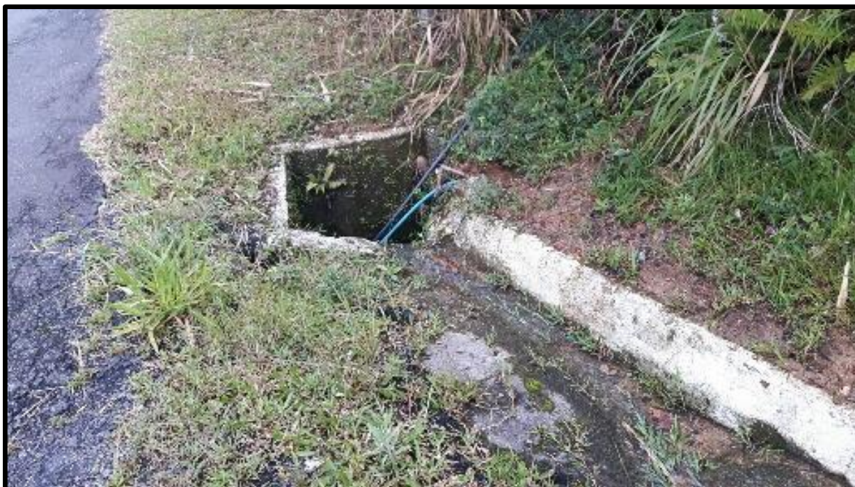
Figura 50– Boca de lobo (drenagem pluvial)
