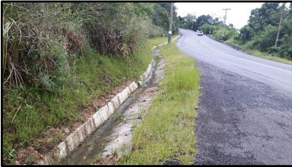
Figura 45 – Canaletas (drenagem pluvial)
