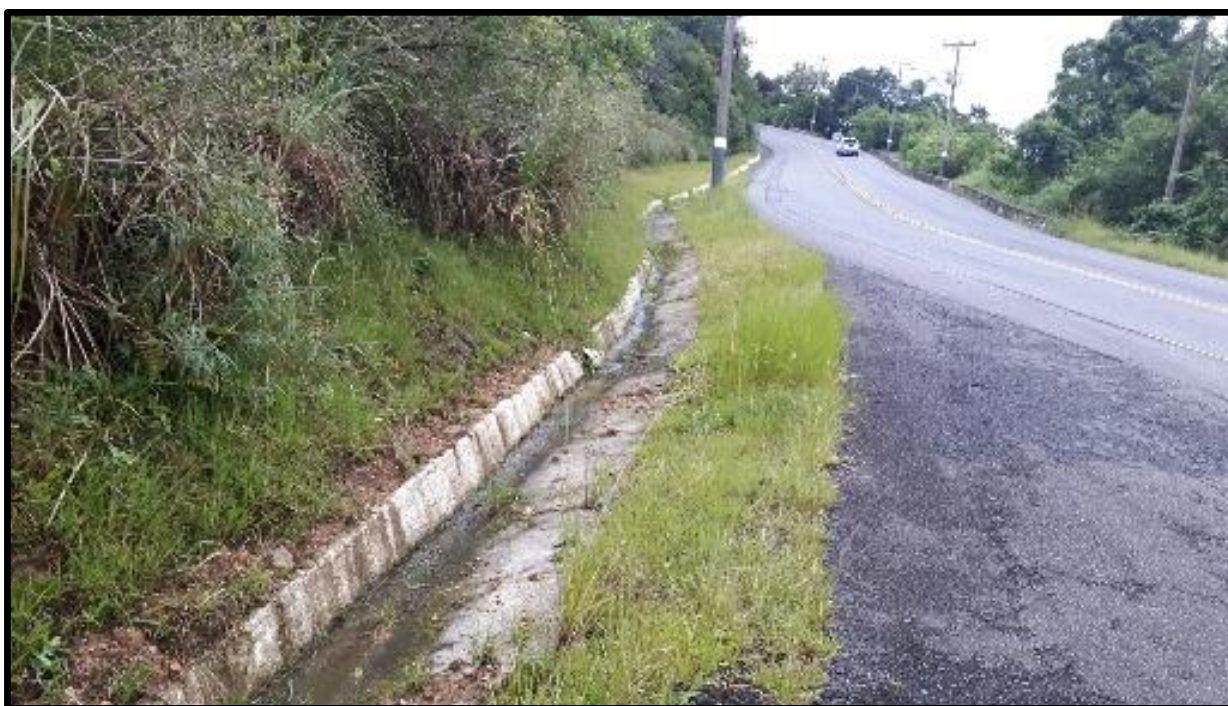
Figura 51– Canaletas (drenagem pluvial).
