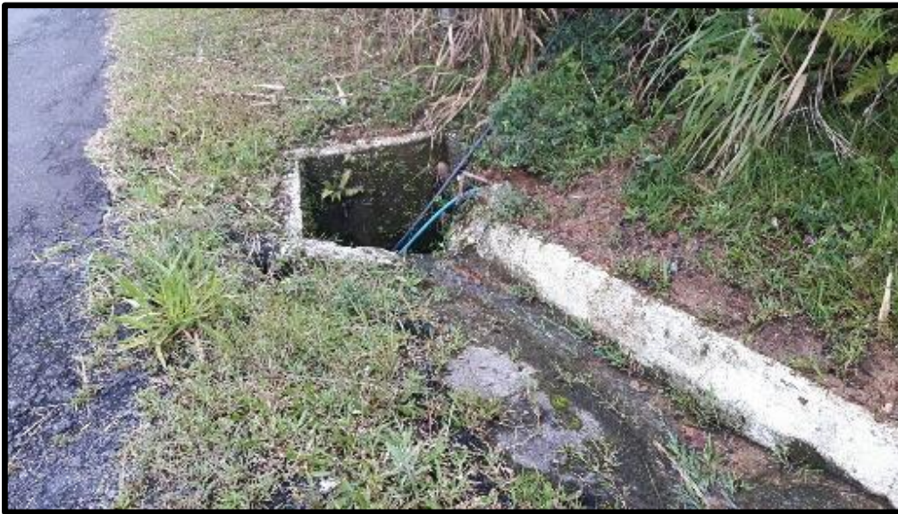
Figura 44– Boca de lobo (drenagem pluvial)
