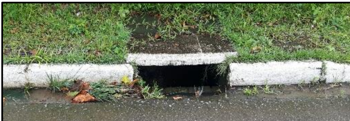
Figura 58 - Ilustração da boca de lobo, sistema público de drenagem de águas pluviais, próximo ao empreendimento em estudo.
